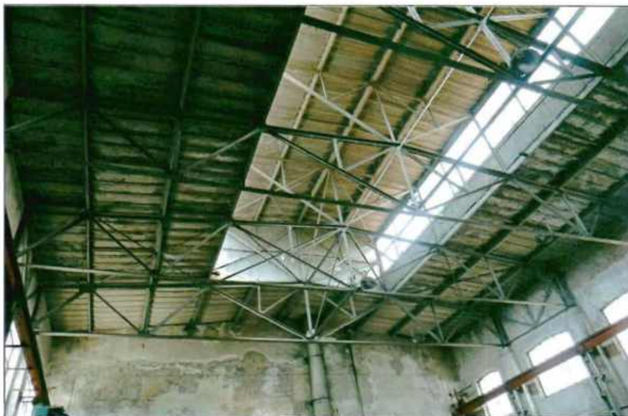
4. Интерьер. Фрагмент. Конструкции светового фонаря.
