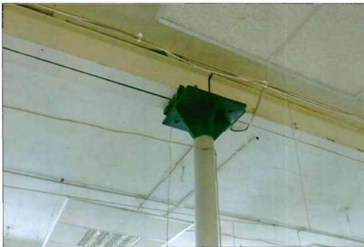
7. Интерьер. Фрагмент. Конструкция перекрытия.
