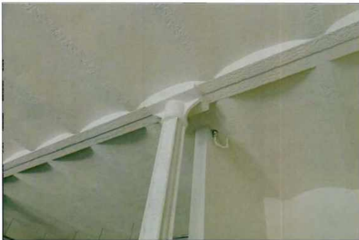
6. Интерьер. Фрагмент. Конструкция перекрытия.
