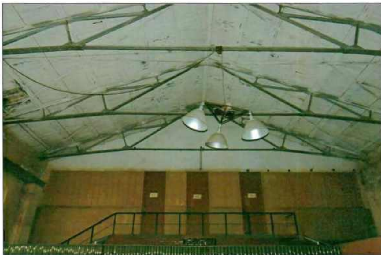
11. Интерьер. Фрагмент. Конструктивная система перекрытия.
