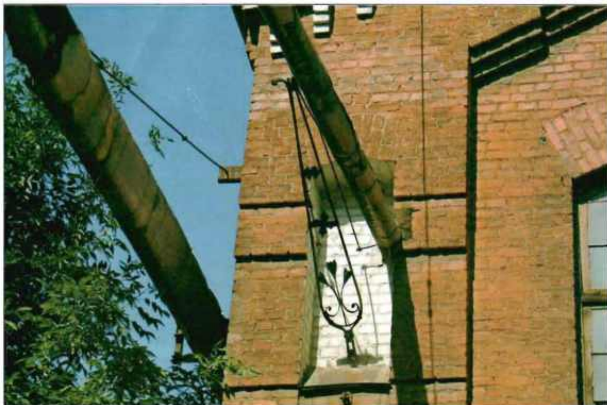
10. Юго-восточный фасад. Фрагмент. Кронштейн.
