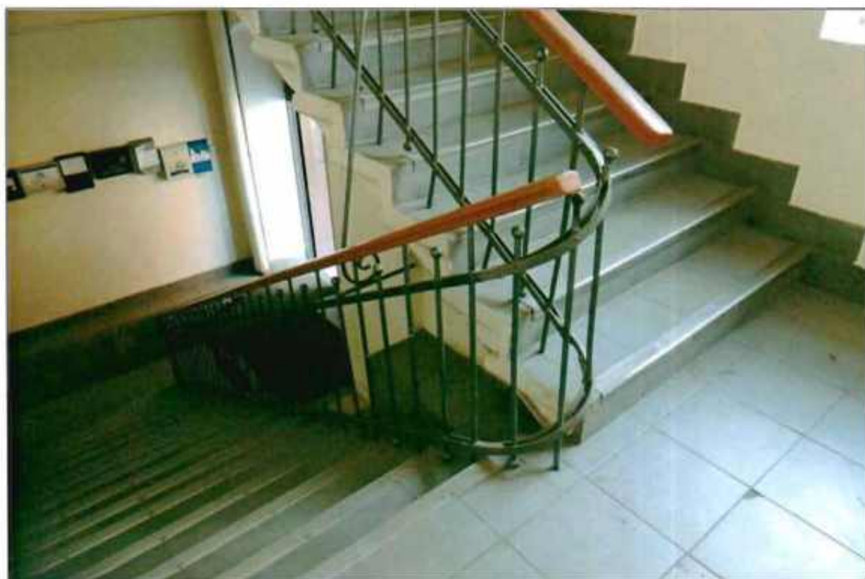
5. Интерьер. Фрагмент. Межэтажная лестница.
