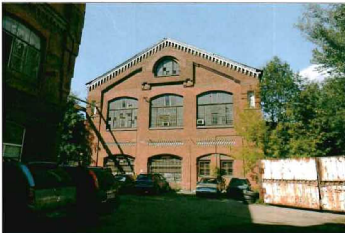
8. Общий вид юго-восточного фасада.
