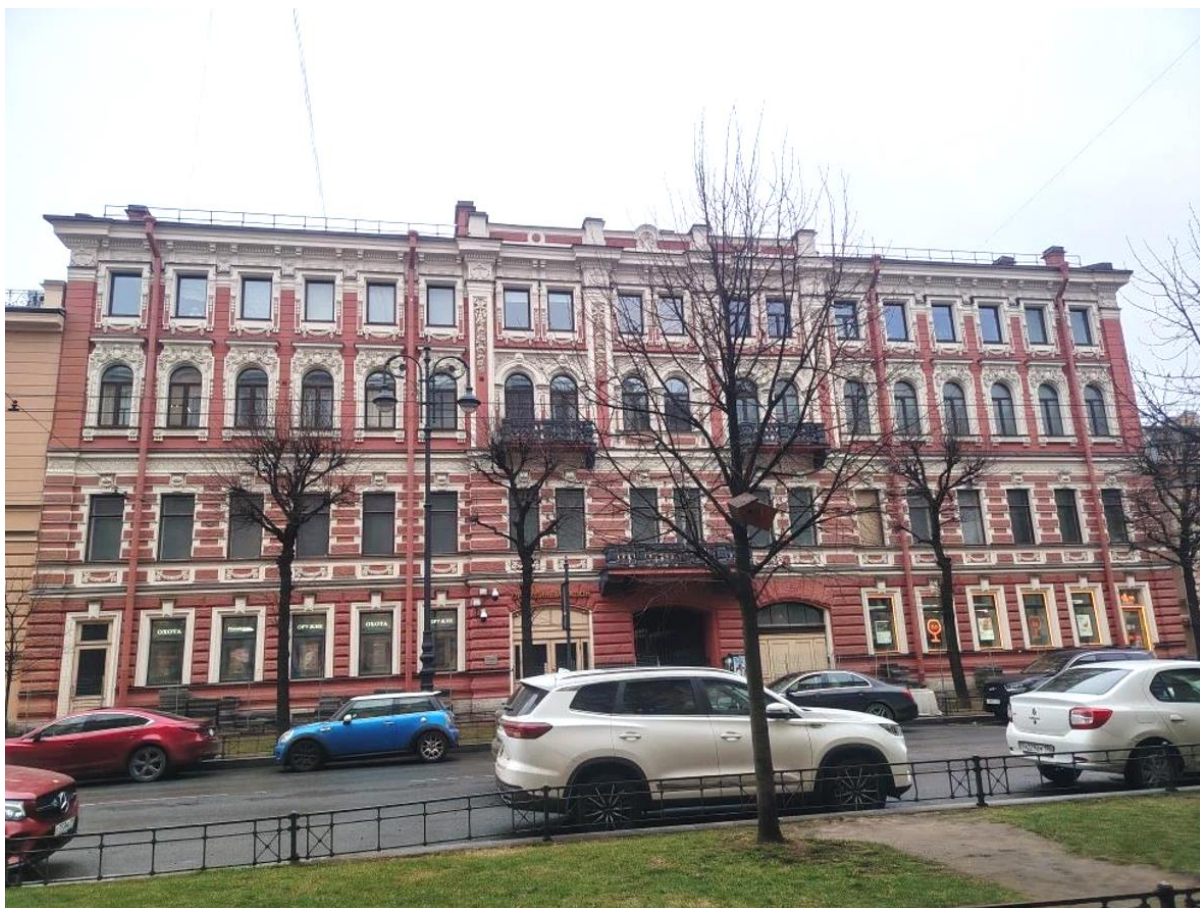
Фото 1. Лицевой фасад дома № 31 по улице Чайковского.
