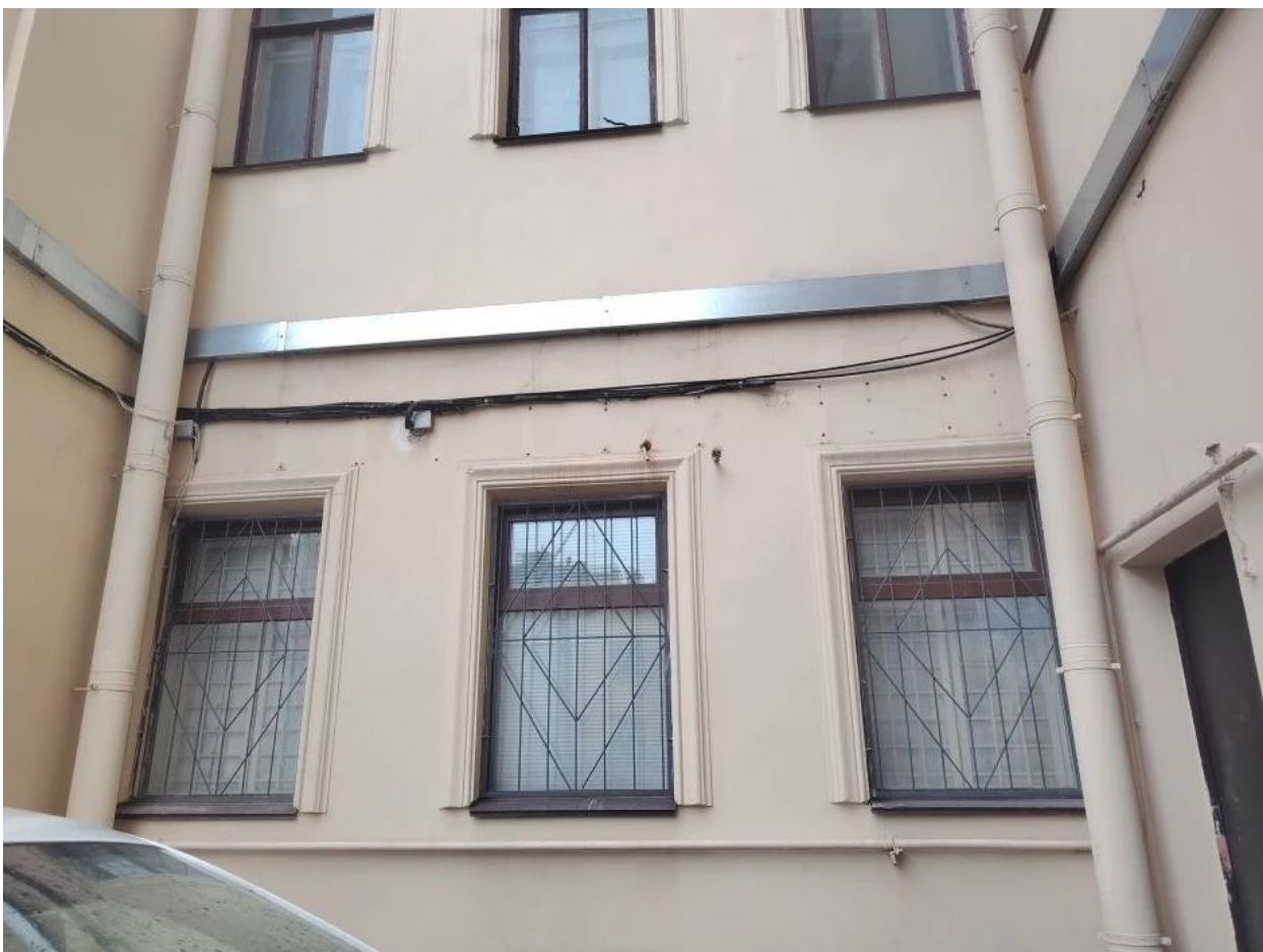
Фото 5. Вид на окна дворового фасада исследуемого объекта.
