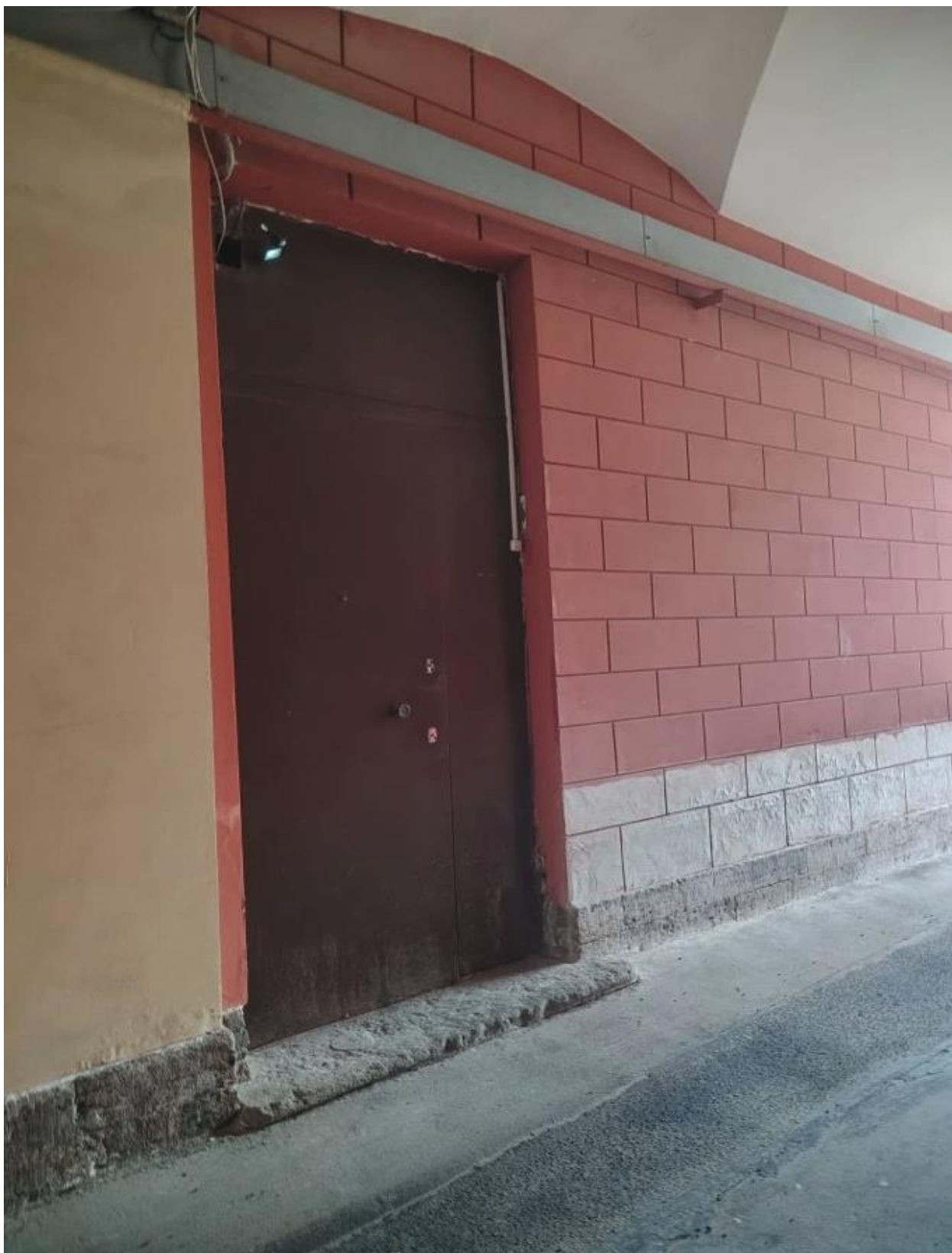
Фото 3. Вид на вход в пом. 10-Н с арочного проезда.
