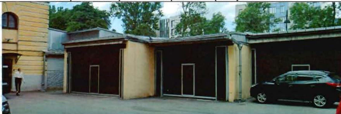
6. Фрагмент северной части ограды со стороны двора
