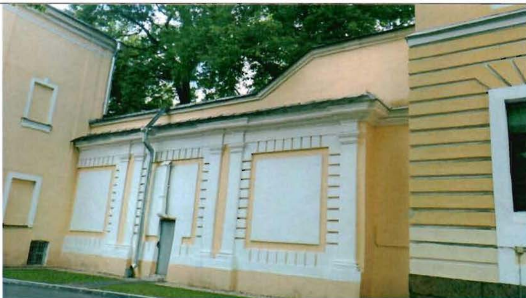
1. Южная часть ограды
