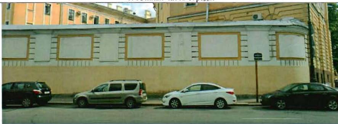
2. Фрагмент северной части ограды со стороны ул. Смольного
