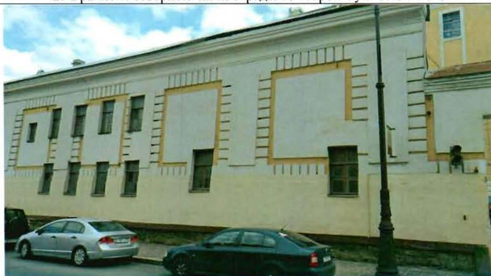
3. Фрагмент северной части ограды со стороны ул. Смольного
