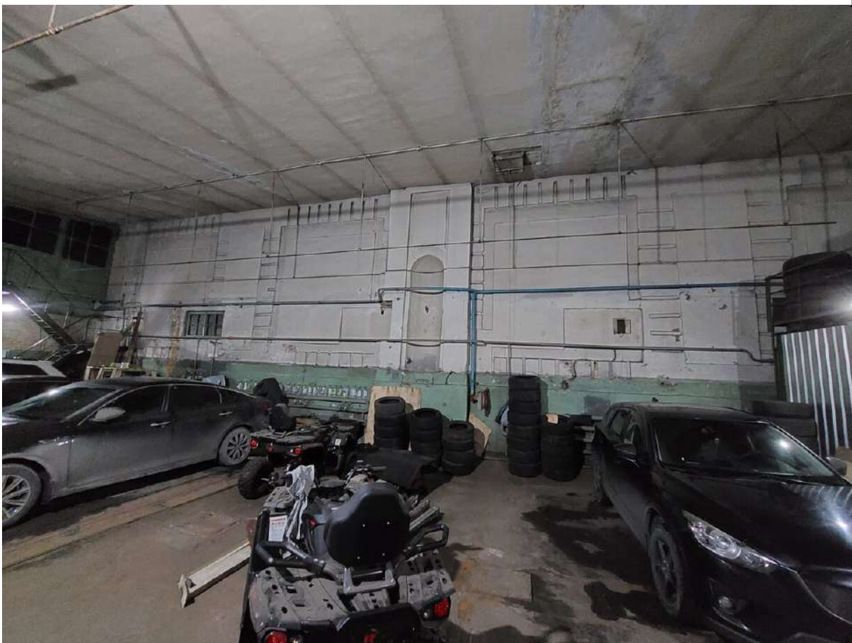
Фото 15. Общий вид на объект со стороны интерьера объекта капитального строительства, пристроенного к нему. Дата фотофиксации: 20.02.2026г.
