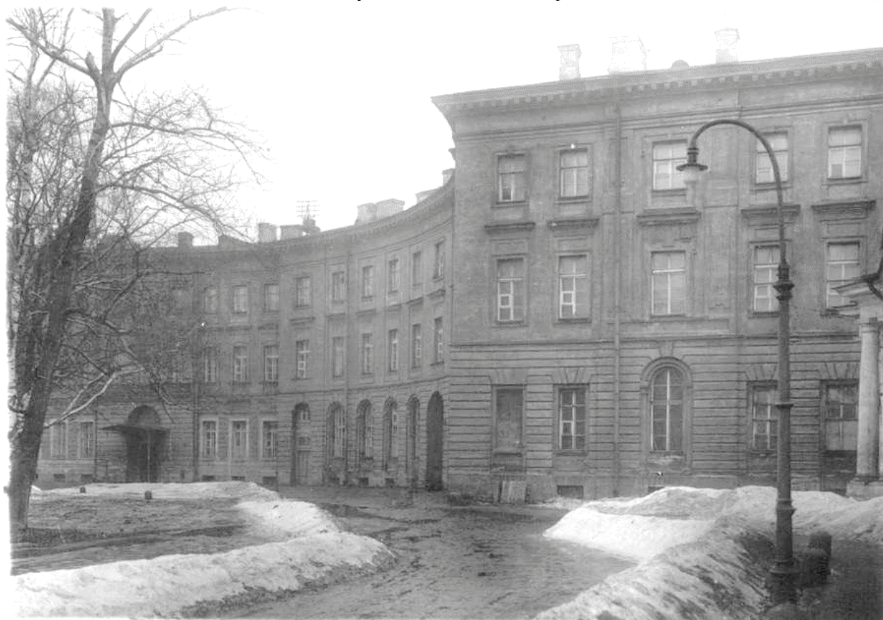
Рисунок 4.30 – Вид части фасада здания бывшего Александровского института, 1932 г. ЦГАКФФД СПб. Фотодокументы. Оп.1ГР-31. Ед.хр.45934
