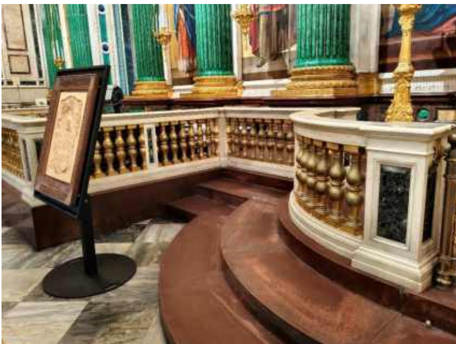
31. «Собор» (в составе «Собор Исаакиевский»), Исаакиевская площадь, д.4, лит. А. Балюстрада соли и решетки амвона. Фрагмент. Фото 02.12.2025г.
