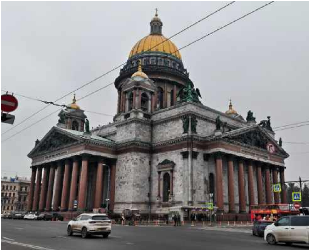
1. «Собор» (в составе «Собор Исаакиевский»), Исаакиевская площадь, д.4, лит. А. Общий вид с юго-востока. Фото 02.12.2025г.
