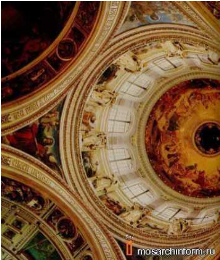
40. Центральный неф. Купол. Фото 1960-е гг. После реставрации. /Восстановление памятников архитектуры Ленинграда. - Л., 1989. С.422
