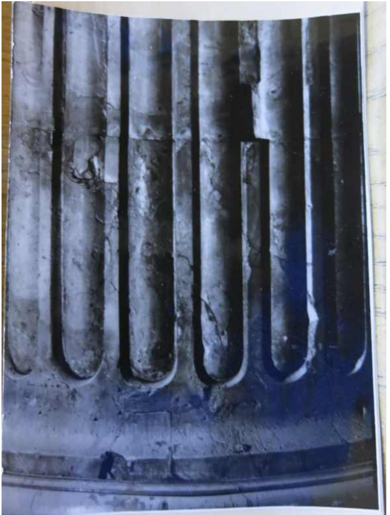
44. Фуст колонны главного иконостаса. Сектор хранения документированной информации (архив) КГИОП. П-59. Фототека. 1980 г.
