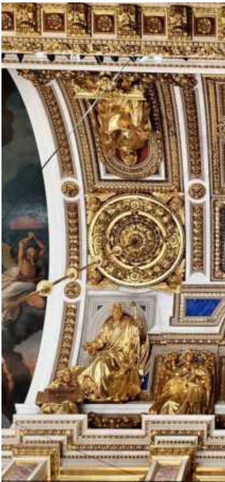
4. «Собор» (в составе «Собор Исаакиевский»), Исаакиевская площадь, д.4, лит. А. Южная подпружная арка. Общий вид. Фото 02.12.2025г.
