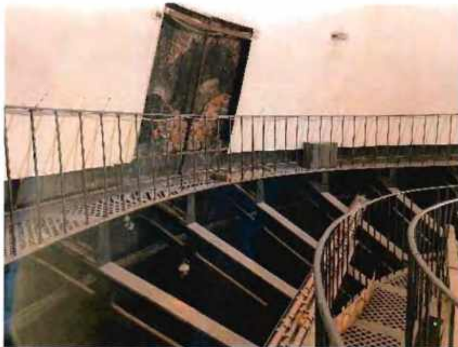
3. Заполнение конической части купола объекта культурного наследия. Фото от 05.07.2022.
