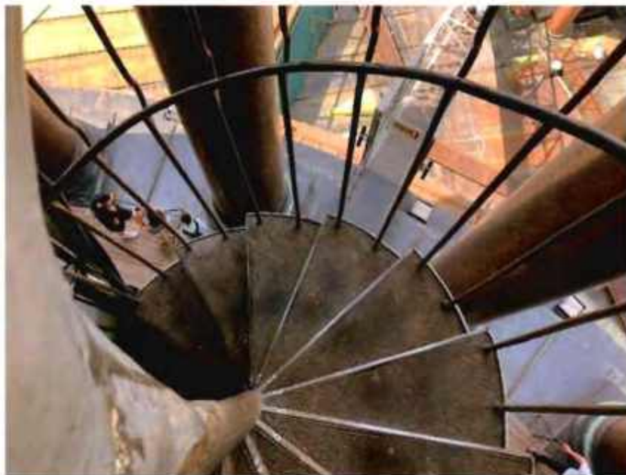
4. Наружная винтовая металлическая лестница объекта культурного наследия. Фото от 23.06.2022.
