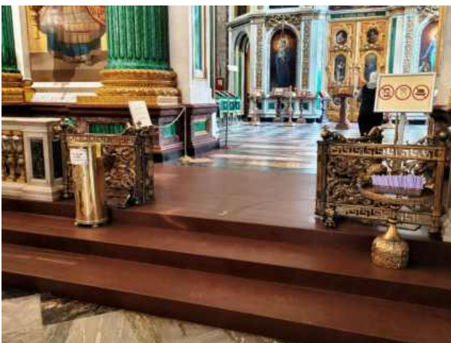
26. «Собор» (в составе «Собор Исаакиевский»), Исаакиевская площадь, д.4, лит. А. Балюстрада соли и решетки амвона. Фрагмент. Фото 02.12.2025г.
