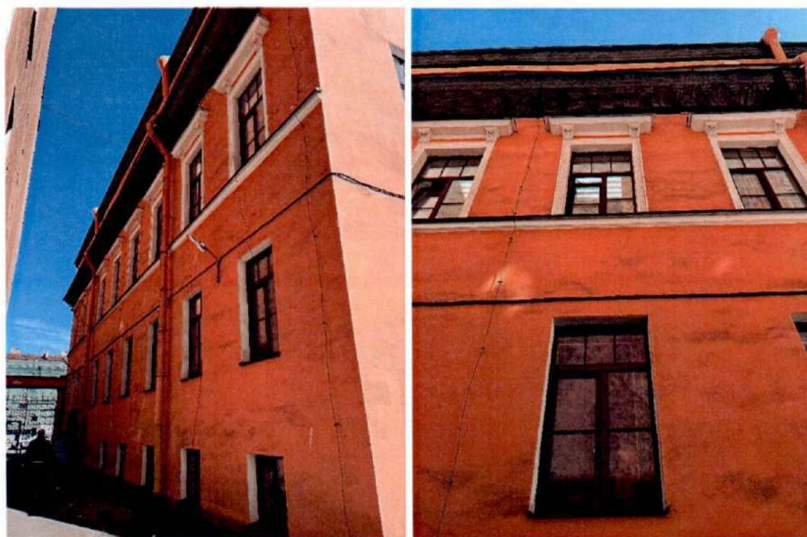
Фото 4, 5. Западный фасад объекта культурного наследия.
