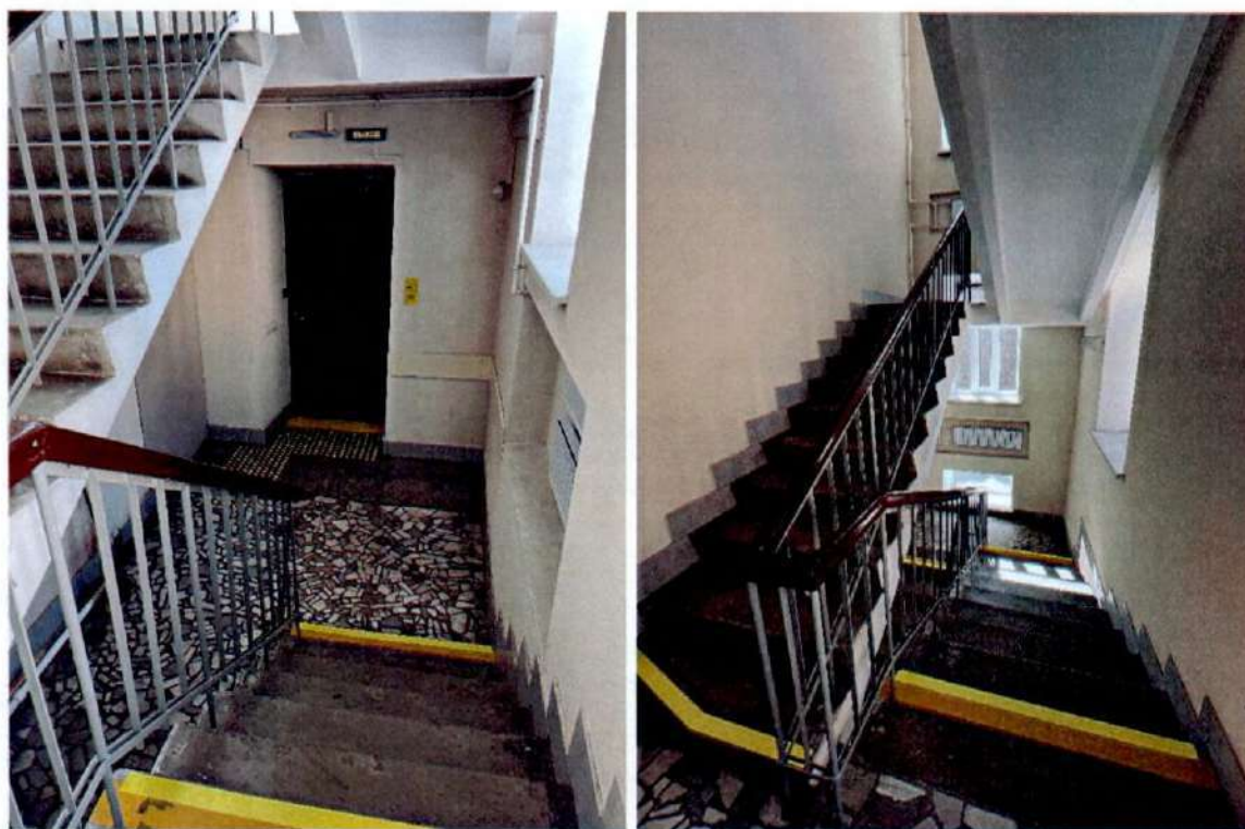
Фото 19, 20. Лестница Л-2 объекта культурного наследия.
