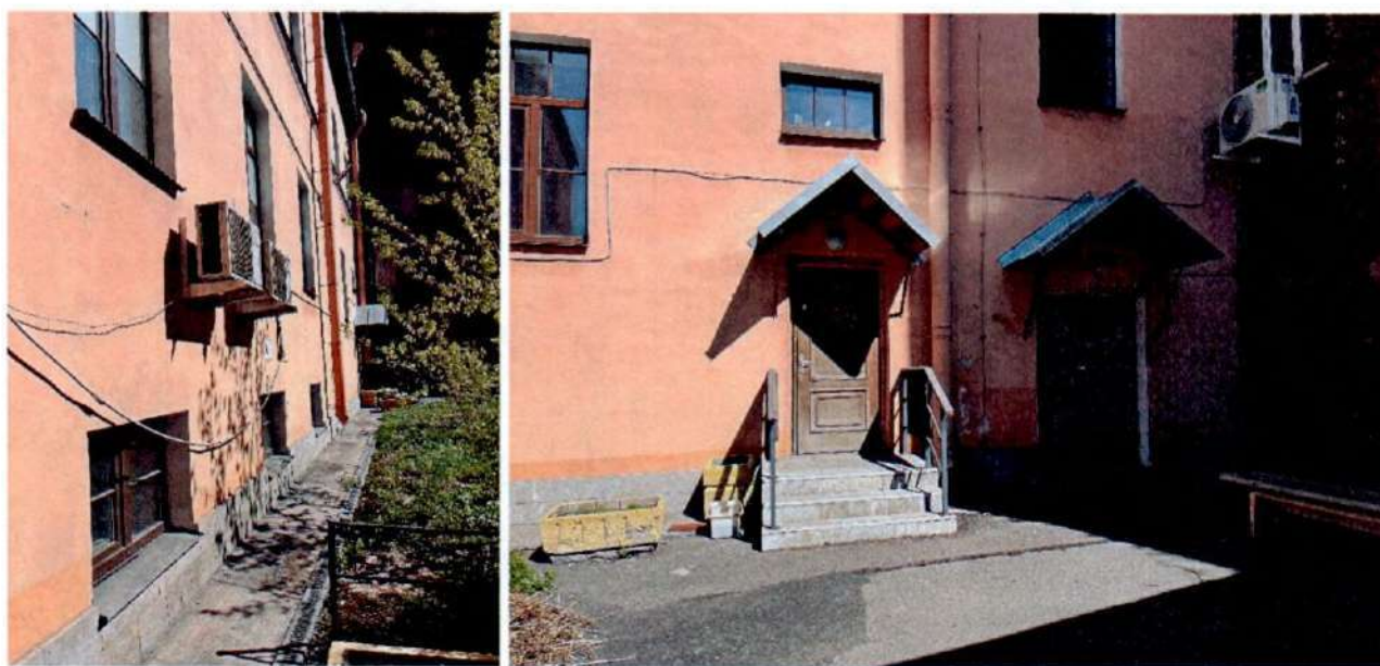
Фото 18, 19. Фрагменты дворового фасада объекта культурного наследия, восточная часть.
