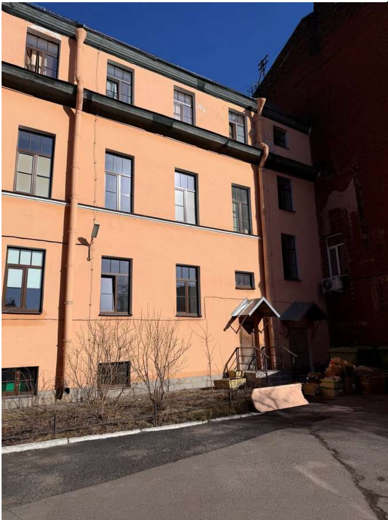
Фото 13. Общий вид на лицевой корпус. Дата фотофиксации: 14.03.2026г.
