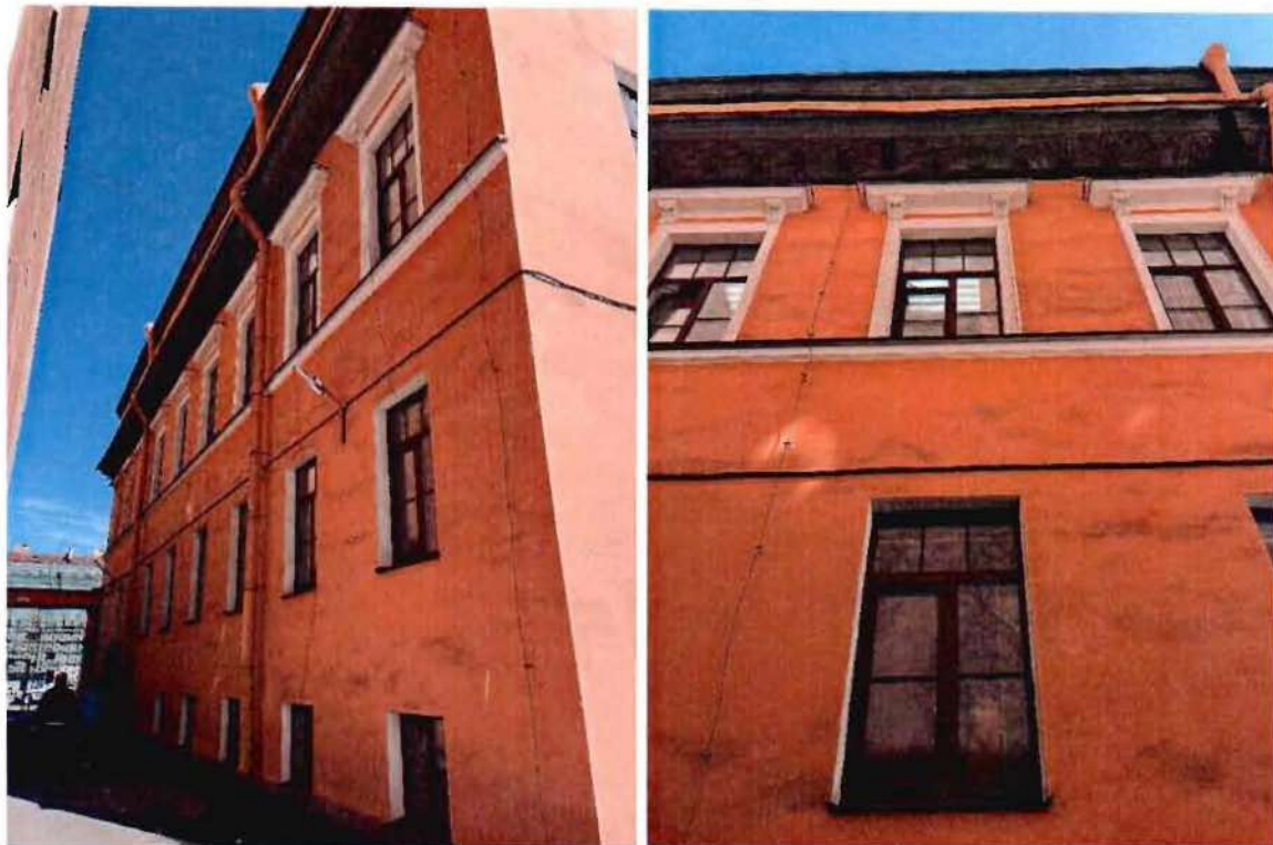
4, 5. Западный фасад объекта культурного наследия.
