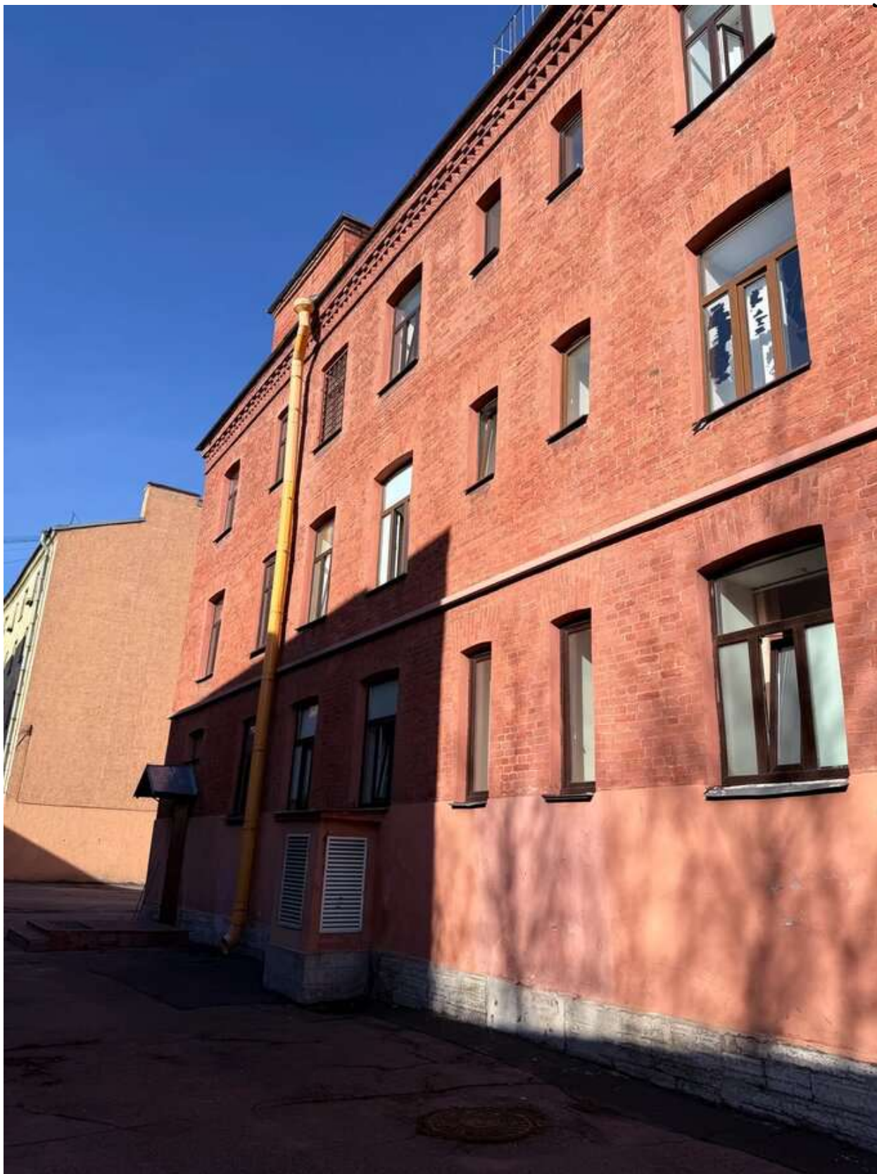
Фото 40. Общий вид на дворовой корпус. Дата фотофиксации: 14.03.2026г.
