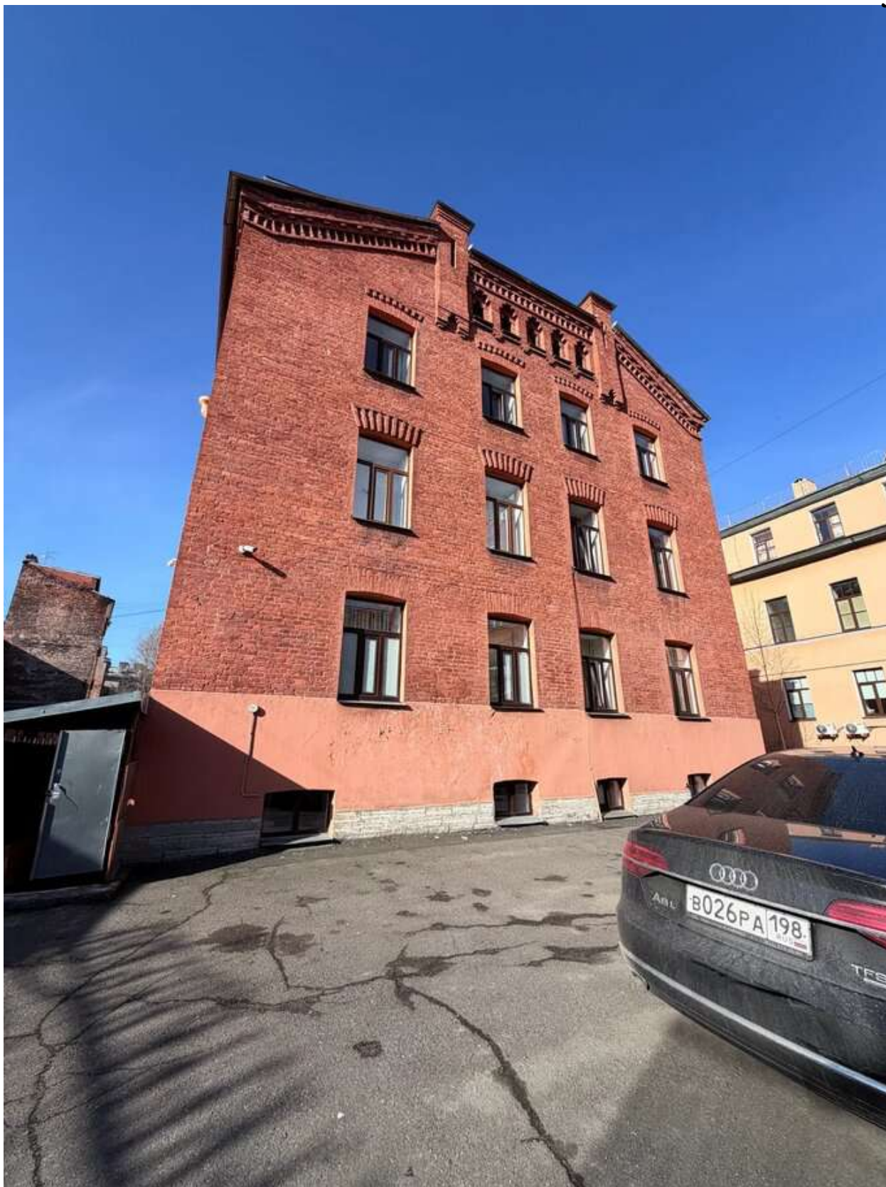
Фото 45. Общий вид на дворовой корпус. Дата фотофиксации: 14.03.2026г.
