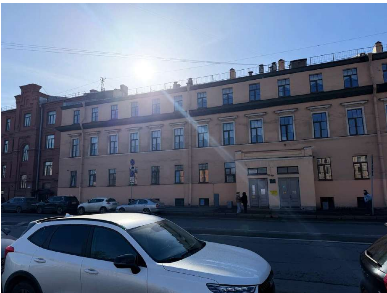
Фото 8. Общий вид на лицевой корпус. Дата фотофиксации: 14.03.2026г.
