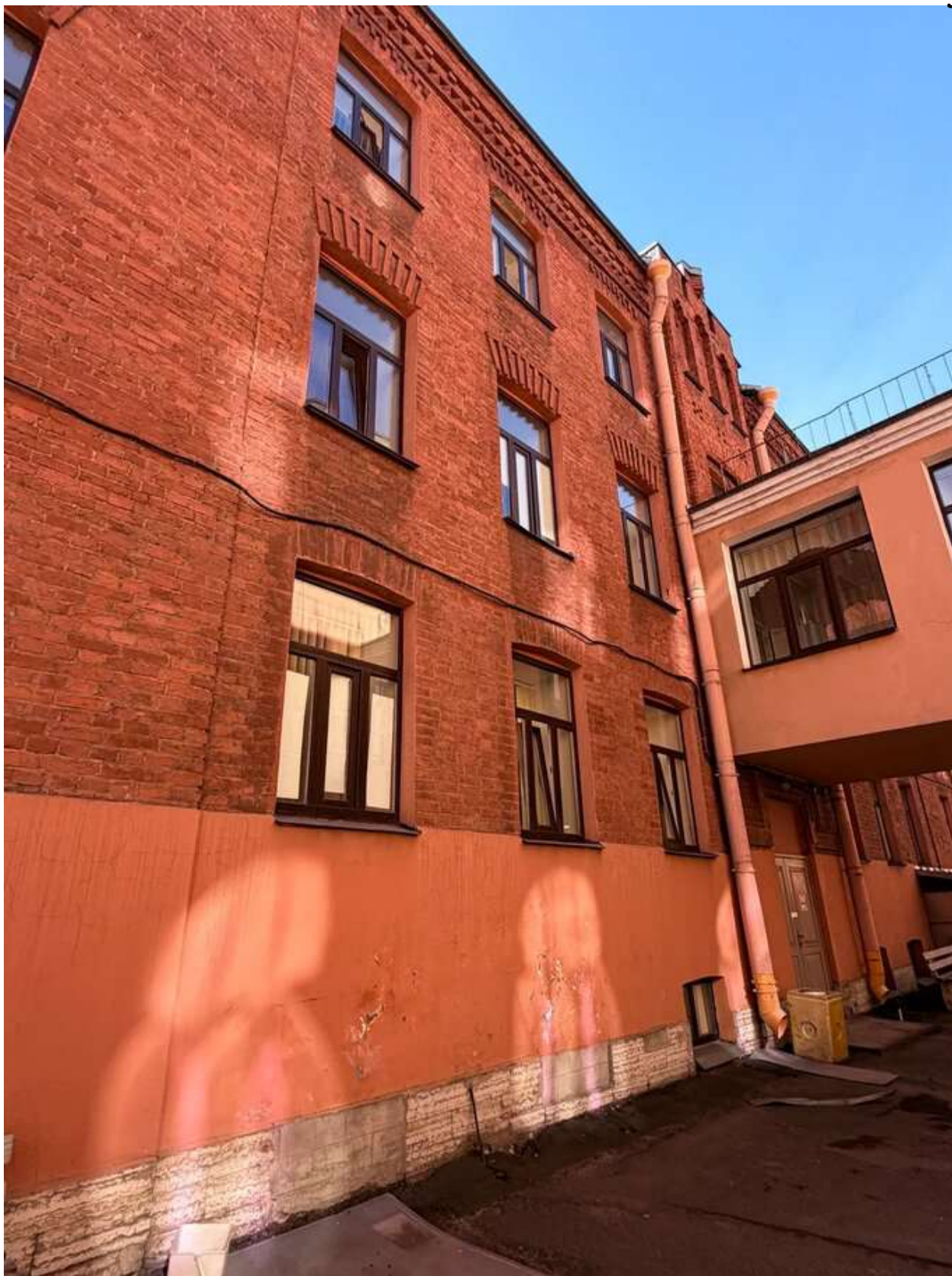
Фото 49. Общий вид на дворовой корпус. Дата фотофиксации: 14.03.2026г.
