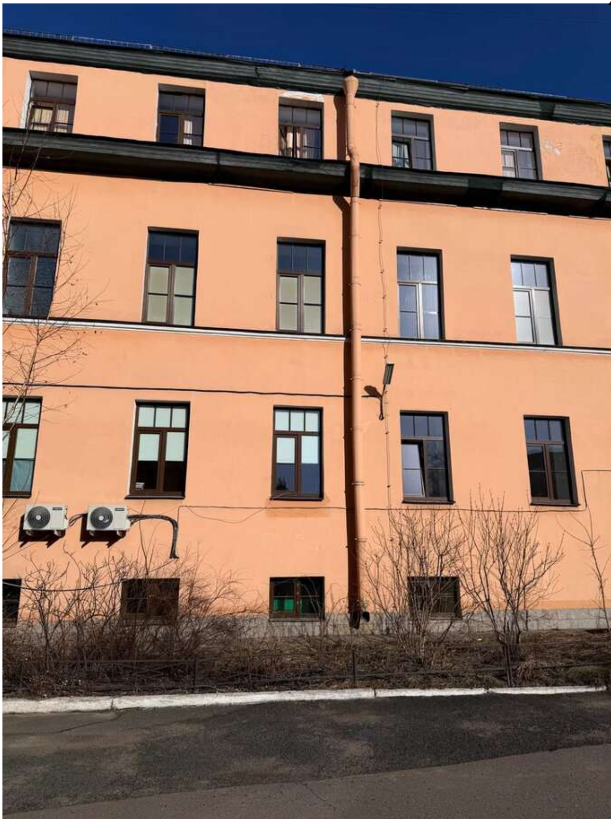
Фото 14. Общий вид на лицевой корпус. Дата фотофиксации: 14.03.2026г.
