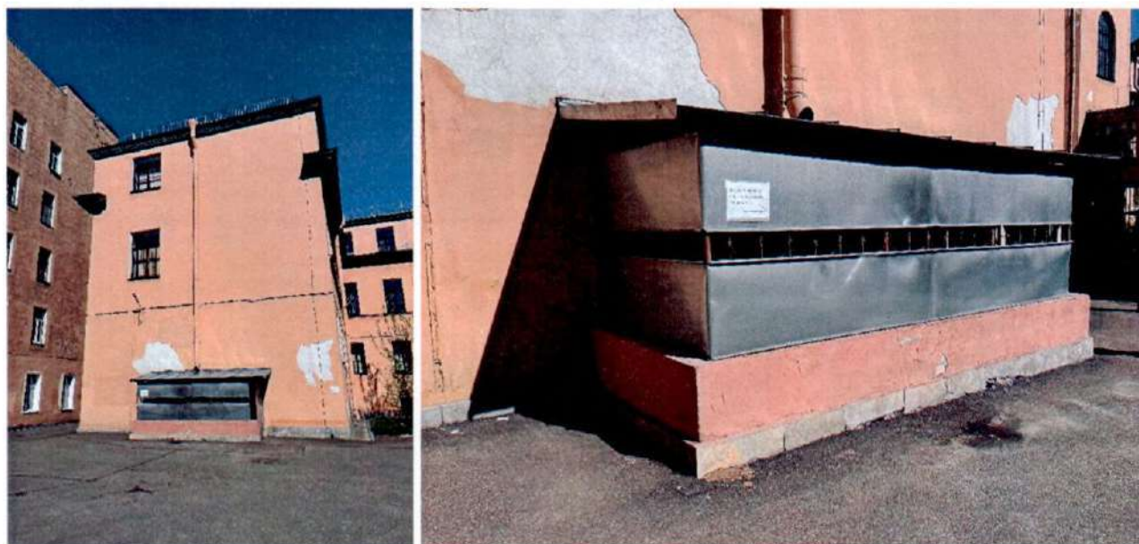
Фото 8, 9. Торцевой южный фасад объекта культурного наследия.
