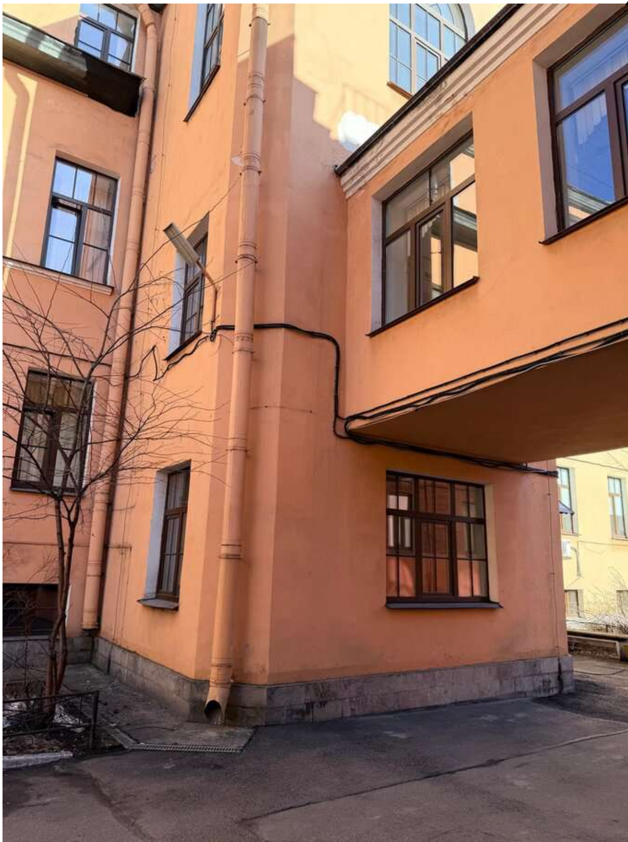
Фото 21. Общий вид на лицевой корпус. Дата фотофиксации: 14.03.2026г.
