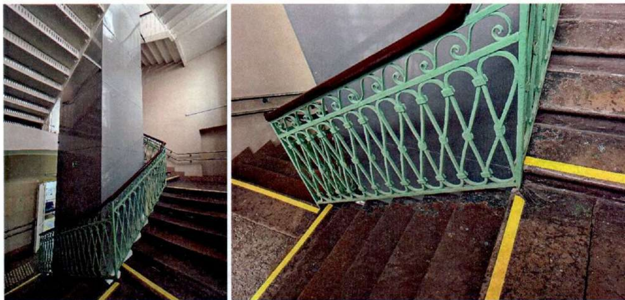
Фото 32, 33. Лестница Л-5 объекта культурного наследия.
