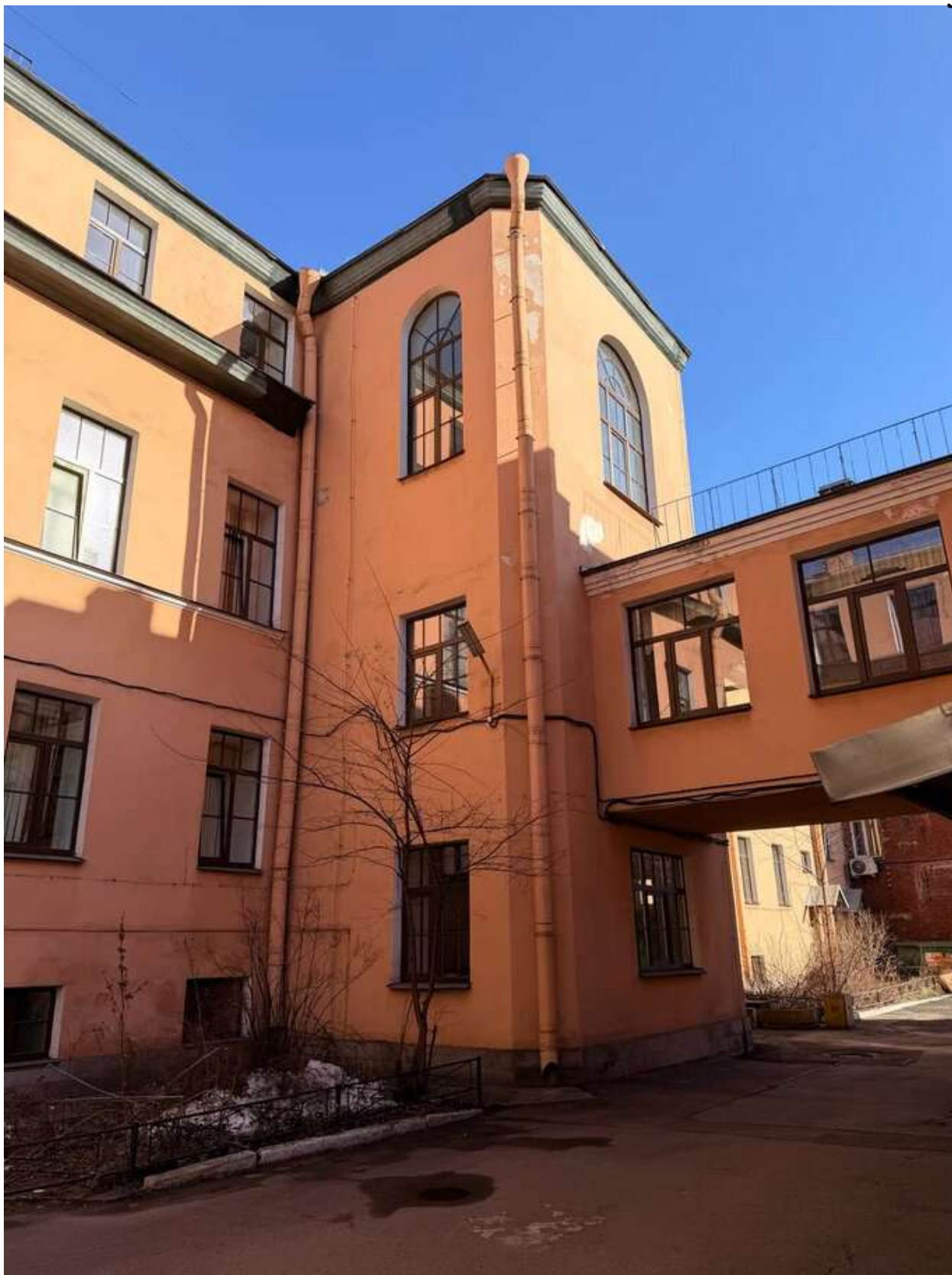
Фото 23. Общий вид на лицевой корпус. Дата фотофиксации: 14.03.2026г.
