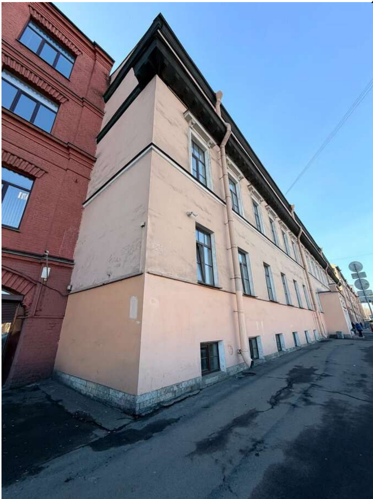
Фото 12. Общий вид на лицевой корпус. Дата фотофиксации: 14.03.2026г.
