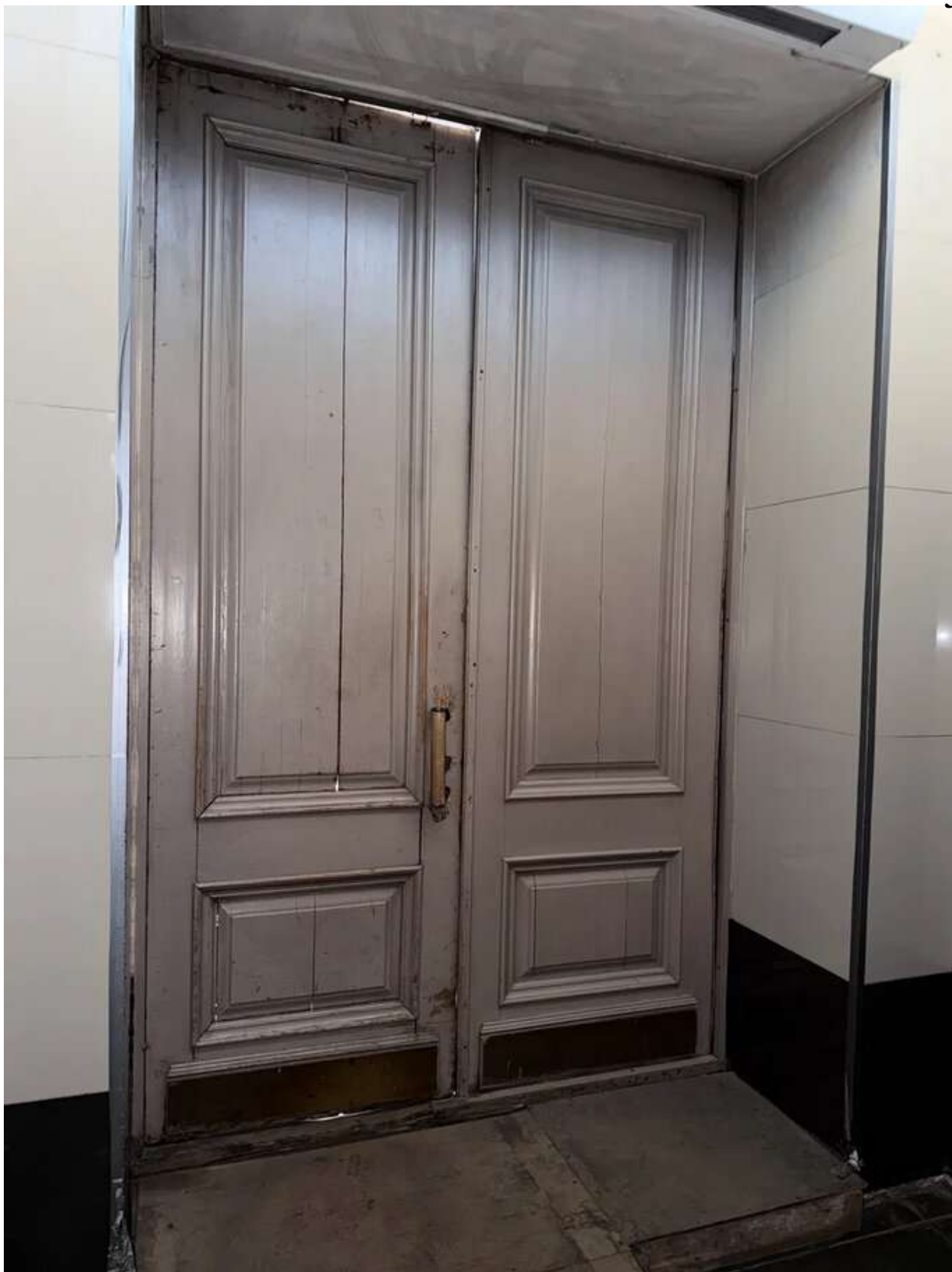
Фото 57. Общий вид интерьера лицевого корпуса (главный вход). Дата фотофиксации: 14.03.2026г.
