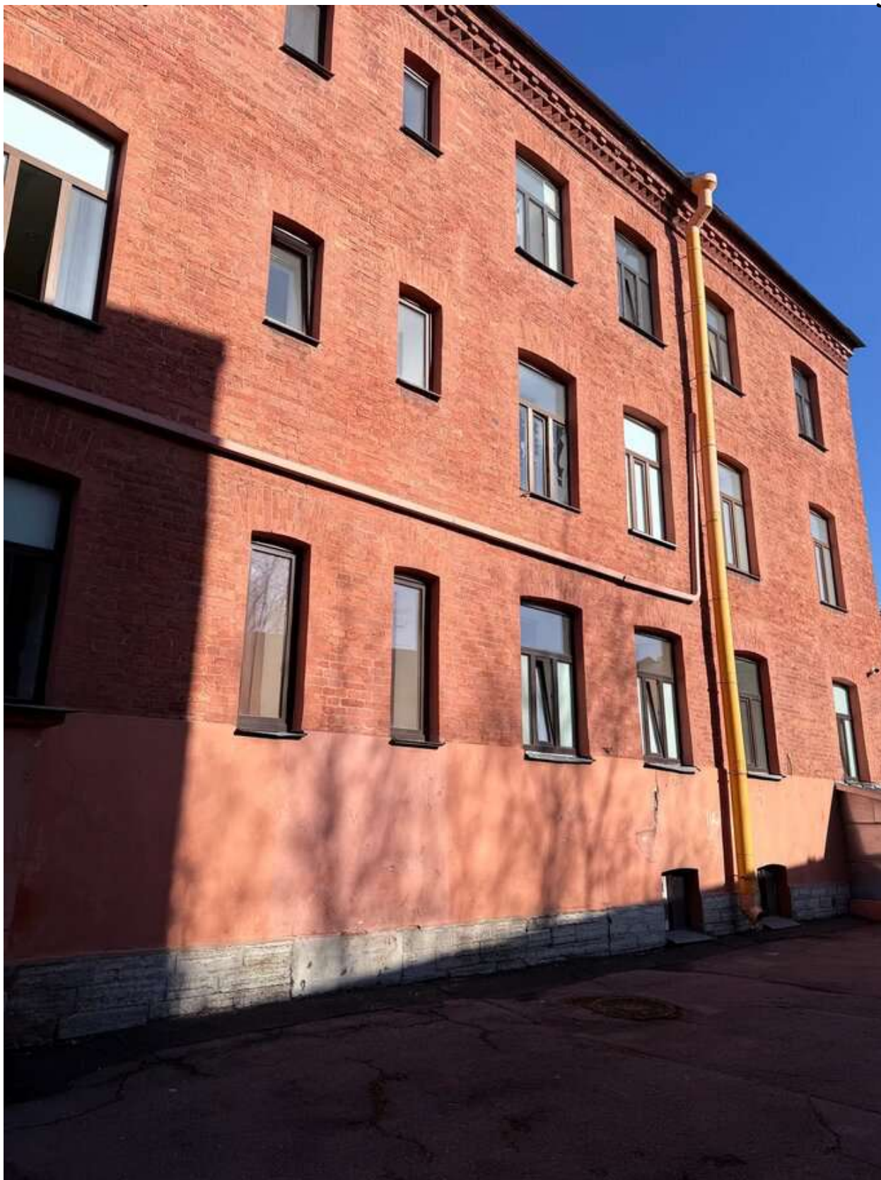
Фото 39. Общий вид на дворовой корпус. Дата фотофиксации: 14.03.2026г.
