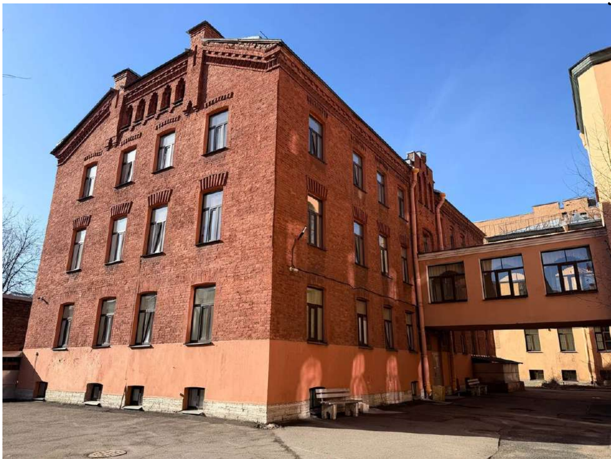
Фото 46. Общий вид на дворовой корпус. Дата фотофиксации: 14.03.2026г.
