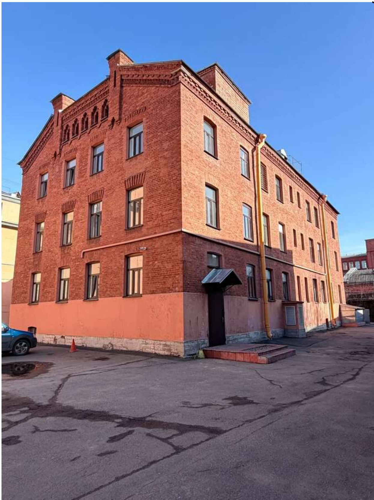
Фото 37. Общий вид на дворовой корпус. Дата фотофиксации: 14.03.2026г.
