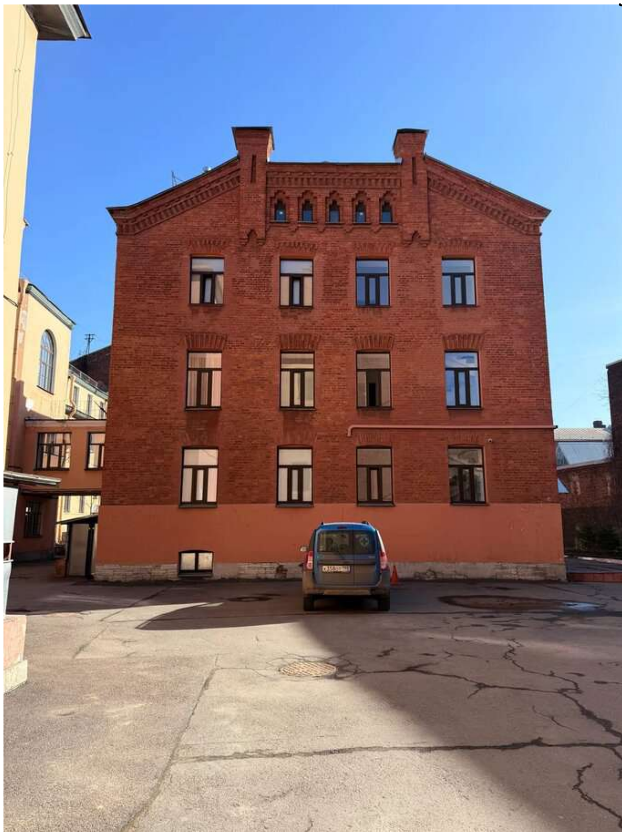
Фото 35. Общий вид на дворовой корпус. Дата фотофиксации: 14.03.2026г.
