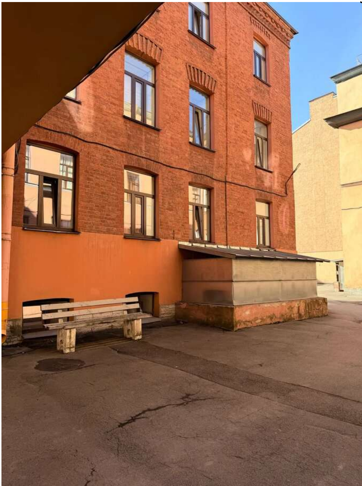
Фото 51. Общий вид на дворовой корпус. Дата фотофиксации: 14.03.2026г.
