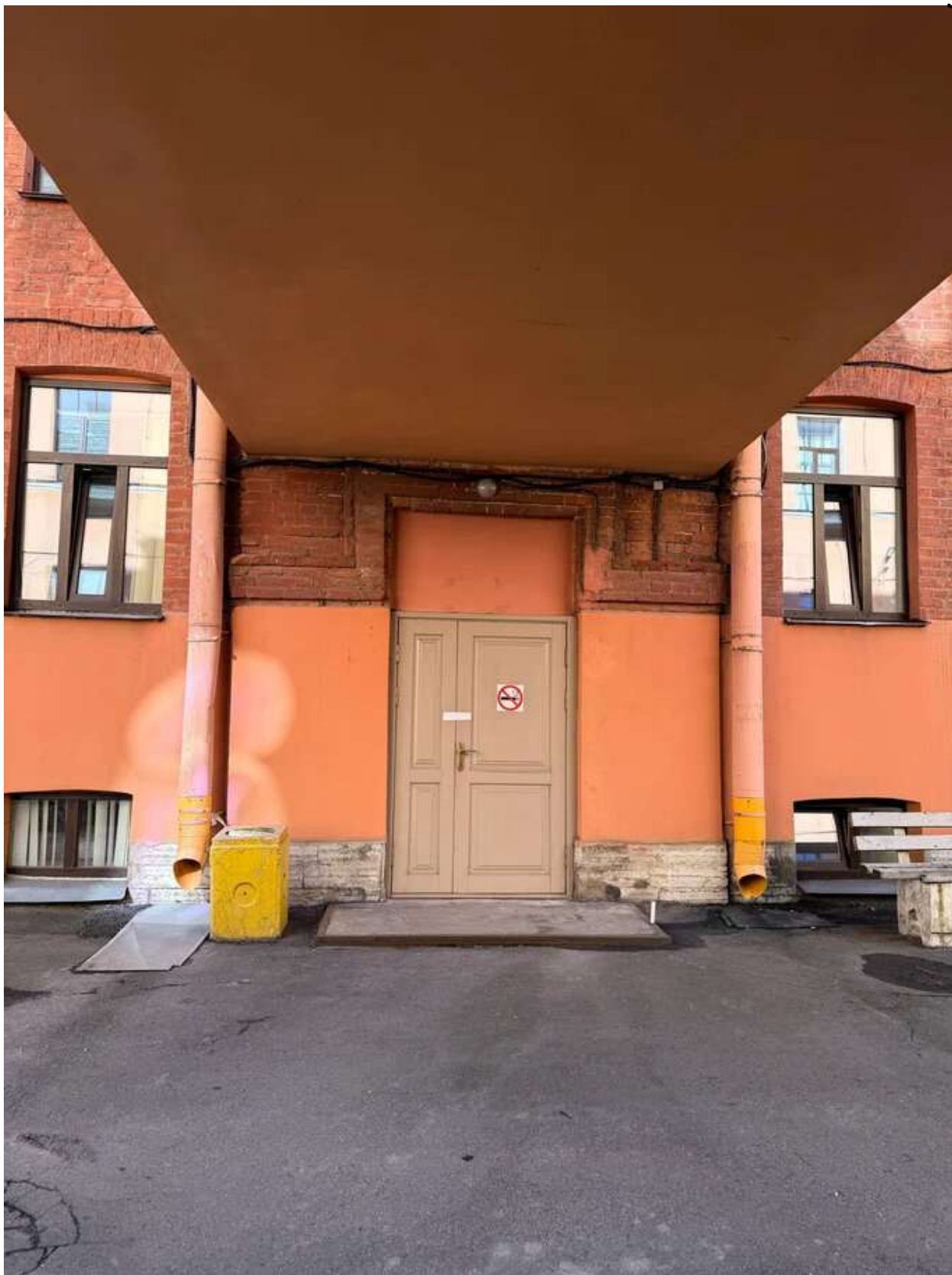
Фото 50. Общий вид на дворовой корпус. Дата фотофиксации: 14.03.2026г.
