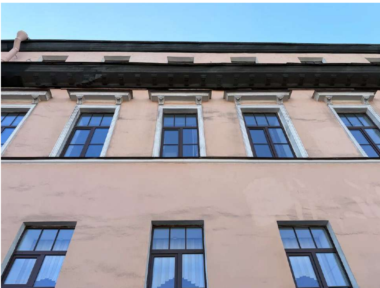
Фото 11. Общий вид на лицевой корпус. Дата фотофиксации: 14.03.2026г.
