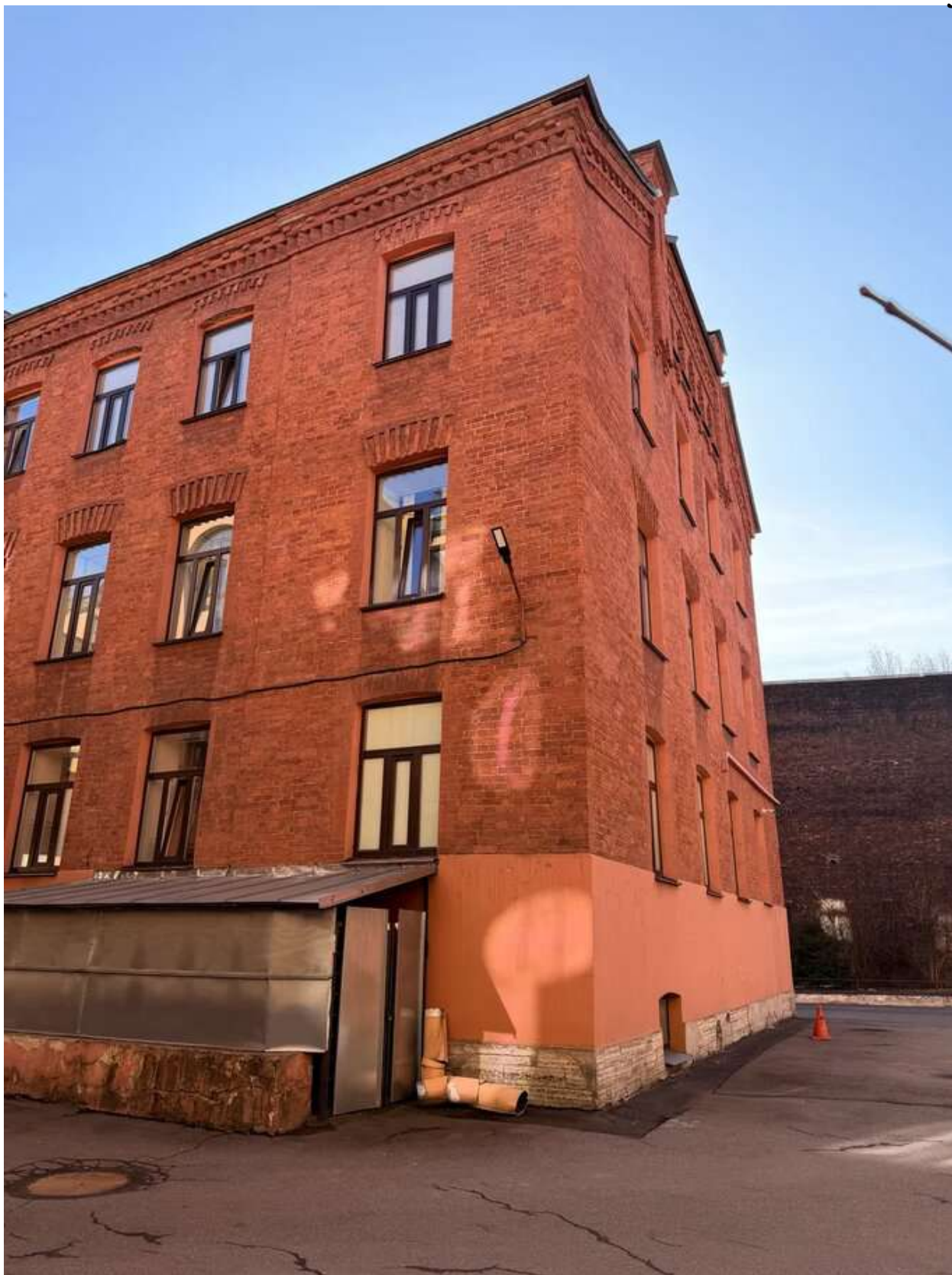
Фото 53. Общий вид на дворовой корпус. Дата фотофиксации: 14.03.2026г.
