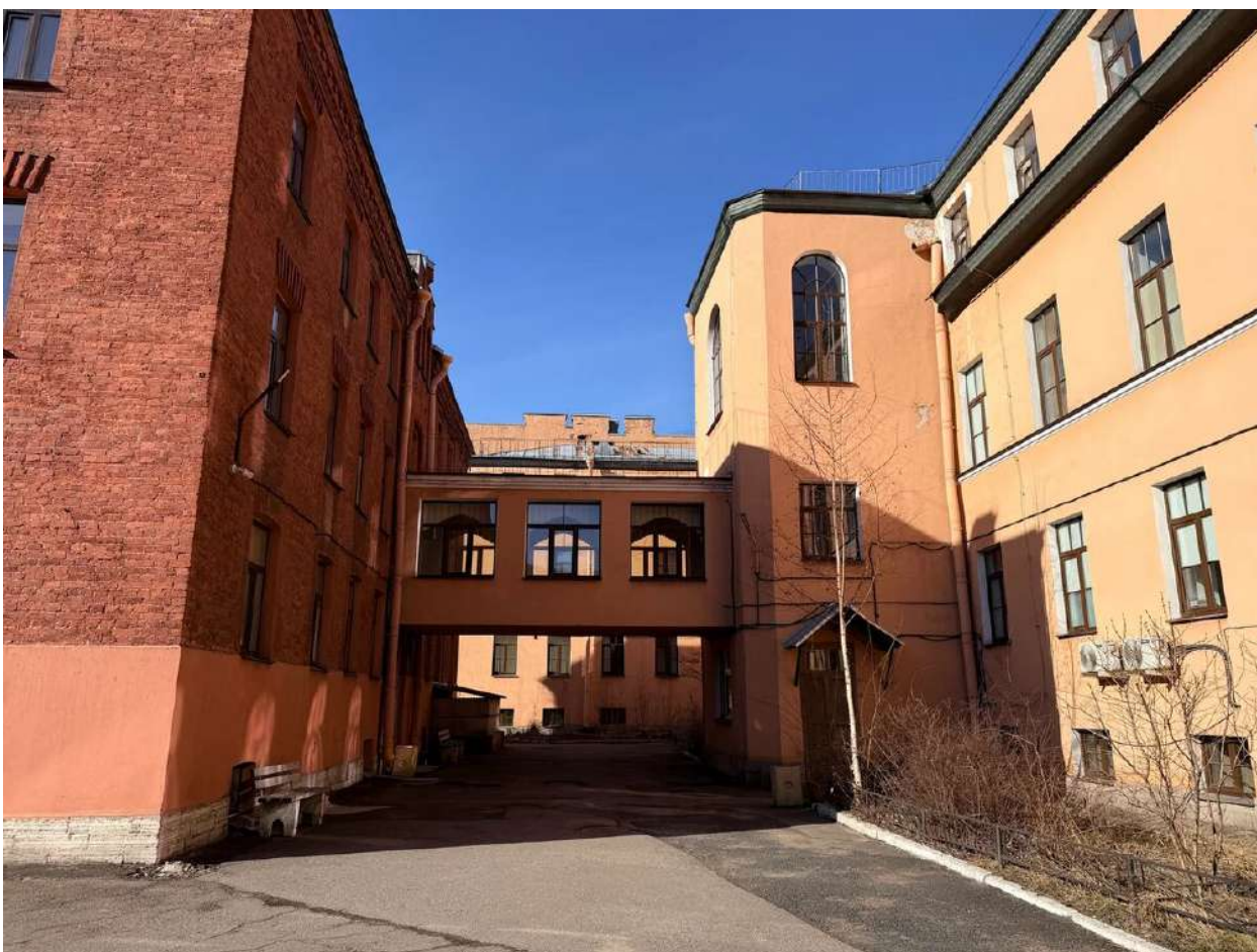
Фото 20. Общий вид на объекты. Дата фотофиксации: 14.03.2026г.
