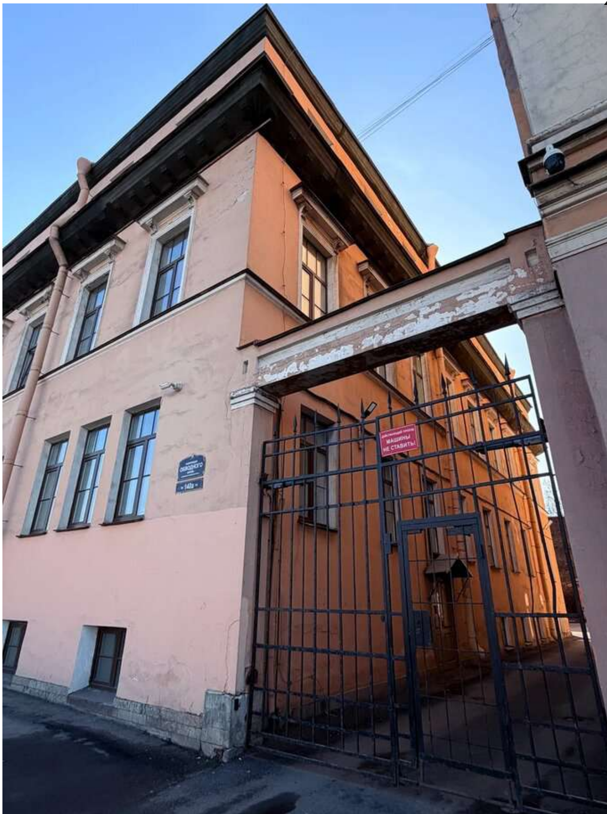
Фото 9. Общий вид на лицевой корпус. Дата фотофиксации: 14.03.2026г.
