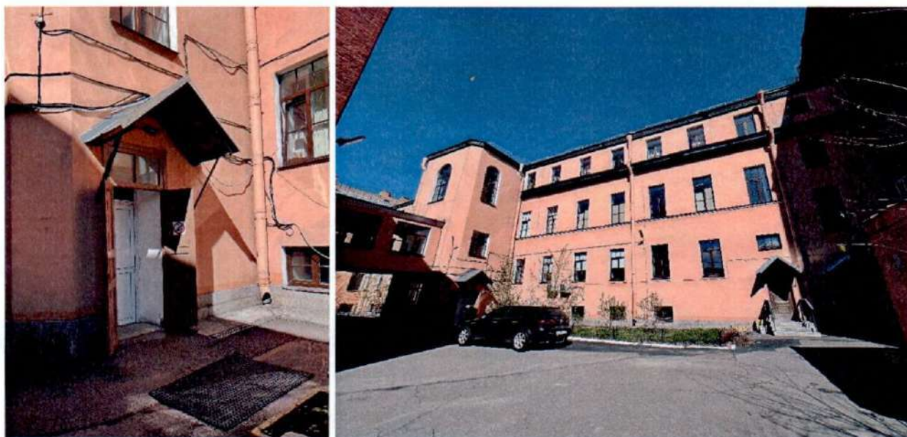
Фото 16. Крыльцо с восточной стороны ризалита со стороны дворовых фасадов объекта культурного наследия.
