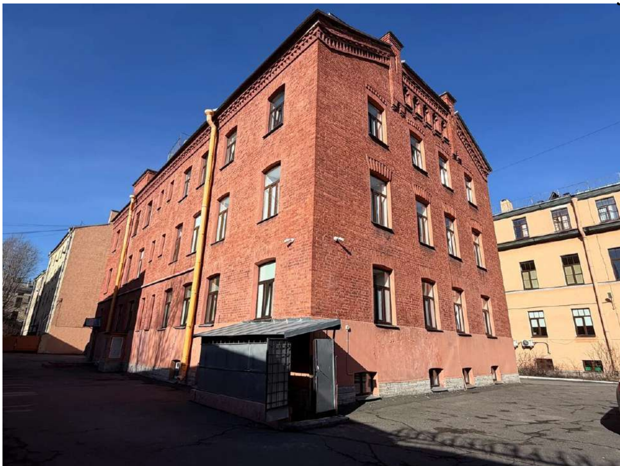
Фото 42. Общий вид на дворовой корпус. Дата фотофиксации: 14.03.2026г.
