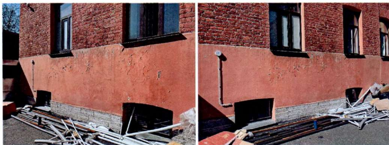
Фото 6, 7. Фрагмент цокольного этажа восточного фасада объекта культурного наследия.
