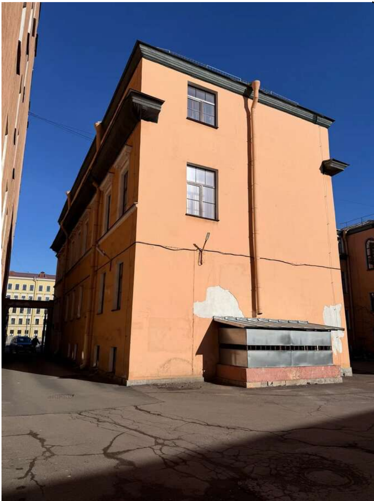
Фото 31. Общий вид на лицевой корпус. Дата фотофиксации: 14.03.2026г.
