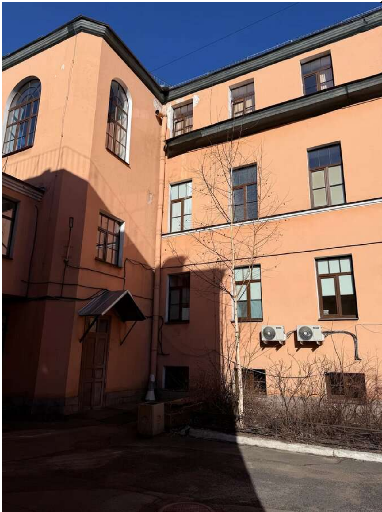
Фото 15. Общий вид на лицевой корпус. Дата фотофиксации: 14.03.2026г.
