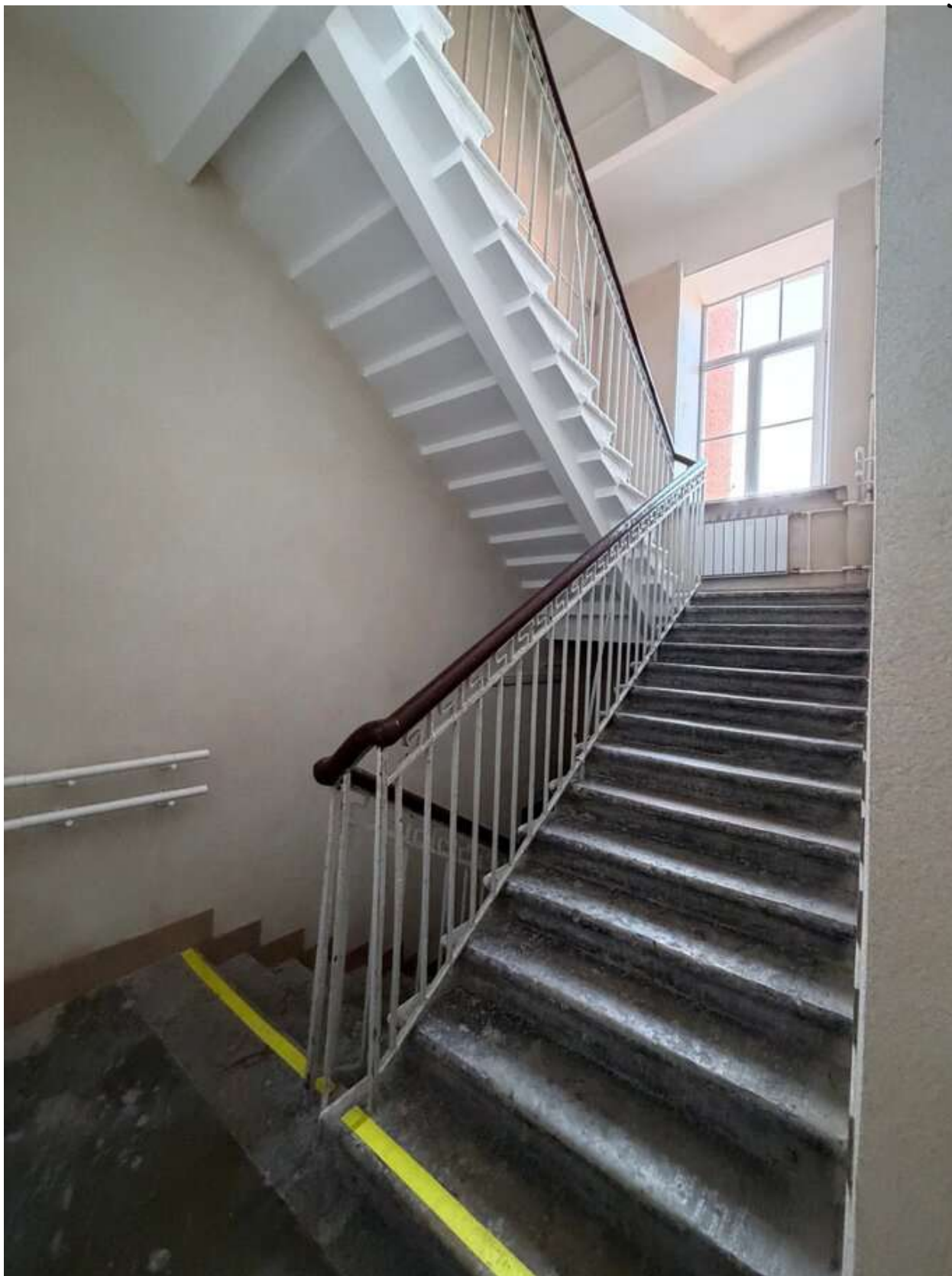
Фото 62. Общий вид интерьера лицевого корпуса. Дата фотофиксации: 14.03.2026г.
