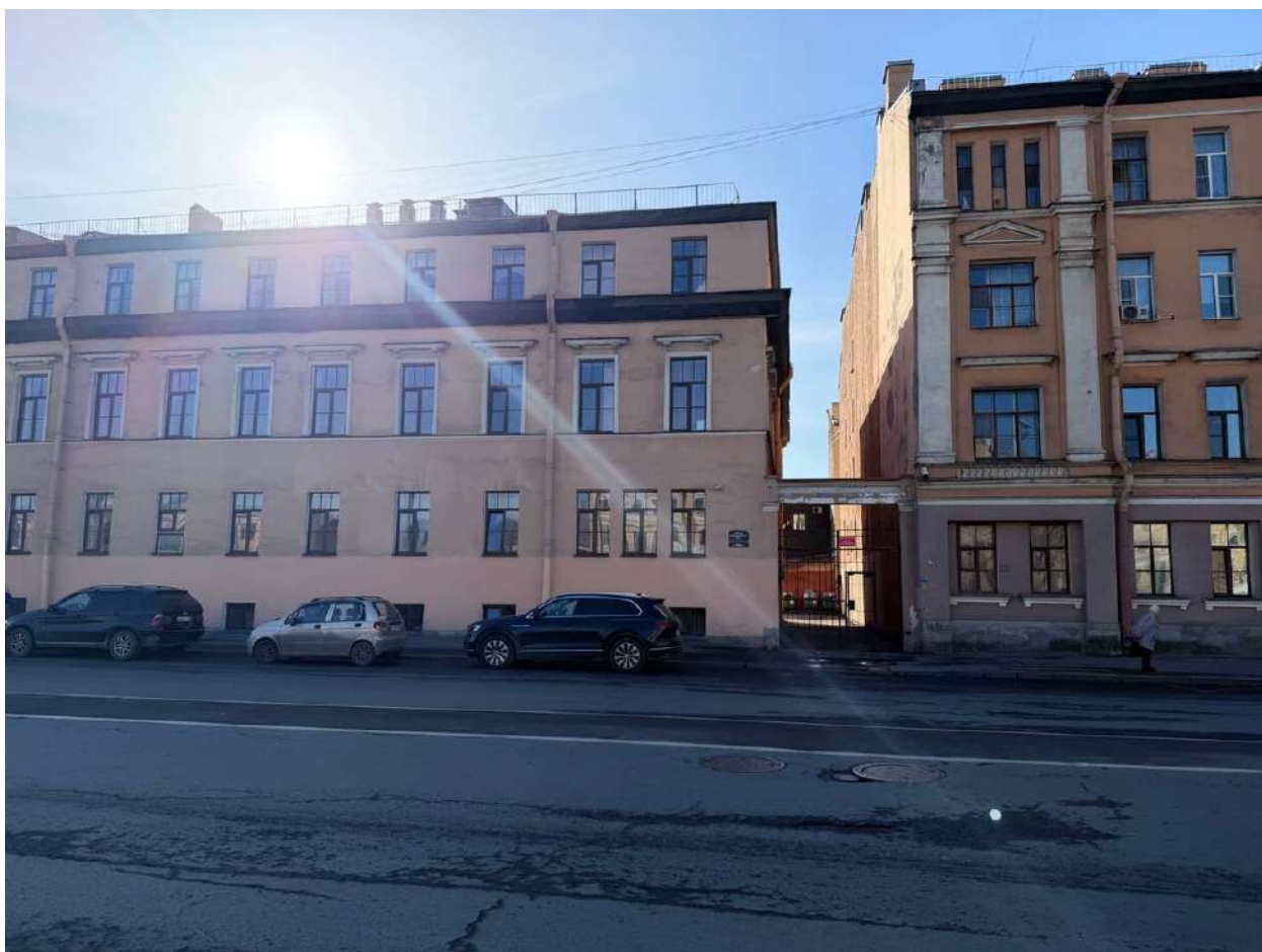
Фото 2. Общий вид на лицевой корпус. Дата фотофиксации: 14.03.2026г.
