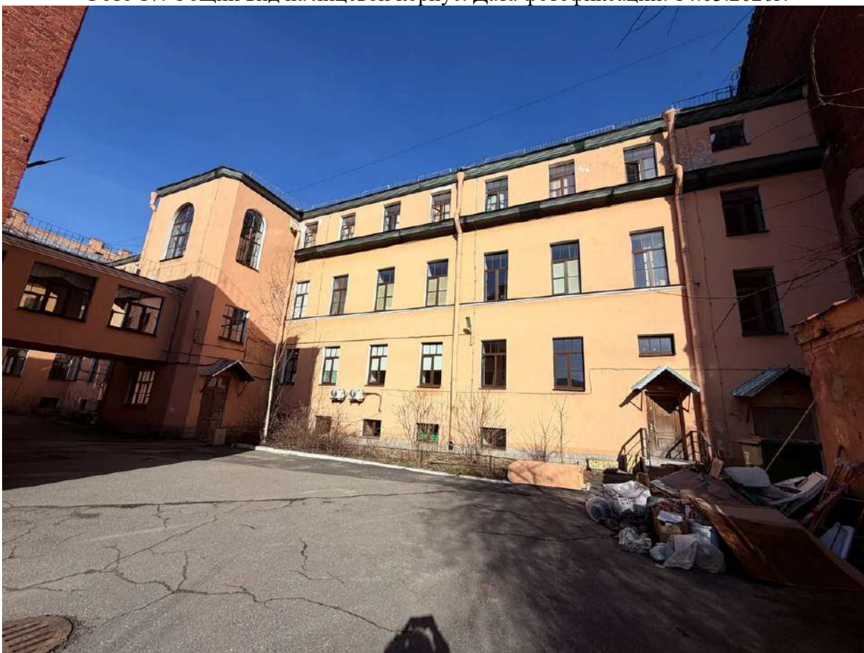
Фото 18. Общий вид на лицевой корпус. Дата фотофиксации: 14.03.2026г.
