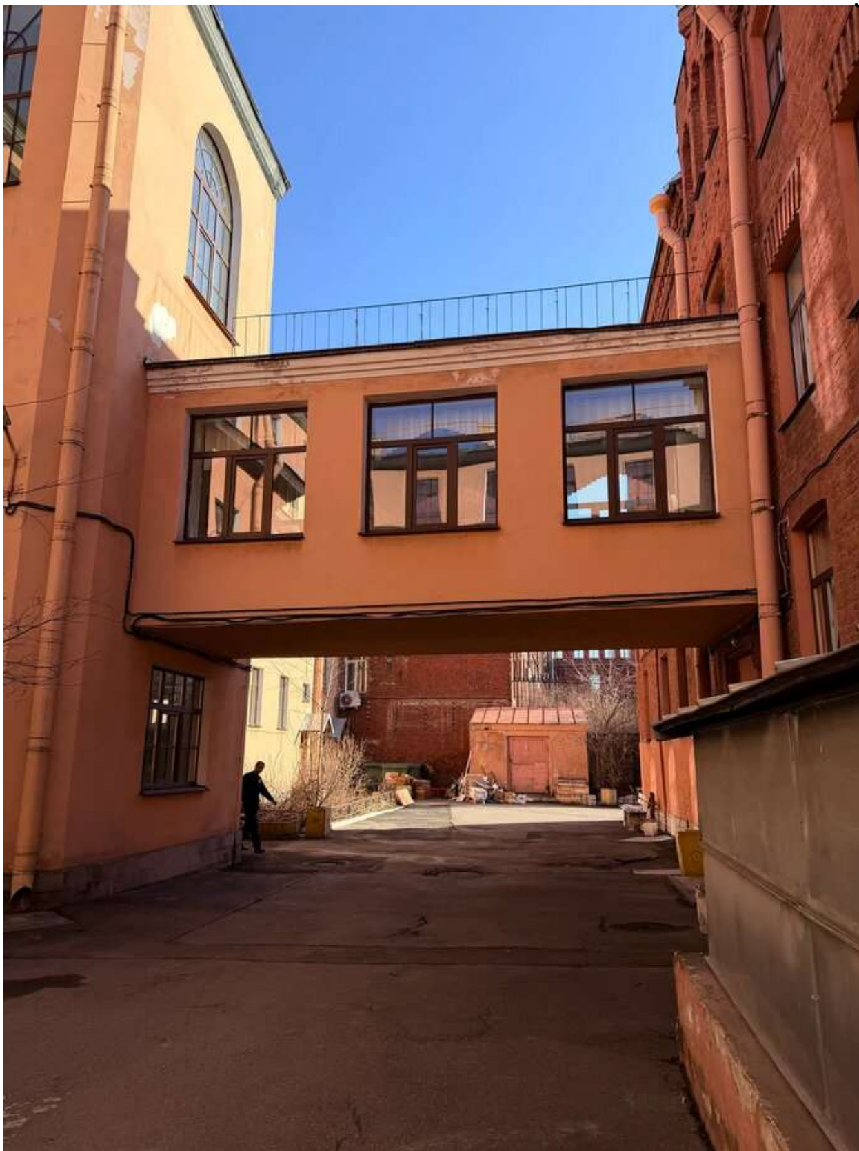
Фото 22. Общий вид на переход между лицевым и дворовым корпусами. Дата фотофиксации: 14.03.2026г.
