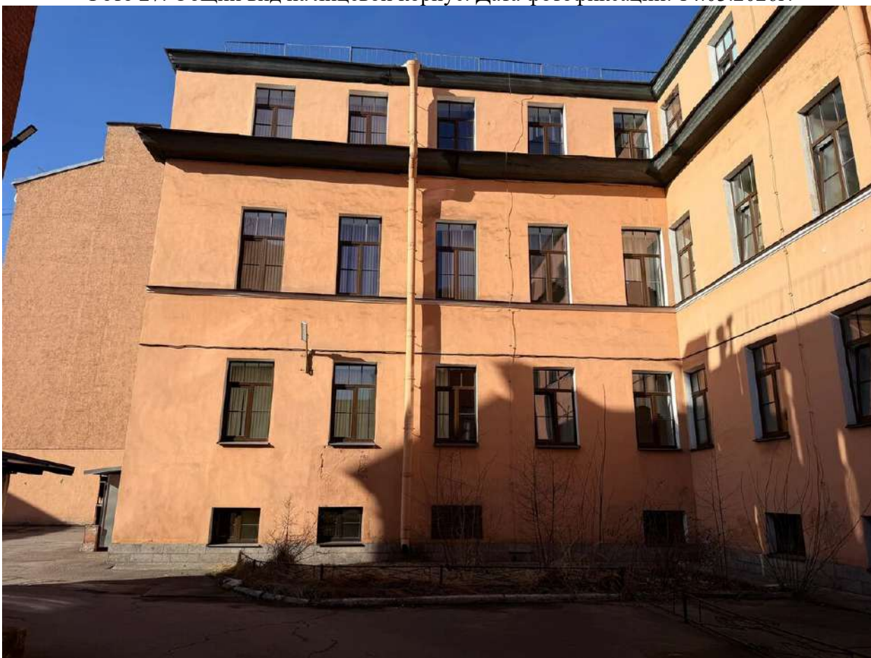
Фото 28. Общий вид на лицевой корпус. Дата фотофиксации: 14.03.2026г.
