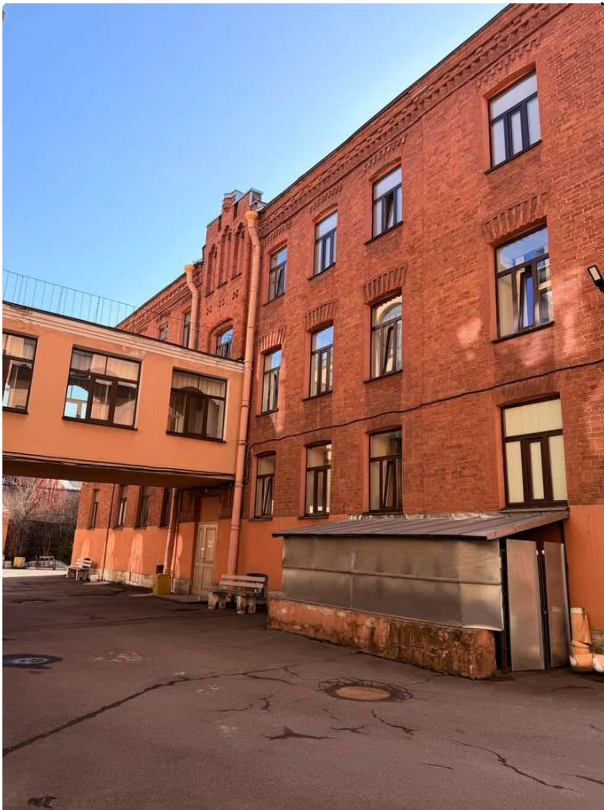
Фото 54. Общий вид на дворовой корпус. Дата фотофиксации: 14.03.2026г.
