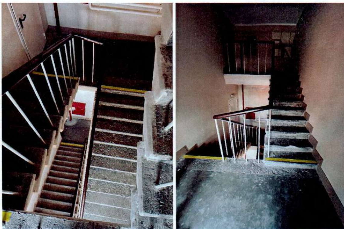
Фото 34, 35. Лестница Л-4 объекта культурного наследия.
