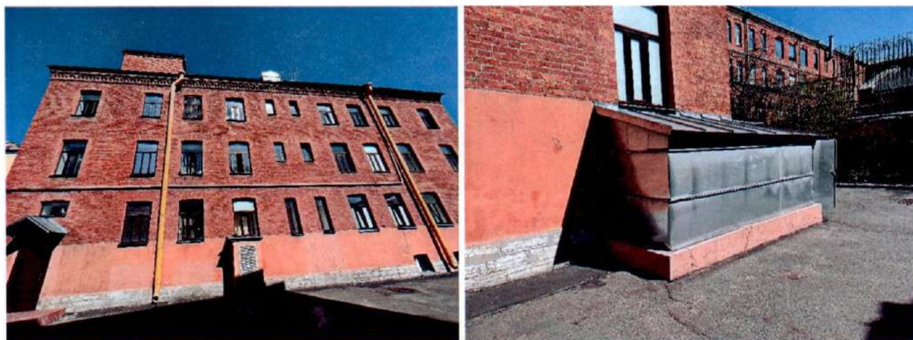
Фото 15, 16. Южный фасад и приямок со стороны южного фасада объекта культурного наследия.
