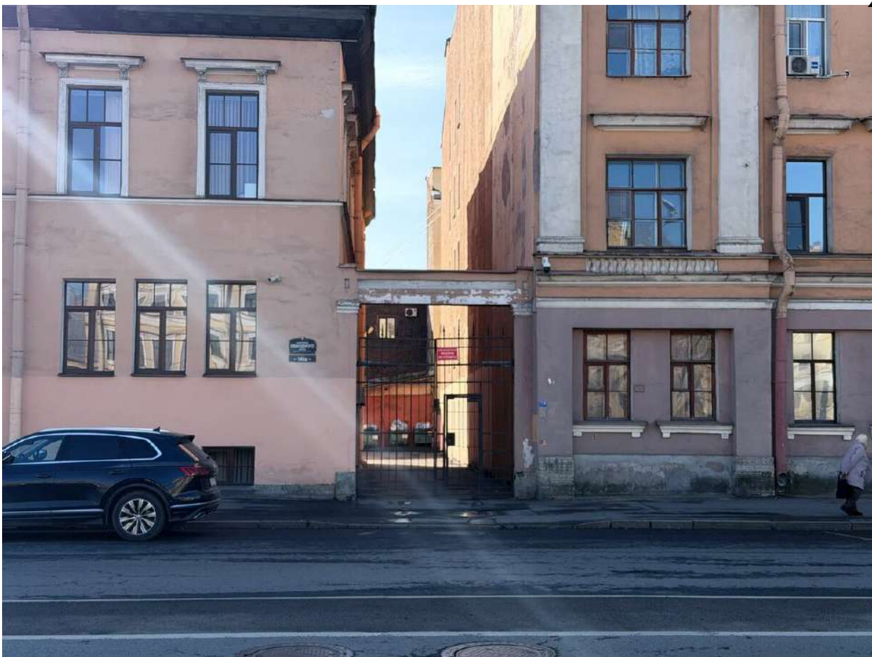
Фото 3. Общий вид на лицевой корпус. Дата фотофиксации: 14.03.2026г.
