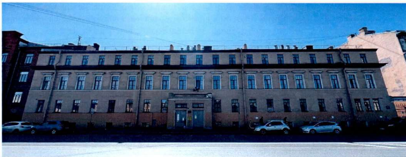
Фото 1. Общий вид на лицевой фасад объекта культурного наследия по наб. Обводного канала.
