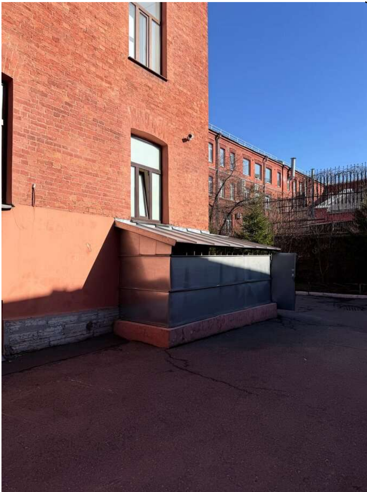
Фото 41. Общий вид на дворовой корпус. Дата фотофиксации: 14.03.2026г.
