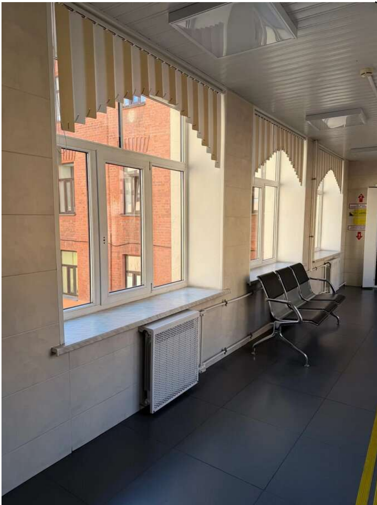
Фото 55. Общий вид перехода между дворовым и лицевым корпусами. Дата фотофиксации: 14.03.2026г.
