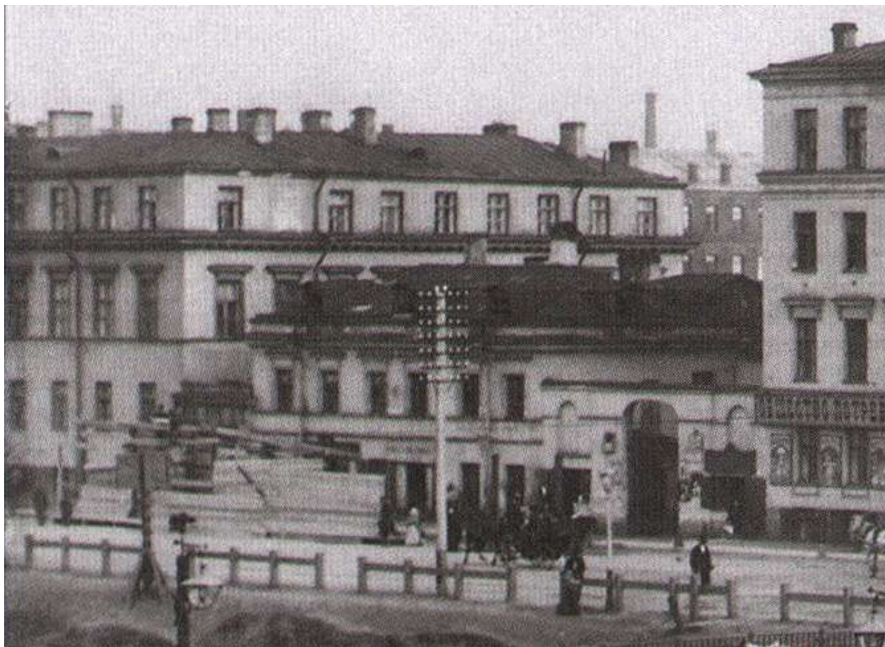
Фрагмент снимка со зданием по адресу: наб. Обводного канала, д. 140.
