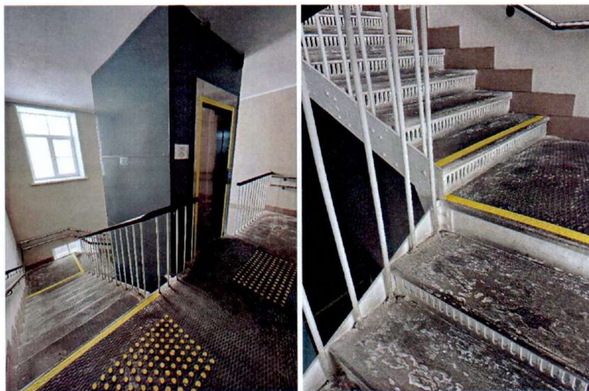
Фото 30, 31. Лестница Л-5 объекта культурного наследия.
