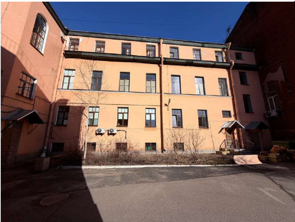
Фото 17. Общий вид на лицевой корпус. Дата фотофиксации: 14.03.2026г.
