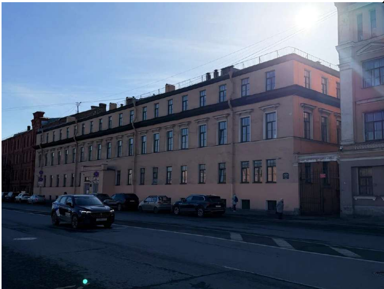
Фото 1. Общий вид на лицевой корпус. Дата фотофиксации: 14.03.2026г.
