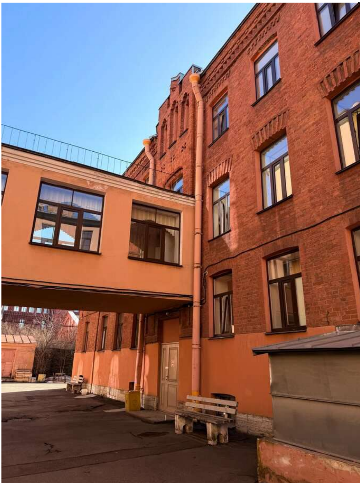
Фото 52. Общий вид на дворовой корпус. Дата фотофиксации: 14.03.2026г.
