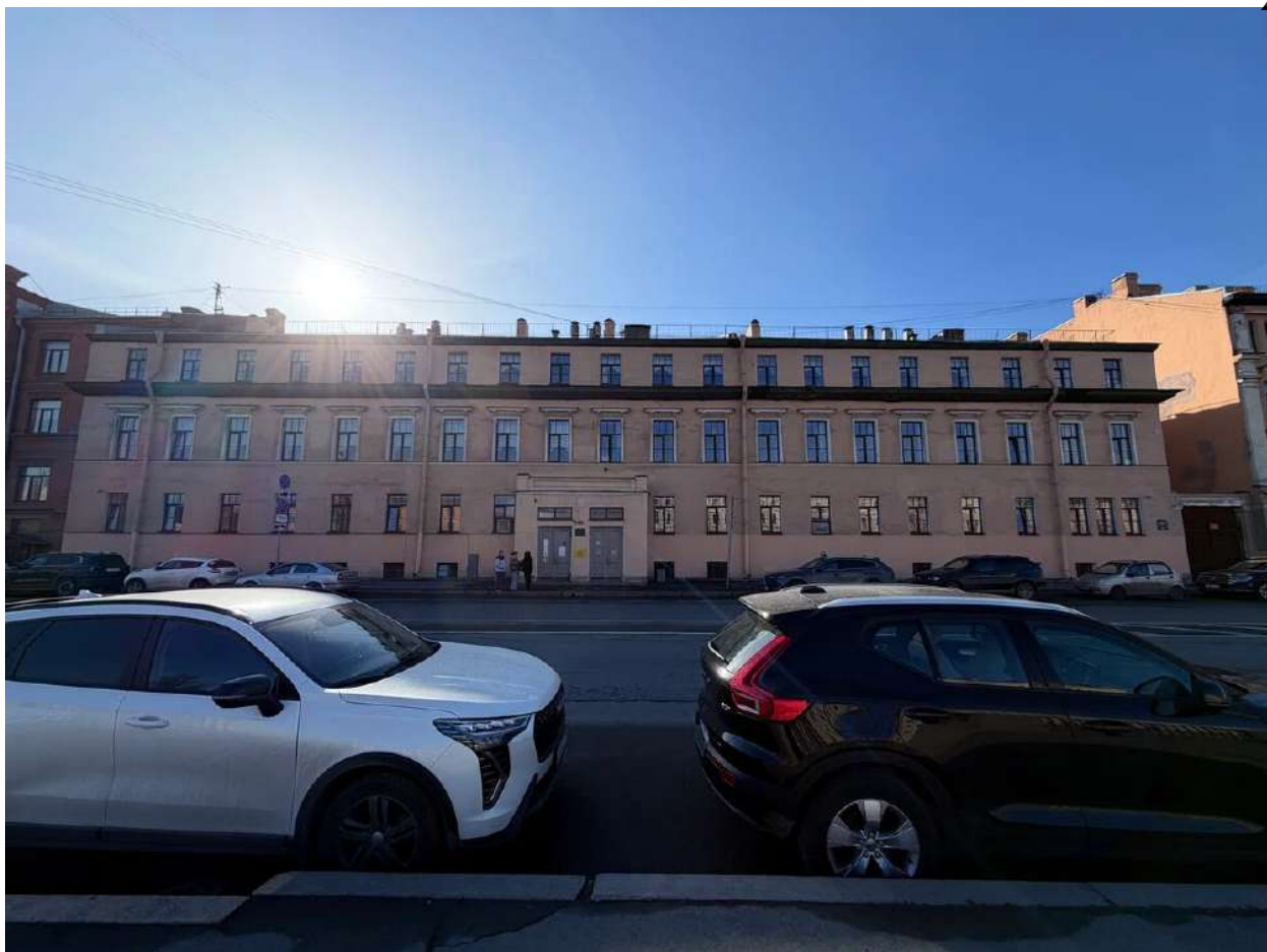
Фото 5. Общий вид на лицевой корпус. Дата фотофиксации: 14.03.2026г.
