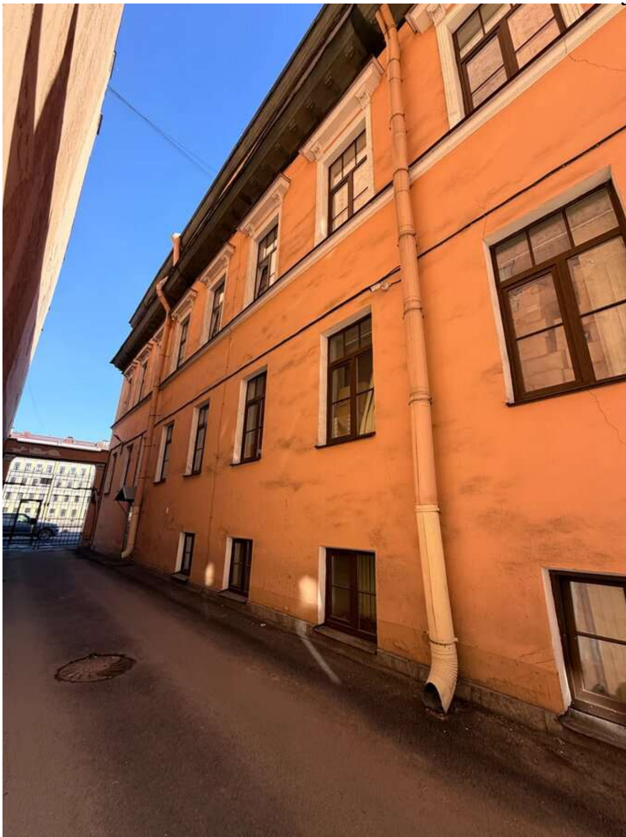
Фото 33. Общий вид на лицевой корпус. Дата фотофиксации: 14.03.2026г.
