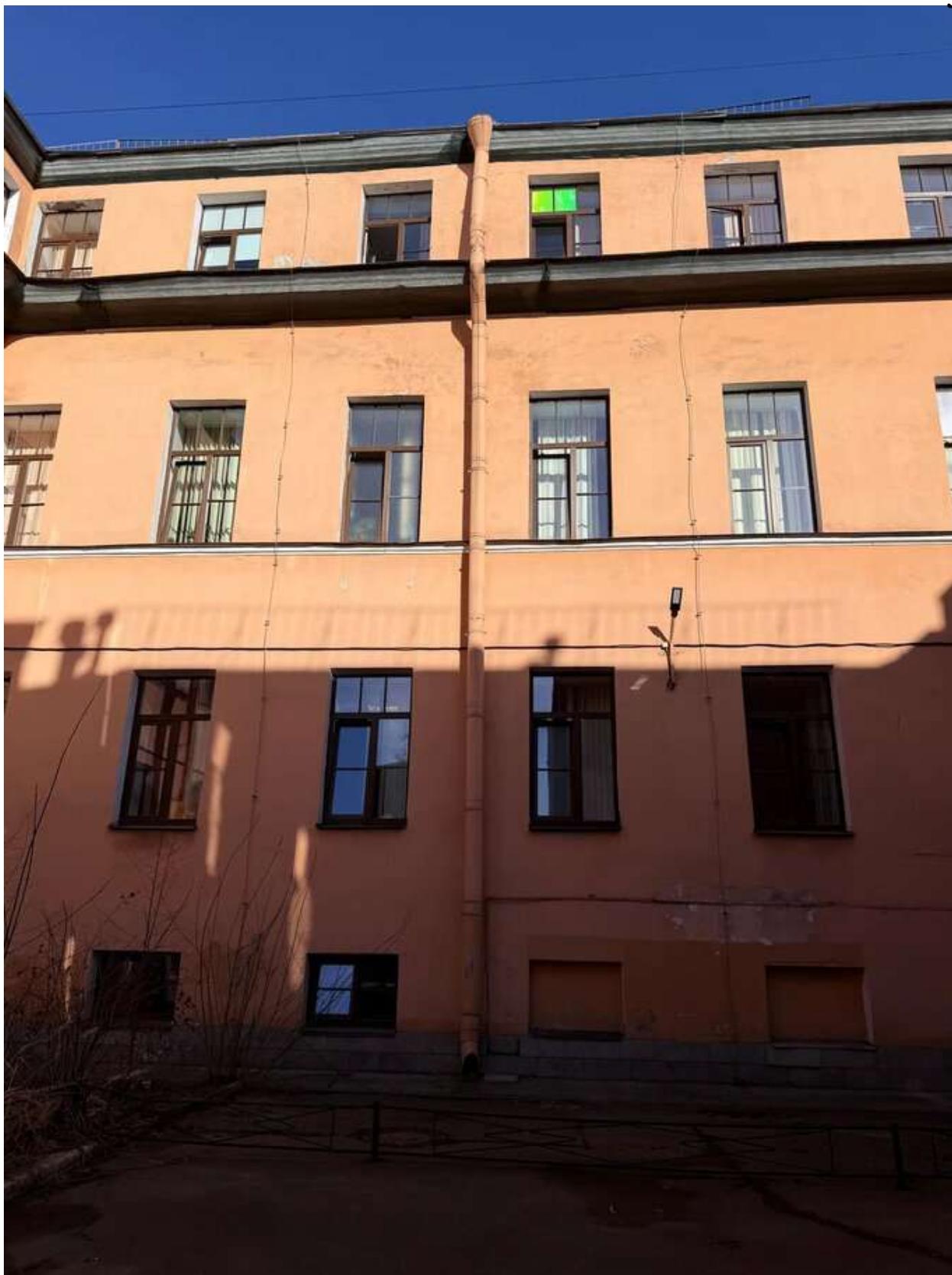
Фото 25. Общий вид на лицевой корпус. Дата фотофиксации: 14.03.2026г.
