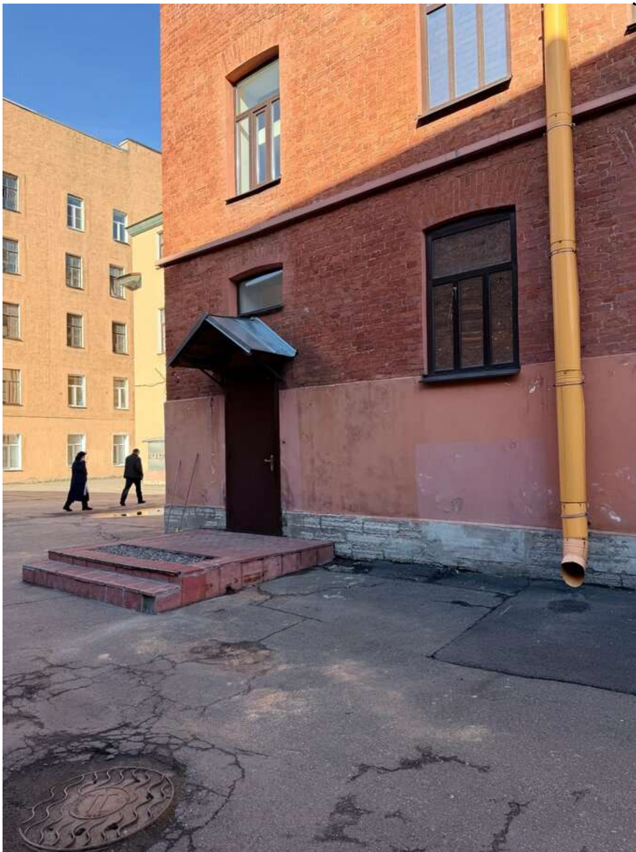
Фото 38. Общий вид на дворовой корпус. Дата фотофиксации: 14.03.2026г.
