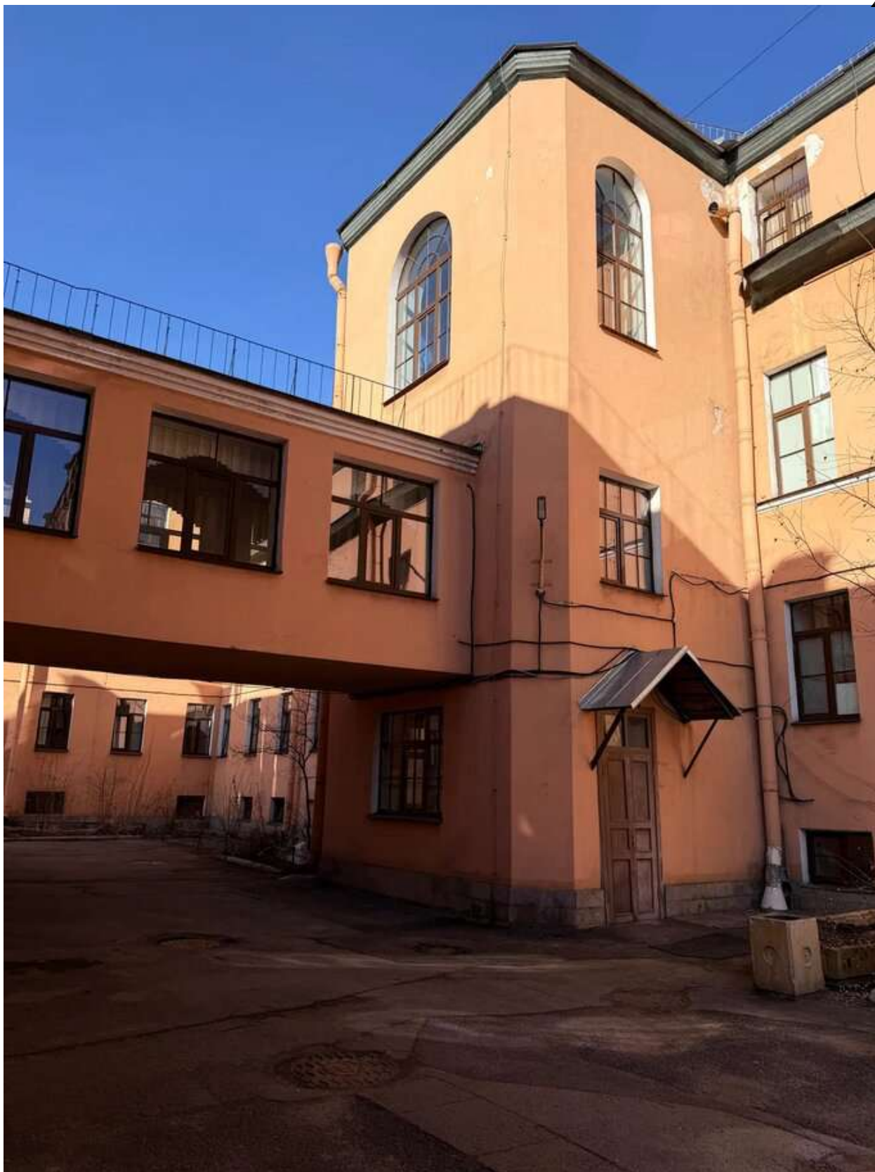
Фото 16. Общий вид на лицевой корпус. Дата фотофиксации: 14.03.2026г.
