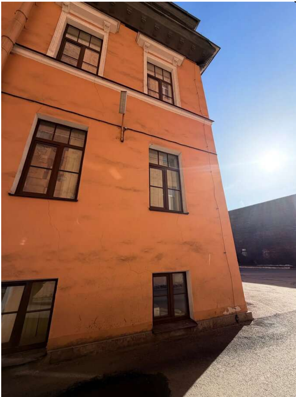
Фото 32. Общий вид на лицевой корпус. Дата фотофиксации: 14.03.2026г.
