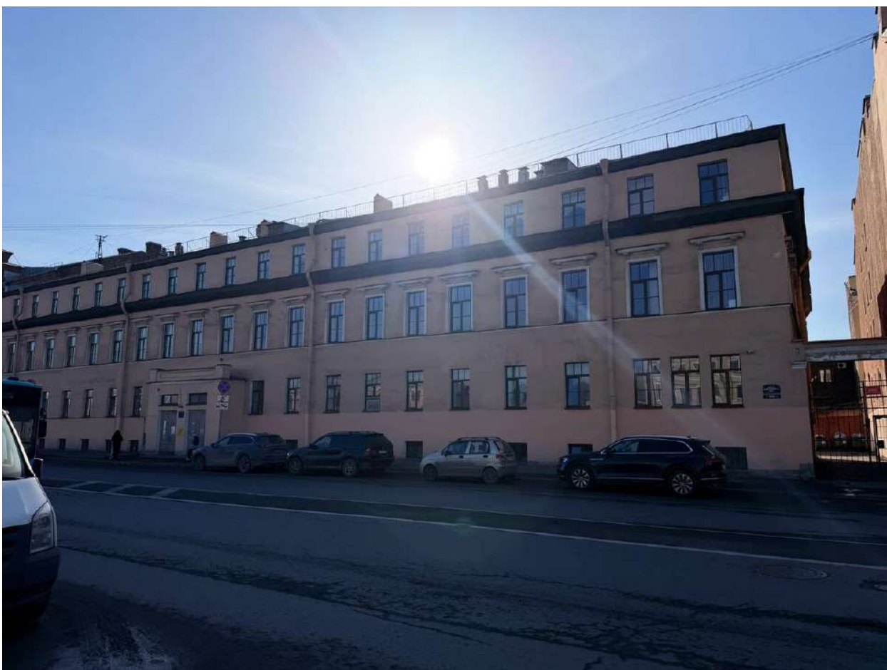
Фото 4. Общий вид на лицевой корпус. Дата фотофиксации: 14.03.2026г.
