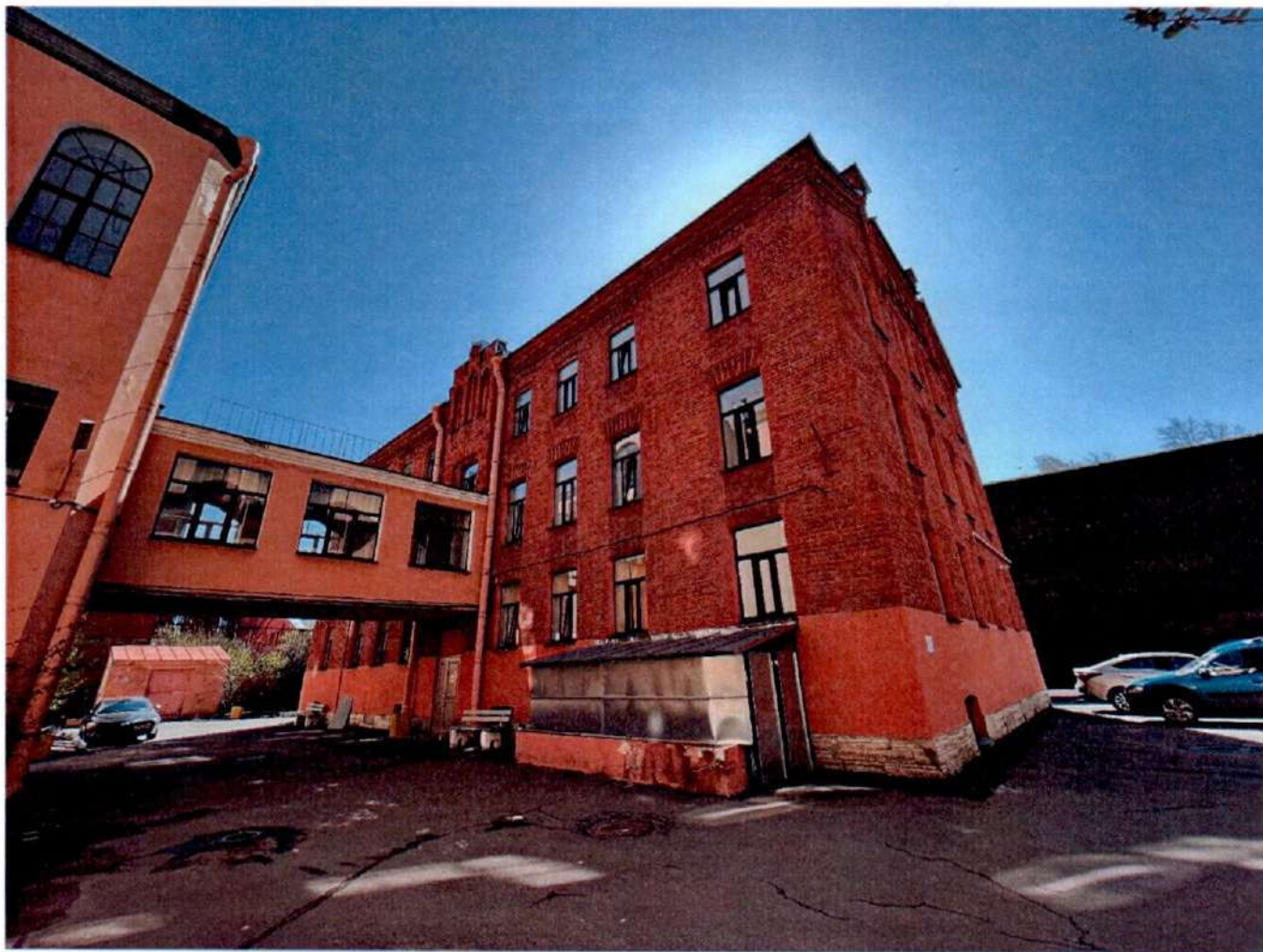
Фото 8. Общий вид на северный и западный фасады объекта культурного наследия.
