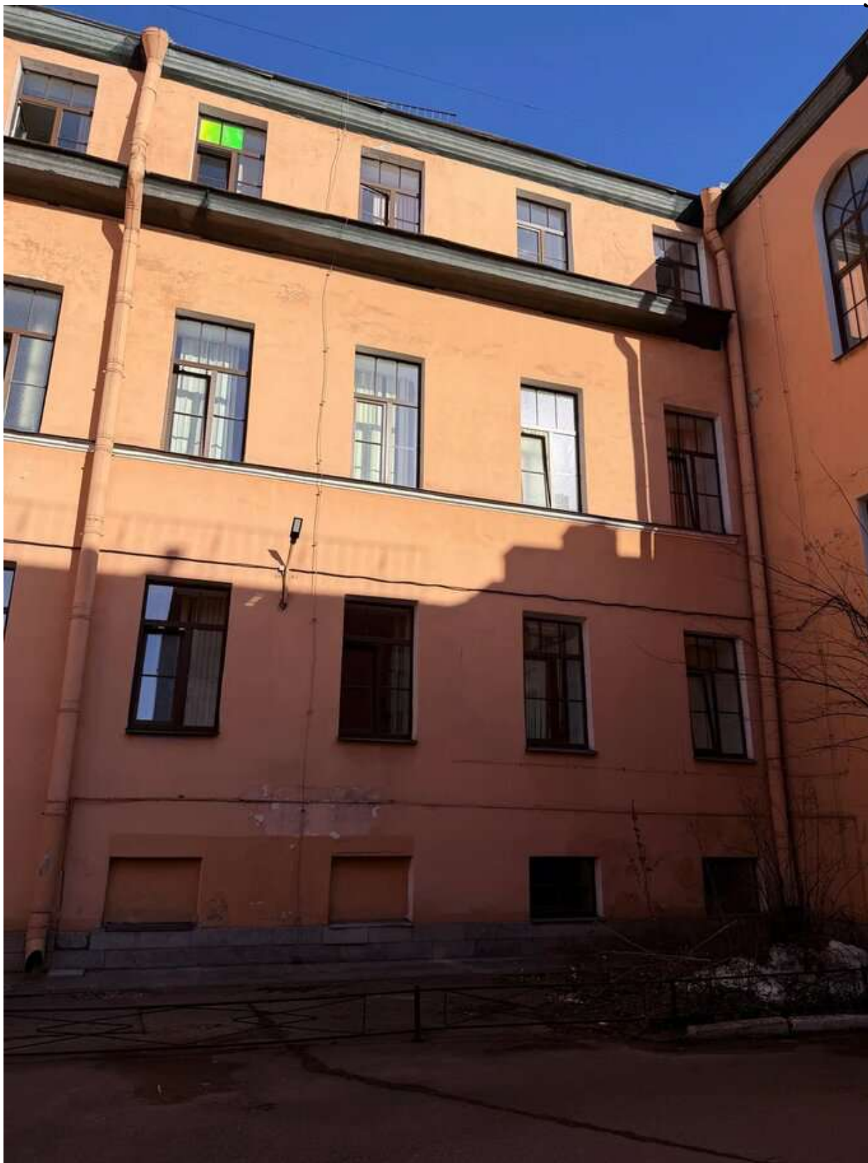
Фото 24. Общий вид на лицевой корпус. Дата фотофиксации: 14.03.2026г.
