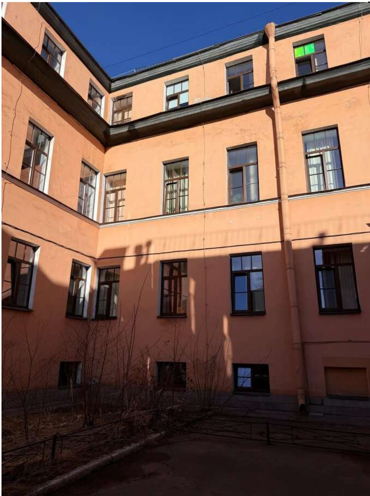
Фото 26. Общий вид на лицевой корпус. Дата фотофиксации: 14.03.2026г.
