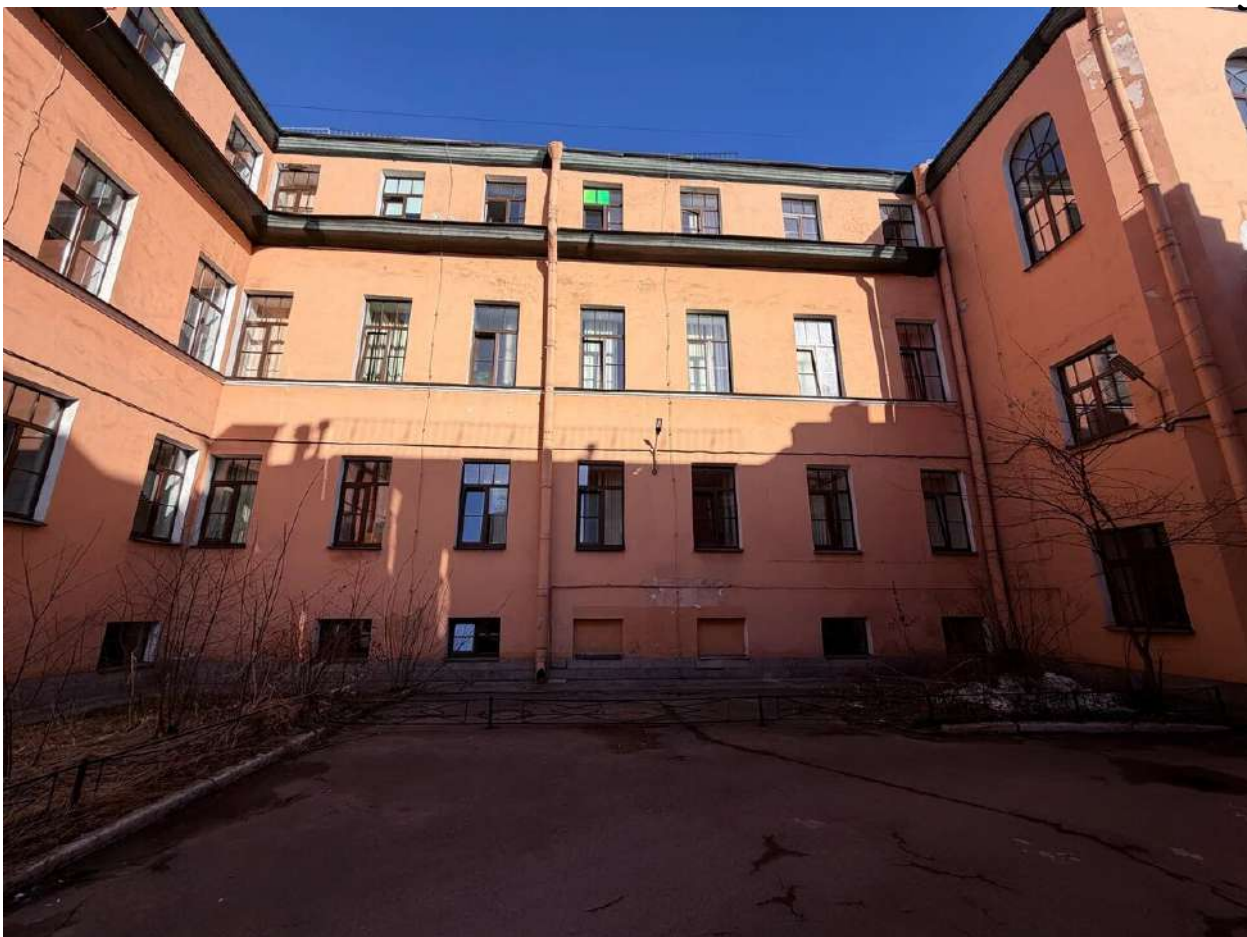
Фото 27. Общий вид на лицевой корпус. Дата фотофиксации: 14.03.2026г.
