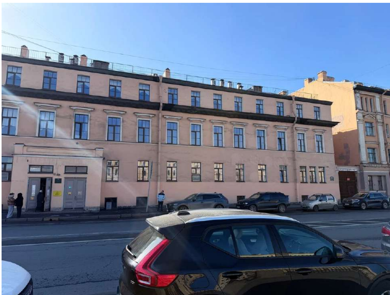
Фото 6. Общий вид на лицевой корпус. Дата фотофиксации: 14.03.2026г.
