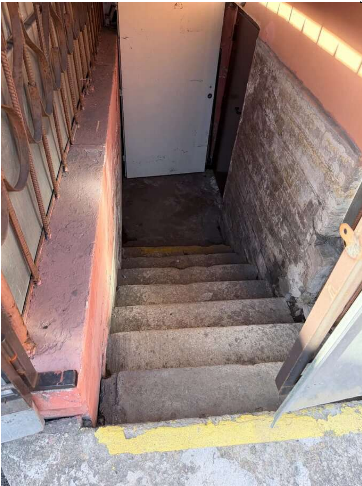
Фото 43. Общий вид на приямок дворового корпуса. Дата фотофиксации: 14.03.2026г.
