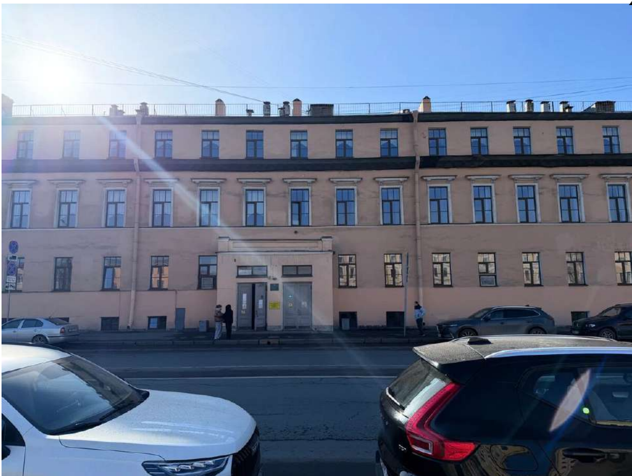
Фото 7. Общий вид на лицевой корпус. Дата фотофиксации: 14.03.2026г.
