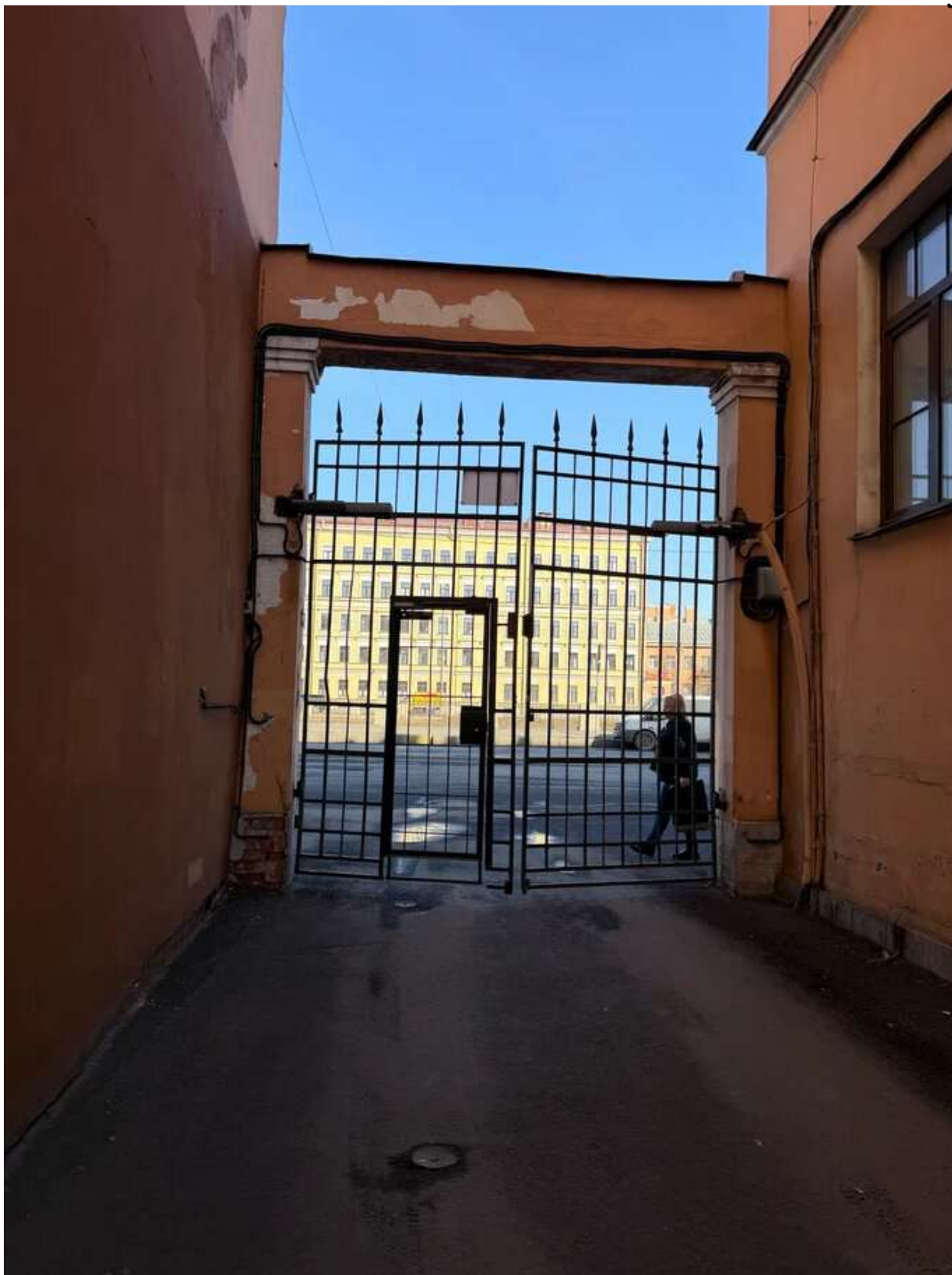
Фото 34. Общий вид на ворота лицевого корпуса. Дата фотофиксации: 14.03.2026г.
