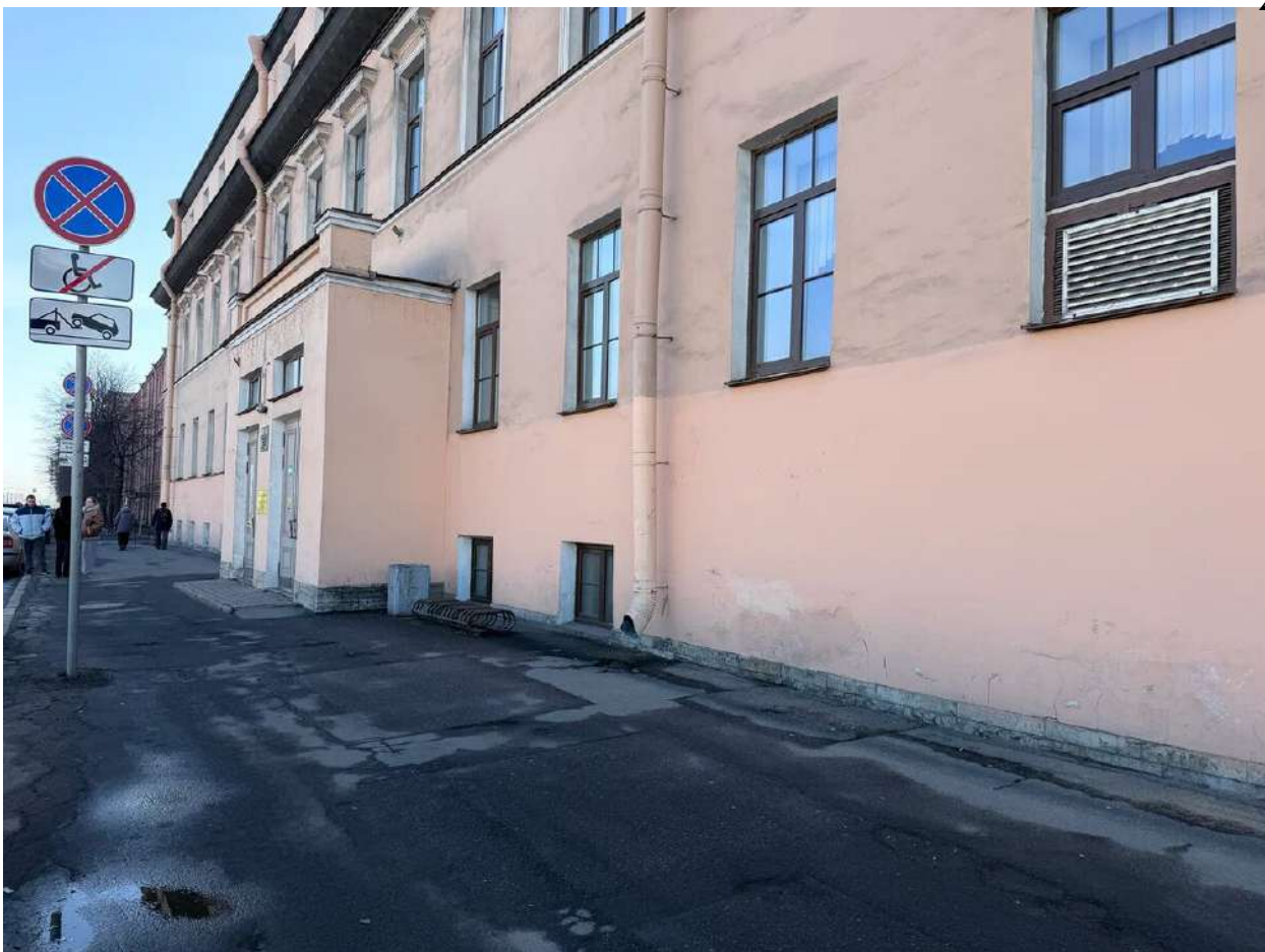
Фото 10. Общий вид на лицевой корпус. Дата фотофиксации: 14.03.2026г.
