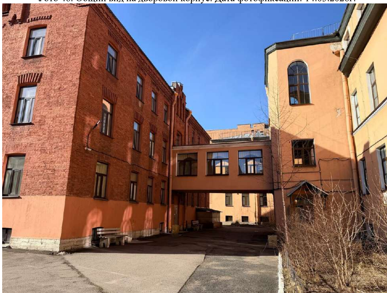
Фото 47. Общий вид на дворовой корпус. Дата фотофиксации: 14.03.2026г.
