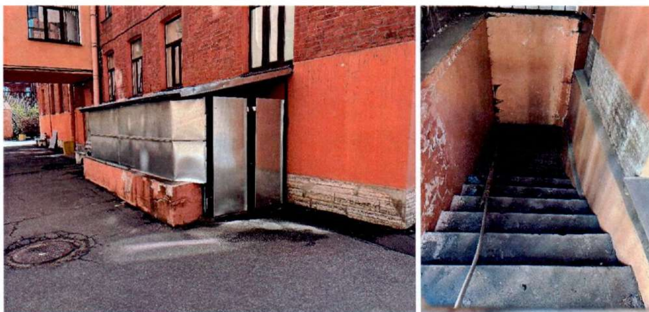
Фото 4, 5. Приемок со стороны северного фасада объекта культурного наследия.
