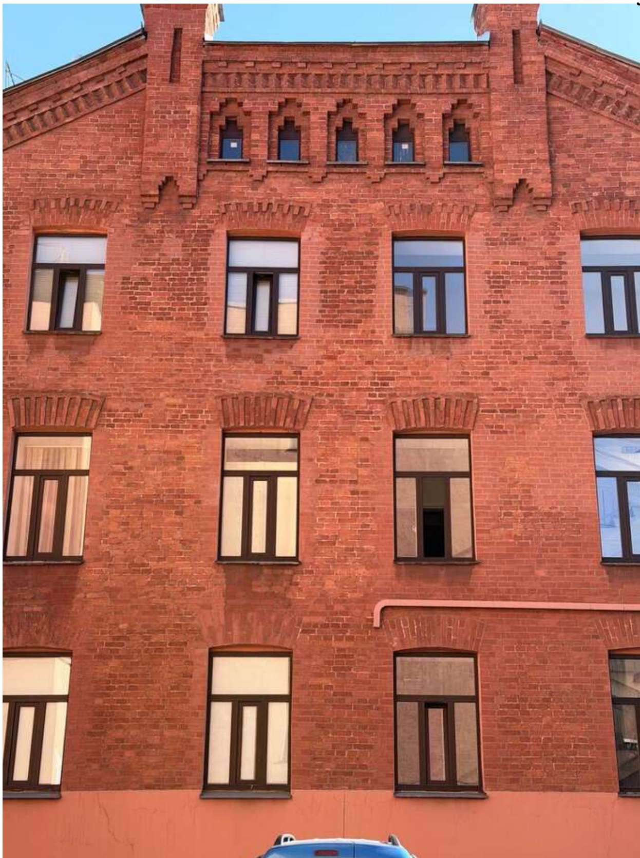
Фото 36. Общий вид на дворовой корпус объекта. Дата фотофиксации: 14.03.2026г.
