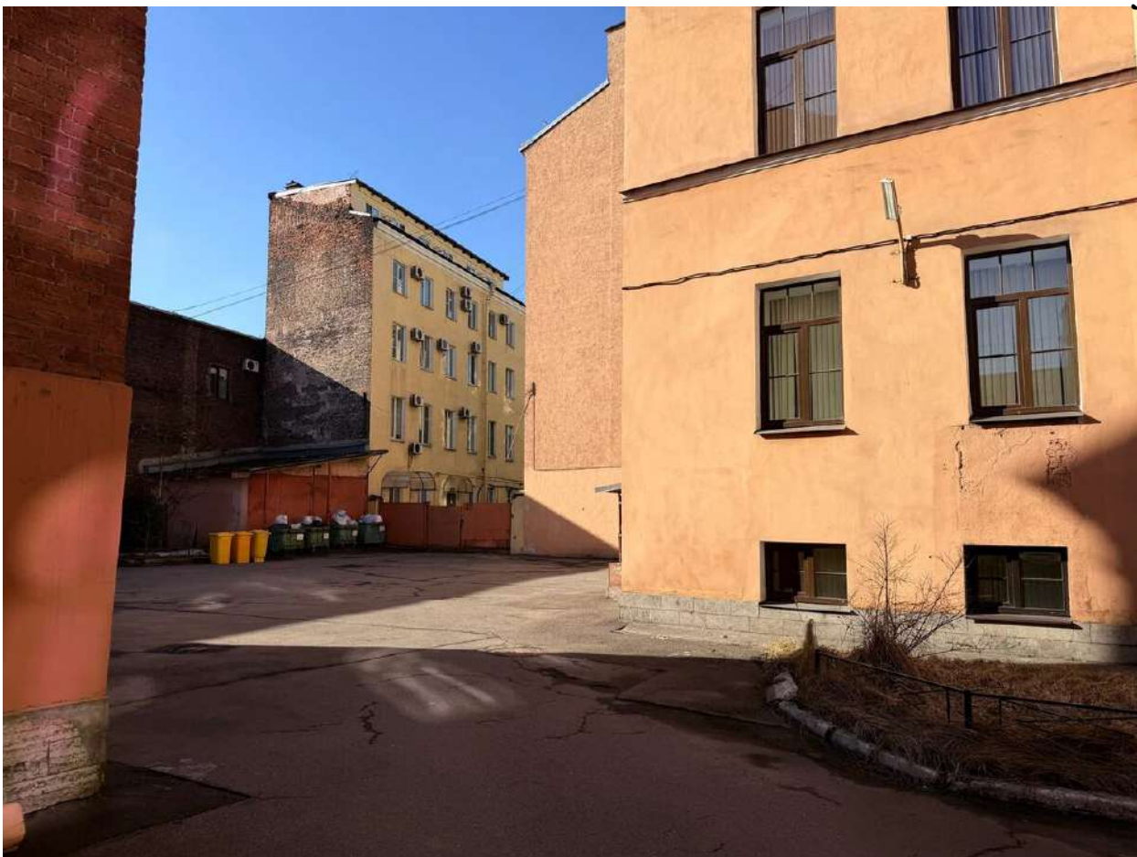
Фото 29. Общий вид на лицевой корпус. Дата фотофиксации: 14.03.2026г.
