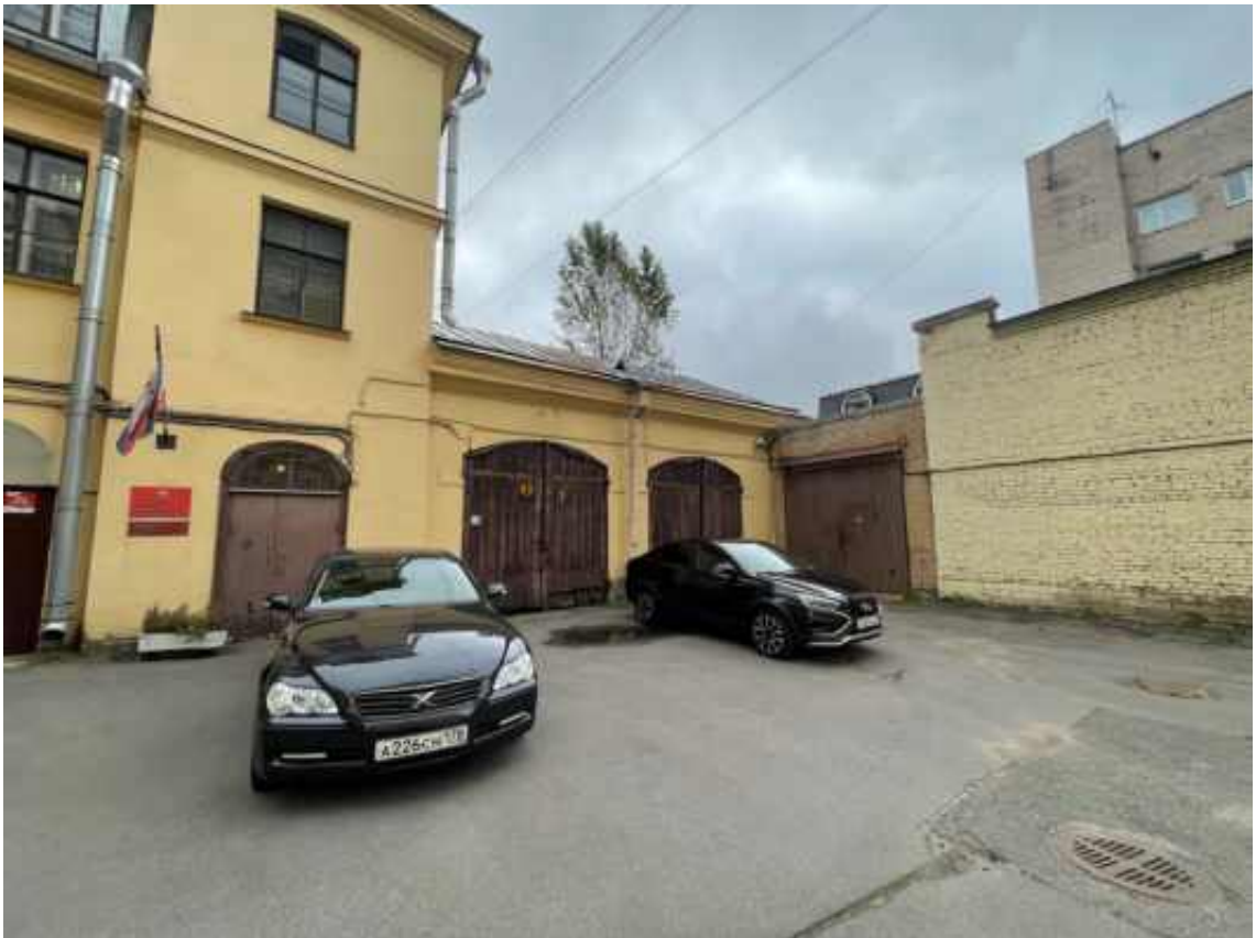
6. Вид на южный и восточный фасады со стороны двора
