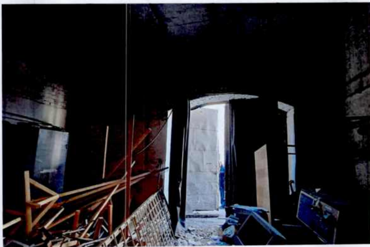
3. Помещение 1-го этажа.
