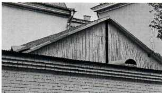
4. Фрагмент крыши здания (с южной стороны)
