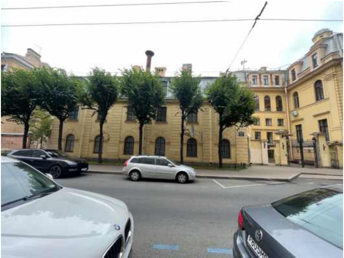
1. Вид на северные фасады со стороны Большой Монетной улицы
