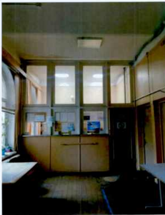
8. Интерьер. Помещение 1-Н(3) объекта культурного наследия в уровне 1-го этажа.
