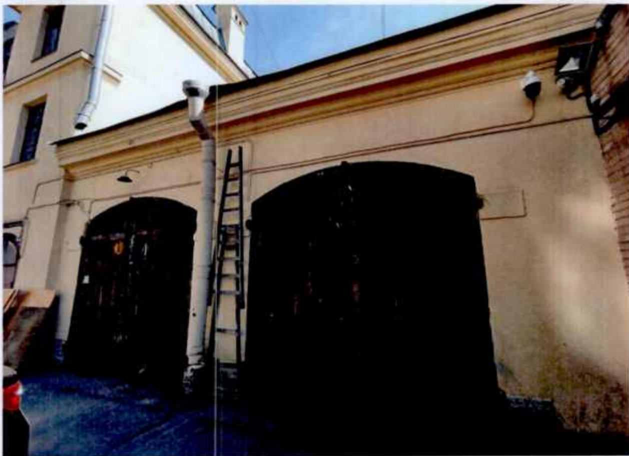
2. Вид на западный фасад объекта культурного наследия.
