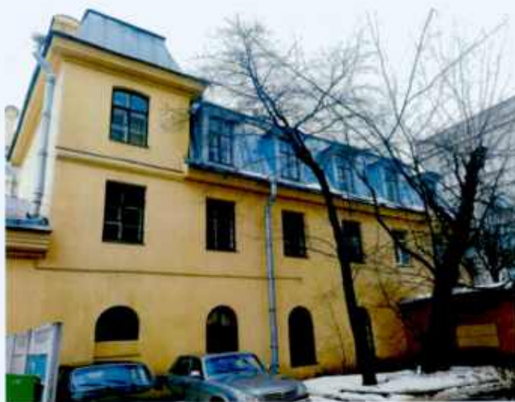
2. Общий вид. Восточный фасад объекта культурного наследия.
