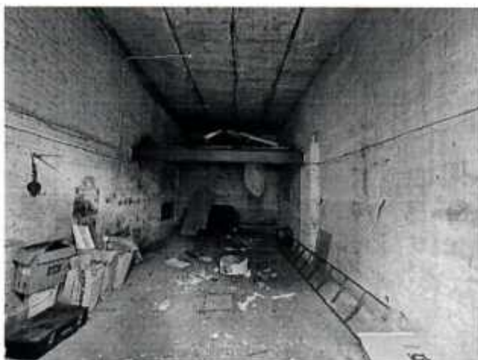
Фрагмент интерьера (пом. 1-го эт)
