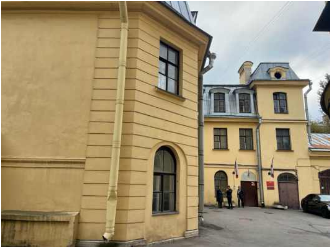
4. Вид на западные фасады со стороны двора
