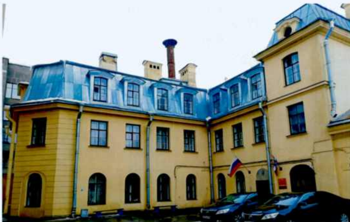
3. Общий вид. Дворовые фасады объекта культурного наследия.
