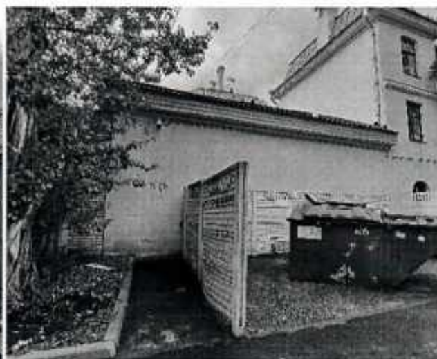
2. Фрагмент восточного фасада
