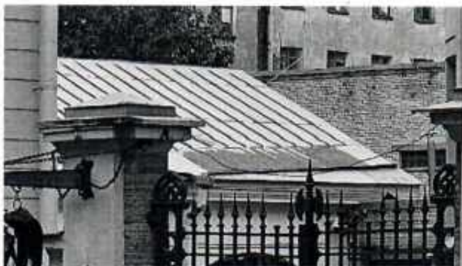
3. Фрагмент крыши здания
