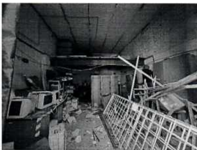
Фрагмент интерьера (пом. 1-го эт)
