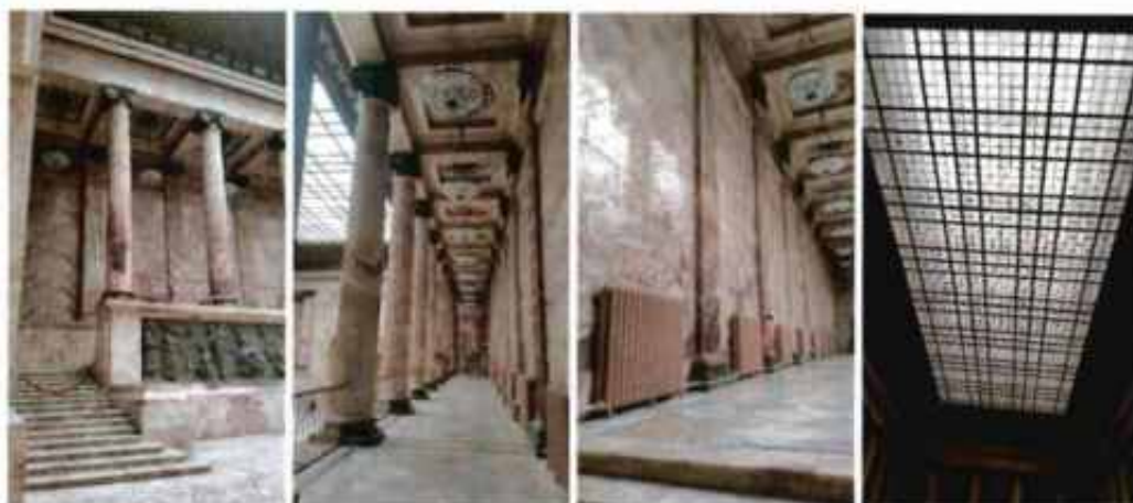
26, 27, 28. Подвальные помещения в центральной части объекта культурного наследия и симметричные лестницы с 1 этажа, пом. 1-Н (44)
