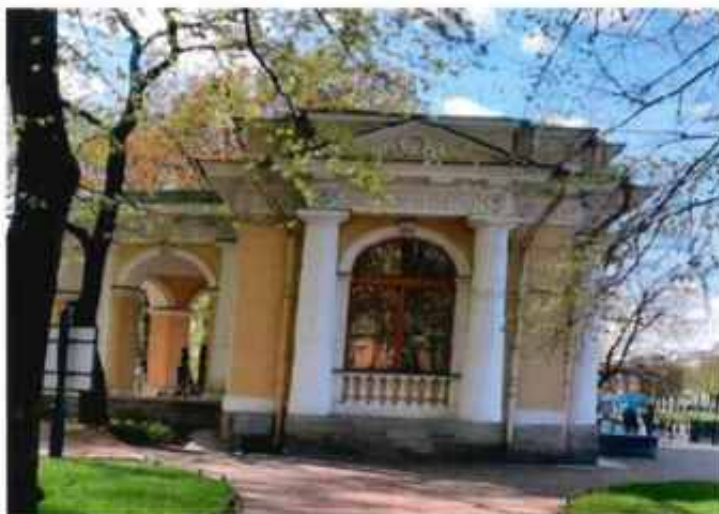
Фото 4: Фрагмент объекта культурного наследия (восточный лицевой фасад).
