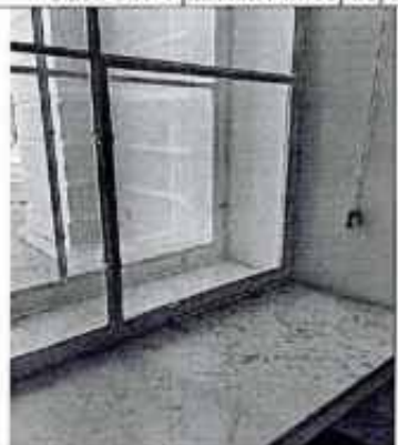
Фото 56. Фрагмент интерьера (подоконная доска)
