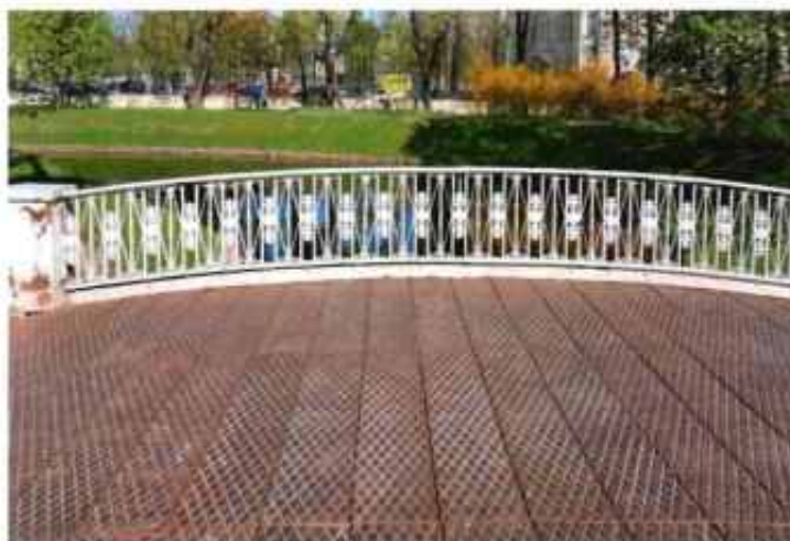
Фото 5. Фрагмент объекта культурного наследия (перильное ограждение моста и поверхность моста).
