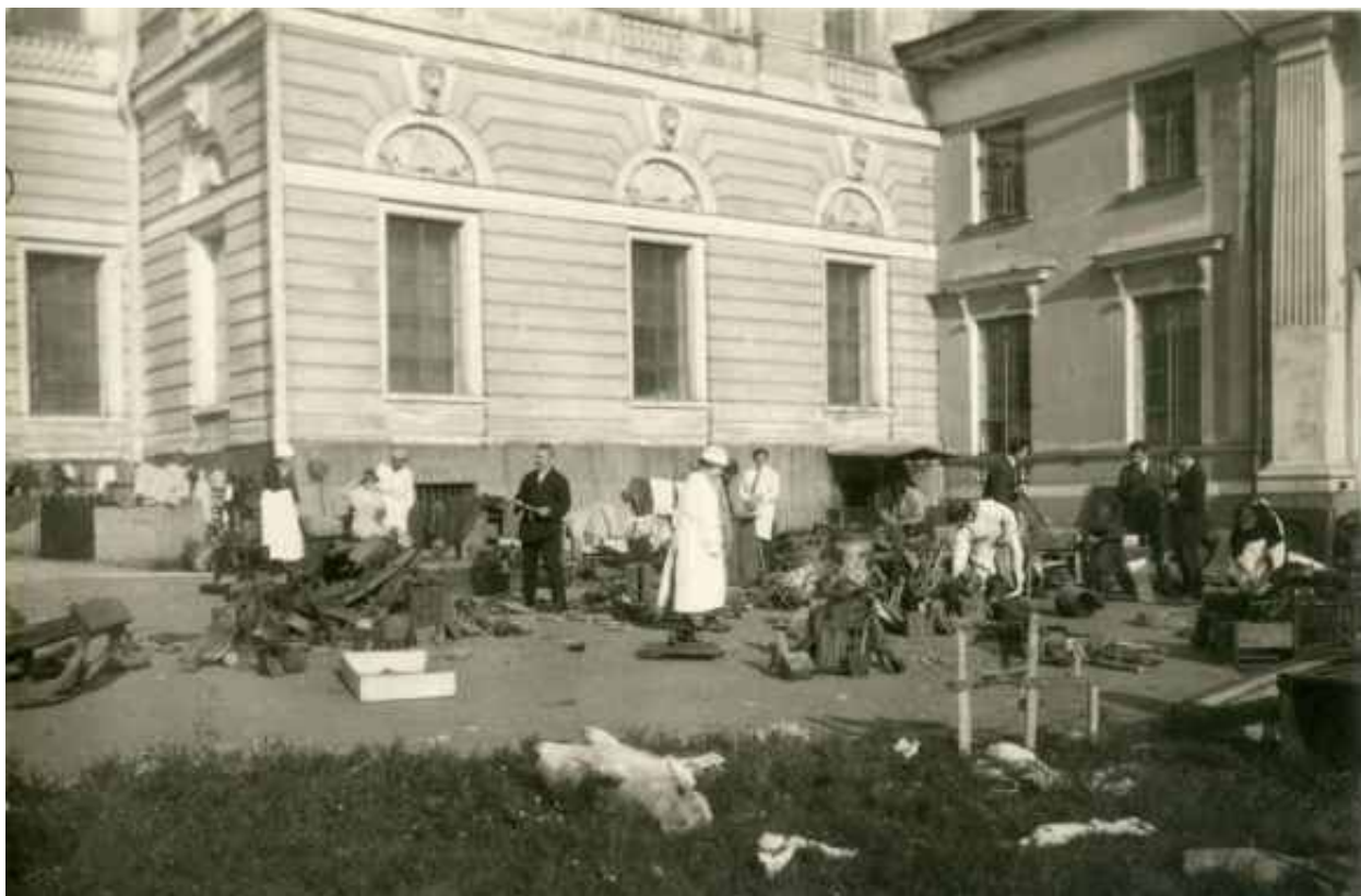
Илл. 8. Государственный Русский музей. Объект культурного наследия федерального значения «Корпус главный Русского музея». Просушка вещей после нводнения. Фото 1924 г. Источник: https://pastvu.com/p/1998699
