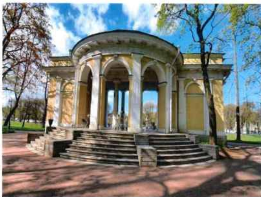
Фото 3: Фрагмент объекта культурного наследия (южный лицевой фасад).
