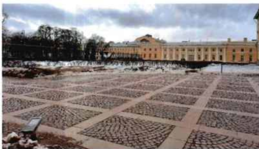
Фото 7: Фрагмент объекта культурного наследия. Вид с северо-востока.
