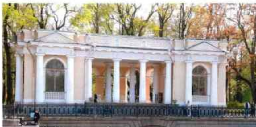
Фото 2: Общий вид на объект культурного наследия. Вид с севера.
