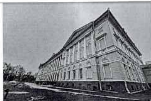
Фото 4. Фасад фрагмент (со стороны Михайловского сада)
