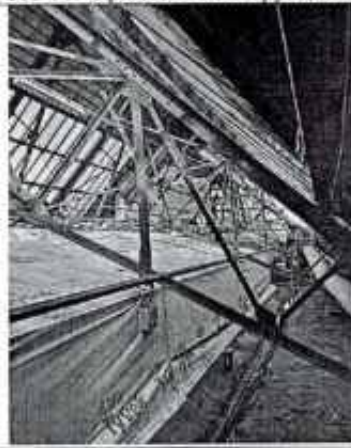
Фото 13. Фрагмент конструкций светового фонаря
