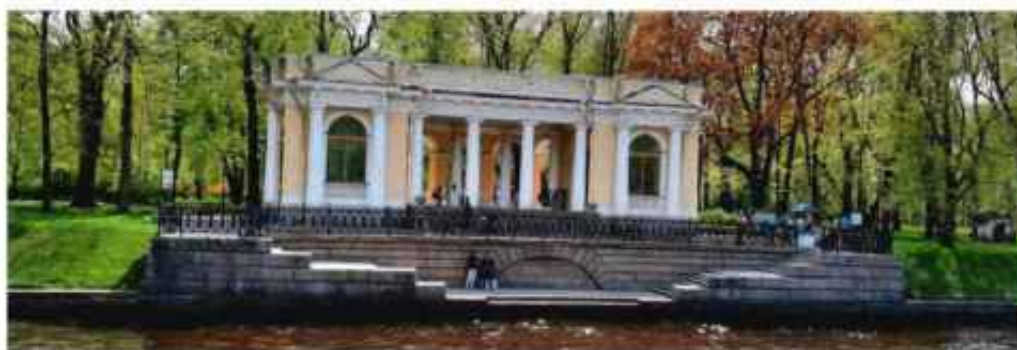
Фото 2; Общий вид на объект культурного наследия. Вид с севера.
