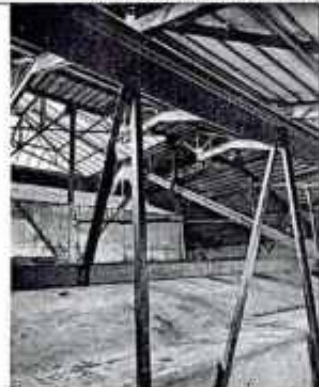
Фото 9. Фрагмент конструкций светового фонаря
