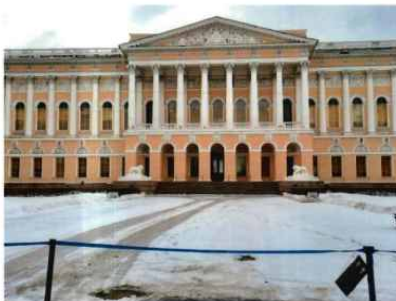
Фото 3: Фрагмент объекта культурного наследия. Вид с юга (центральная часть объекта).
