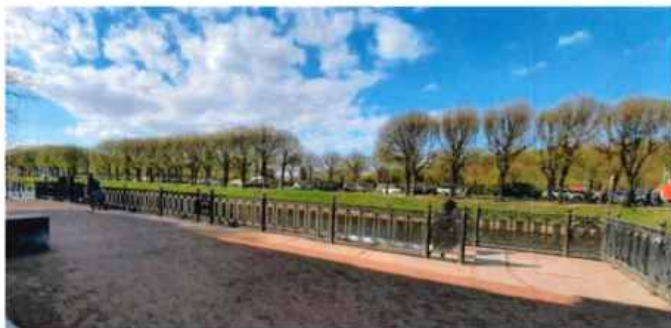
Фото 4. Перильное ограждение и мощение верхней площадки объекта культурного наследия гранитными плитами.
