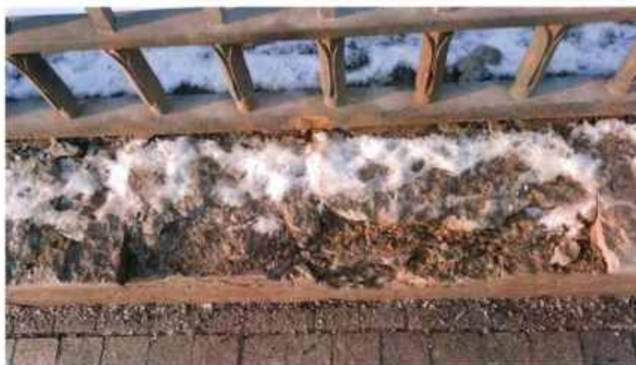
Фото 11: фрагмент объекта культурного наследия (известняковый цоколь).
