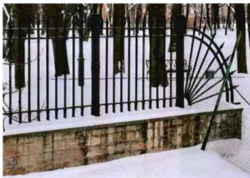
Фото 13: фрагмент объекта культурного наследия (завершающие звенья ограды в виде веера из копий).
