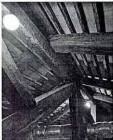
Фото 10. Фрагмент конструкций крыши
