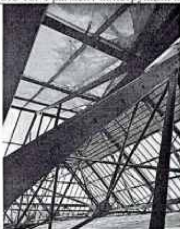
Фото 12. Фрагмент конструкций светового фонаря
