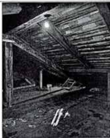
Фото 11. Фрагмент конструкций крыши
