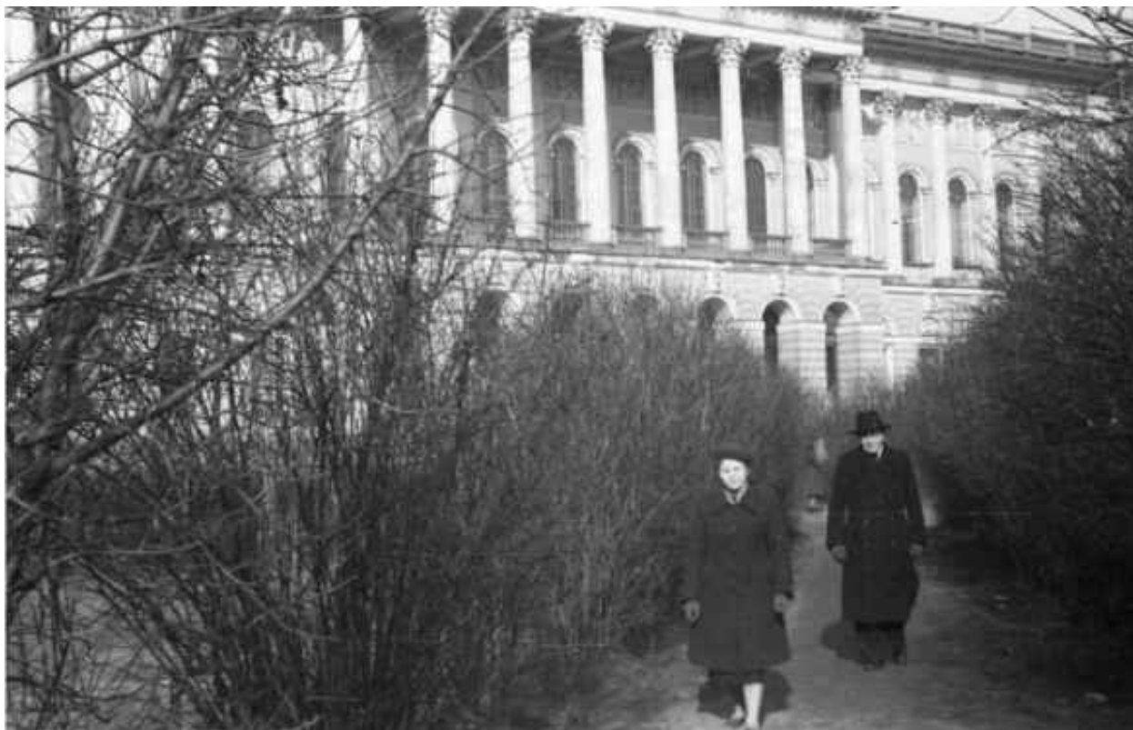
Илл. 14. Государственный Русский музей. Объект культурного наследия федерального значения «Корпус главный Русского музея». Фото 1950-1955 гг. Источник: https://pastvu.com/p/2364821
