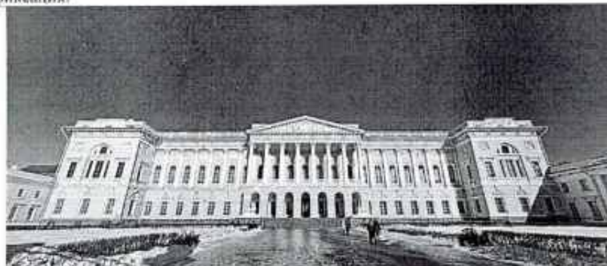
Фото 1. Фасад (по ул. Инженерной)
