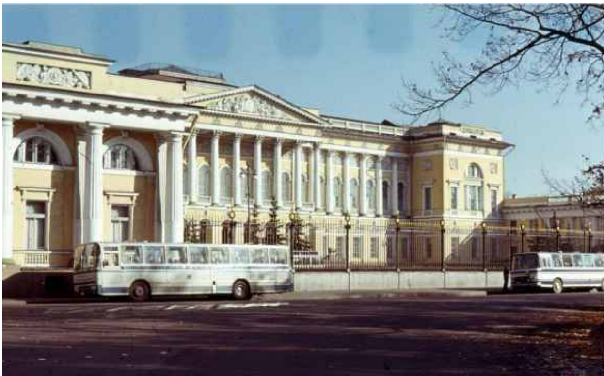
Илл. 18. Государственный Русский музей. Объект культурного наследия федерального значения «Корпус главный Русского музея». Фото 1981-1982 гг. Источник: https://pastvu.com/p/1121729
