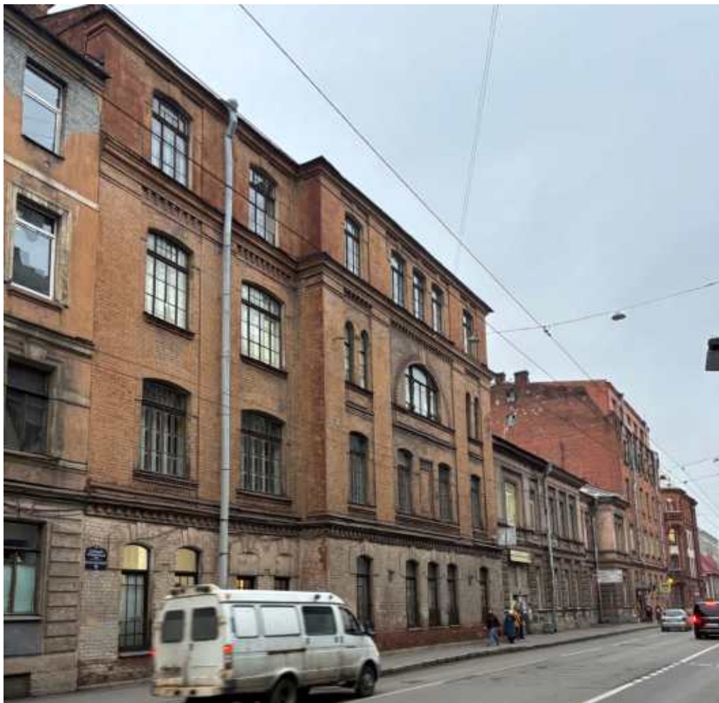
Фото 1. ОКН «Производственное здание», «Особняк и контора О.Ф. Кирхнера», «Производственное здание (главная контора и типография)», расположенные по адресу: Санкт-Петербург, Большая Пушкарская улица, дом 10, литер В, Г, Е, входящие в состав ансамбля «Комплекс картонажно-переплетной фабрики товарищества «Отто Кирхнер».
