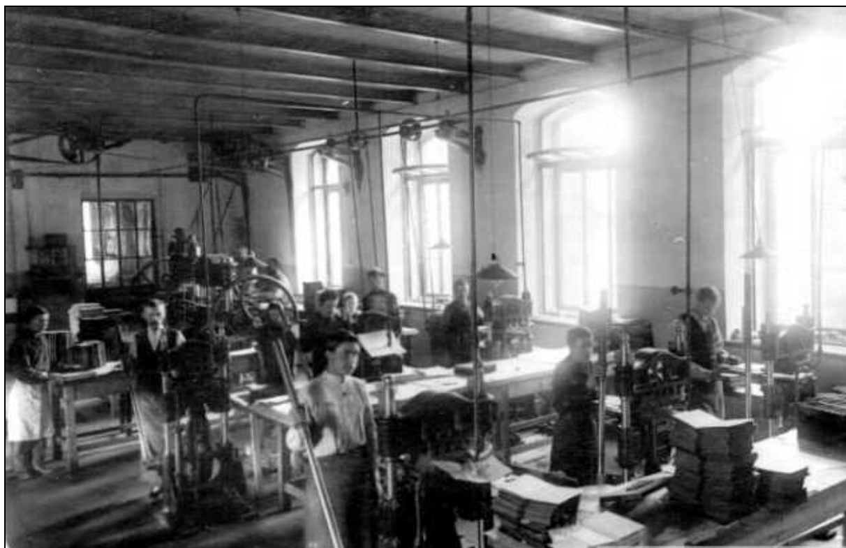
67. Цех фабрики «Отто Кирхнер» (современный корпус лит. В). 1909 г. // ЦГА КФФД СПб. Шифр: Д 14312.
