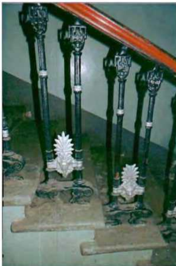
2. Интерьер. Фрагмент лестничного ограждения.
