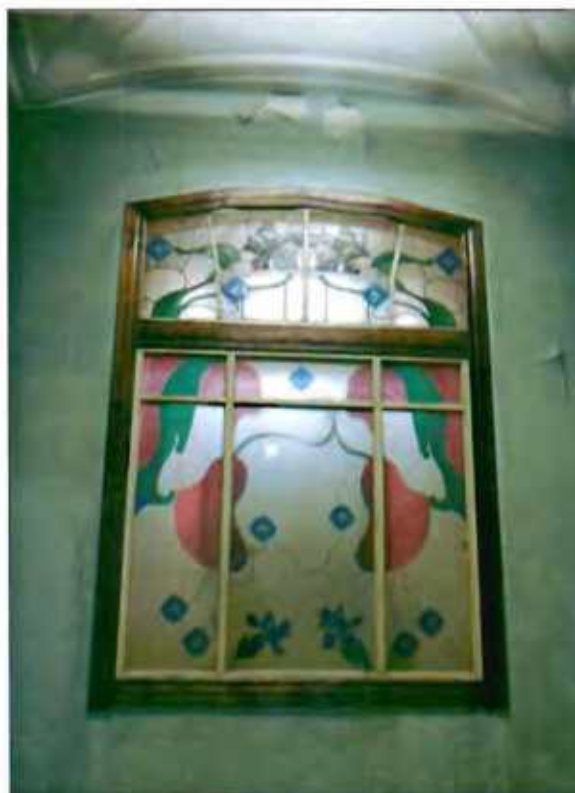
3. Интерьер. Фрагмент. Витражное полихромное заполнение фрамуги оконного проема вестибюля.
