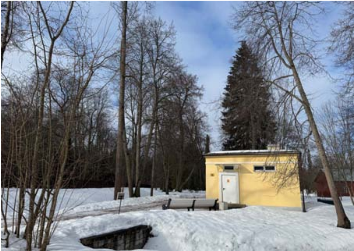
Фото 3. Вид на здание д.5 лит. В на восточный фасад и прилегающую территорию. Объект культурного наследия федерального значения «Верхний парк».
