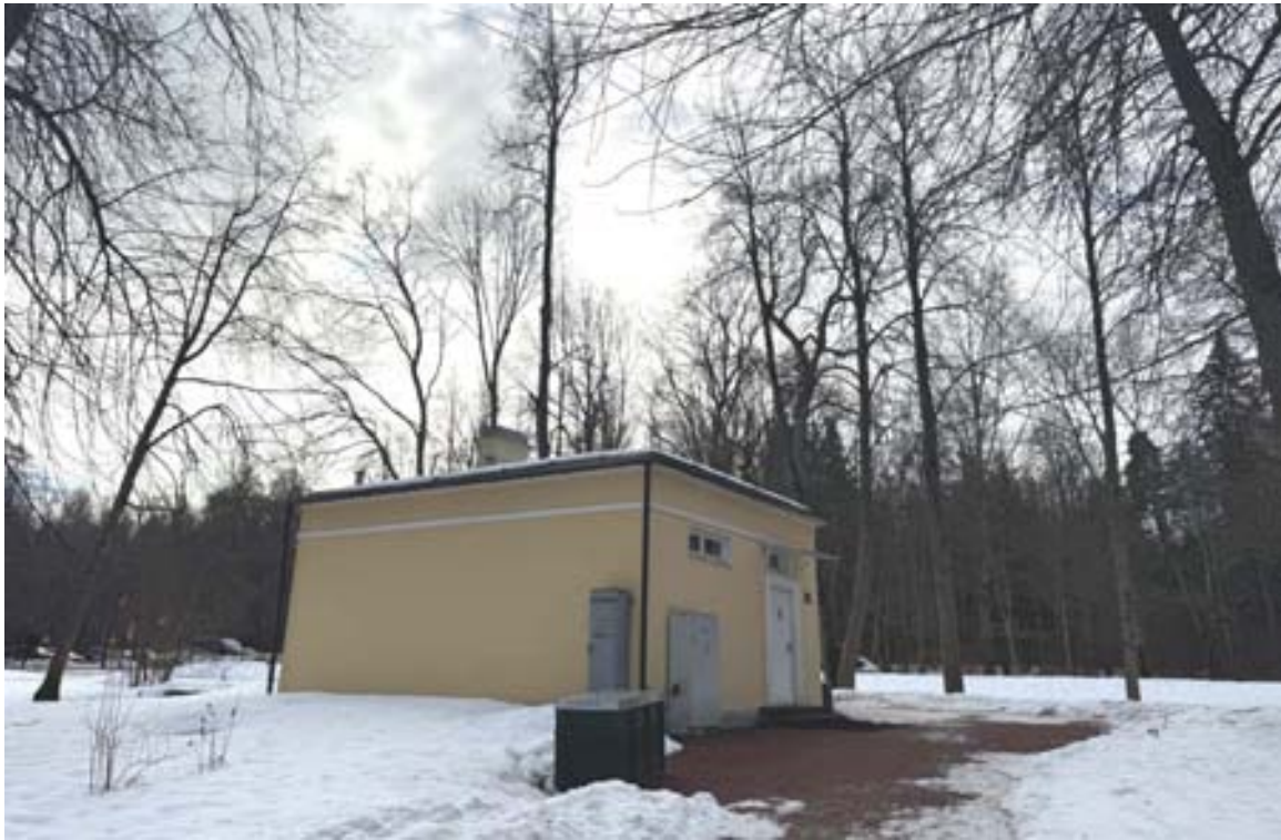
Фото 1. Вид на здание д.5 лит. В на западный фасад и прилегающую территорию. Объект культурного наследия федерального значения «Верхний парк».
