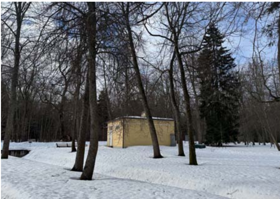
Фото 2. Вид на здание д.5 лит. В на северный фасад и прилегающую территорию. Объект культурного наследия федерального значения «Верхний парк».
