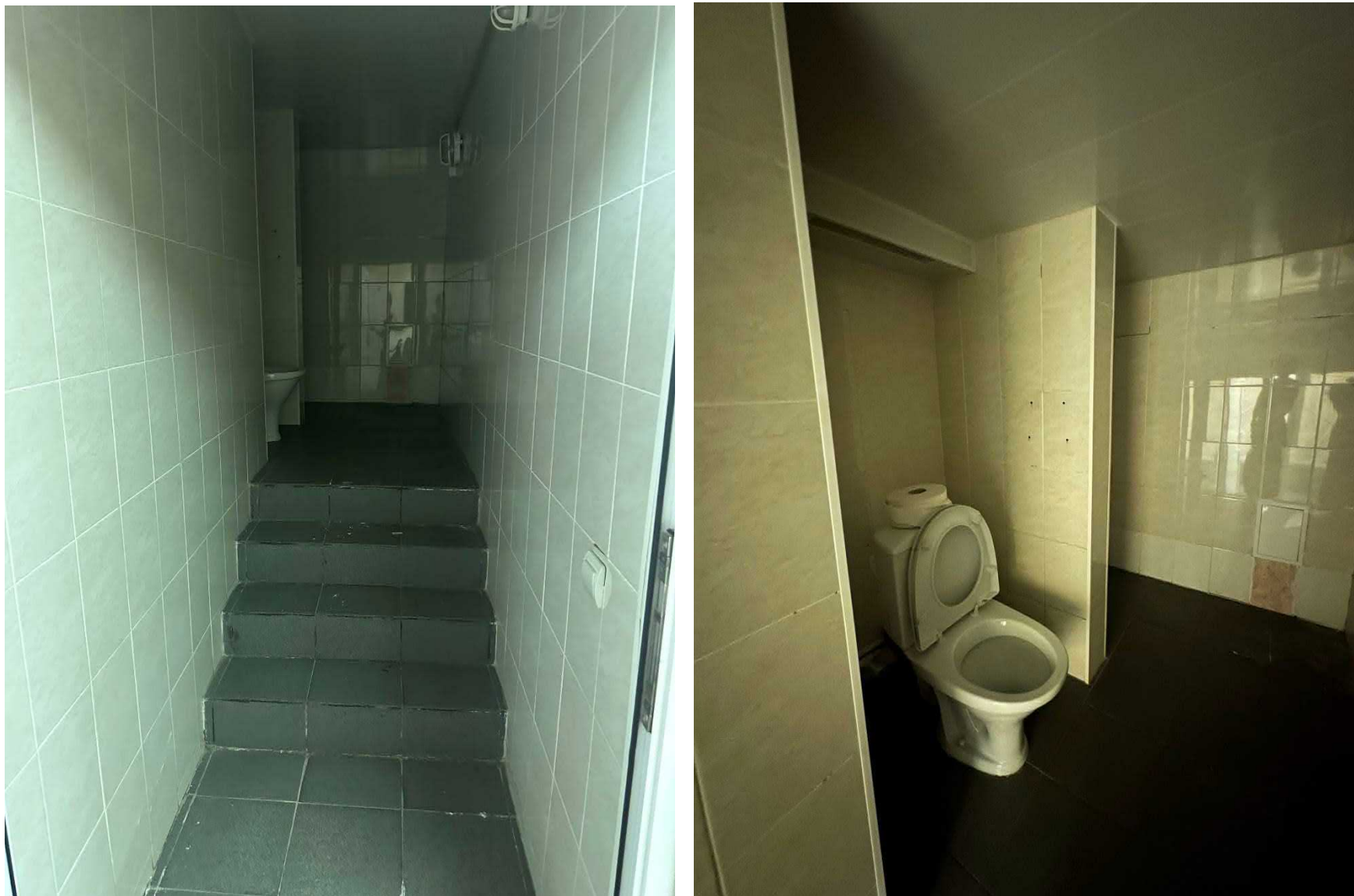
Фото 9, 10. Помещение 1-Н. Цокольный этаж. Санузел
