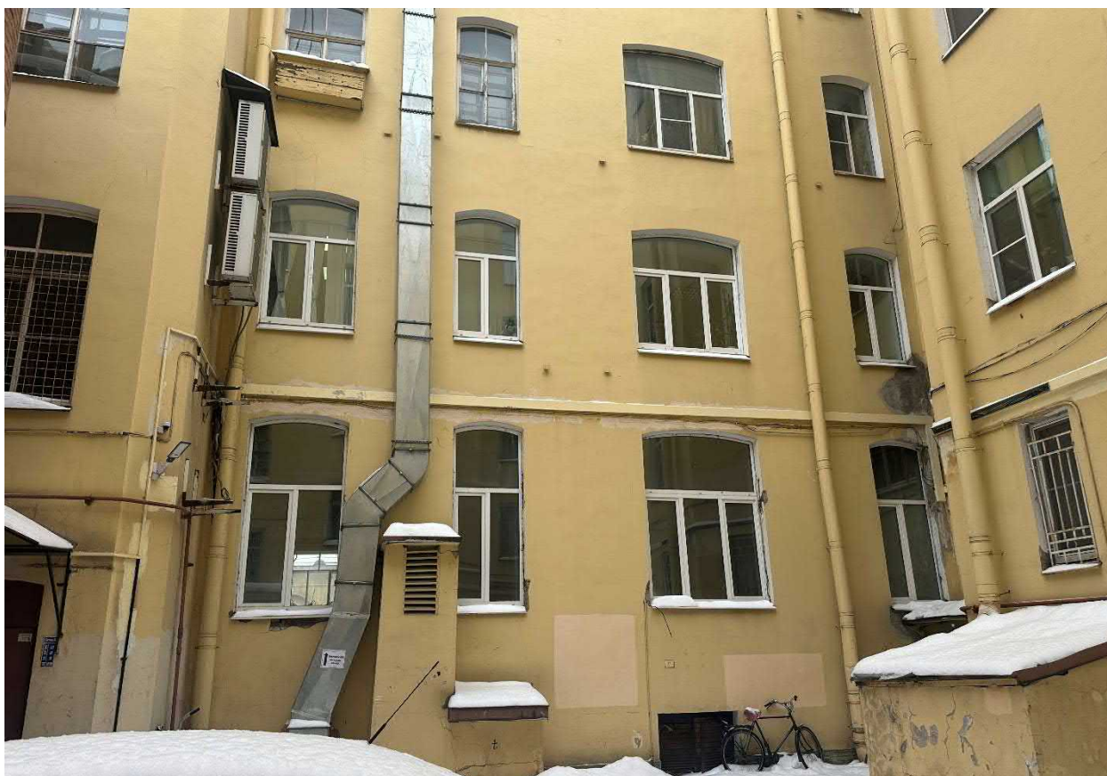
Фото 2. Общий вид здания со стороны двора
