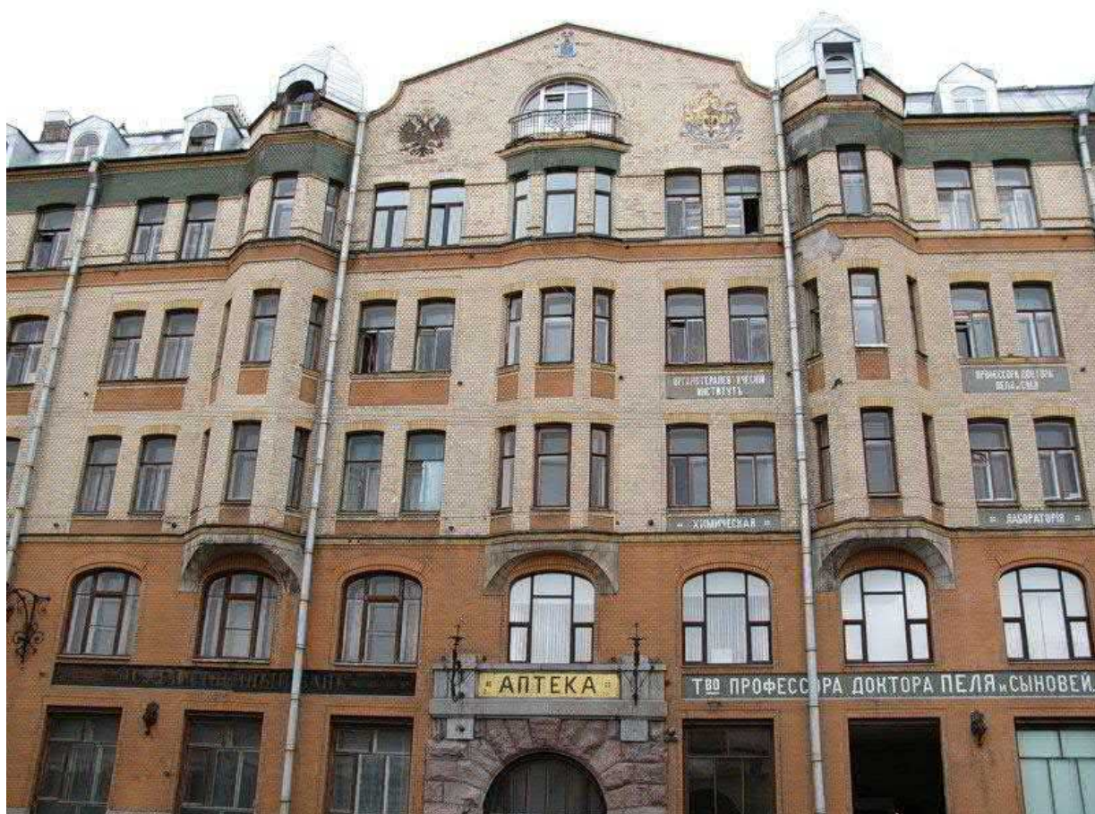
Фото 1. Общий вид здания со стороны 7-й линии ВО
