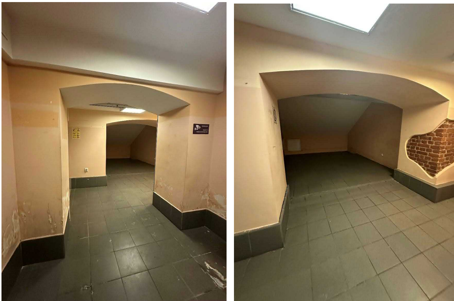
Фото 3, 4. Помещение 1-Н. Цокольный этаж. Пространство под лестницей
