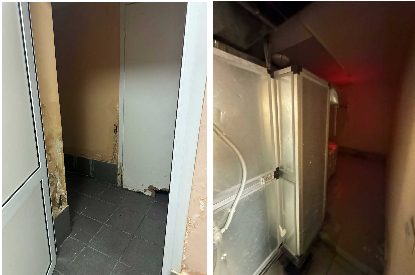
Фото 17, 18. Помещение 1-Н. Цокольный этаж
