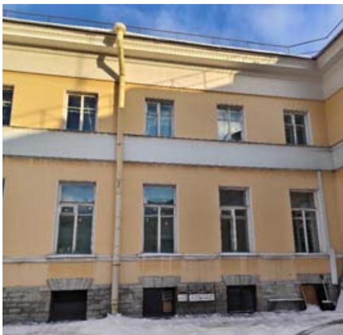
41. «Флигель служебный западный Михайловского дворца» (в составе «Дворец Великого князя Михаила Павловича (Русский музей Императора Александра III)»), г. Санкт-Петербург, Инженерная улица, дом 2-4, литера Г. Северный дворовый фасад. Фрагмент. Фото 03.02.2026г.
