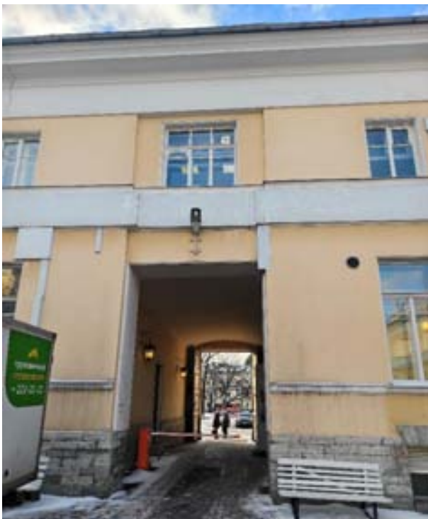
55. «Флигель служебный западный Михайловского дворца» (в составе «Дворец Великого князя Михаила Павловича (Русский музей Императора Александра III)»), г. Санкт-Петербург, Инженерная улица, дом 2-4, литера Г. Южный дворовый фасад. Фрагмент. Фото 03.02.2026г.
