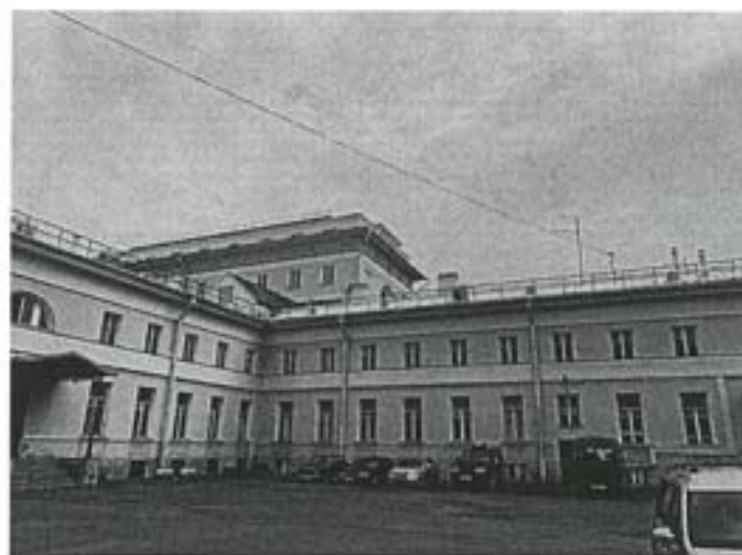
Фото 4. Фрагмент дворового фасада
