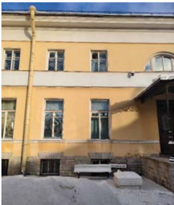
44. «Флигель служебный западный Михайловского дворца» (в составе «Дворец Великого князя Михаила Павловича (Русский музей Императора Александра III)»), г. Санкт-Петербург, Инженерная улица, дом 2-4, литера Г. Северный дворовый фасад. Фрагмент. Фото 03.02.2026г.
