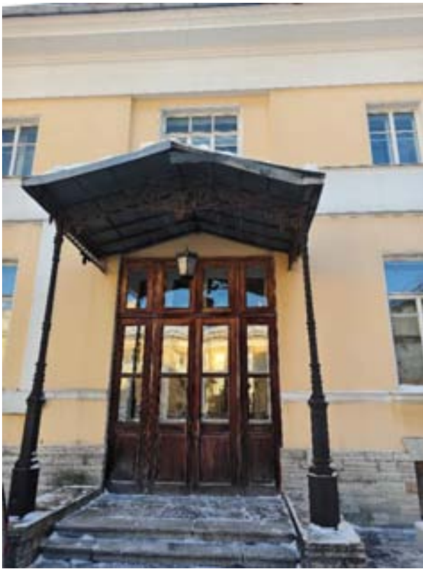
59. «Флигель служебный западный Михайловского дворца» (в составе «Дворец Великого князя Михаила Павловича (Русский музей Императора Александра III)»), г. Санкт-Петербург, Инженерная улица, дом 2-4, литера Г. Восточный дворовый фасад. Фрагмент. Фото 03.02.2026г.
