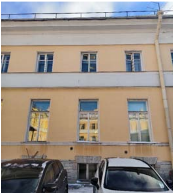
61. «Флигель служебный западный Михайловского дворца» (в составе «Дворец Великого князя Михаила Павловича (Русский музей Императора Александра III)»), г. Санкт-Петербург, Инженерная улица, дом 2-4, литера Г. Восточный дворовый фасад. Фрагмент. Фото 03.02.2026г.
