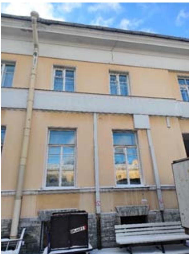
56. «Флигель служебный западный Михайловского дворца» (в составе «Дворец Великого князя Михаила Павловича (Русский музей Императора Александра III)»), г. Санкт-Петербург, Инженерная улица, дом 2-4, литера Г. Южный дворовый фасад. Фрагмент. Фото 03.02.2026г.
