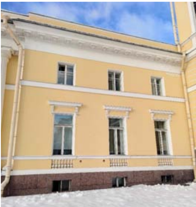
24. «Флигель служебный западный Михайловского дворца» (в составе «Дворец Великого князя Михаила Павловича (Русский музей Императора Александра III)»), г. Санкт-Петербург, Инженерная улица, дом 2-4, литера Г. Восточный лицевой фасад. Фрагмент. Фото 03.02.2026г.
