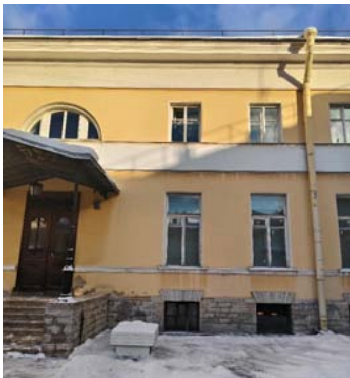
42. «Флигель служебный западный Михайловского дворца» (в составе «Дворец Великого князя Михаила Павловича (Русский музей Императора Александра III)»), г. Санкт-Петербург, Инженерная улица, дом 2-4, литера Г. Северный дворовый фасад. Фрагмент. Фото 03.02.2026г.
