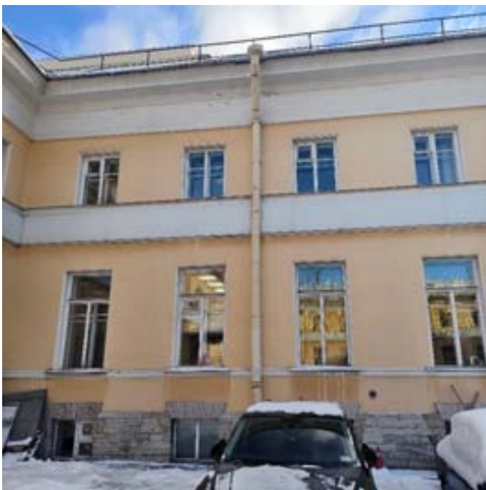
62. «Флигель служебный западный Михайловского дворца» (в составе «Дворец Великого князя Михаила Павловича (Русский музей Императора Александра III)»), г. Санкт-Петербург, Инженерная улица, дом 2-4, литера Г. Восточный дворовый фасад. Фрагмент. Фото 03.02.2026г.
