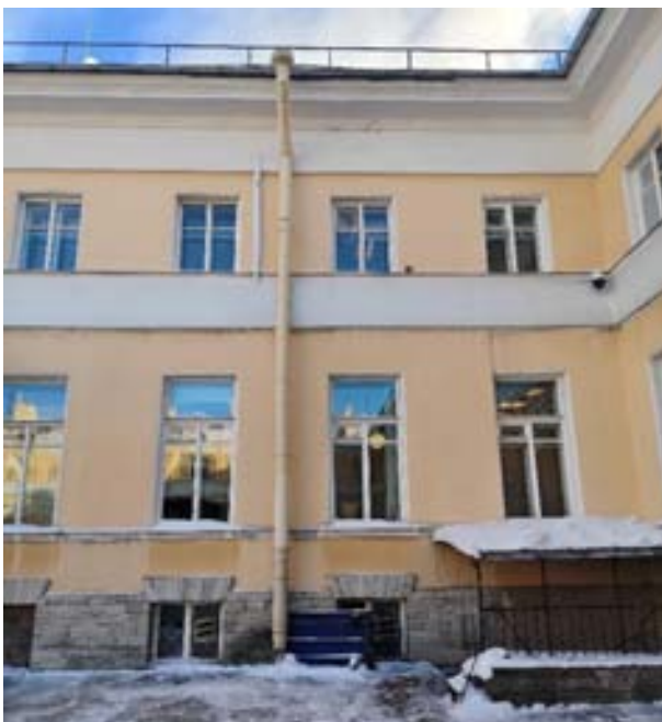
58. «Флигель служебный западный Михайловского дворца» (в составе «Дворец Великого князя Михаила Павловича (Русский музей Императора Александра III)»), г. Санкт-Петербург, Инженерная улица, дом 2-4, литера Г. Восточный дворовый фасад. Фрагмент. Фото 03.02.2026г.
