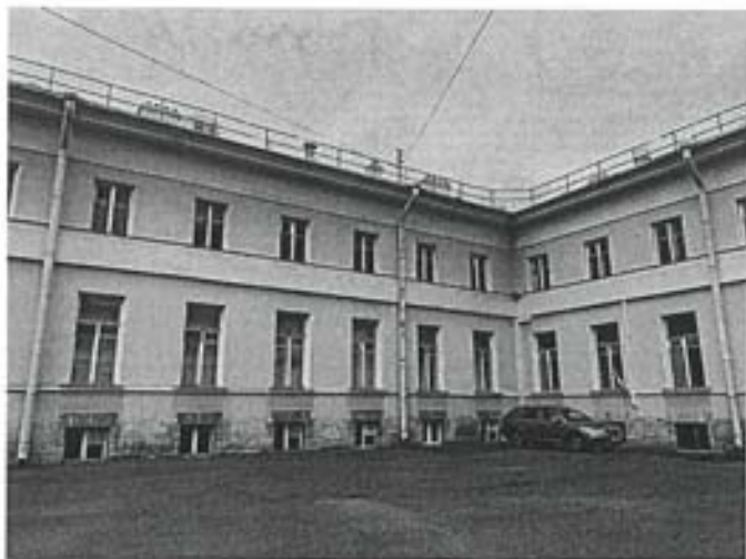
Фото 3. Фрагмент дворового фасада
