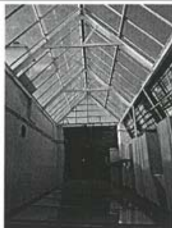
Фото 10. Фрагмент светового фонаря
