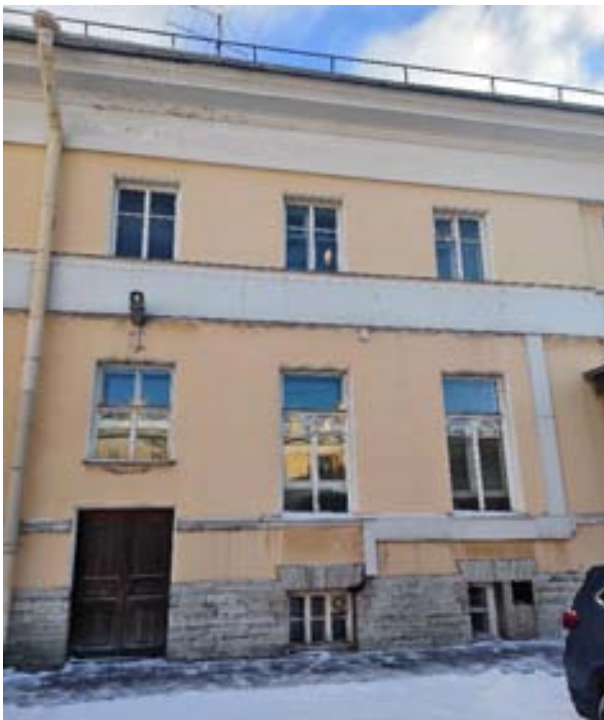
60. «Флигель служебный западный Михайловского дворца» (в составе «Дворец Великого князя Михаила Павловича (Русский музей Императора Александра III)»), г. Санкт-Петербург, Инженерная улица, дом 2-4, литера Г. Восточный дворовый фасад. Фрагмент. Фото 03.02.2026г.
