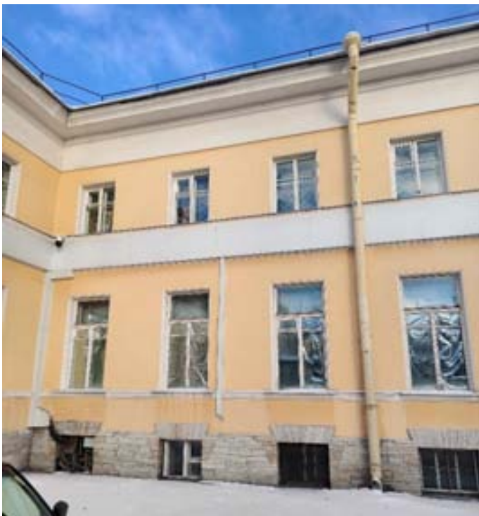
45. «Флигель служебный западный Михайловского дворца» (в составе «Дворец Великого князя Михаила Павловича (Русский музей Императора Александра III)»), г. Санкт-Петербург, Инженерная улица, дом 2-4, литера Г. Северный дворовый фасад. Фрагмент. Фото 03.02.2026г.
