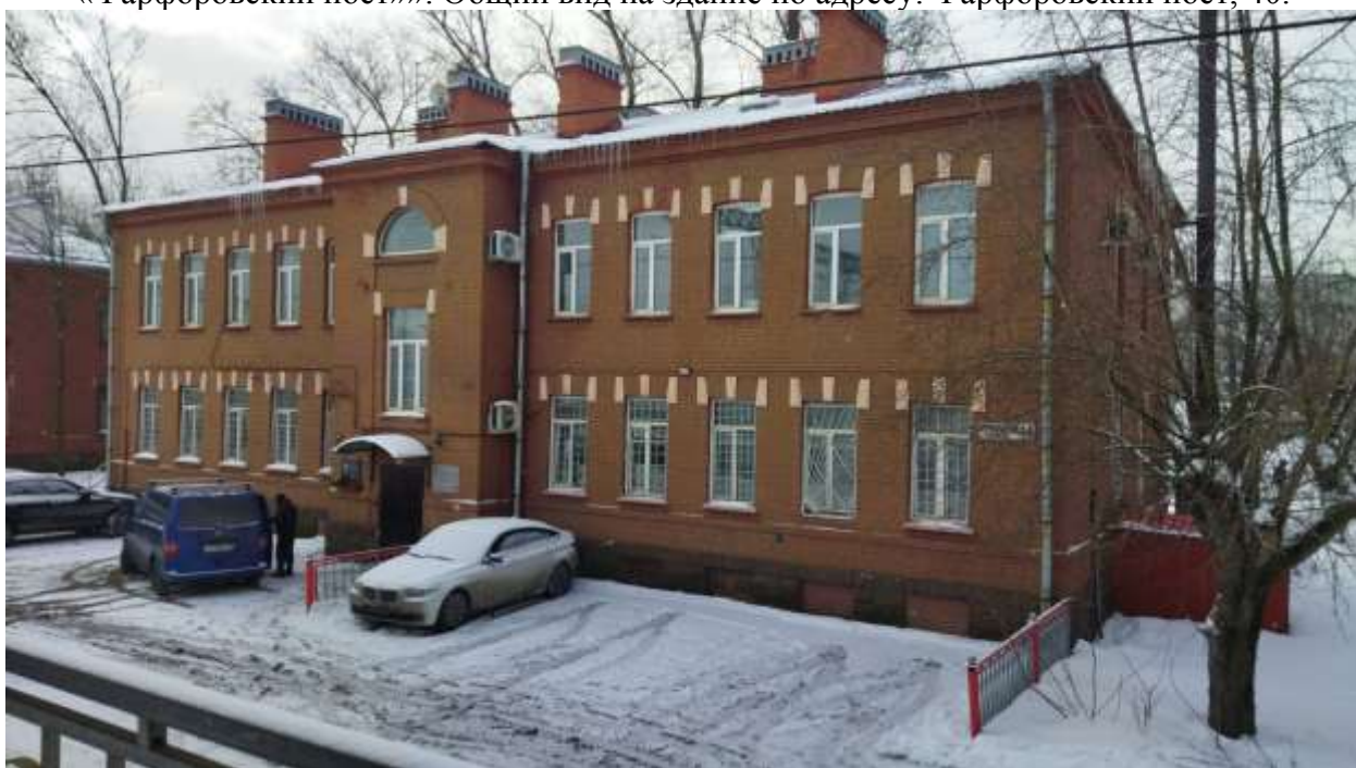
Фото 6. ОКН регионального значения «Историческая железнодорожная станция «Фарфоровский пост»». Общий вид на здание по адресу: Фарфоровский пост, 44.
