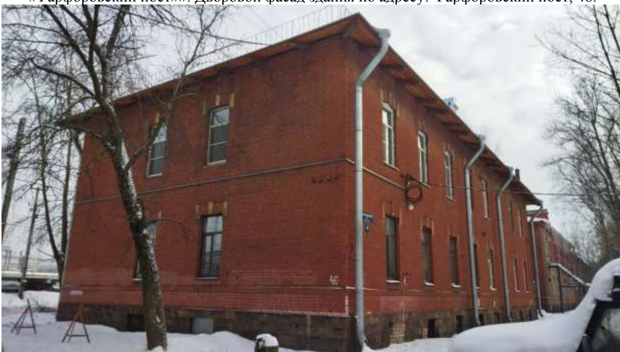
Фото 10. ОКН регионального значения «Историческая железнодорожная станция «Фарфоровский пост»». Дворовой фасад здания по адресу: Фарфоровский пост, 40.
