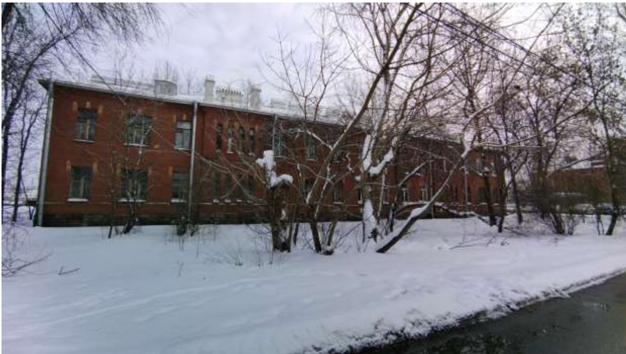
Фото 9. ОКН регионального значения «Историческая железнодорожная станция «Фарфоровский пост»». Дворовой фасад здания по адресу: Фарфоровский пост, 48.
