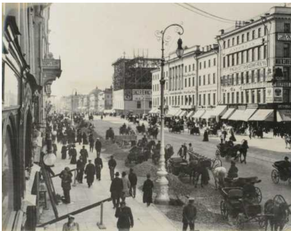
24. Строительство Дома компании «Зингер» на углу Невского проспекта. Фотография. 1902-1903 гг. https://www.citywalls.ru/
