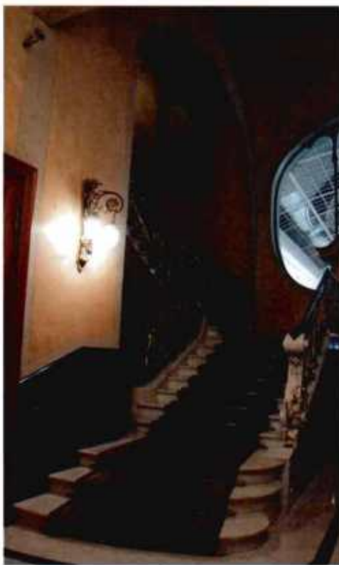
3. Общий вид на лестницу объекта культурного наследия.
