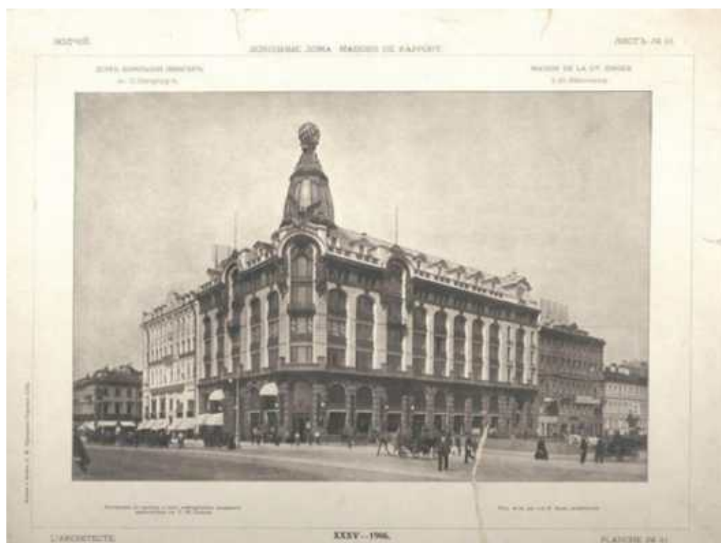
28. Дом компании «Зингер» в С.-Петербурге. Фотография. 1906 г. Опубликовано в: Зодчий. Журнал архитектурный и художественно-технический орган Императорского СПб. общества архитекторов. – № 39. СПб., 1906. С. 390.
