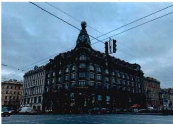
1. Общий вид на объект культурного наследия.
