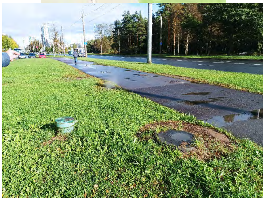
27. Земельный участок проектирования реконструкции распределительной сети. Дата съемки: 10.10.2025г.
