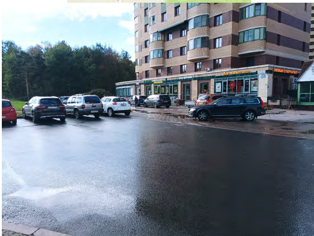
24. Земельный участок проектирования реконструкции распределительной сети. Дата съемки: 10.10.2025г.
