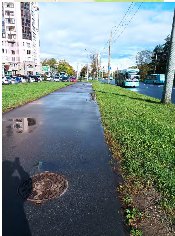
21. Земельный участок проектирования реконструкции распределительной сети. Дата съемки: 10.10.2025г.
