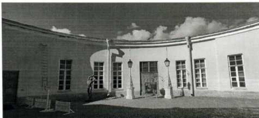
8. Северный фасад полукруглого двора
