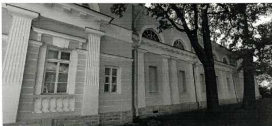
13. Восточный фасад. Фрагмент
