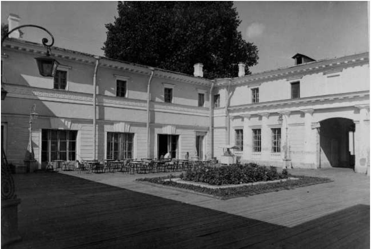
26. «Корпус конюшенный» (в составе «Ансамбль Елагина острова») (Елагин остров, д 4, лит. Д). Внутренний двор. Архив КГИОП. Паспорт 98-3_83 П. «Конюшенный корпус Елагина дворца».
