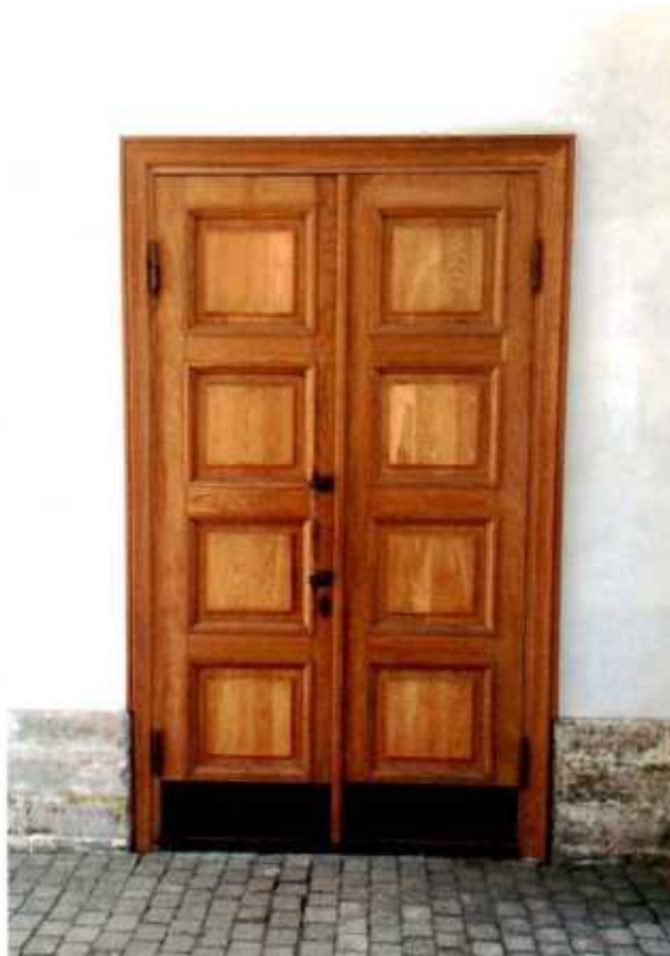
7. «корпус конюшенный». Дворовой фасад. Фрагмент.
