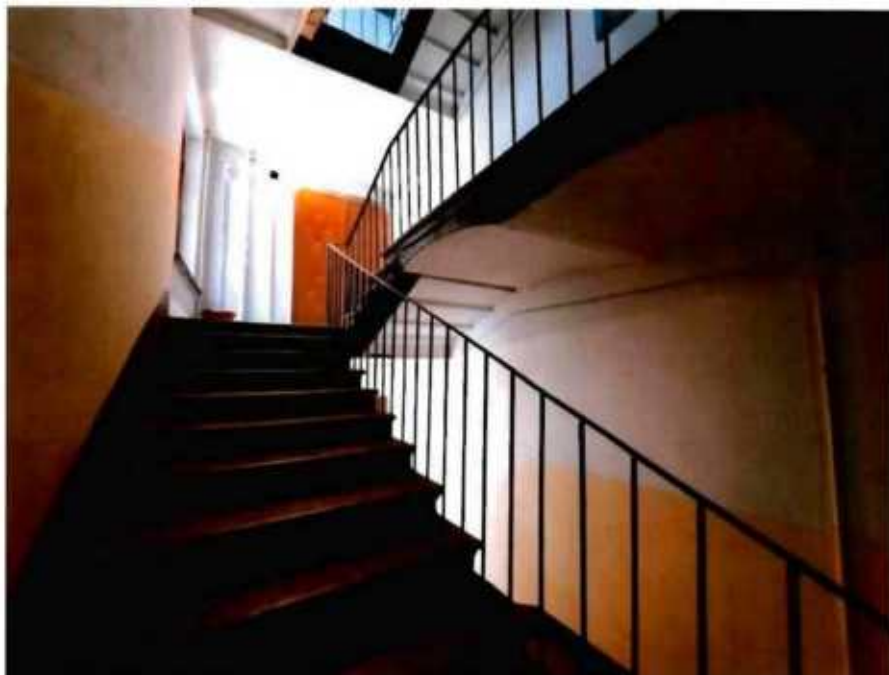
16. Интерьеры объекта культурного наследия. Лестница 5ЛК
