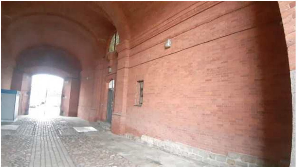
31. «Арсенал (в составе «Кронверк Петропавловской крепости»)). (Александровский парк, д. 7, лит. А). Арочный проезд. Фото мест установки оборудования и прокладки кабельных трасс. Штиглиц М.С. 17.12.2025.
