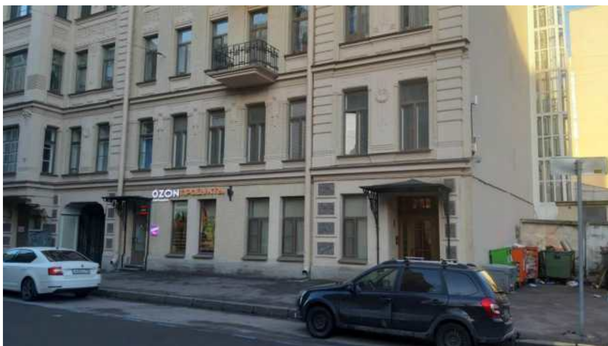
6. «Дом П.Н. Парусова» (Введенская ул., д. 19, лит. А). Лицевой фасад. Фото мест установки оборудования и прокладки кабельных трасс. Штиглиц М.С. 17.12.2025.
