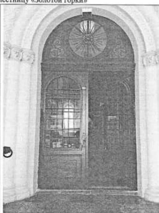
20. Вид на дверной проем с площадки «Золотой горки»
