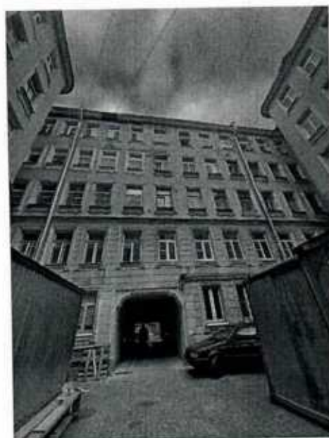
10. Фрагмент дворового фасада
