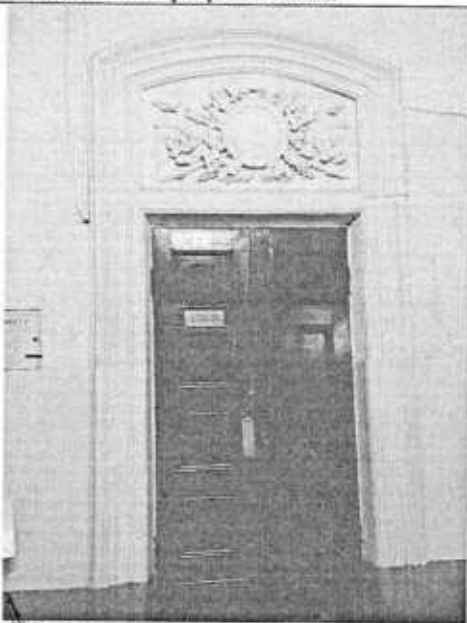
58. Вид на дверной проем 1-го этажа
