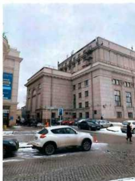
5. Фрагмент восточного фасада объекта культурного наследия.
