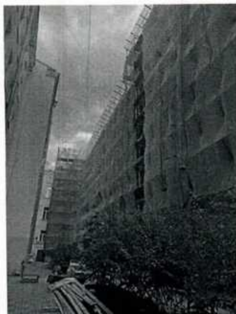
6. Фрагмент дворового фасада
