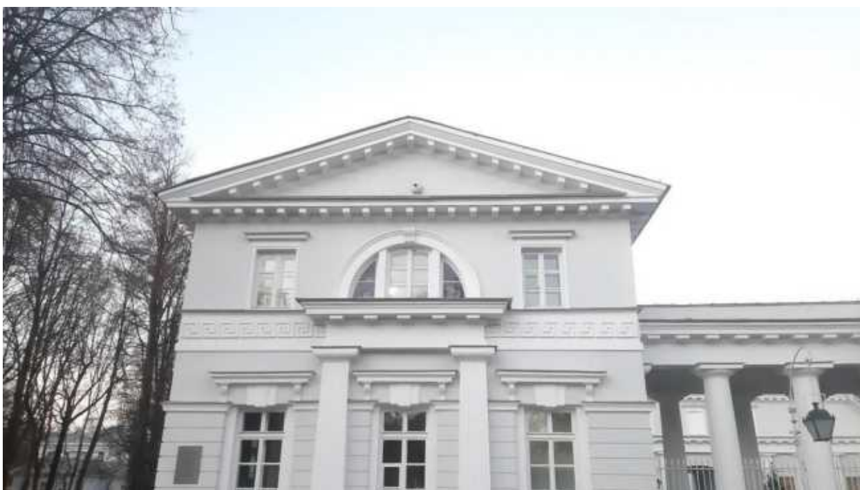
14. «Корпус конюшенный» (в составе «Ансамбль Елагина острова») (Елагин остров, д. 4, лит. Д). Лицевой фасад. Фото мест установки оборудования и прокладки кабельных трасс. Штиглиц М.С. 17.12.2025.
