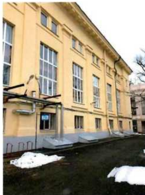
7. Фрагмент южного фасада объекта объекта культурного наследия.
