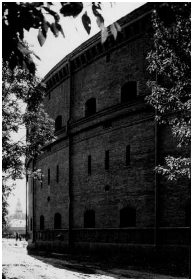
20. «Арсенал» (в составе «Кронверк Петропавловской крепости») (Александровский парк, д. 7, лит. А). Фрагмент северо-восточного фасада. Фото 1981. Архив КГИОП. Паспорт П 90-37_78 П. «Арсенал и ров Кронверка».
