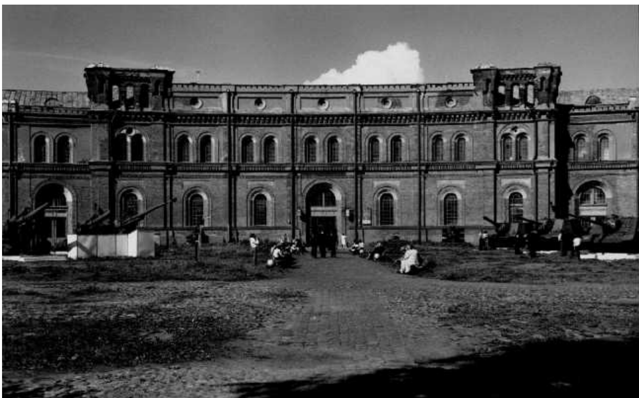
18. «Арсенал» (в составе «Кронверк Петропавловской крепости») (Александровский парк, д. 7, лит. А). Центральная часть южного лицевого фасада. Фото 1981. Архив КГИОП. Паспорт П 90-37_78 П. «Арсенал и ров Кронверка».
