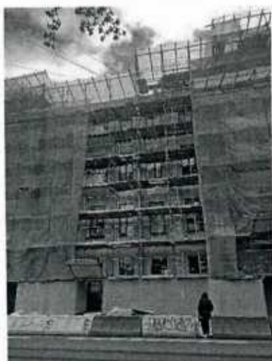
3. Фрагмент фасада со стороны ул. Введенская
