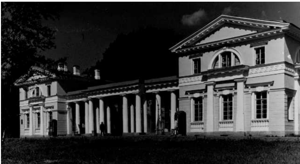
24. «Корпус конюшенный» (в составе «Ансамбль Елагина острова») (Елагин остров, д 4, лит. Д). Южный фасад. Вид с Масляного луга. 1968. Архив КГИОП. Паспорт 98-3_83 П. «Конюшенный корпус Елагина дворца».
