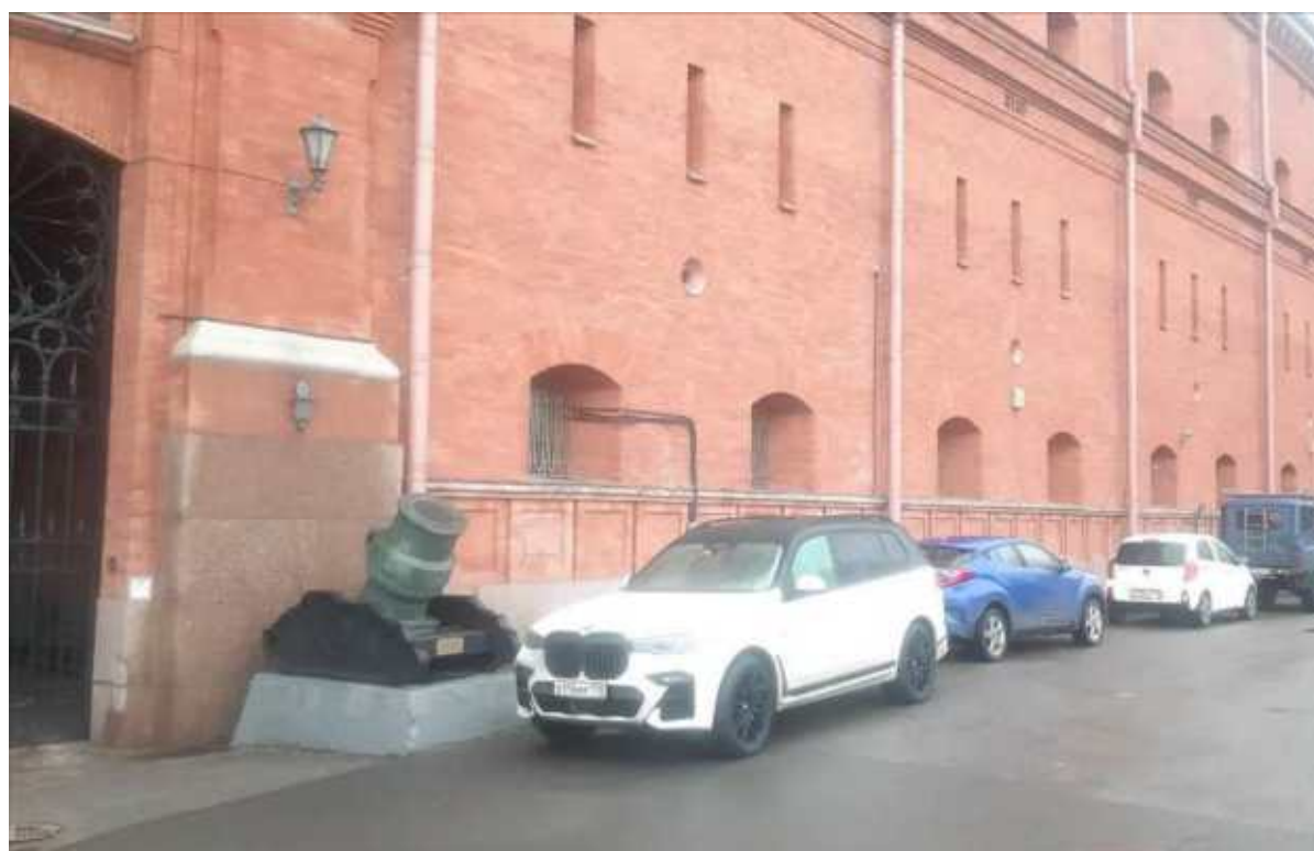
38. «Арсенал (в составе «Кронверк Петропавловской крепости»)». (Александровский парк, д. 7, лит. А). Фрагмент лицевого фасада. Фото мест установки оборудования и прокладки кабельных трасс. Штиглиц М.С. 17.12.2025.
