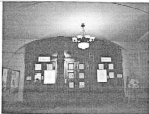
44. Вид на дверное заполнение входа
