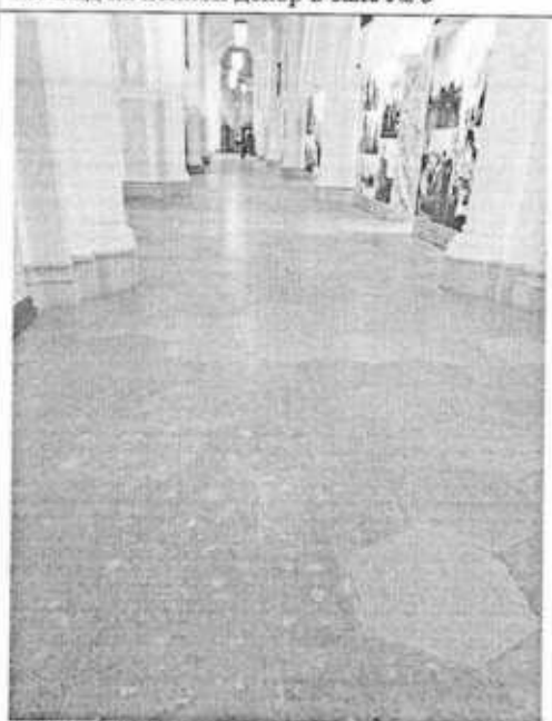
54. Вид на каменную облицовку пола в зале 2-го этажа
