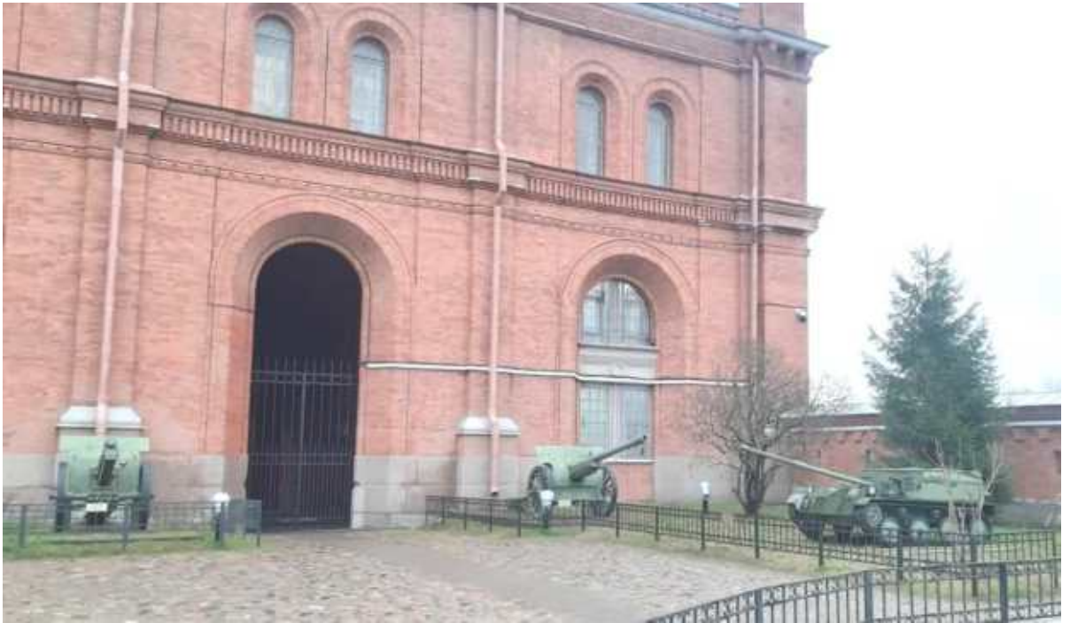
29. «Арсенал (в составе «Кронверк Петропавловской крепости»)). (Александровский парк, д. 7, лит. А). Фрагмент лицевого фасада. Фото мест установки оборудования и прокладки кабельных трасс. Штиглиц М.С. 17.12.2025.
