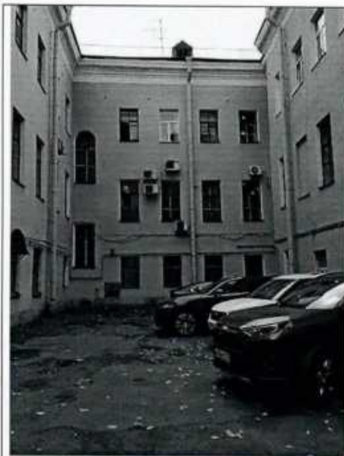
13. Вид на дворовые фасады
