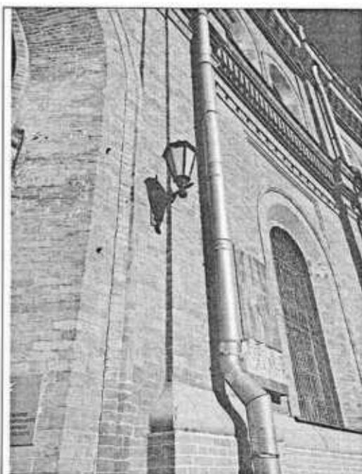
11. Вид на фрагмент фасада с фонарем
