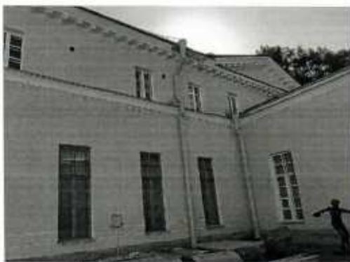
11. Фрагмент южного фасада полукруглого двора
