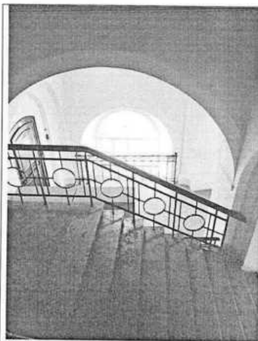
47. Фрагмент лестницы центральной части
