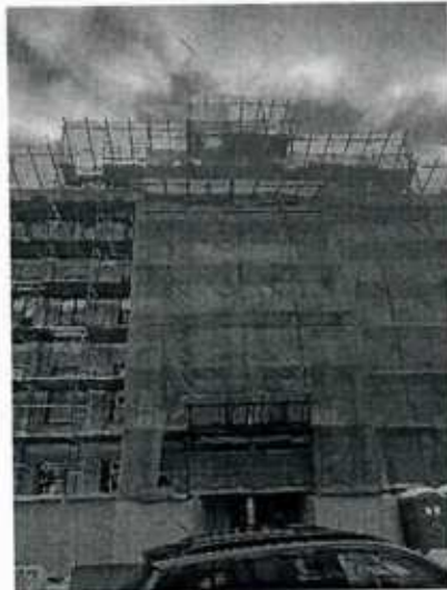
1. Фрагмент фасада со стороны ул. Введенская
