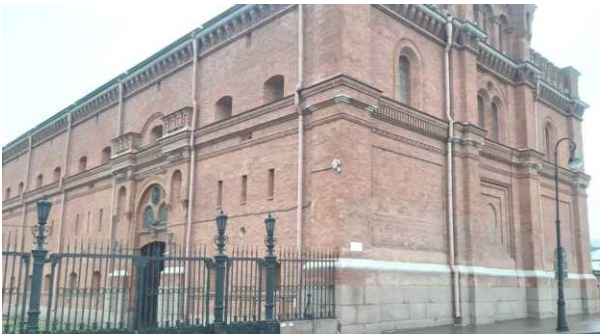
27. «Арсенал (в составе «Кронверк Петропавловской крепости»)». (Александровский парк, д. 7, лит. А). Лицевой фасад. Фото мест установки оборудования и прокладки кабельных трасс. Штиглиц М.С. 17.12.2025.
