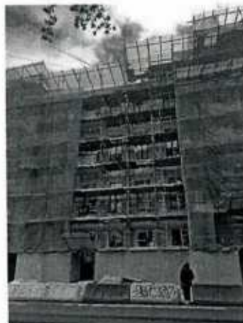
4. Фрагмент фасада со стороны ул. Введенская
