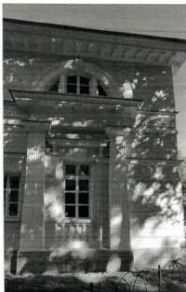
4. Западный фасад. Фрагмент.
