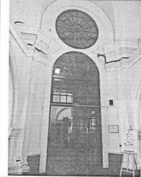
57. Вид на арочный проем 1-го этажа
