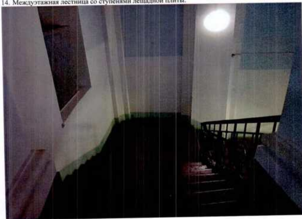
14. Междуэтажная лестница со ступенями лещадной плиты.
