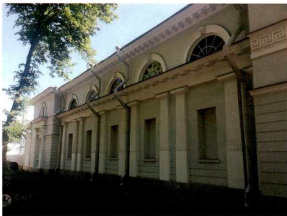
2. «корпус конюшенный». Вид с западной стороны.
