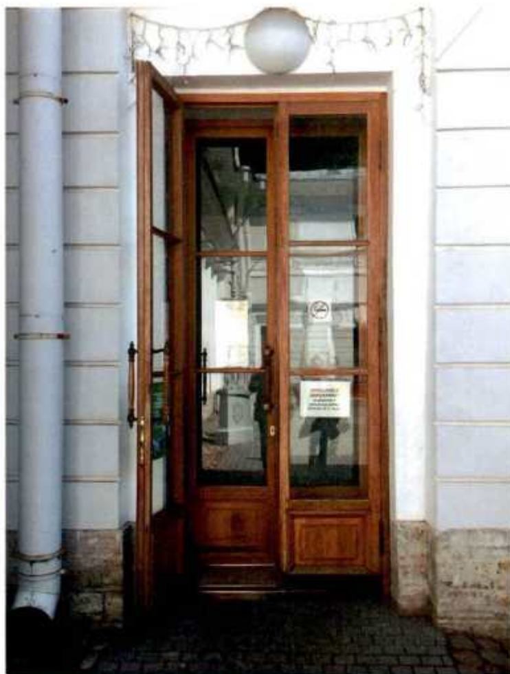
8. «корпус конюшенный». Дворовой фасад. Фрагмент.
