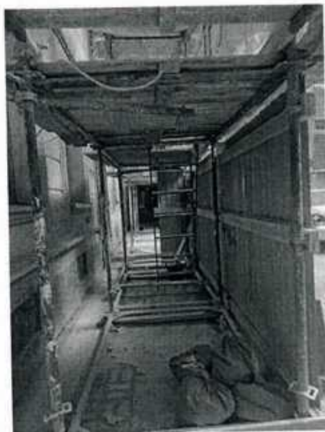
7. Фрагмент дворового фасада
