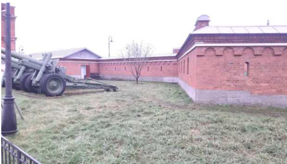
28. «Арсенал (в составе «Кронверк Петропавловской крепости»)». (Александровский парк, д. 7, лит. А). Дворовые фасады. Фото мест установки оборудования и прокладки кабельных трасс. Штиглиц М.С. 17.12.2025.
