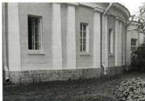
12. Восточный фасад. Фрагмент.
