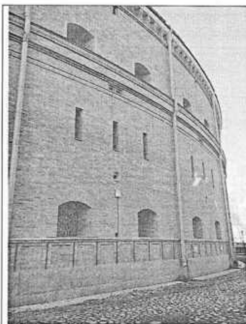
16. Вид на фрагмент фасада с восточной стороны
