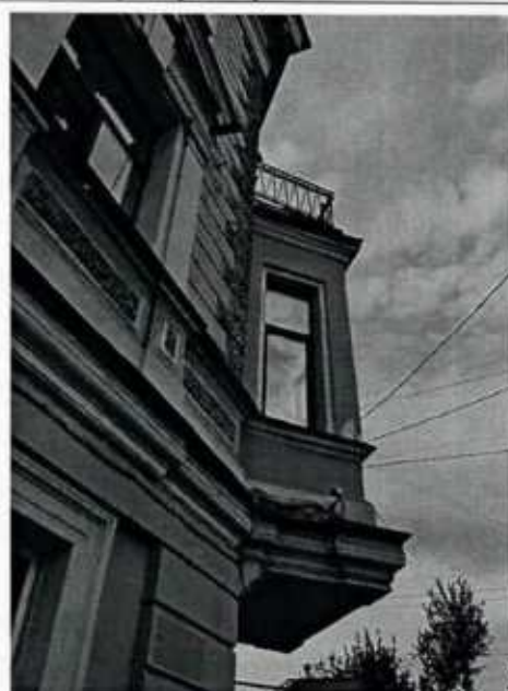
4. Фрагмент лицевого фасада с эркером
