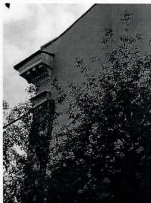
5. Вид на фрагмент фасада с карнизом
