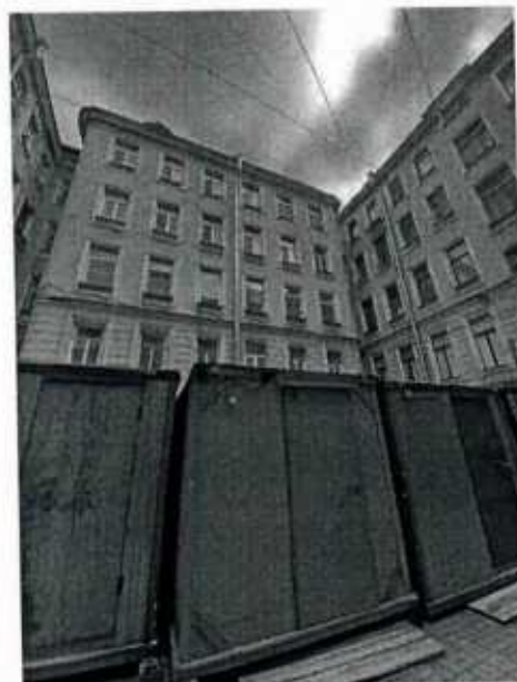
8. Фрагмент дворового фасада
