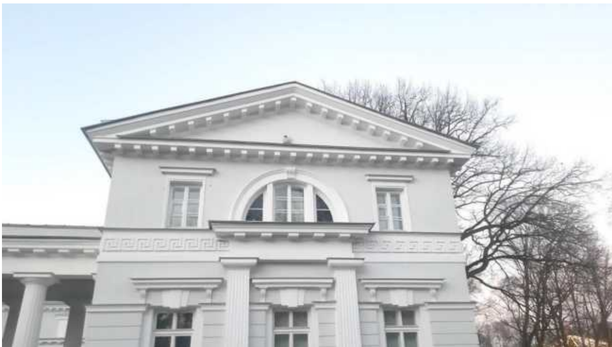
13. «Корпус конюшенный» (в составе «Ансамбль Елагина острова») (Елагин остров, д. 4, лит. Д). Лицевой фасад. Фото мест установки оборудования и прокладки кабельных трасс. Штиглиц М.С. 17.12.2025.
