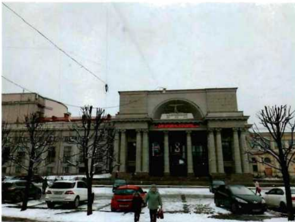
1. Фрагмент северного фасада объекта культурного наследия.
