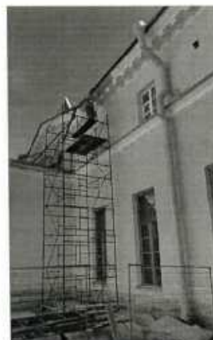
10. Фрагмент южного фасада полукруглого двора
