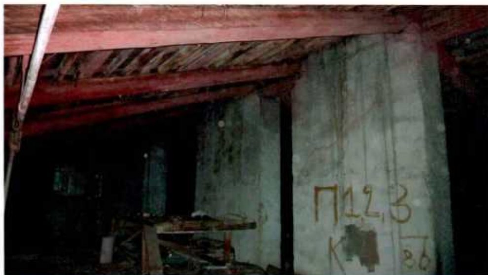
10. Стропильная система. Чердак.
