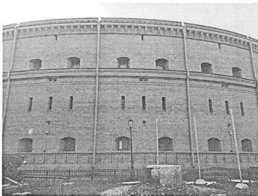
15. Общий вид на фасад с северной стороны
