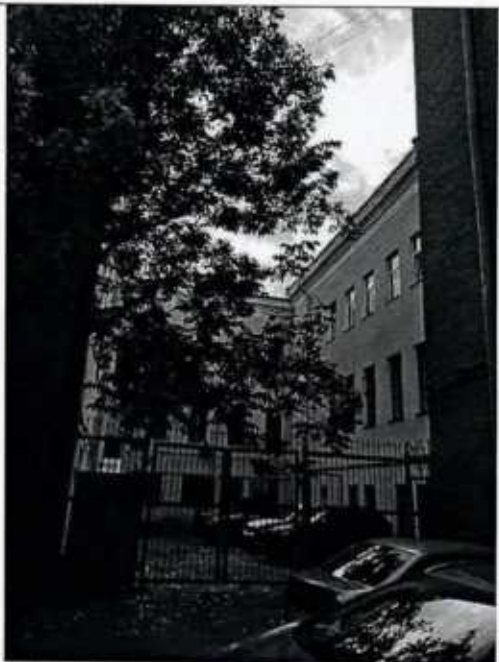
9. Вид на дворовую часть здания
