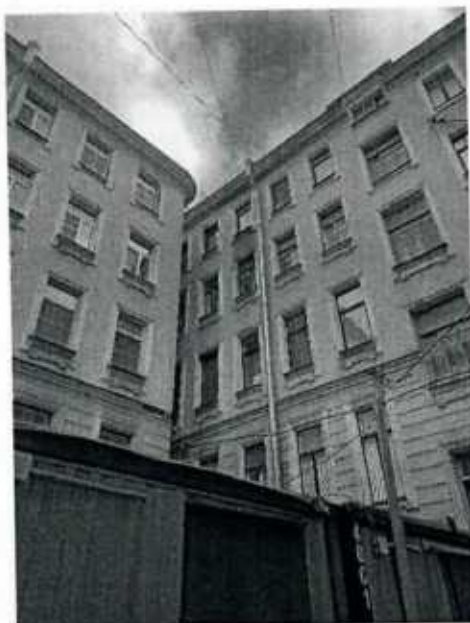
9. Фрагмент дворового фасада
