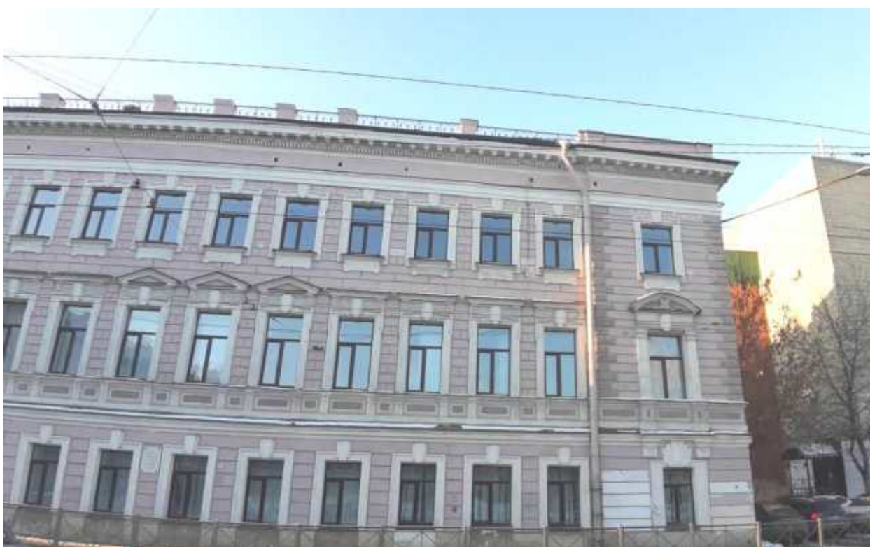
2. «Дом, где в 1892-1918 гг. жил и работал физиолог Павлов Иван Петрович (б. кв.2)» (Большая Пушкарская ул., д. 18, лит. А). Лицевой фасад. Фото мест установки оборудования и прокладки кабельных трасс. Штиглиц М.С. 17.12.2025.
