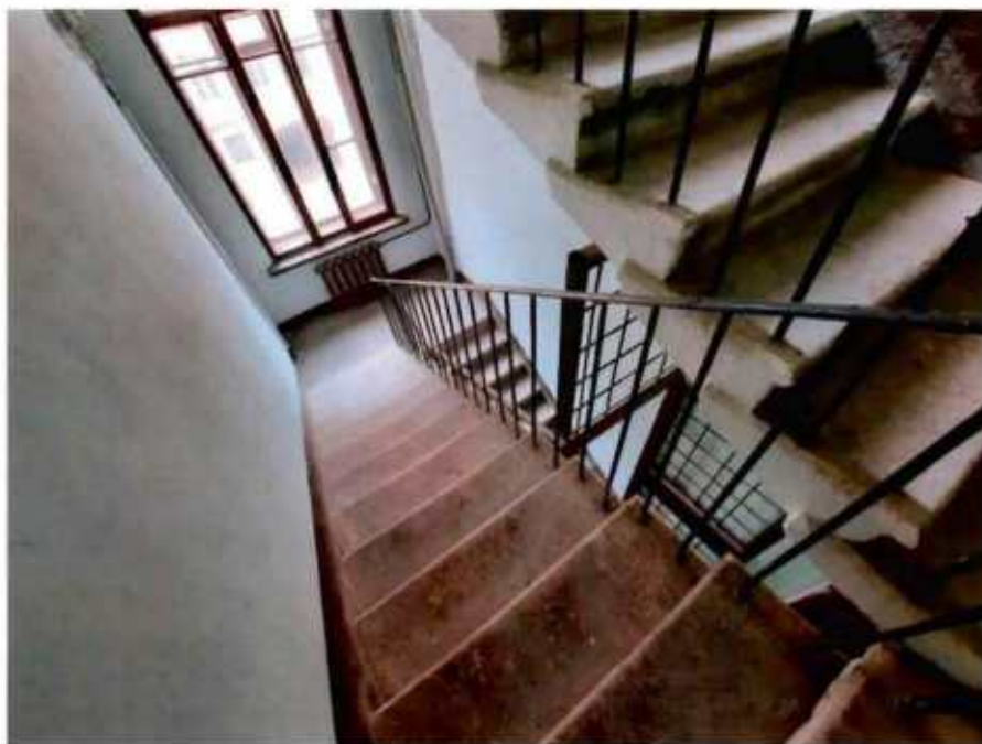
15. Интерьеры объекта культурного наследия. Лестница 3ЛК
