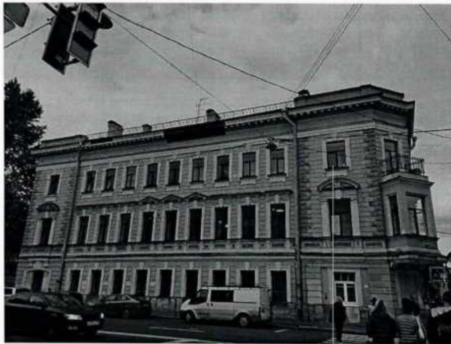
1. Общий вид лицевого фасада со стороны Введенской улицы
