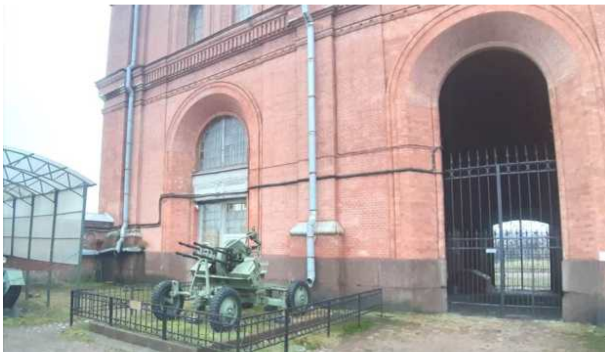
34. «Арсенал (в составе «Кронверк Петропавловской крепости»)). (Александровский парк, д. 7, лит. А). Дворовые фасады. Фото мест установки оборудования и прокладки кабельных трасс. Штиглиц М.С. 17.12.2025.
