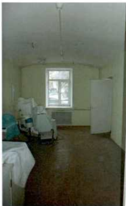
16. Помещение 1-Н (ч. п. 46). Сводчатые перекрытия.
