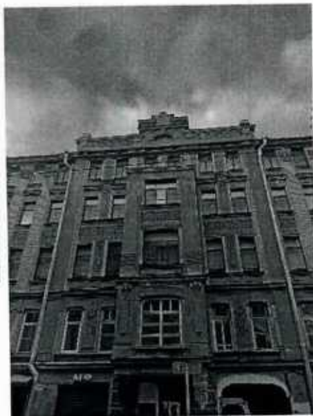
12. Фрагмент фасада со стороны ул. Лизы Чайкиной
