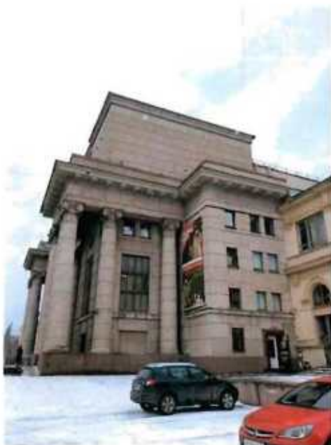
2. Западный фасад объекта культурного наследия.
