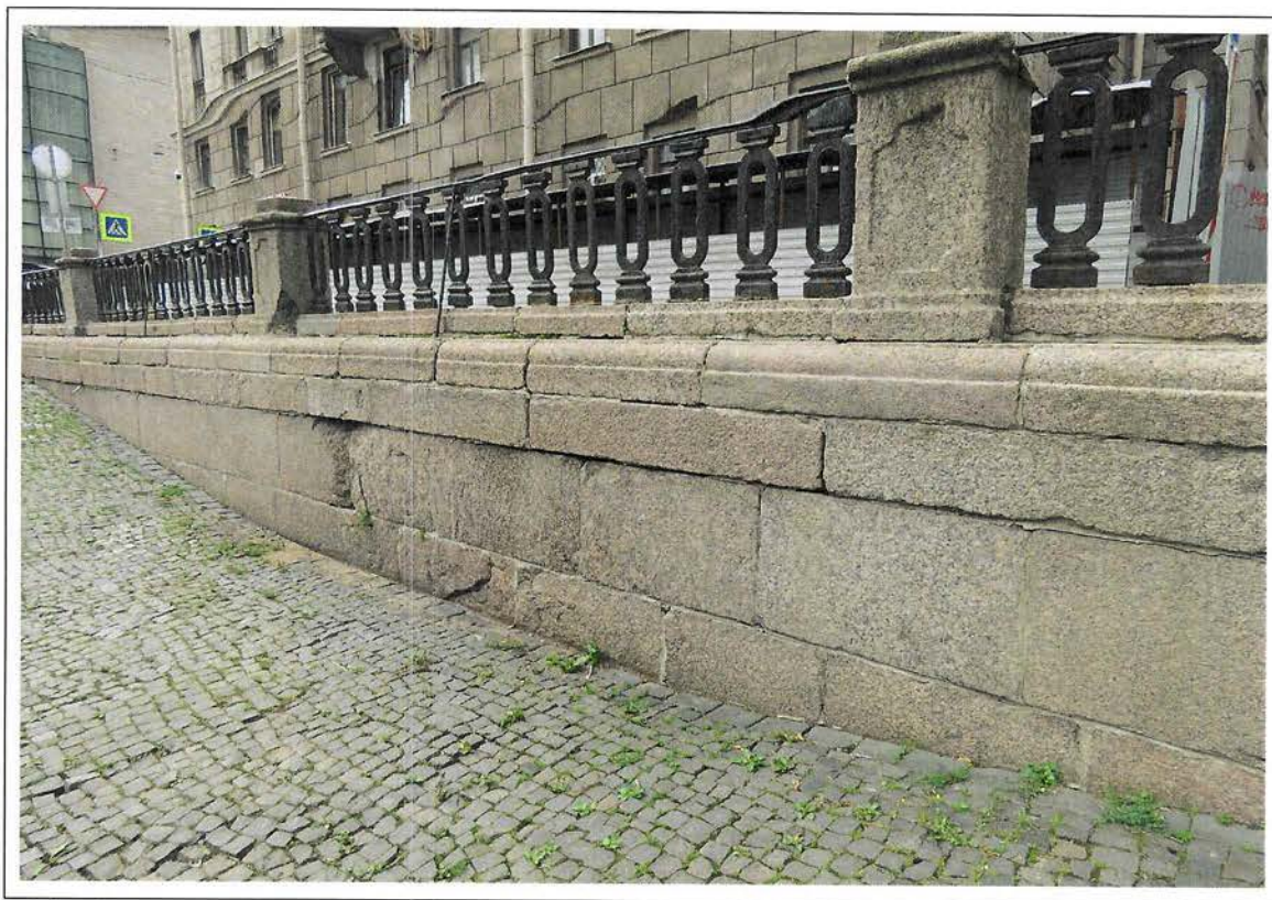
Рис. 31. Сколы облицовки задней стенки вследствие термического воздействия. Скол основания тумбы
