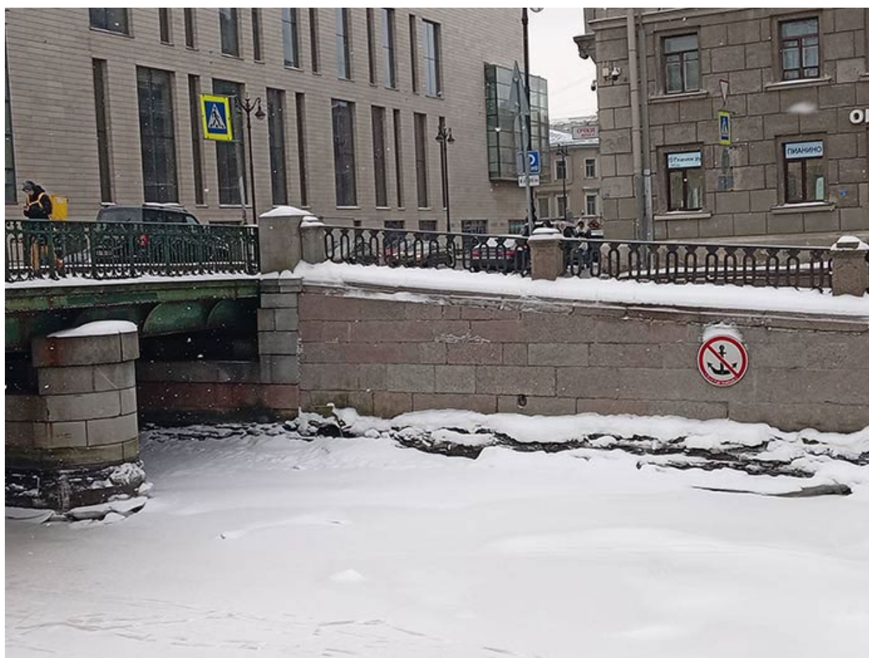
Фото 3. Объект культурного наследия регионального значения «Набережная Крюкова канала» по адресу: Санкт-Петербург, наб. Крюкова канала, мост Декабристов - Матвеев мост, литера А (правый берег)
