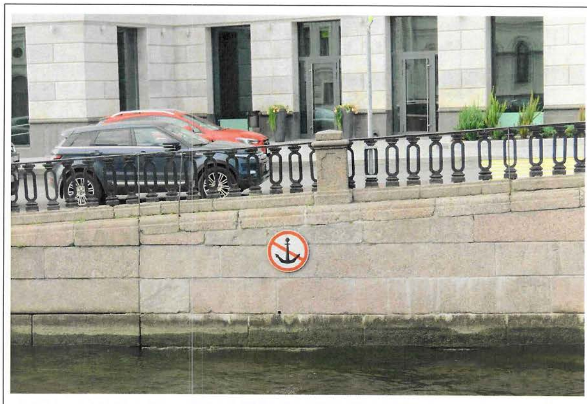
Рис. 18. Знак “Якорей не бросать” и выпуск дренажа на участке переменной высоты у устья Матвеева моста
