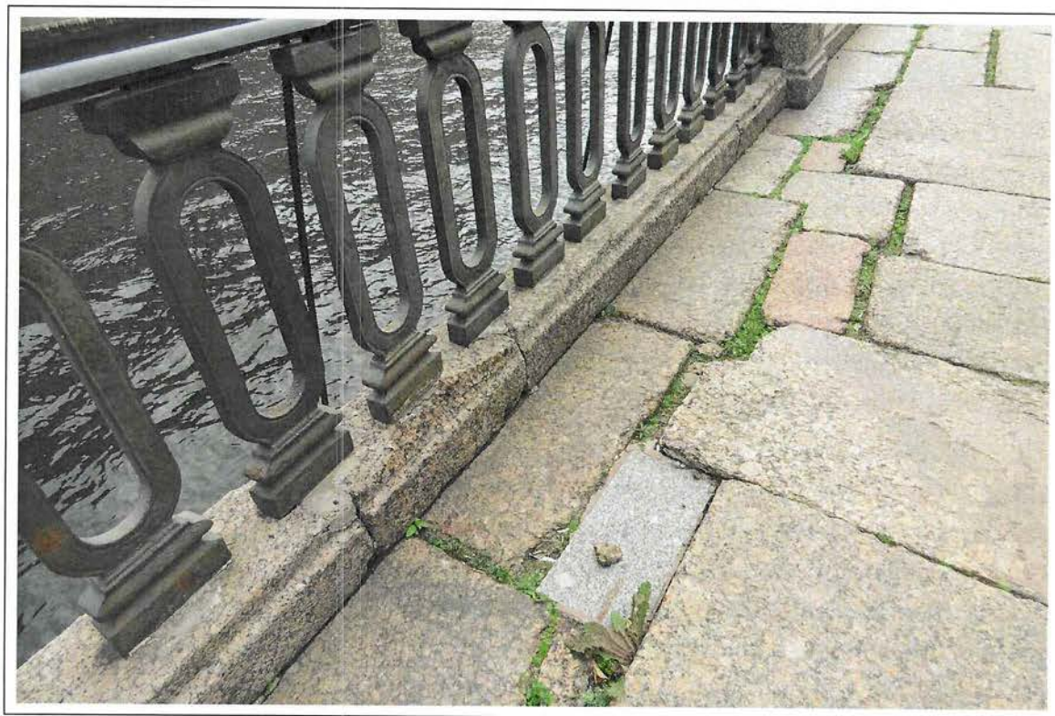
Рис. 15. Скол гранитного основания балясин в секции перил №11
