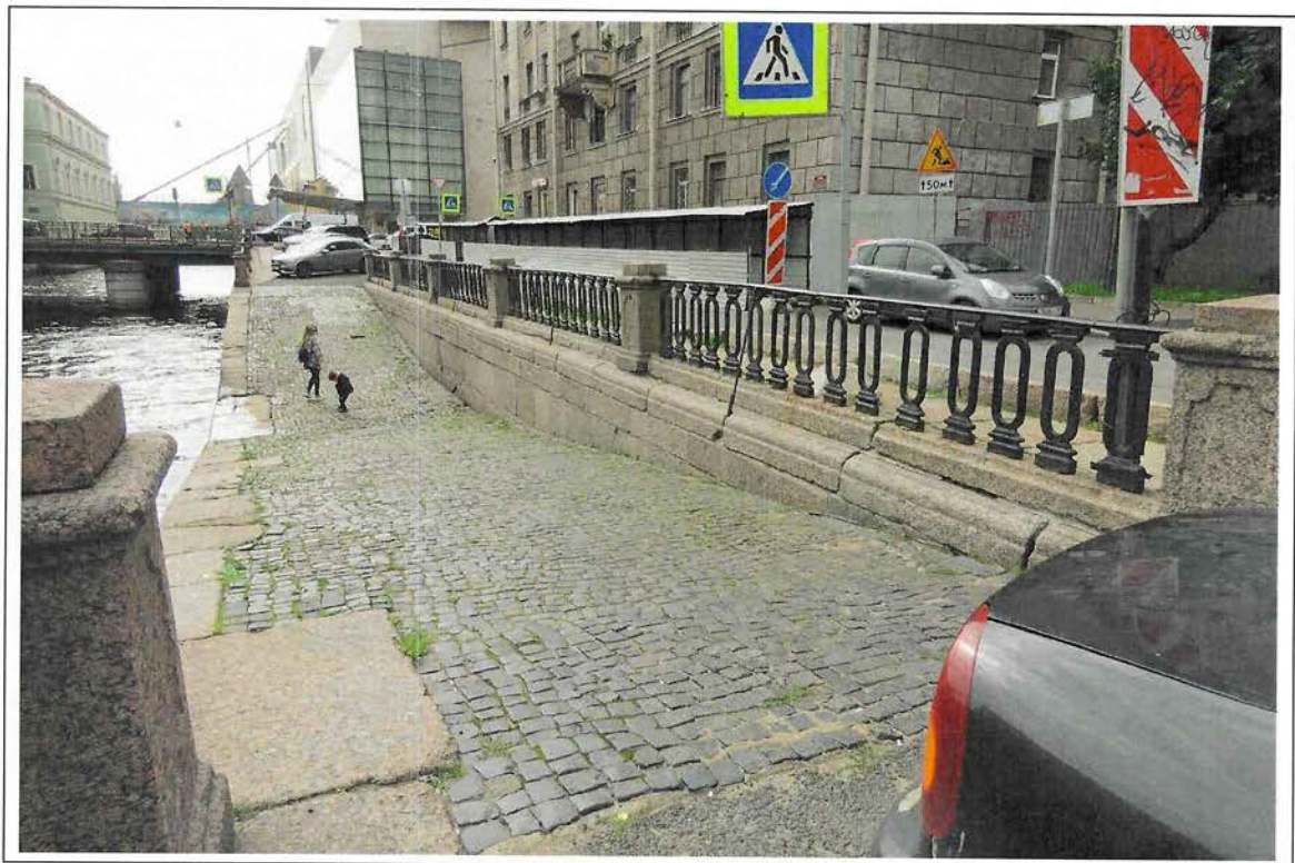
Рис. 28. Диабазовое мощение пандусов спуска
