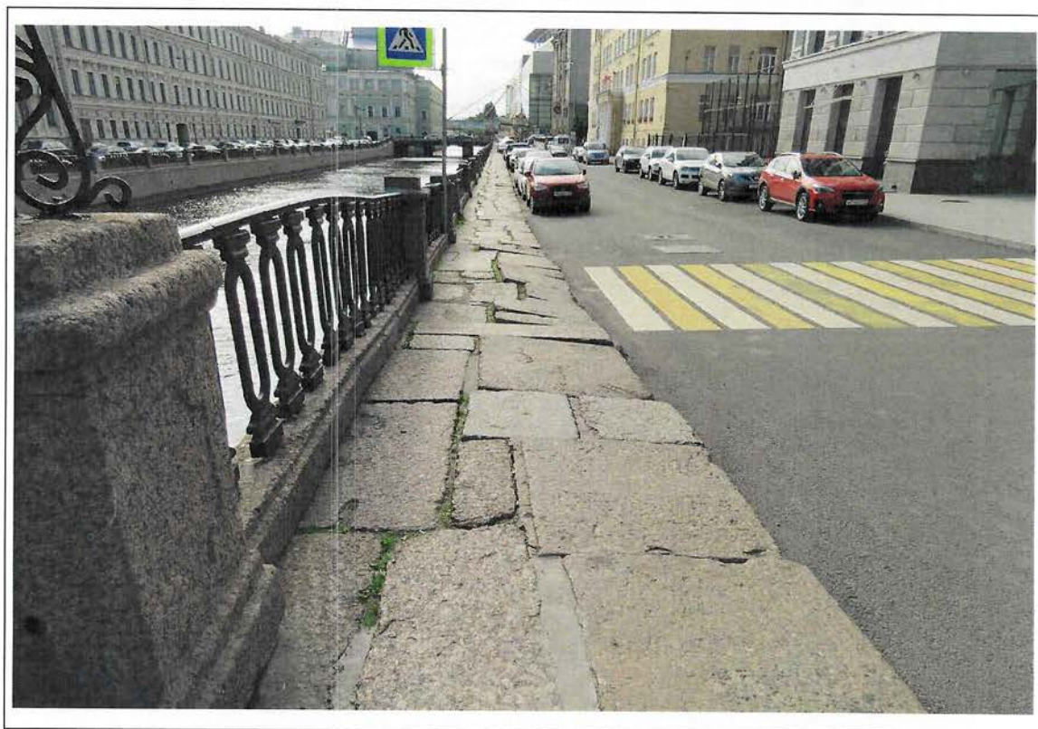
Рис.8. Тротуар на участке сопряжения с устоем Матвеева моста
