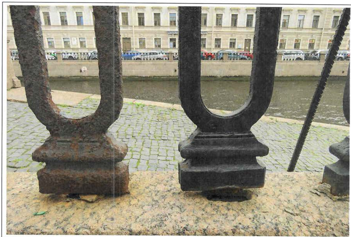
Рис. 34. Не окрашенная и не закрепленная в основании балясина
