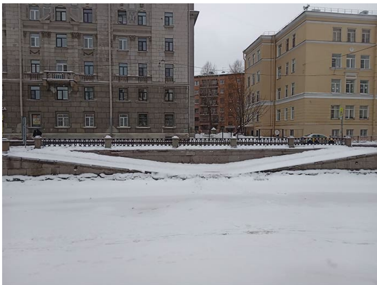
Фото 4. Объект культурного наследия регионального значения «Набережная Крюкова канала» по адресу: Санкт-Петербург, наб. Крюкова канала, мост Декабристов - Матвеев мост, литера А (правый берег)
