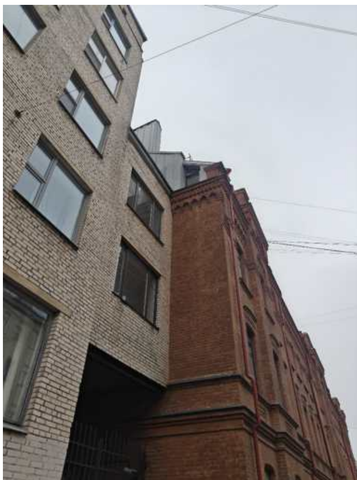
Фото 6. Фрагмент дворового фасада выявленного объекта культурного наследия «Казарма для трех рот», входящего в состав выявленного объекта культурного наследия «Комплекс казарм 18-го Саперного батальона»
