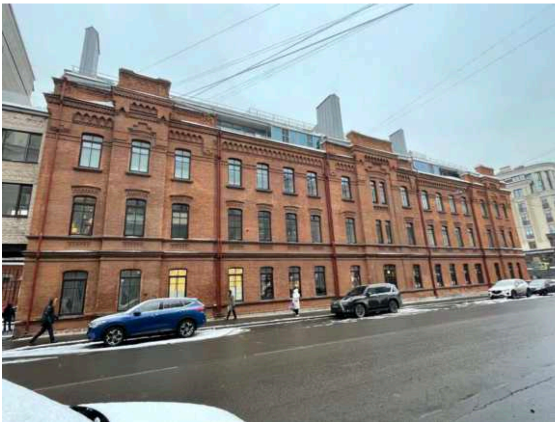
Фото 1. Фрагмент лицевого фасада выявленного объекта культурного наследия «Казарма для трех рот», входящего в состав выявленного объекта культурного наследия «Комплекс казарм 18-го Саперного батальона»
