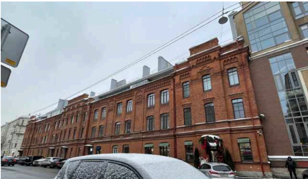
Фото 3. Фрагмент лицевого фасада выявленного объекта культурного наследия «Казарма для трех рот», входящего в состав выявленного объекта культурного наследия «Комплекс казарм 18-го Саперного батальона»
