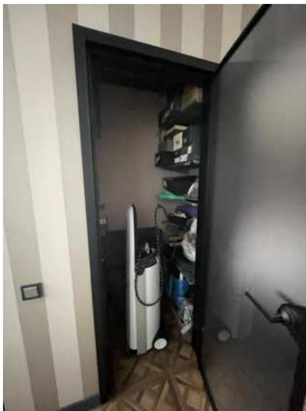
Фото 20. Интерьер квартиры № 88 выявленного объекта культурного наследия «Казарма для трех рот», входящего в состав выявленного объекта культурного наследия «Комплекс казарм 18-го Саперного батальона»
