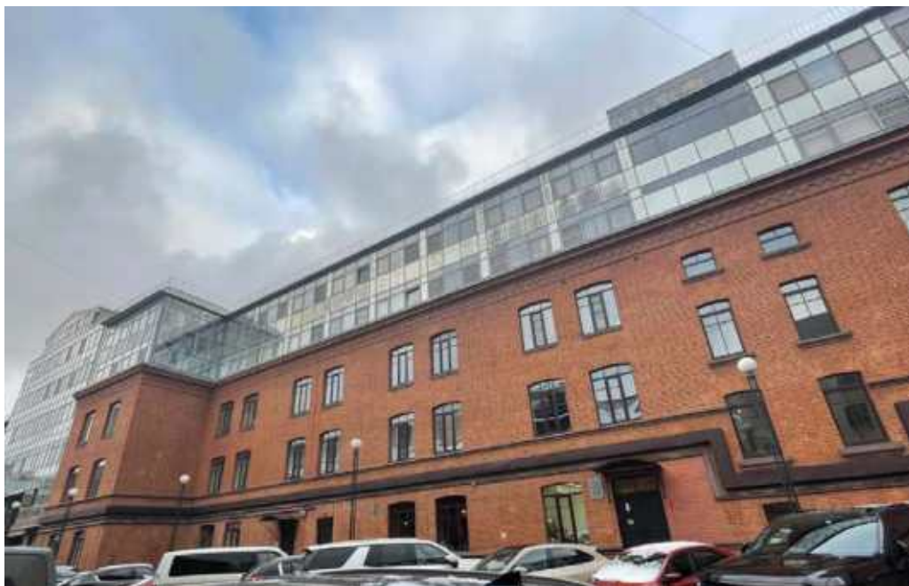
Фото 5. Фрагмент дворового фасада выявленного объекта культурного наследия «Казарма для трех рот», входящего в состав выявленного объекта культурного наследия «Комплекс казарм 18-го Саперного батальона»
