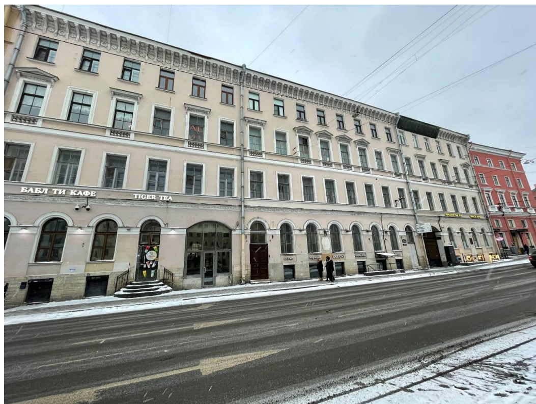
Фото 2. Лицевой фасад объекта культурного наследия регионального значения «Дом, где жили: в 1837 г. актриса Асенкова Варвара Николаевна, до 1843 г. издатель Краевский Андрей Александрович (кв. 47), в 1842-1846 гг. революционный демократ, писатель и литературный критик Белинский Виссарион Григорьевич (кв. 55, 48, 47, 43)»
