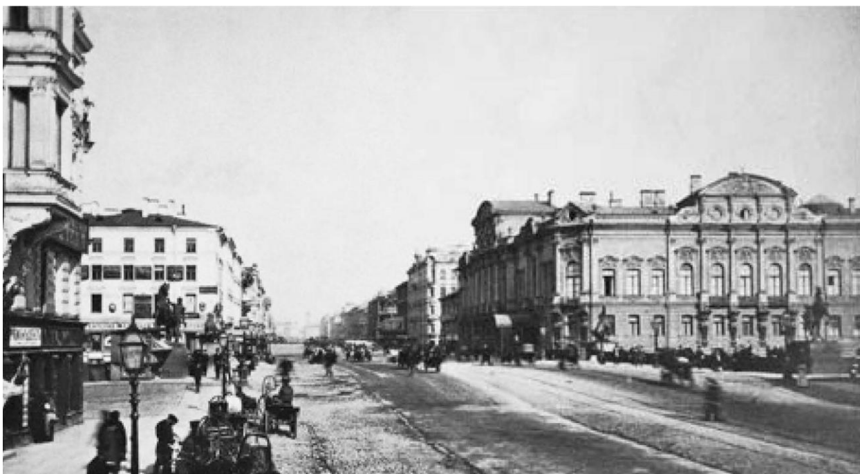
21. Невский проспект. Слева за Аничковым мостом дом генерал-майора Семянникова. Фото 1880-х гг. — Доходный дом (левая часть) // Citywalls.ru – архитектурный сайт Петербурга [Электронный ресурс]. URL: https://www.citywalls.ru/house15023.html .
