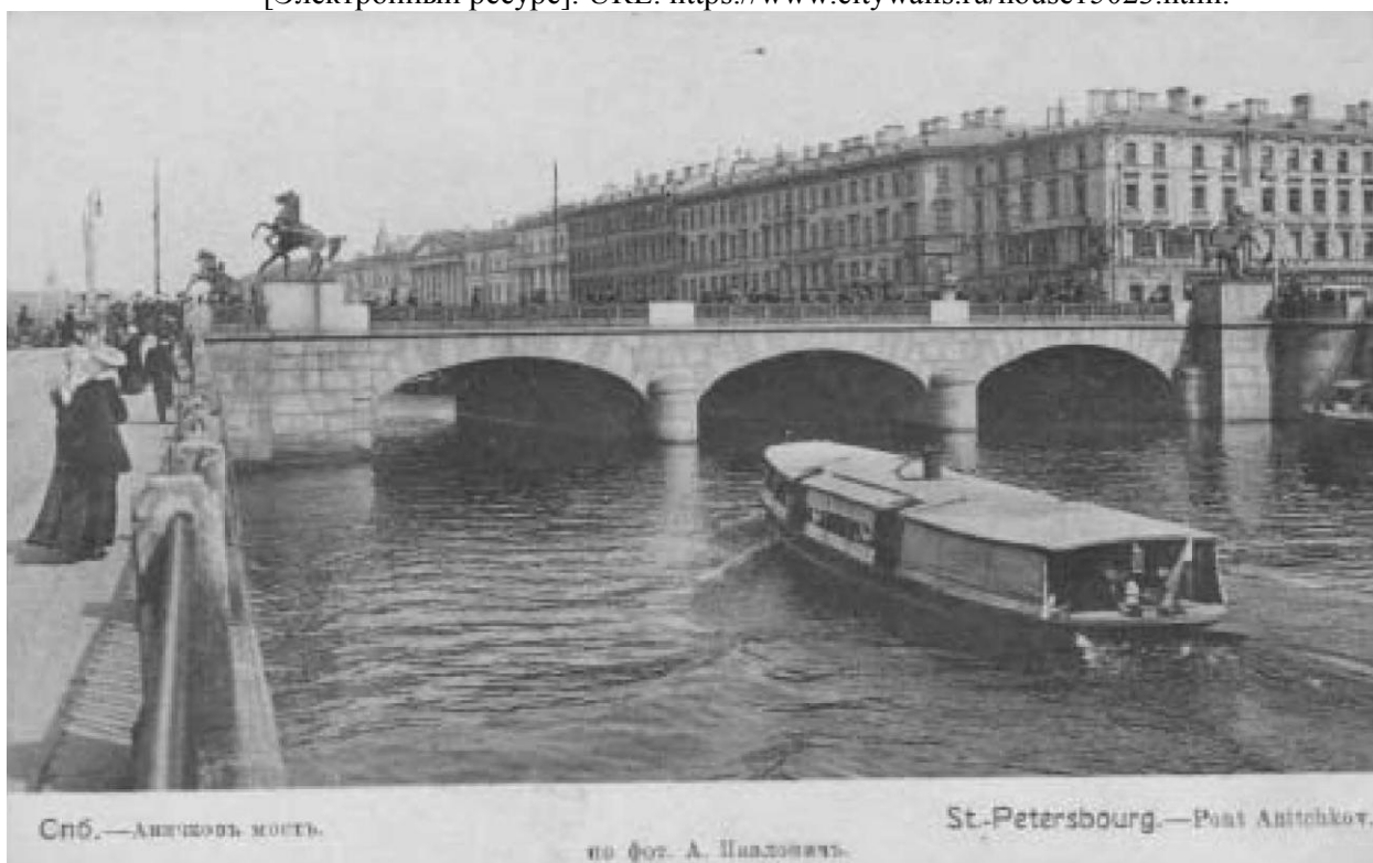
22. Аничков мост. Фото начала XX в. — Доходный дом (левая часть) // Citywalls.ru – архитектурный сайт Петербурга [Электронный ресурс]. URL: https://www.citywalls.ru/house15023.html .
