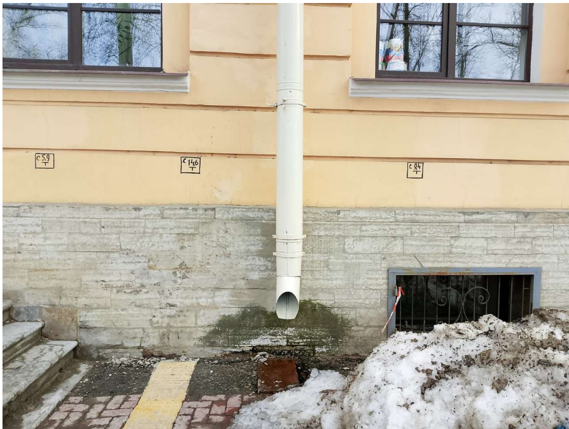
10. Пр. Стачек, 158. Лицевой фасад центрального объёма (фрагмент). Биопоражение цоколя.
