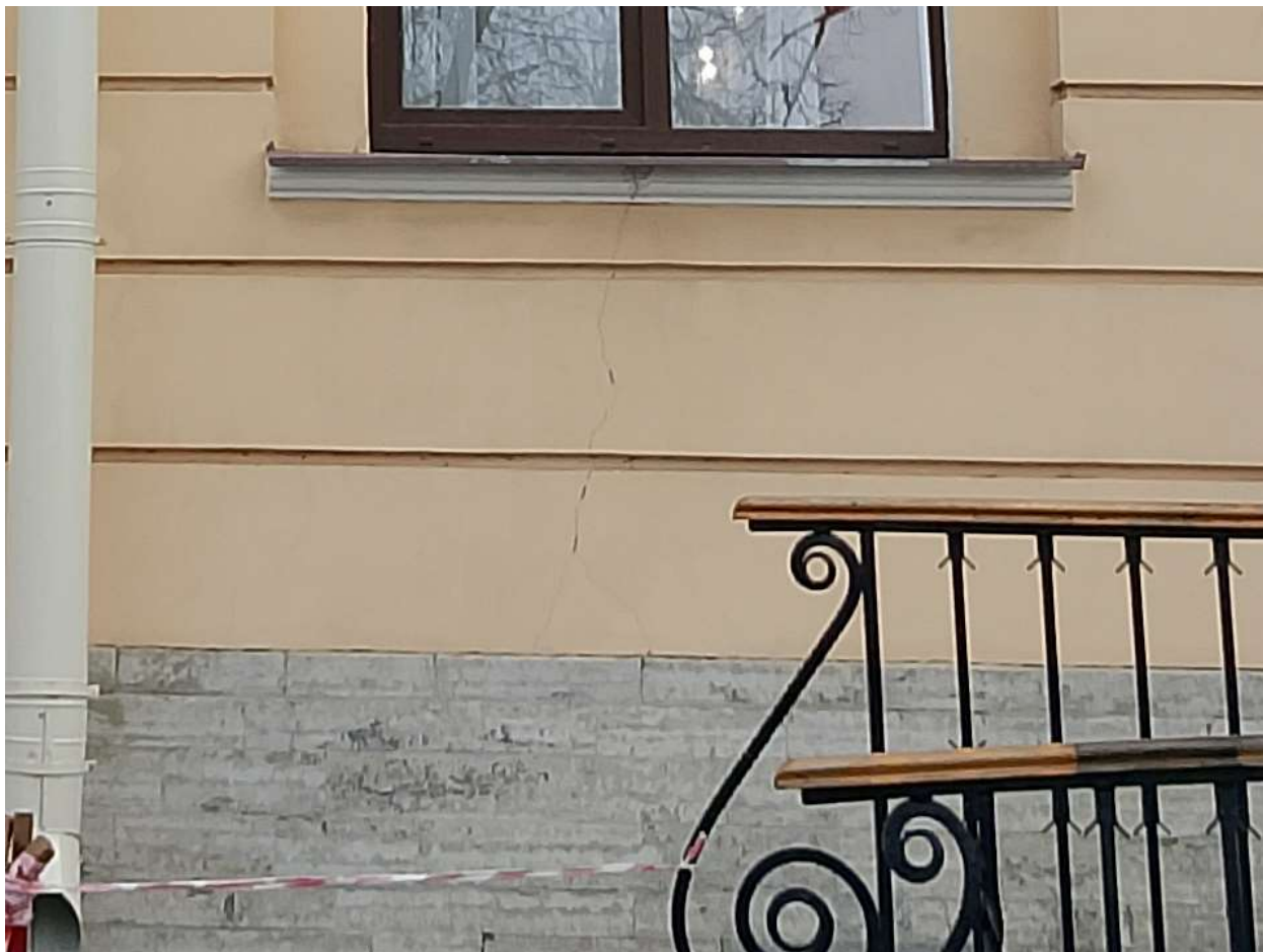
5. Пр. Стачек, 158. Лицевой фасад центрального объёма (фрагмент). Волосьяная трещина под оконным проёмом 1 этажа.
