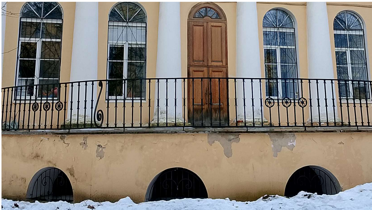
20. Пр. Стачек, 158. Юго-восточный (дворовый) фасад центрального объёма. Утраты окрасочного слоя, биопоражение, загрязнение цоколя террасы; утрата лакового покрытия, истирание и биопоражение дверного заполнения.
