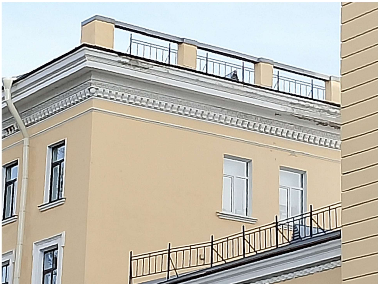
11. Пр. Стачек, 158. Юго-западный боковой фасад центрального объёма. Деструкция штукатурного венчающего карниза.
