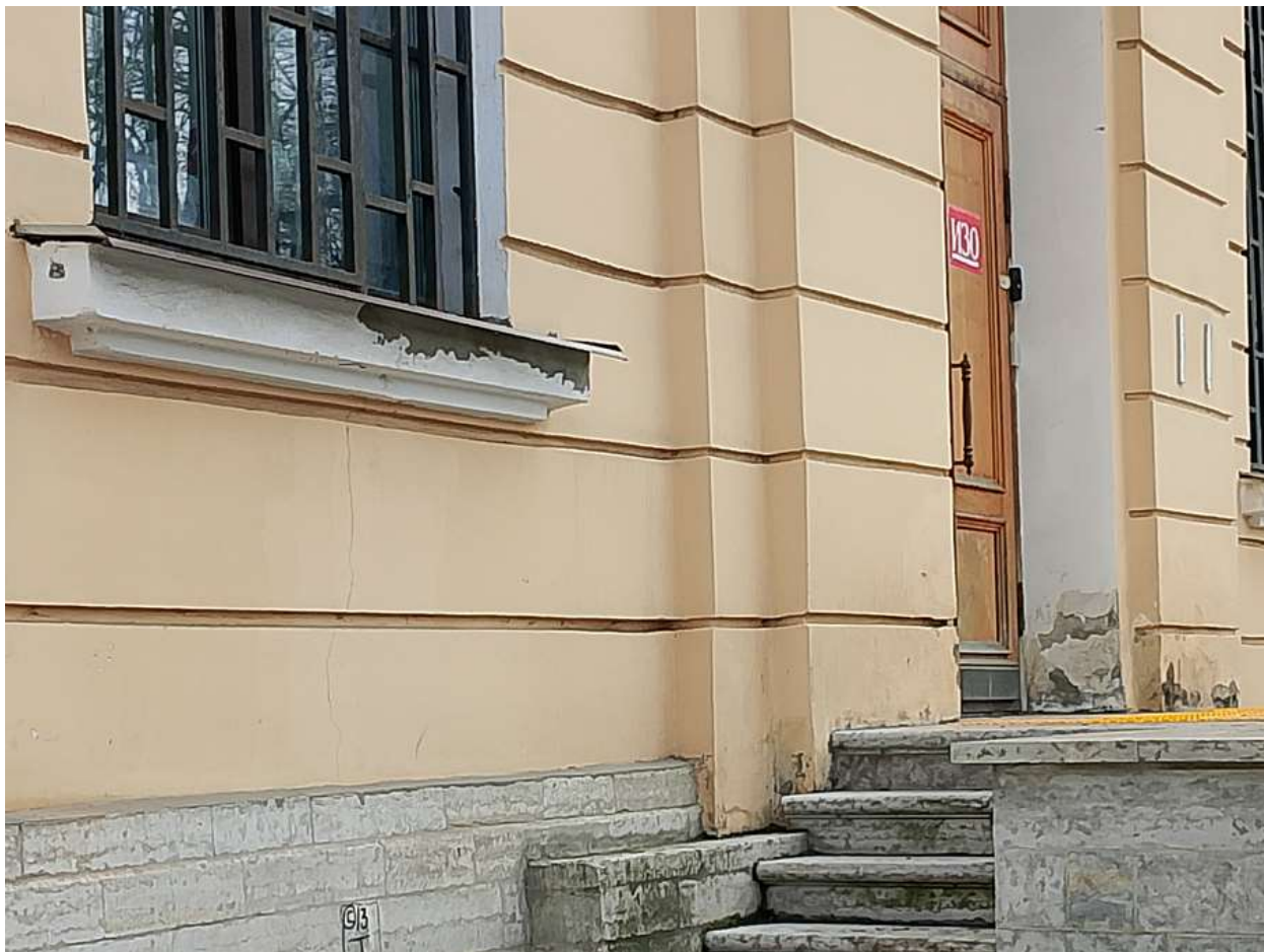
15. Пр. Стачек, 158. Западная башня, северо-западный фасад (фрагмент). Волосая трещина под оконным проёмом 1 этажа, утраты окрасочного слоя с биопоражением и деструкцией штукатурной отделки в нижней части фасада и дверного откоса.
