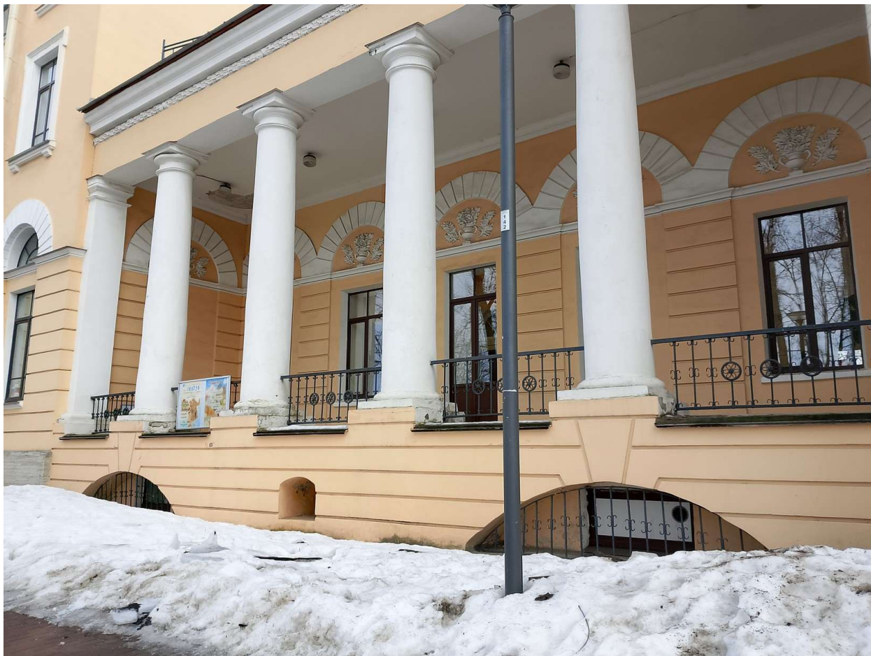
12. Пр. Стачек, 158. Западная лоджия. Биопоражения штукатурной отделки в нижней части фасада, утраты окрасочного слоя на базах колонн.
