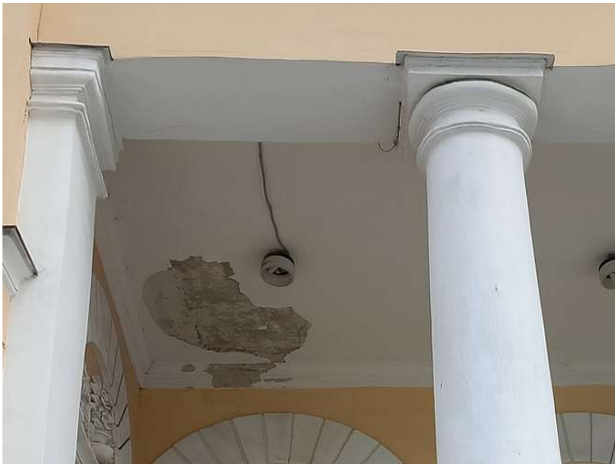
13. Пр. Стачек, 158. Западная лоджия. Утрата и отслоение окрасочного слоя, биопоражение, деструкция штукатурного слоя вследствие переувлажнения.
