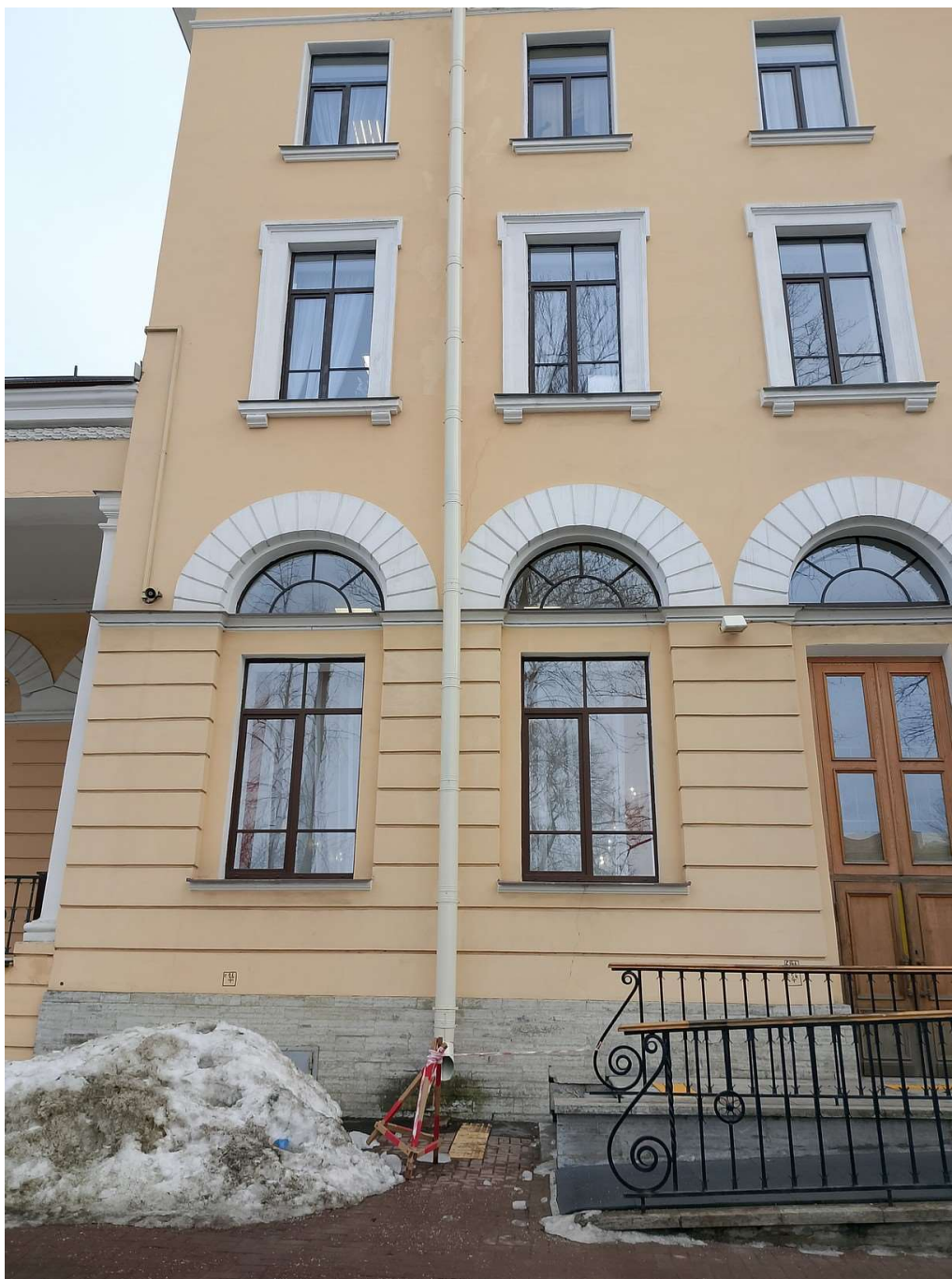
4. Пр. Стачек, 158. Лицевой фасад центрального объёма (фрагмент). Загрязнение фасада, биопоражения цоколя.
