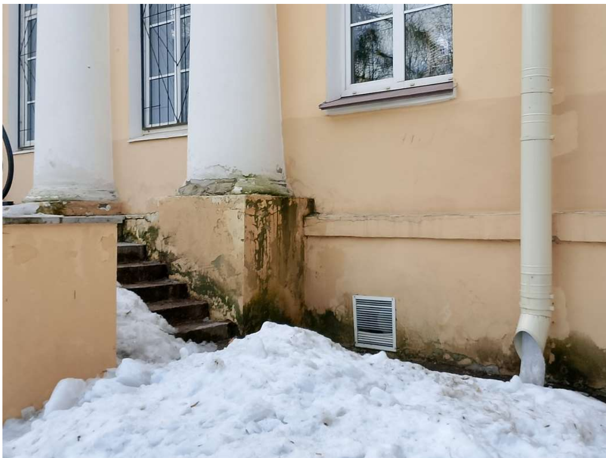
22. Пр. Стачек, 158. Юго-восточный (дворовый) фасад центрального объёма. Утраты штукатурного и окрасочного слоя, биопоражение нижней части фасада и основания колоннады; разрушение базы колонны.
