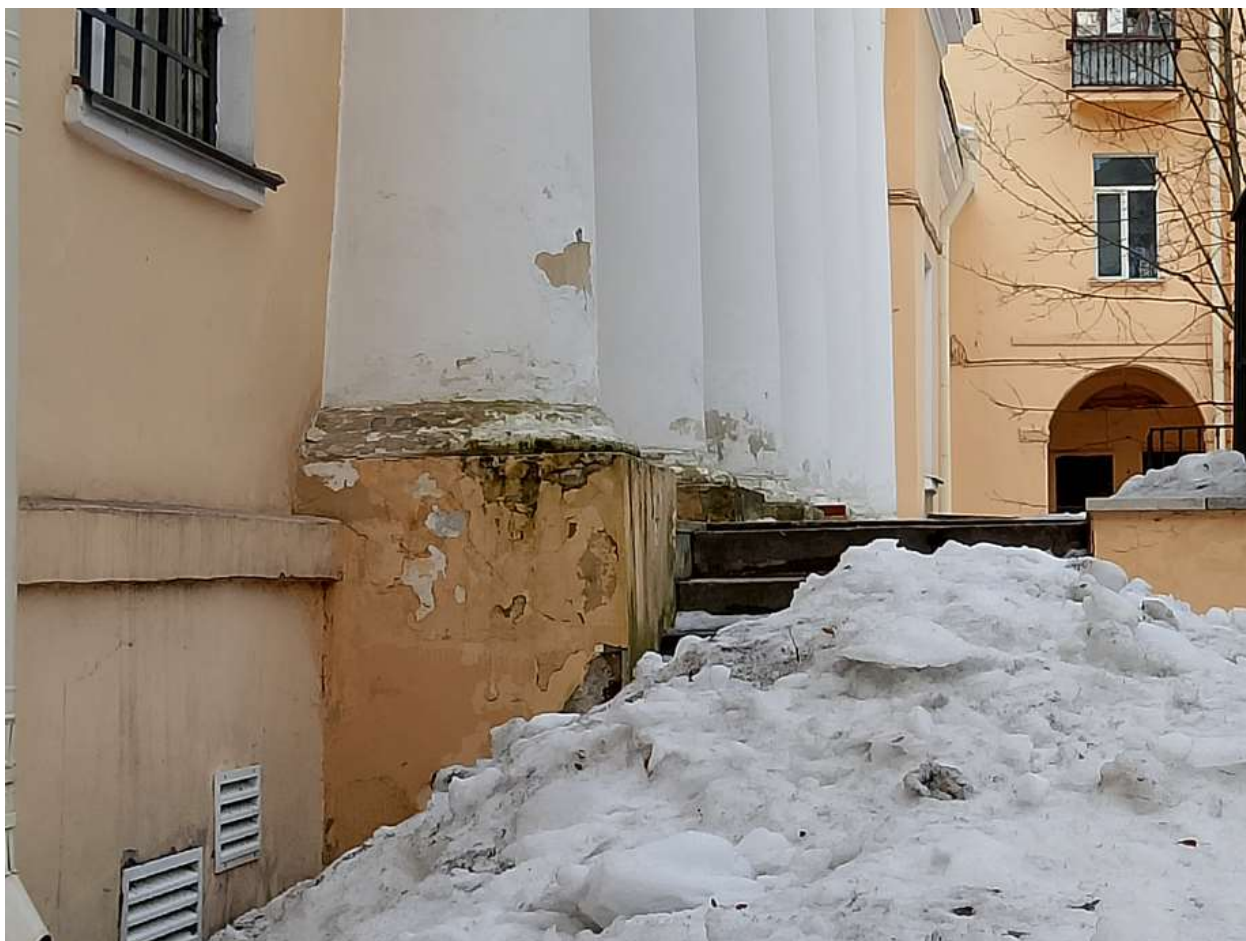
21. Пр. Стачек, 158. Юго-восточный (дворовый) фасад центрального объёма. Утраты штукатурного и окрасочного слоя, биопоражение основания колоннады; разрушение базы колонны.
