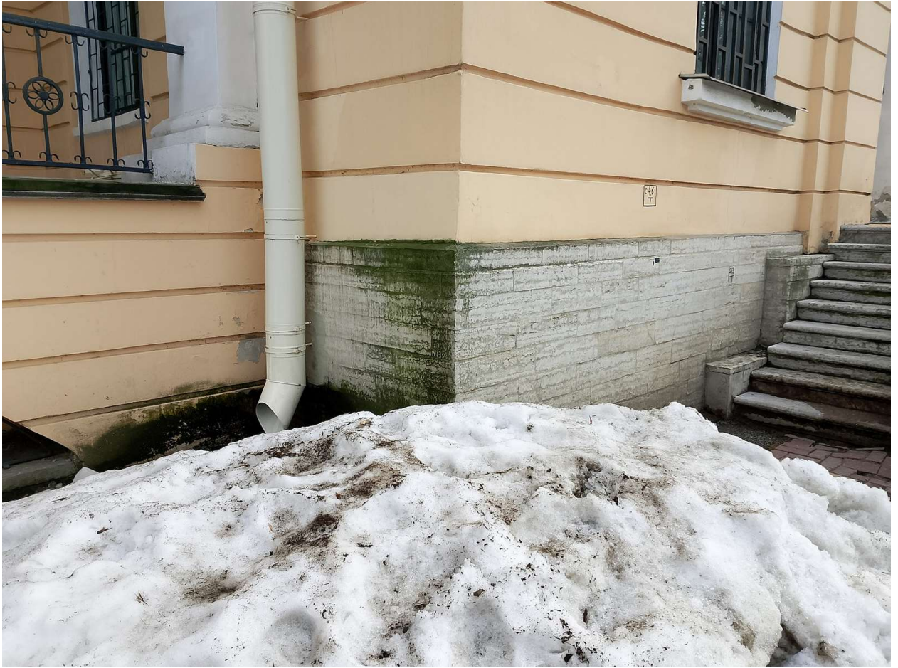
14. Пр. Стачек, 158. Биопоражение штукатурной отделки западной лоджии и известнякового цоколя западного флигеля .
