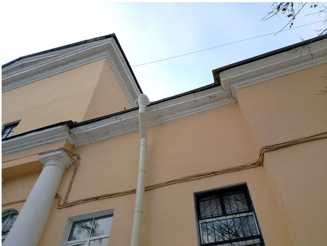
23. Пр. Стачек, 158. Юго-восточный (дворовый) фасад центрального объёма. Металлический выколотной карниз: деформация, утраты окрасочного слоя.
