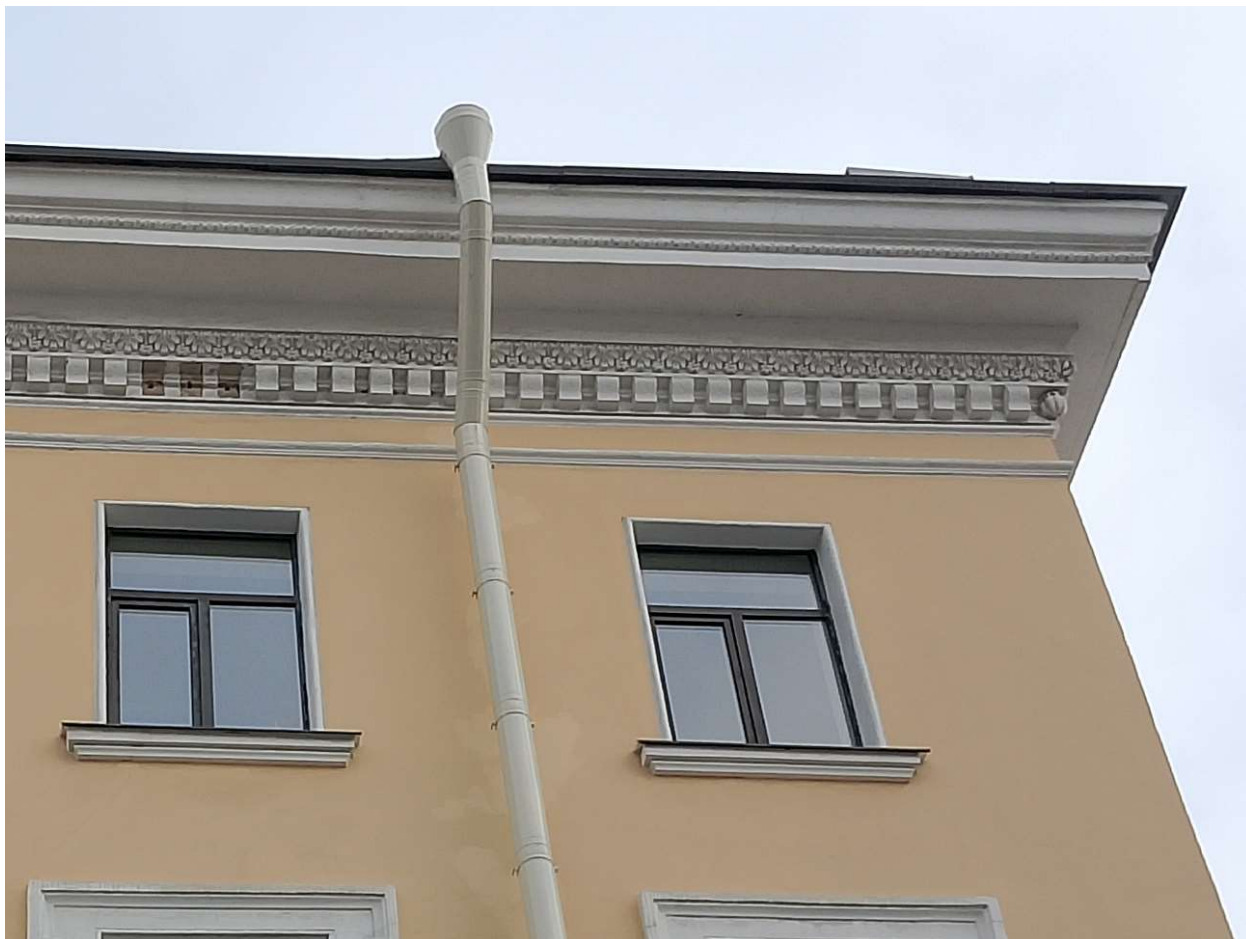
9. Пр. Стачек, 158. Лицевой фасад центрального объёма (фрагмент). Утраты элементов зубчатого карниза.
