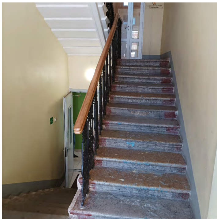
11. Объект культурного наследия регионального значения «Здание еврейского ремесленного училища», расположенного по адресу: Санкт-Петербург, Адмиралтейский район, ул. Декабристов, д.42, Лермонтовский пр., д.2. Лестничная клетка. Дата съемки: 01.08.2024г.
