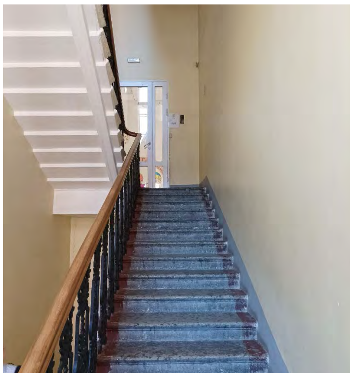
12. Объект культурного наследия регионального значения «Здание еврейского ремесленного училища», расположенного по адресу: Санкт-Петербург, Адмиралтейский район, ул. Декабристов, д.42, Лермонтовский пр., д.2. Лестничная клетка. Дата съемки: 01.08.2024г.
