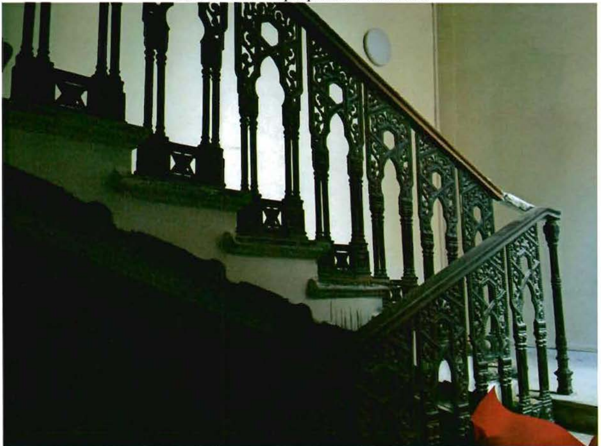
Фото 8. Лестница в северной части здания.
