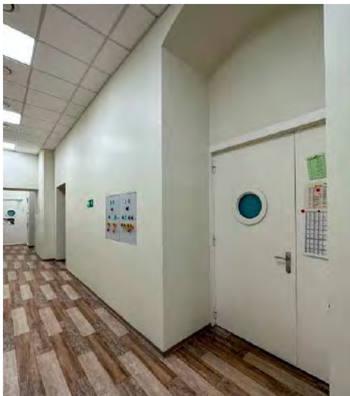
35. Объект культурного наследия регионального значения «Здание еврейского ремесленного училища», расположенного по адресу: Санкт-Петербург, Адмиралтейский район, ул. Декабристов, д.42, Лермонтовский пр., д.2. Коридор третьего этажа. Дата съемки: 01.08.2024г.
