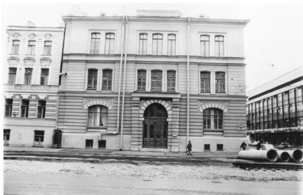
37. Здание Еврейского ремесленного училища. 1987г. Источник: https://pastvu.com/
