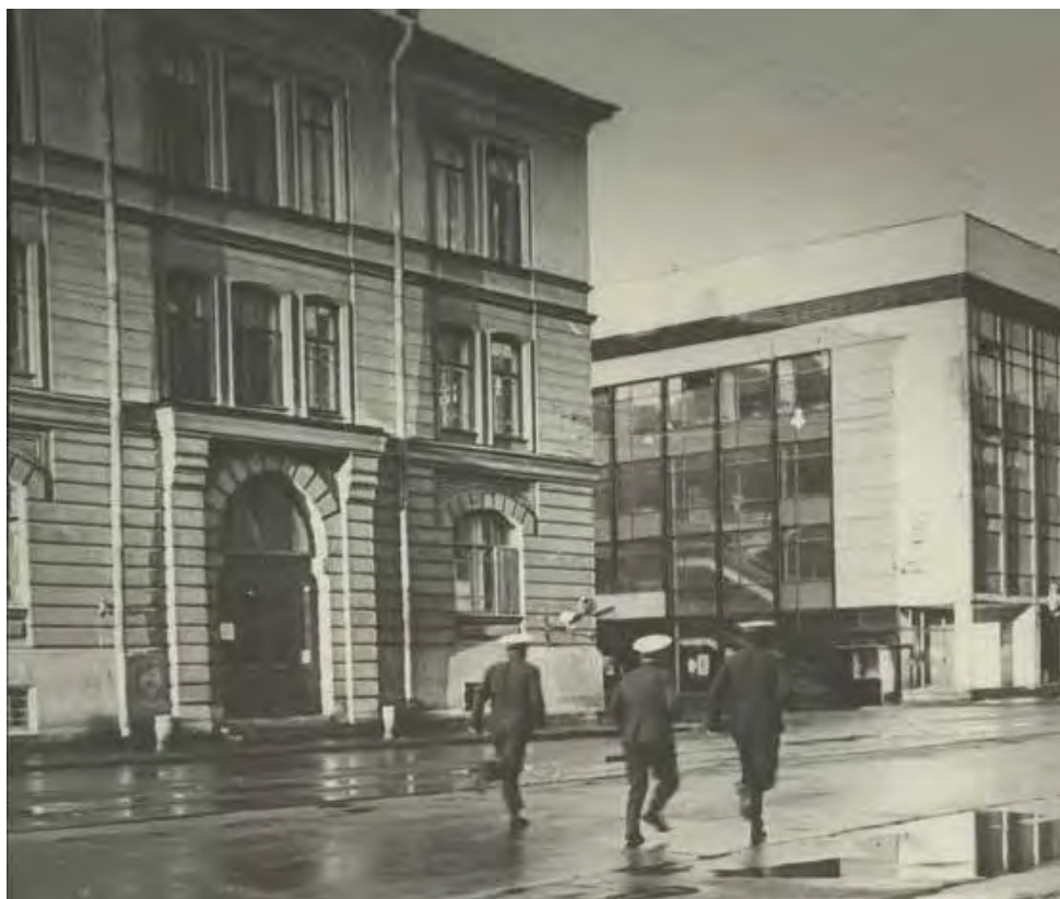
36. Здание Еврейского ремесленного училища. 1975г. Источник: https://pastvu.com/
