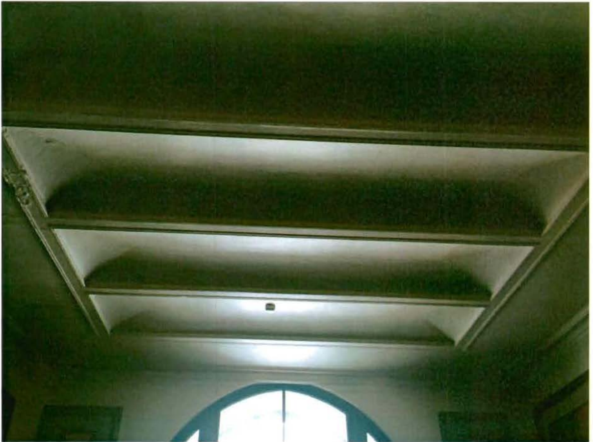
Фото 7. Часть перекрытий 1-го этажа.
