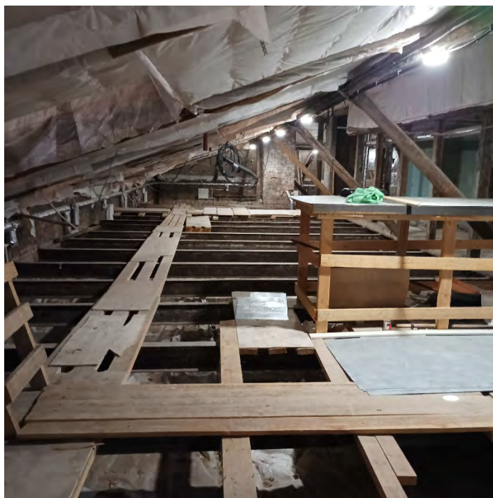
37. Объект культурного наследия регионального значения «Здание еврейского ремесленного училища», расположенного по адресу: Санкт-Петербург, Адмиралтейский район, ул. Декабристов, д.42, Лермонтовский пр., д.2. Чердачное помещение. Дата съемки: 01.08.2024г.
