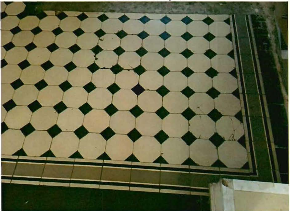
Фото 4. Мощение пола вестибюля центрального входа
