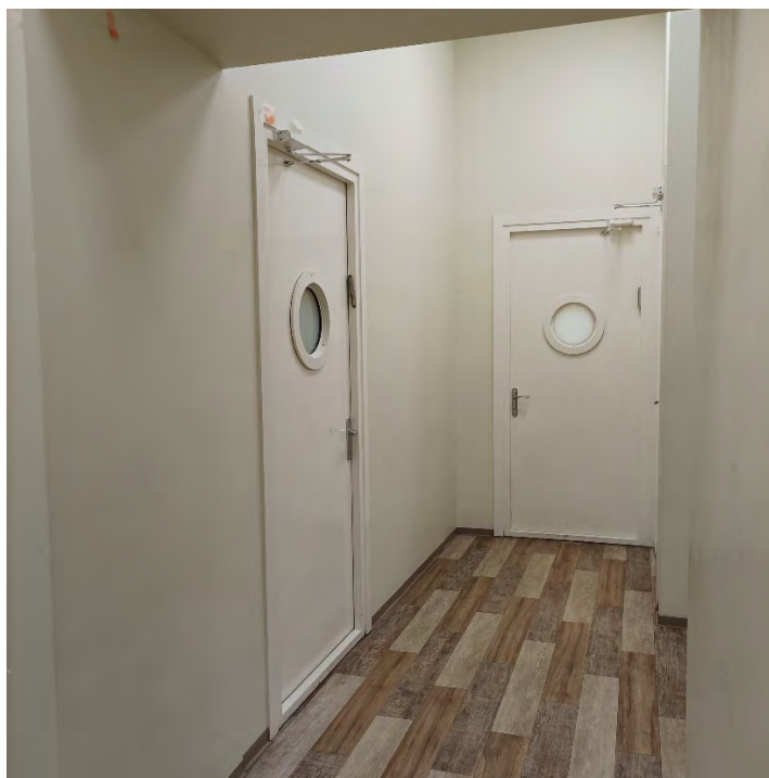
33. Объект культурного наследия регионального значения «Здание еврейского ремесленного училища», расположенного по адресу: Санкт-Петербург, Адмиралтейский район, ул. Декабристов, д.42, Лермонтовский пр., д.2. Коридор второго этажа. Дата съемки: 01.08.2024г.
