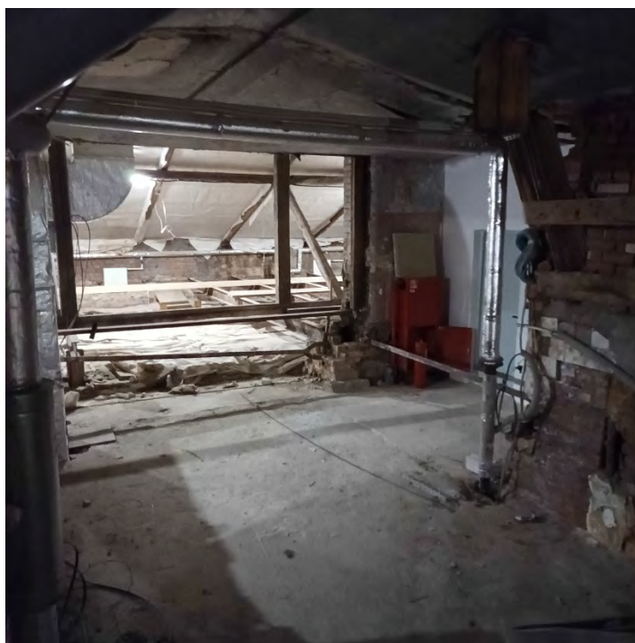
38. Объект культурного наследия регионального значения «Здание еврейского ремесленного училища», расположенного по адресу: Санкт-Петербург, Адмиралтейский район, ул. Декабристов, д.42, Лермонтовский пр., д.2. Чердачное помещение. Дата съемки: 01.08.2024г.
