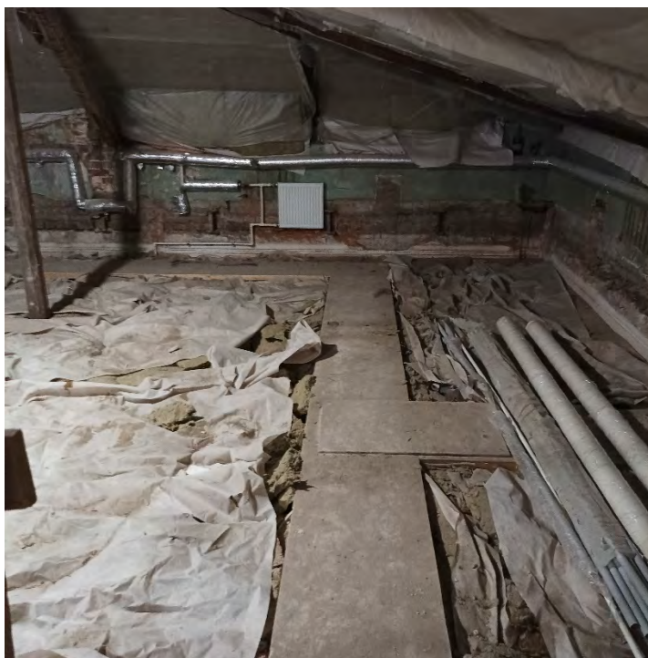
40. Объект культурного наследия регионального значения «Здание еврейского ремесленного училища», расположенного по адресу: Санкт-Петербург, Адмиралтейский район, ул. Декабристов, д.42, Лермонтовский пр., д.2. Чердачное помещение. Дата съемки: 01.08.2024г.
