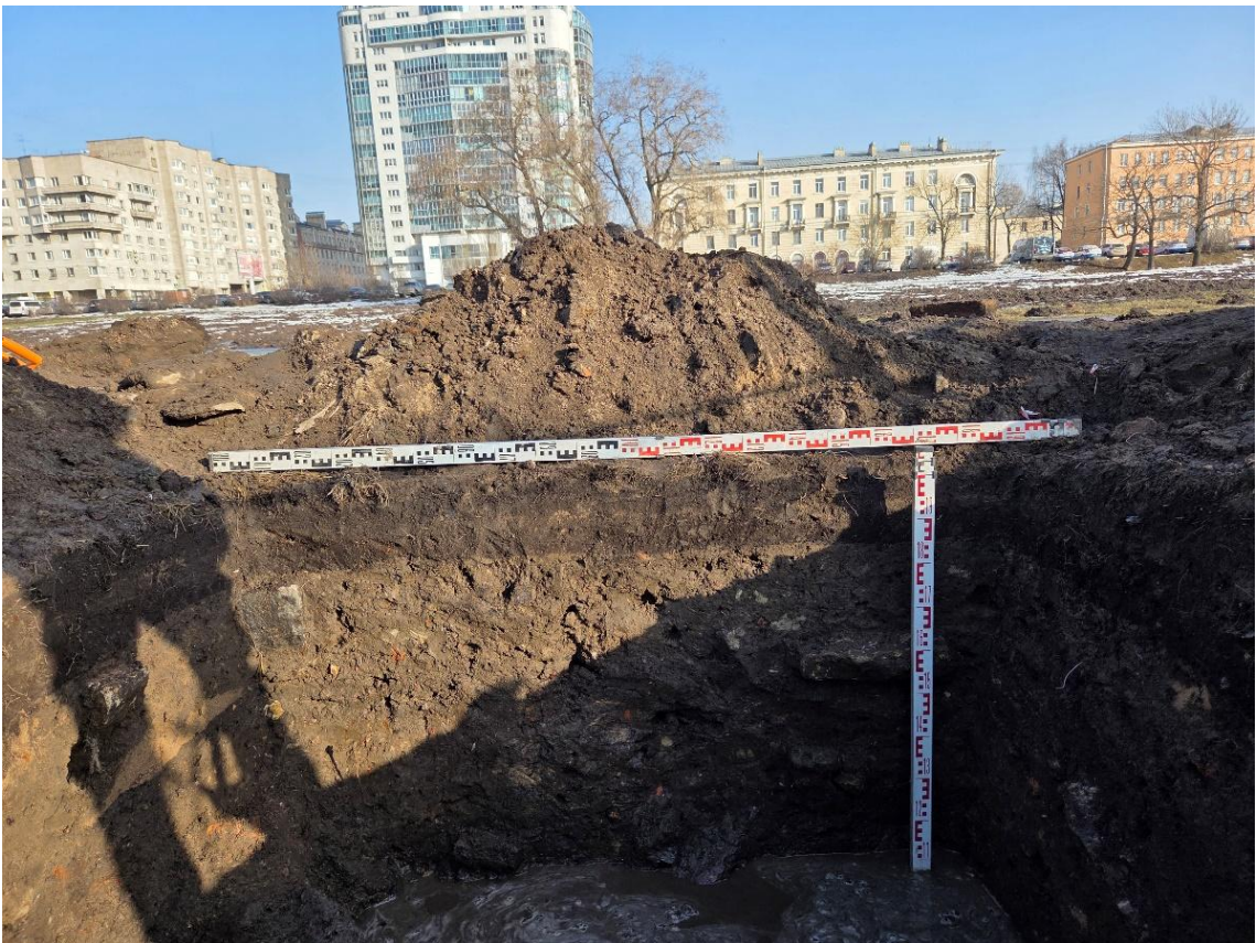
Рис. 23. СПб-2026. Красногвардейский район, «Разработка проектной документации на перекладку силовых кабельных линий внешнего электроснабжения 0,4 кВ КНС у Малоохтинского моста» Шурф 1. Восточная стенка. Вид с запада
