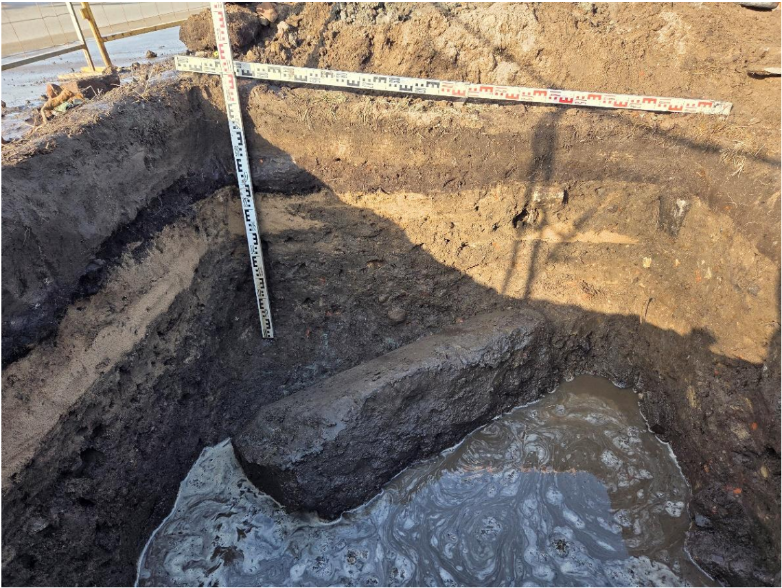
Рис. 22. СПб-2026. Красногвардейский район, «Разработка проектной документации на перекладку силовых кабельных линий внешнего электроснабжения 0,4 кВ КНС у Малоохтинского моста» Шурф 1. Северная стенка. Вид с юга
