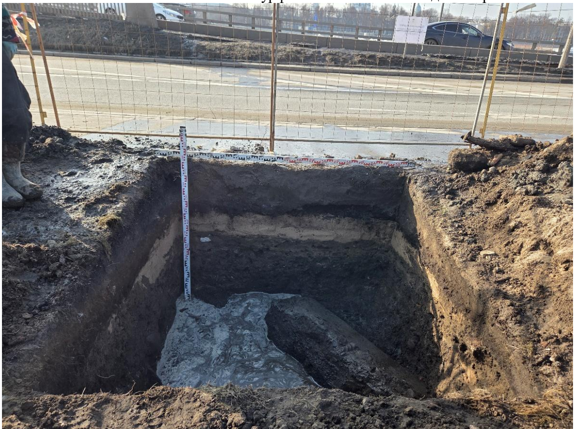
Рис. 21. СПб-2026. Красногвардейский район, «Разработка проектной документации на перекладку силовых кабельных линий внешнего электроснабжения 0,4 кВ КНС у Малоохтинского моста» Шурф 1. Западная стенка. Вид с востока
