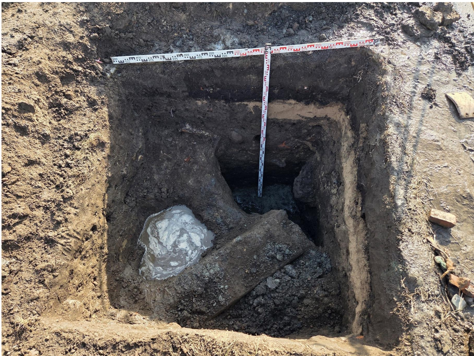
Рис. 17. СПб-2026. Красногвардейский район, «Разработка проектной документации на перекладку силовых кабельных линий внешнего электроснабжения 0,4 кВ КНС у Малоохтинского моста» Шурф 1. Фиксация материковой поверхности после выборки техногена. Вид с севера
