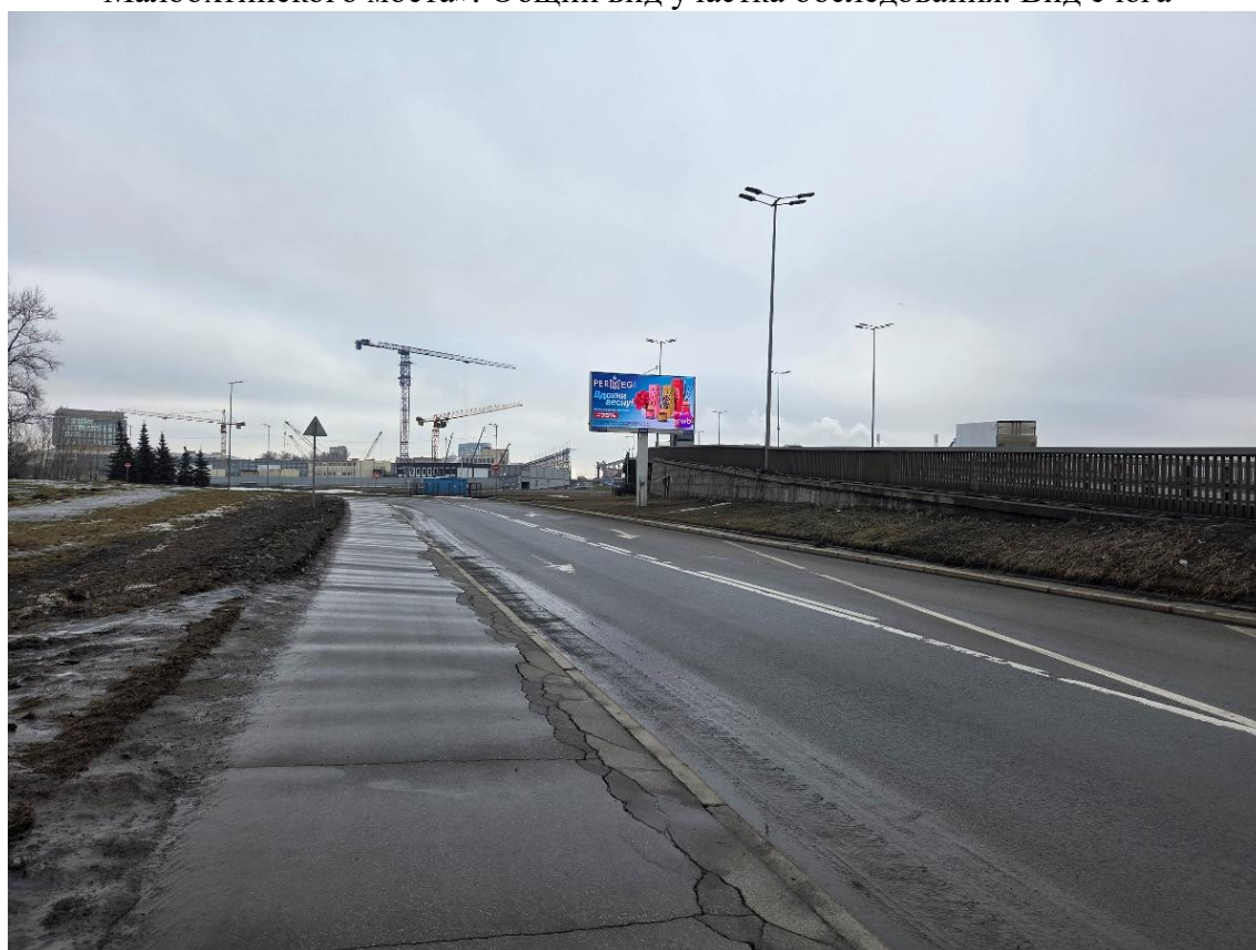
Рис. 12. СПб-2026. Красногвардейский район, «Разработка проектной документации на перекладку силовых кабельных линий внешнего электроснабжения 0,4 кВ КНС у Малоохтинского моста». Шурф 1. Общий вид участка обследования, вид с севера
