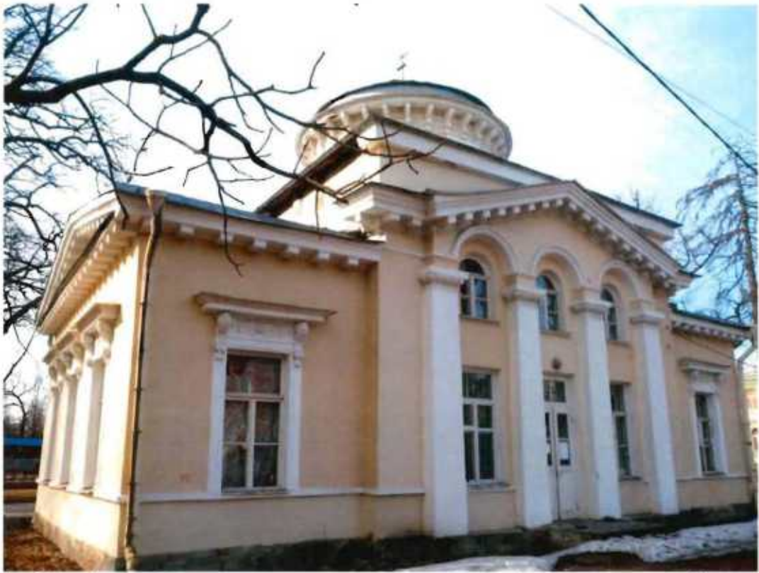
3. Общий вид объекта культурного наследия (здание) с северо-западной стороны.
