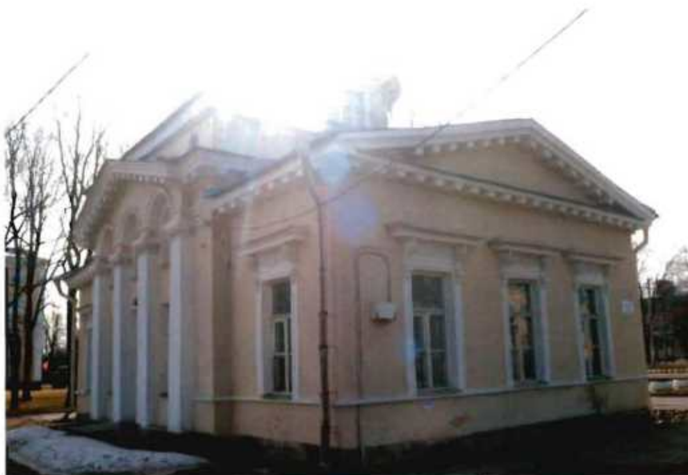
2. Общий вид объекта культурного наследия (здание) с северо-западной стороны.
