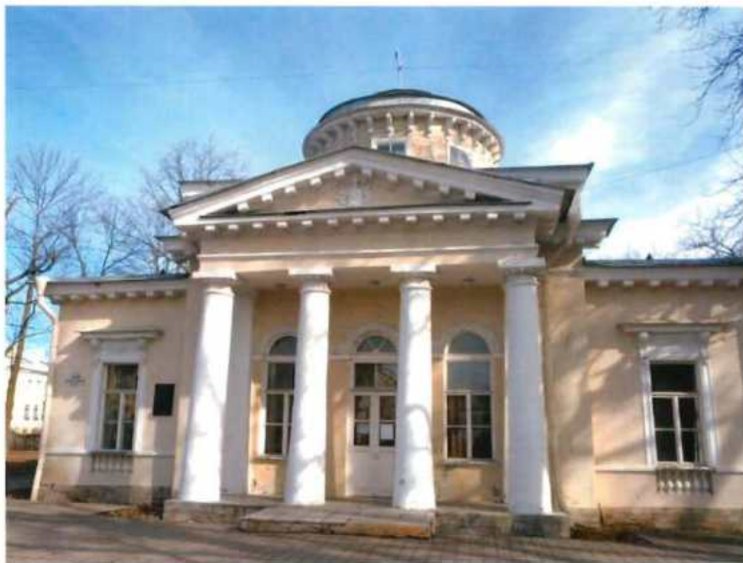
1. Общий вид объекта культурного наследия (здание) с южной стороны.
