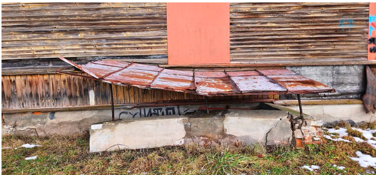
8. Выявленный объект культурного наследия «дом Н. Шарубина(?)». Общий вид приямка входа в подвальное помещение на южном фасаде.
