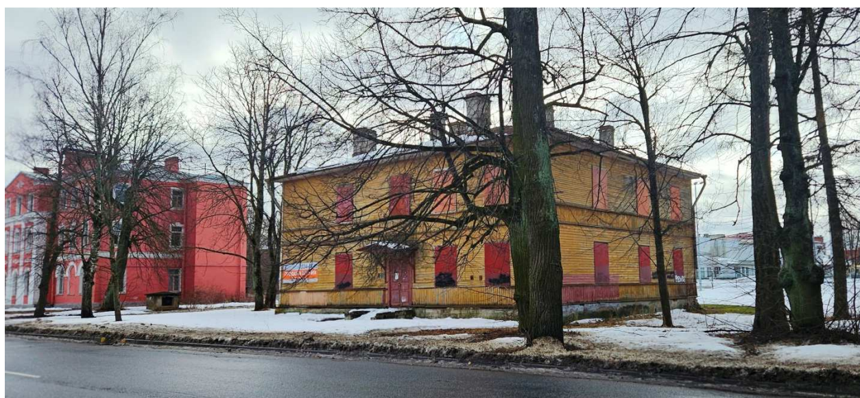
1. Выявленный объект культурного наследия «Дом Н. Шарубина(?)». Вид в застройке Собственного проспекта. Вид северного и западного фасадов.
