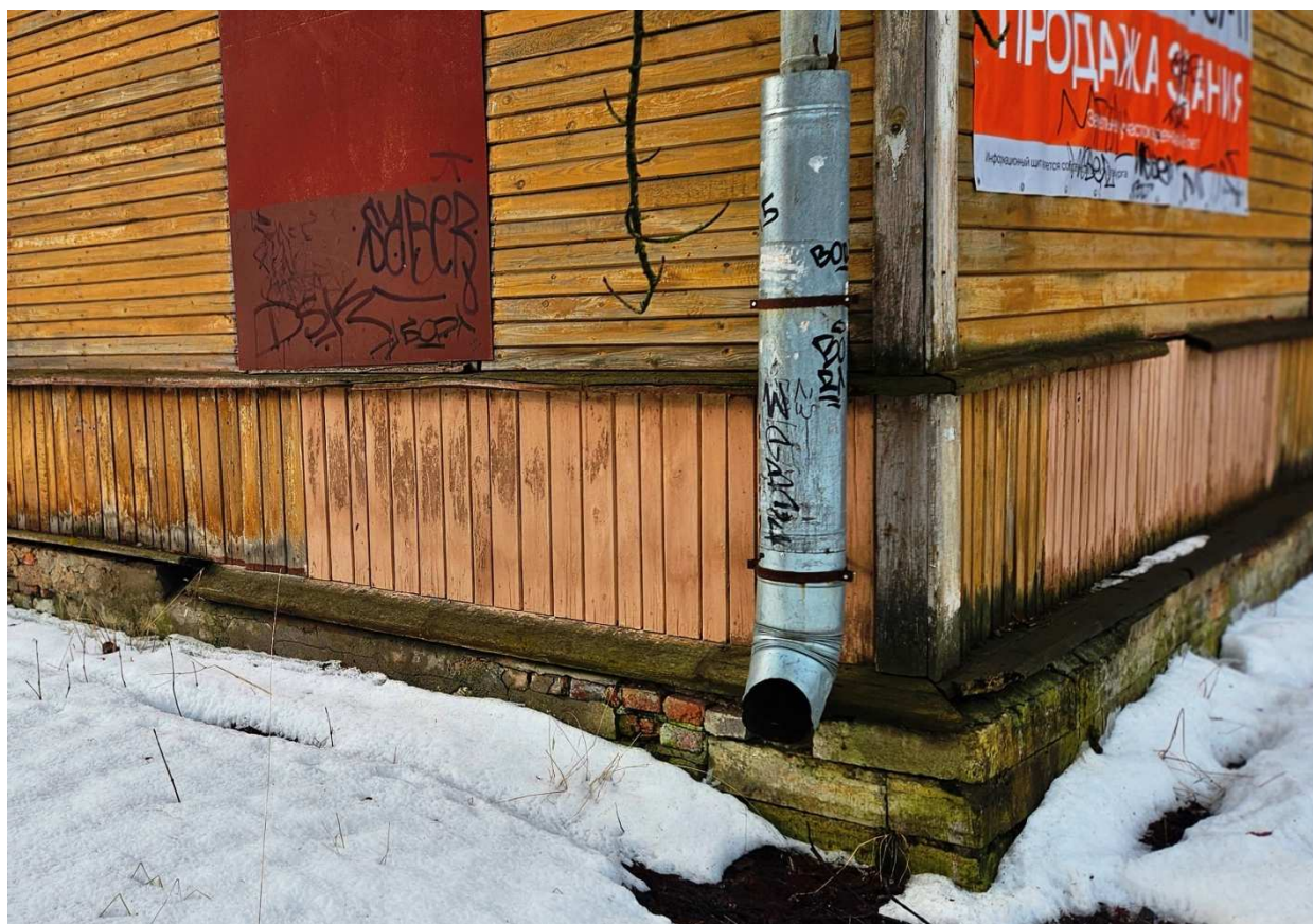
6. Выявленный объект культурного наследия «дом Н. Шарубина(?)». Фрагмент цоколя восточного фасада.
