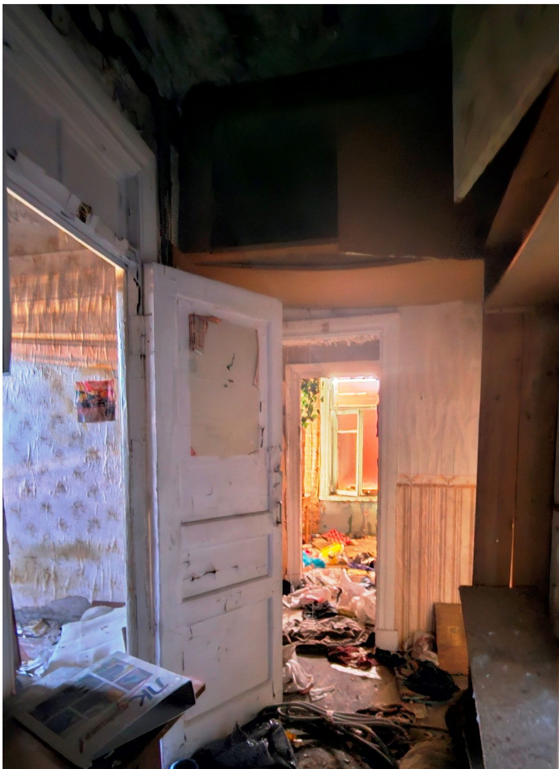
17. Выявленный объект культурного наследия «дом Н. Шарубина(?)». Вид одного из коридоров 2-го этажа.
