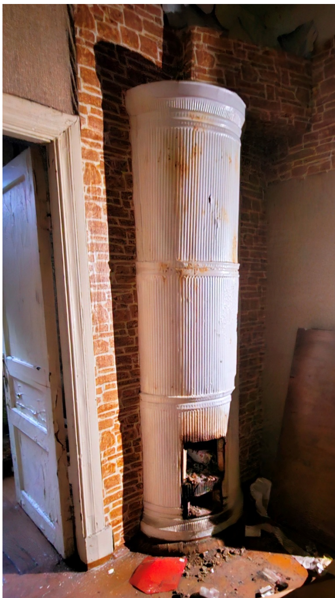
20. Выявленный объект культурного наследия «дом Н. Шарубина(?)». 2-й этаж, пом.5.. Круглая печь
