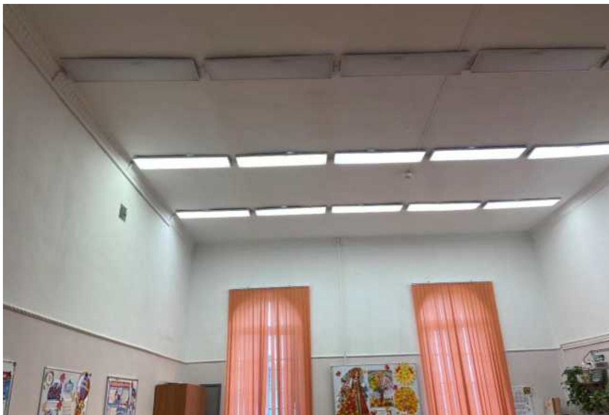
Фото 30. Помещения 2-го этажа.
