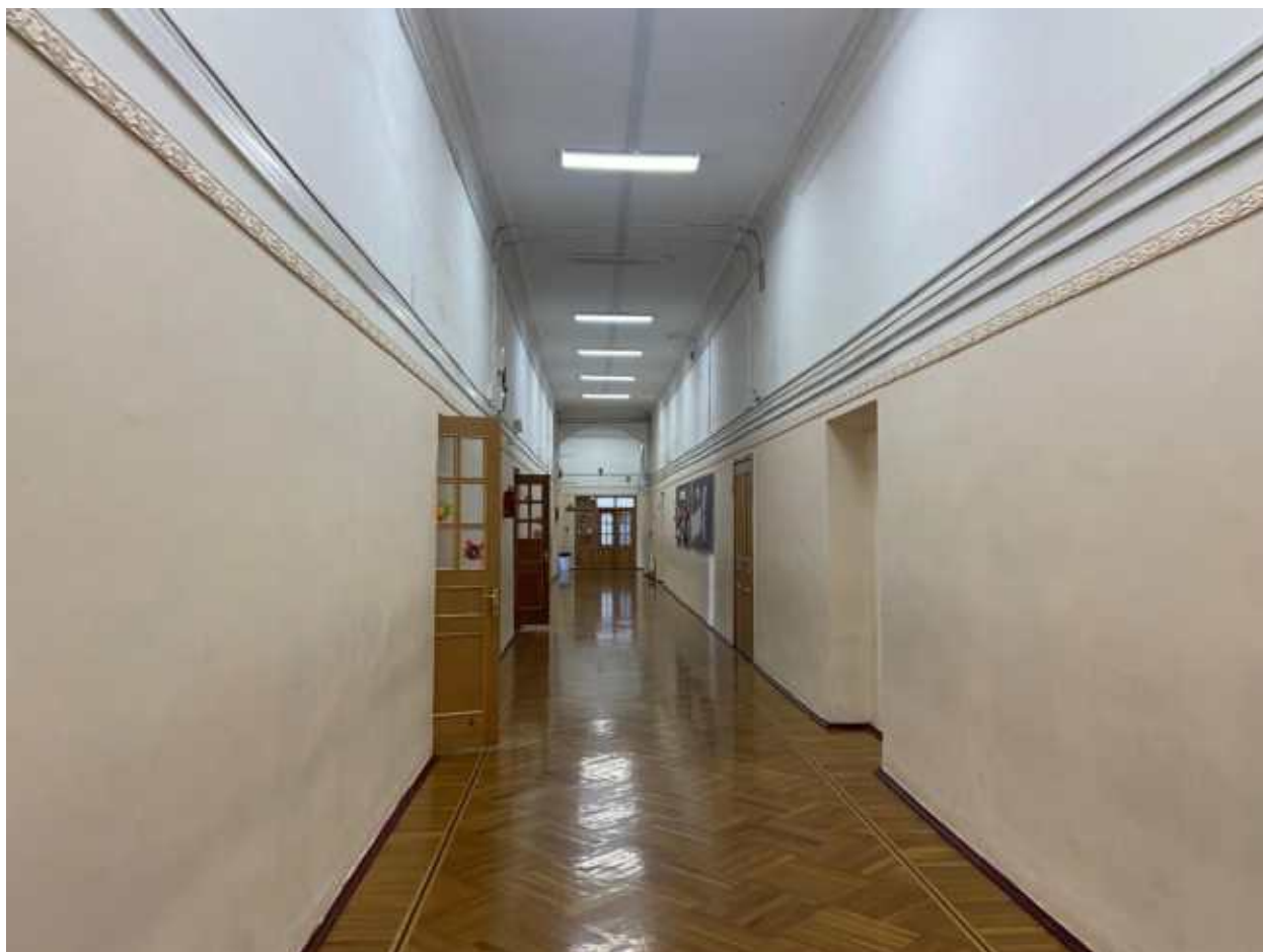
Фото 33. Помещения 2-го этажа.
