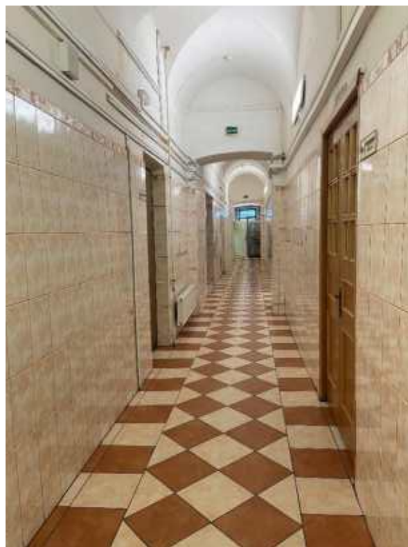
Фото 23. Помещения 1-го этажа.
