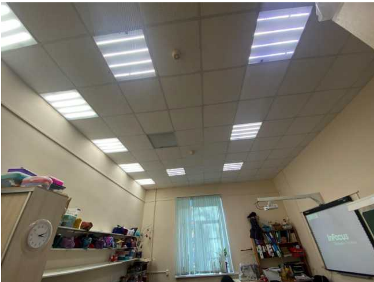
Фото 20. Помещения 1-го этажа.
