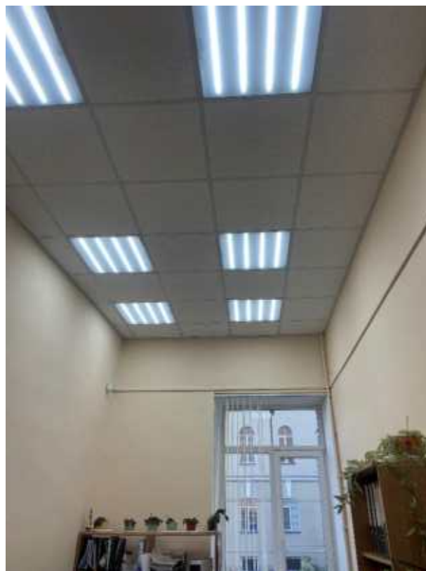
Фото 10. Помещения 1-го этажа.
