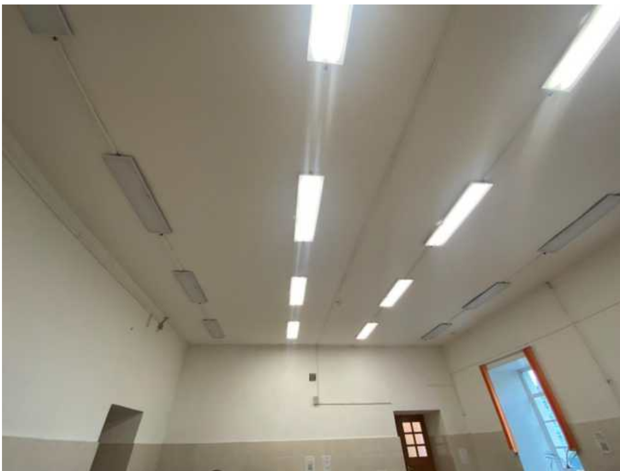
Фото 24. Помещения 1-го этажа.
