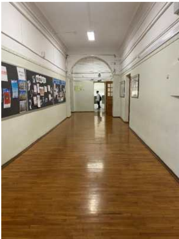
Фото 5. Помещения 1-го этажа.
