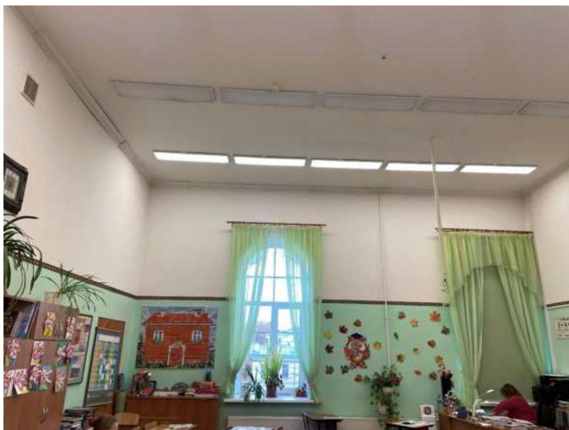
Фото 28. Помещения 2-го этажа.
