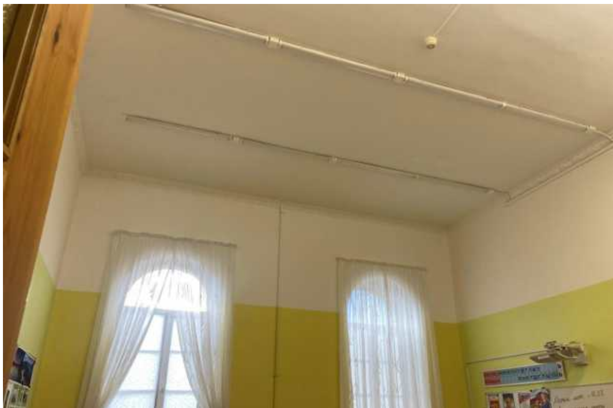
Фото 34. Помещения 2-го этажа.
