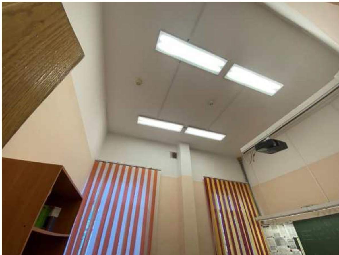
Фото 49. Помещения 3-го этажа.
