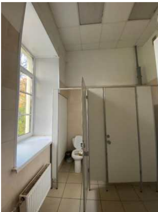
Фото 13. Помещения 1-го этажа.
