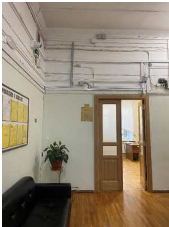
Фото 6. Помещения 1-го этажа.
