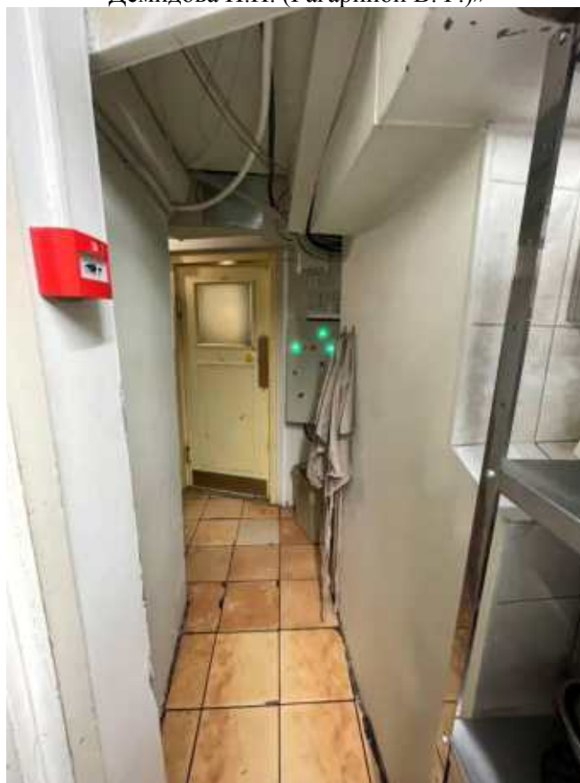
Фото 28. Интерьер пом. 2-Н объекта культурного наследия федерального значения «Дом Демидова П.Н. (Гагариной В.Ф.)»
