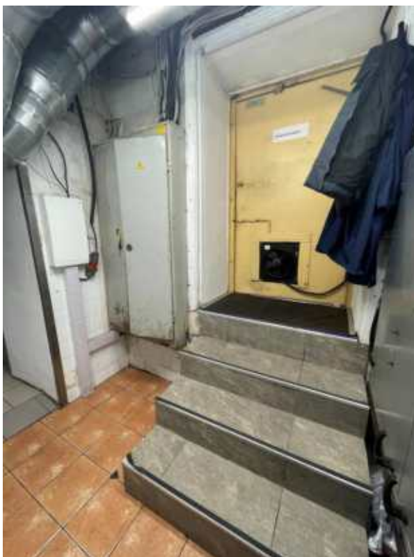
Фото 35. Интерьер пом. 2-Н объекта культурного наследия федерального значения «Дом Демидова П.Н. (Гагариной В.Ф.)»
