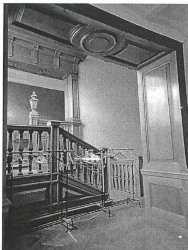
23. Проем оформленный деревянными филенками
