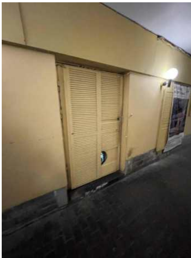
Фото 9. Фрагмент дворового фасада объекта культурного наследия федерального значения «Дом Демидова П.Н. (Гагариной В.Ф.)», вход в пом. 2-Н
