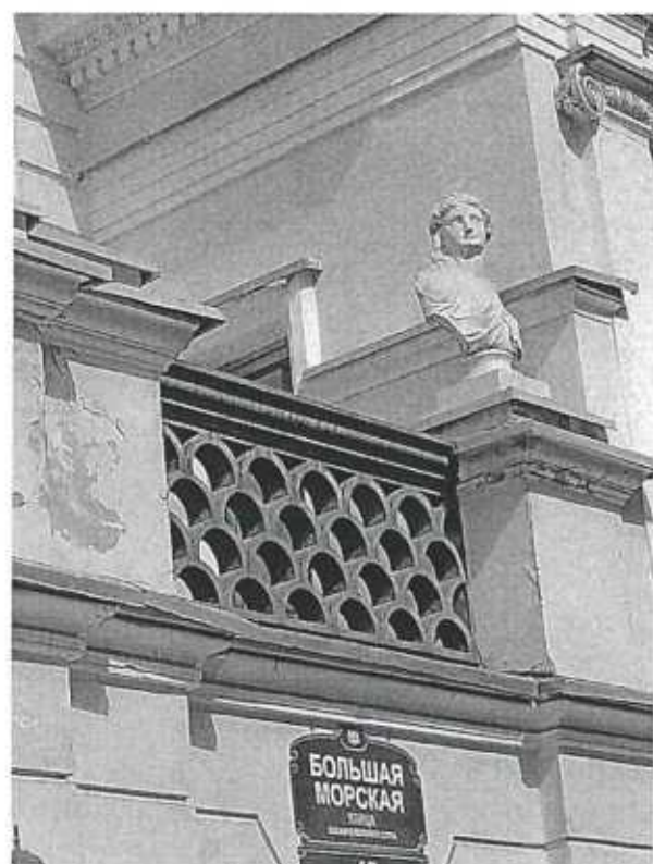
4. Восточный лицевой фасад объекта культурного наследия
