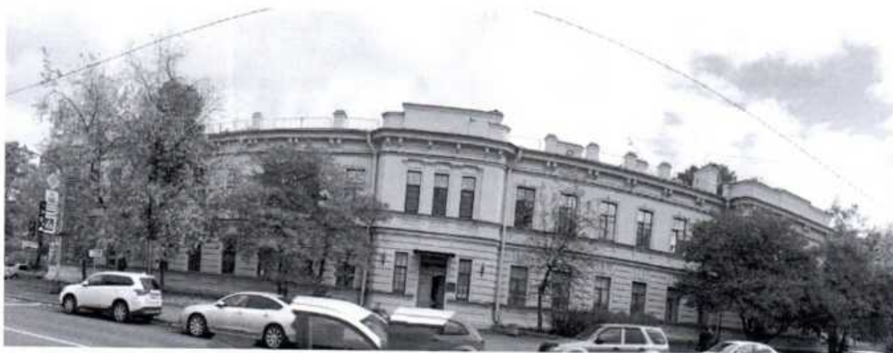
1. Лицевой (западный) фасад
