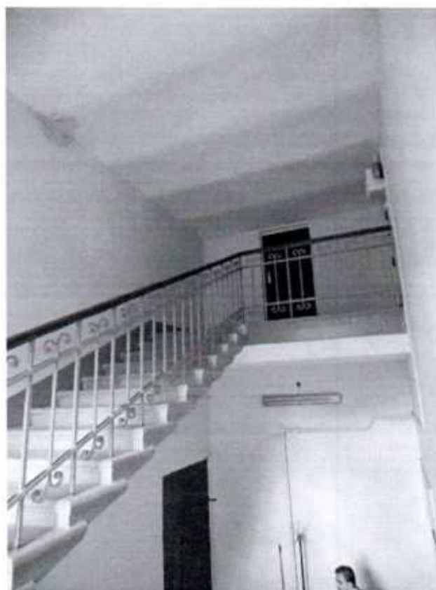
11. Служебная лестница (северная часть здания)
