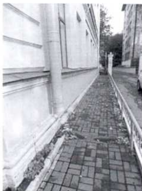
4. Фрагмент южного фасада
