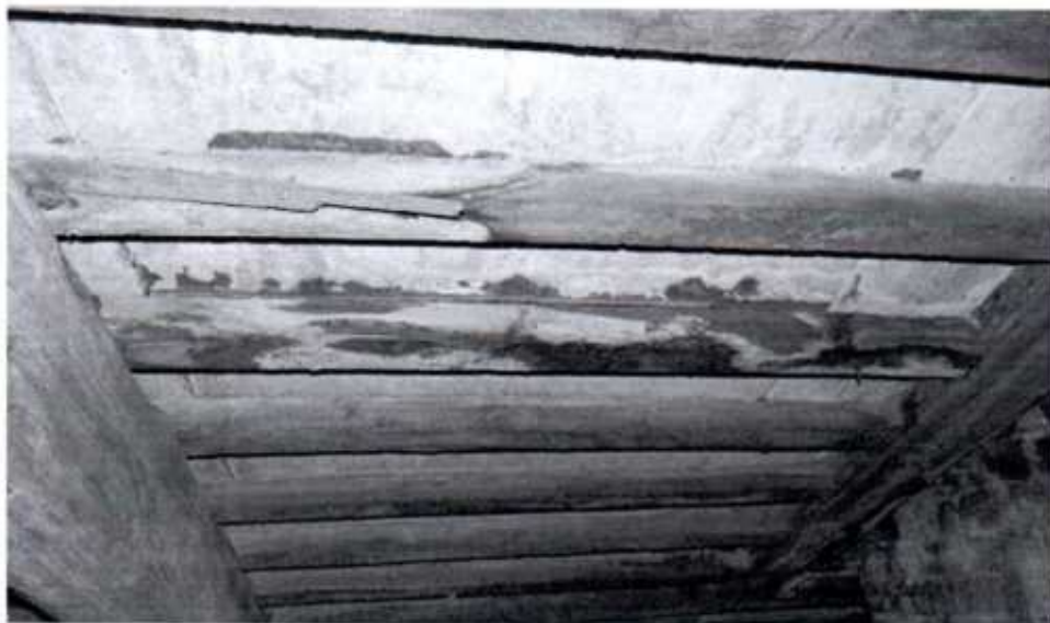
9. Стропильная система (фрагмент)
