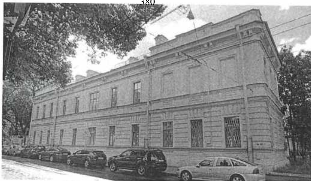
Фото 2. Вид на северный фасад объекта культурного наследия
