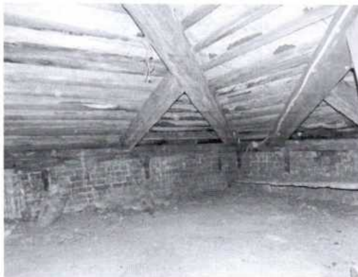
10. Стропильная система (фрагмент)
