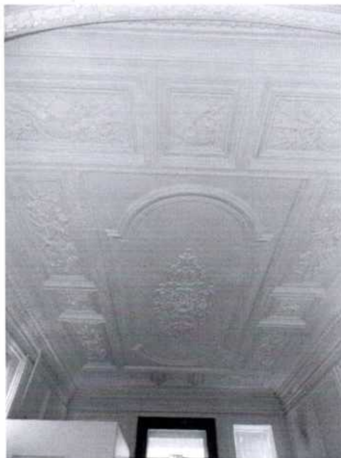
16. Декоративные элементы главного вестибюля (фрагмент)
