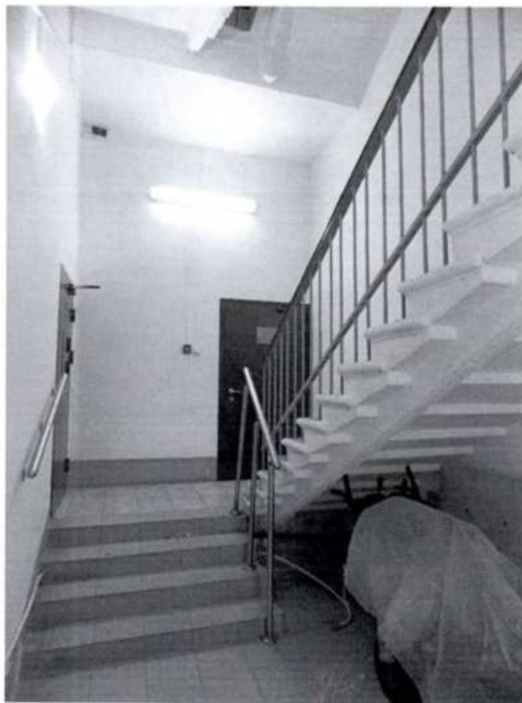
12. Служебная лестница (южная часть здания)
