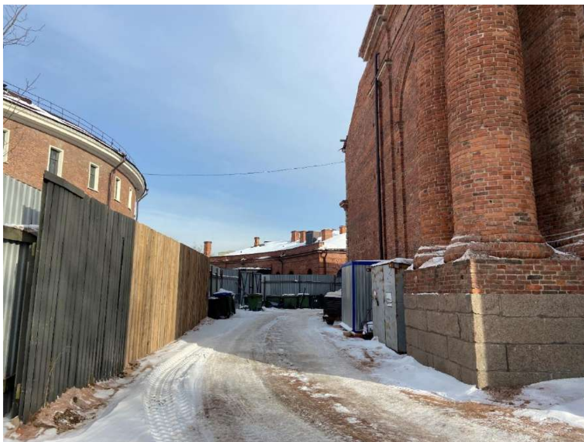
Фото 14. Вид на территорию и объект культурного наследия федерального значения «Склады лесные (три) с аркой» с северо-востока (литера Н корпус № 17).
