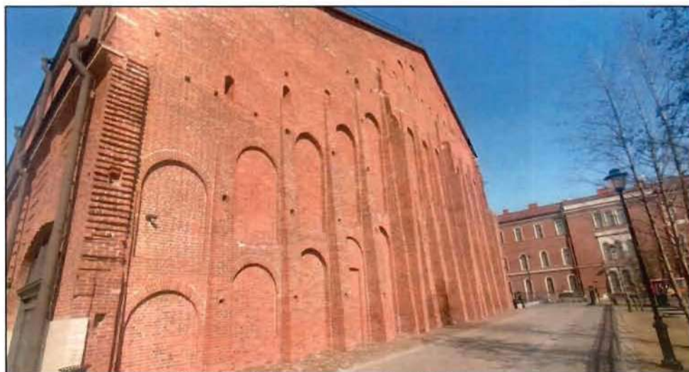
7. Южный фасад объекта культурного наследия.
