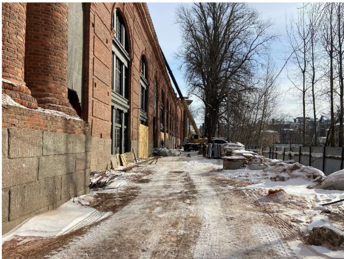
Фото 16. Вид на территорию и объект культурного наследия федерального значения «Склады лесные (три) с аркой» с северо-востока (литера Н корпус № 17).
