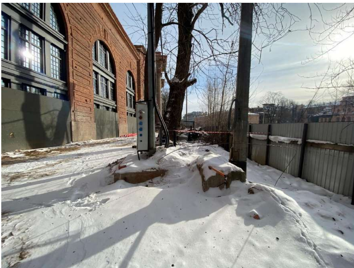
Фото 19. Вид на территорию и объект культурного наследия федерального значения «Склады лесные (три) с аркой» с северо-востока (литера Н корпус № 17).
