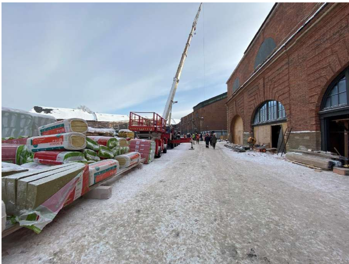
Фото 9. Вид на территорию и объект культурного наследия федерального значения «Склады лесные (три) с аркой» с северо-востока (литера Н корпус № 17).
