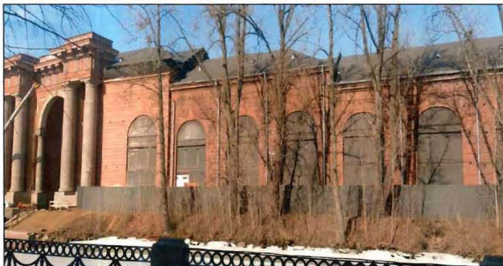
14. Фрагмент южного лицевого фасада объекта культурного наследия.
