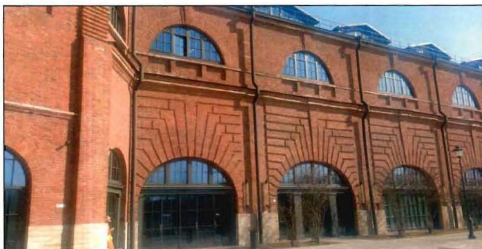
5. Фрагмент западного фасада объекта культурного наследия.
