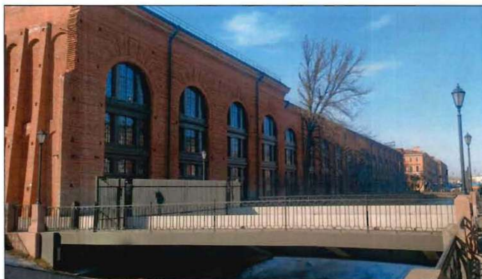
1. Лицевой фасад объекта культурного наследия.
