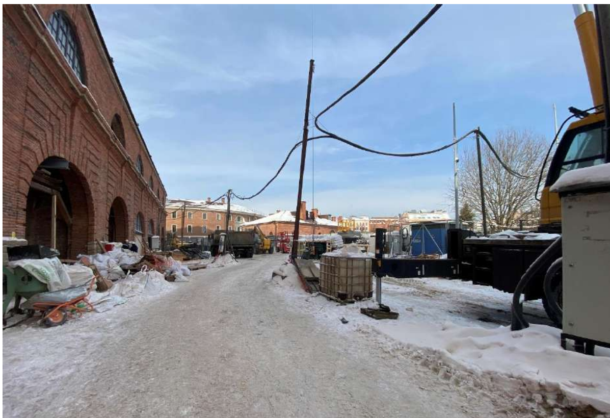
Фото 11. Вид на территорию и объект культурного наследия федерального значения «Склады лесные (три) с аркой» с северо-востока (литера Н корпус № 17).
