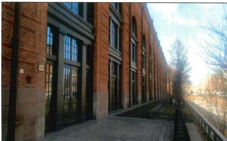
8. Восточный фасад объекта культурного наследия.
