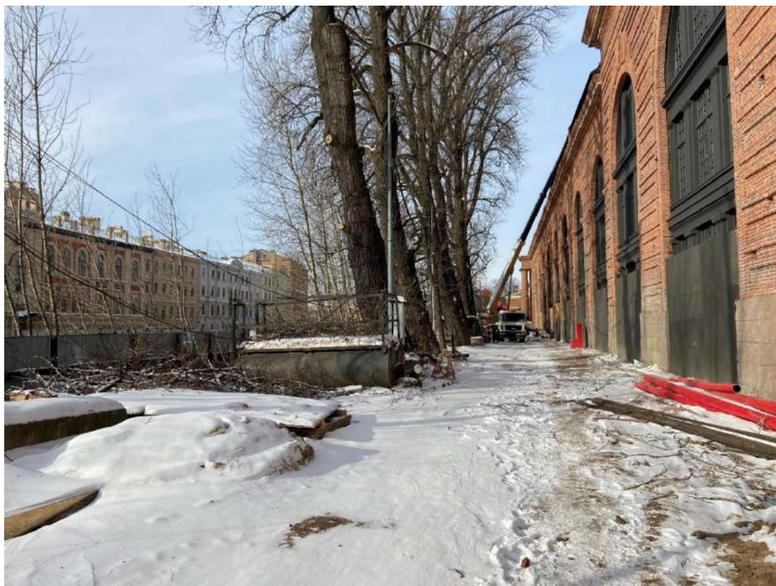
Фото 23. Вид на территорию и объект культурного наследия федерального значения «Склады лесные (три) с аркой» с северо-востока (литера Н корпус № 17).
