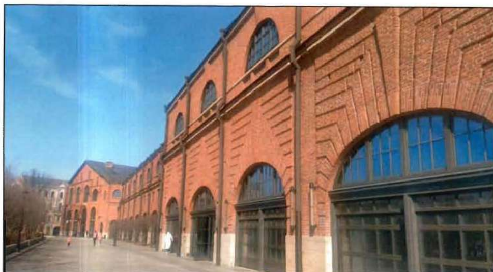
3. Западный фасад объекта культурного наследия.
