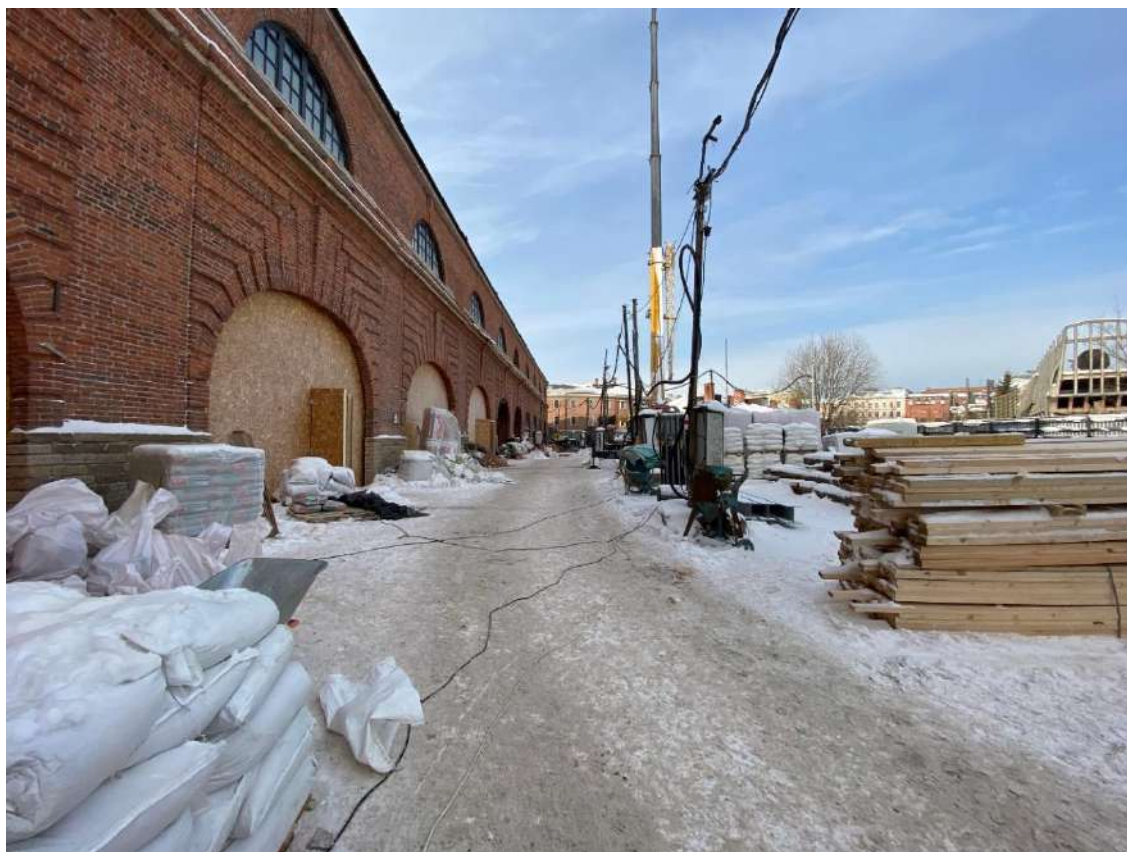
Фото 10. Вид на территорию и объект культурного наследия федерального значения «Склады лесные (три) с аркой» с северо-востока (литера Н корпус № 17).
