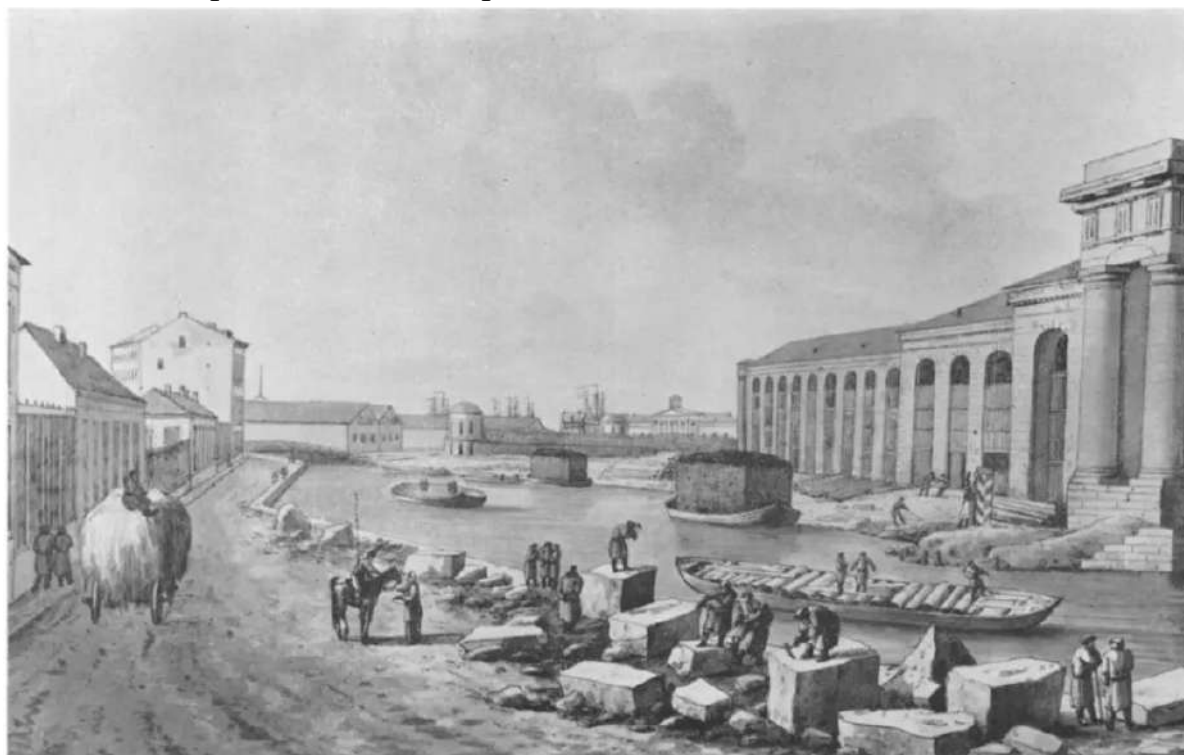
31. А.Е. Мартынов. Строительство набережной реки Мойки напротив Новой Голландии. 1807 г. Захаров О.Н. Архитектурные панорамы Невских берегов. Л., 1984. С.117
