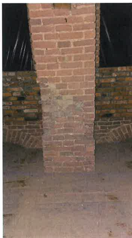
Фото 6. Вырубка в кирпичной кладке контрфорса.
