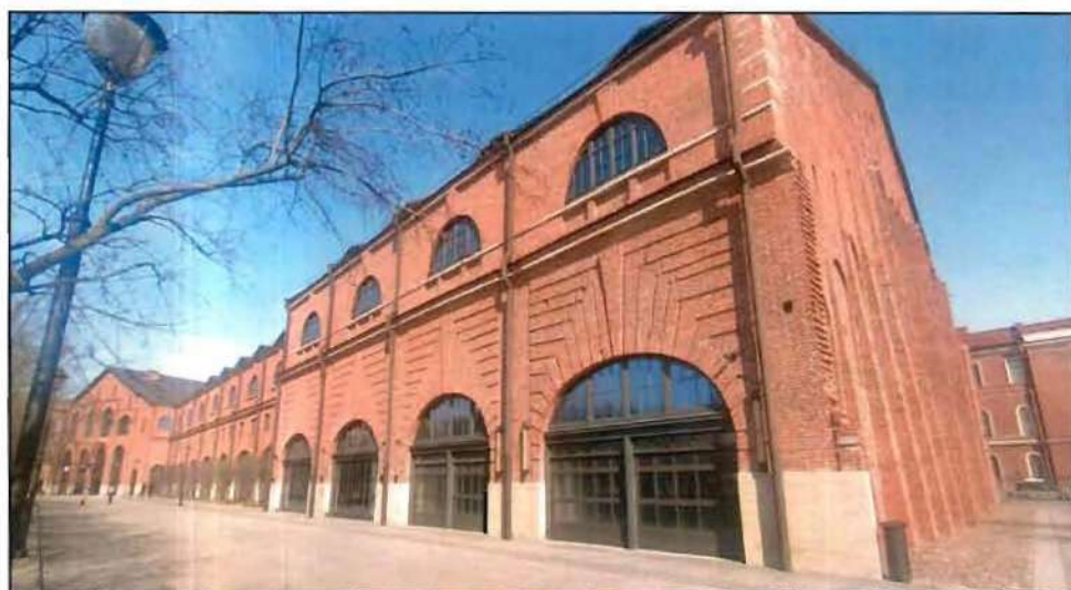
4. Западный фасад объекта культурного наследия.
