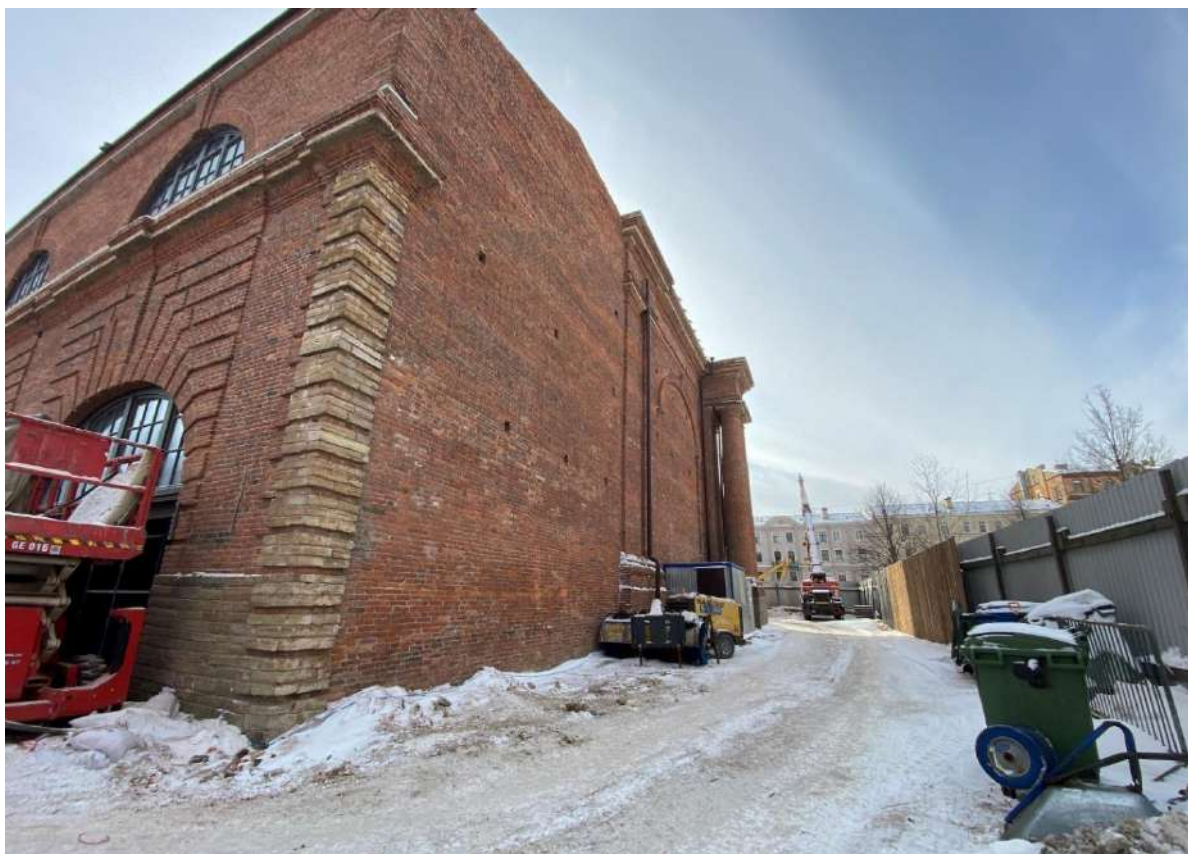
Фото 13. Вид на территорию и объект культурного наследия федерального значения «Склады лесные (три) с аркой» с северо-востока (литера Н корпус № 17).
