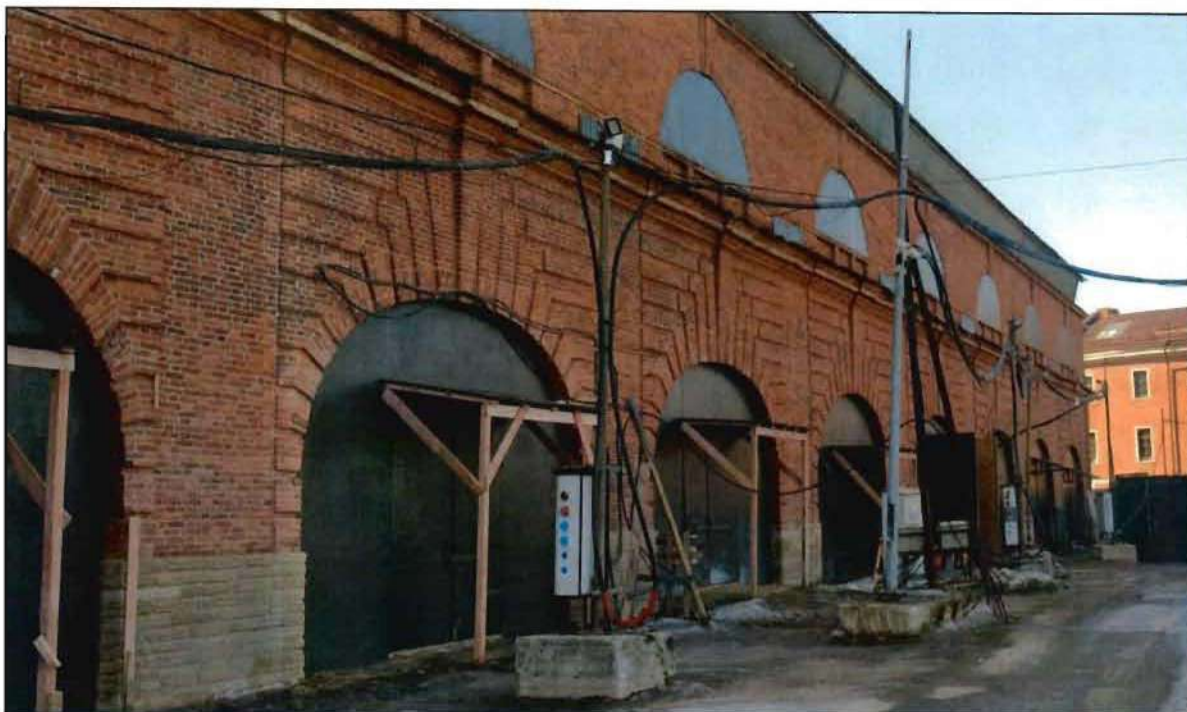
26. Фрагмент северного дворового фасада объекта культурного наследия.
