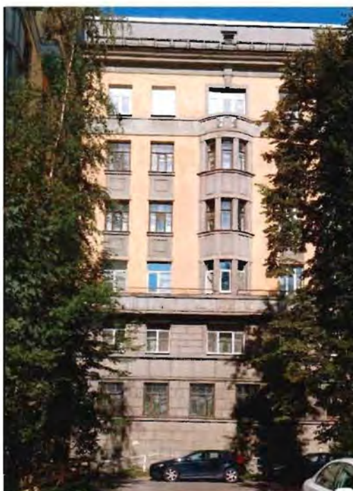
4. Фрагмент. Восточный фасад главного флигеля.
