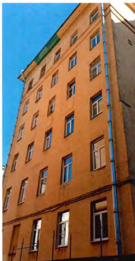
8. Фрагмент. Западный фасад северного флигеля.
