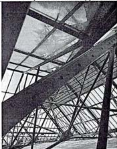
Фото 12. Фрагмент конструкций светового фонаря
