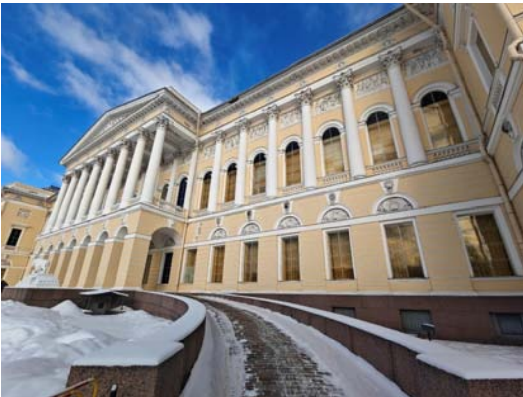
14. «Корпус главный Русского музея» (в составе «Дворец Великого князя Михаила Павловича (Русский музей императора Александра III)», Санкт-Петербург, Инженерная улица, дом 2-4, литера Д. Южный фасад. Фрагмент. Фото 02.02.2026г.
