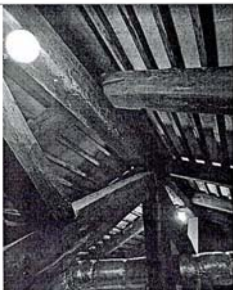
Фото 10. Фрагмент конструкций крыши
