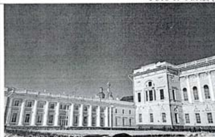
Фото 2. Фасад фрагмент (по ул. Инженерной)
