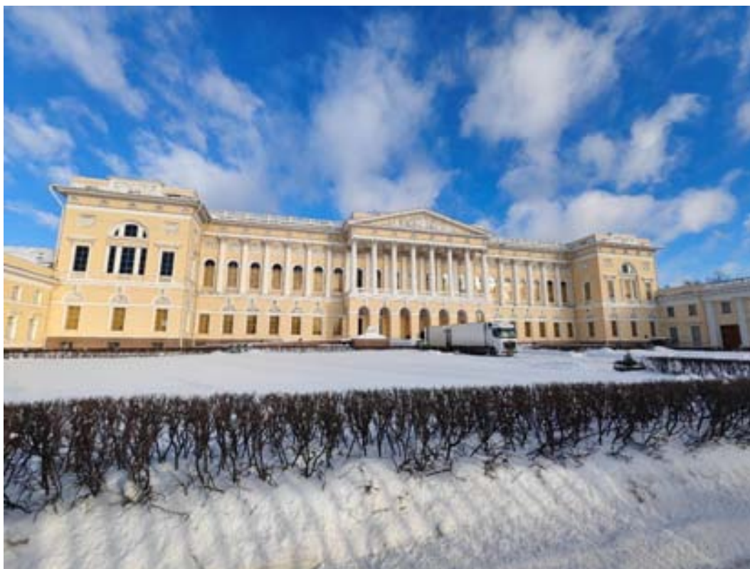
1. «Корпус главный Русского музея» (в составе «Дворец Великого князя Михаила Павловича (Русский музей императора Александра III)», Санкт-Петербург, Инженерная улица, дом 2-4, литера Д. Южный фасад. Общий вид. Фото 02.02.2026г.
