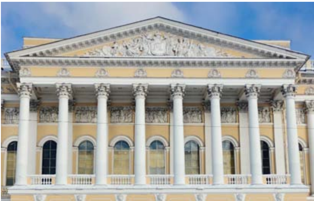
19. «Корпус главный Русского музея» (в составе «Дворец Великого князя Михаила Павловича (Русский музей императора Александра III)», Санкт-Петербург, Инженерная улица, дом 2-4, литера Д. Южный фасад. Фрагмент. Фото 02.02.2026г.
