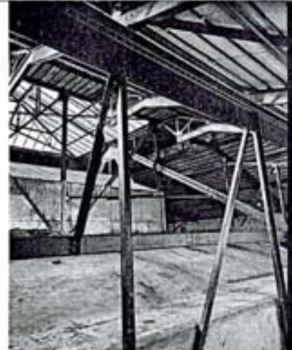
Фото 9. Фрагмент конструкций светового фонаря
