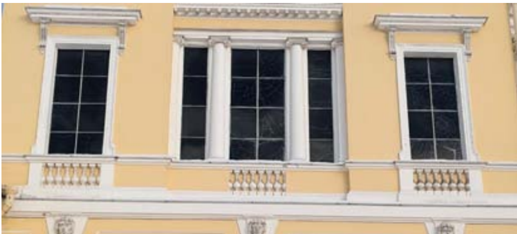
4. «Корпус главный Русского музея» (в составе «Дворец Великого князя Михаила Павловича (Русский музей императора Александра III)», Санкт-Петербург, Инженерная улица, дом 2-4, литера Д. Южный фасад. Фрагмент. Фото 02.02.2026г.
