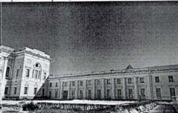
Фото 3. Фасад фрагмент (по ул. Инженерной)
