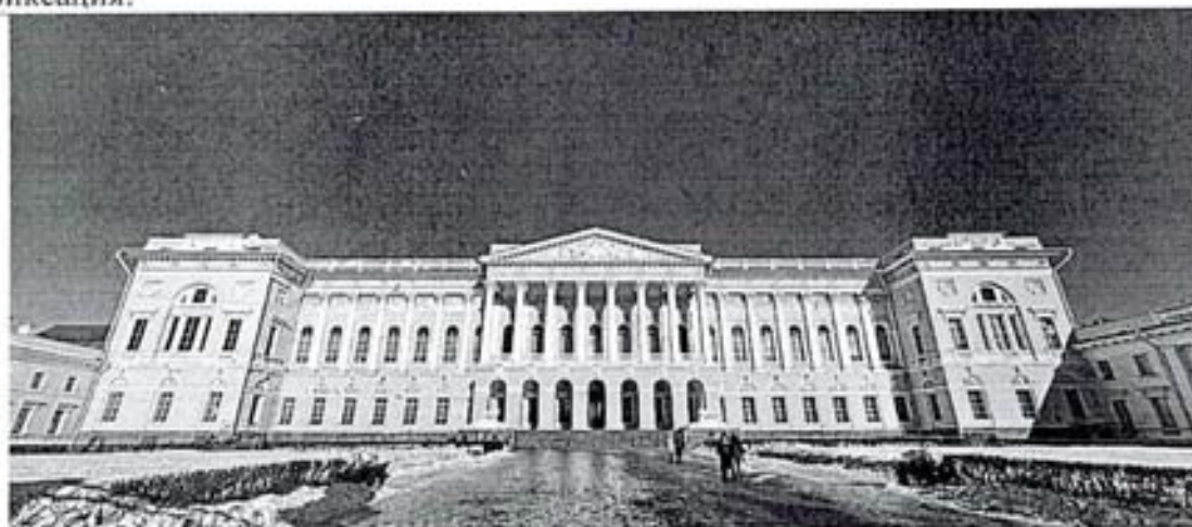
Фото 1. Фасад (по ул. Инженерной)
