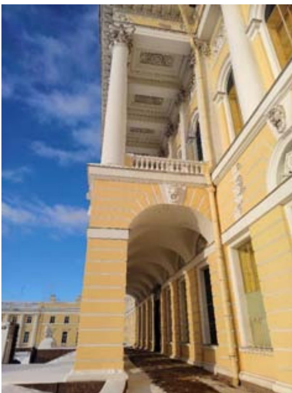
15. «Корпус главный Русского музея» (в составе «Дворец Великого князя Михаила Павловича (Русский музей императора Александра III)», Санкт-Петербург, Инженерная улица, дом 2-4, литера Д. Южный фасад. Фрагмент. Фото 02.02.2026г.
