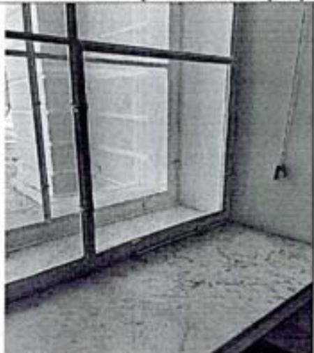
Фото 56. Фрагмент интерьера (подоконная доска)
