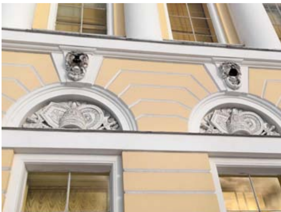
17. «Корпус главный Русского музея» (в составе «Дворец Великого князя Михаила Павловича (Русский музей императора Александра III)», Санкт-Петербург, Инженерная улица, дом 2-4, литера Д. Южный фасад. Фрагмент. Фото 02.02.2026г.
