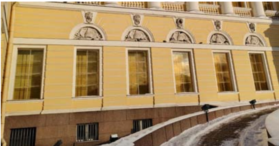
8. «Корпус главный Русского музея» (в составе «Дворец Великого князя Михаила Павловича (Русский музей императора Александра III)», Санкт-Петербург, Инженерная улица, дом 2-4, литера Д. Южный фасад. Фрагмент. Фото 02.02.2026г.
