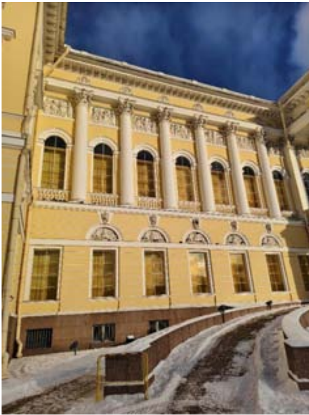
6. «Корпус главный Русского музея» (в составе «Дворец Великого князя Михаила Павловича (Русский музей императора Александра III)», Санкт-Петербург, Инженерная улица, дом 2-4, литера Д. Южный фасад. Фрагмент. Фото 02.02.2026г.
