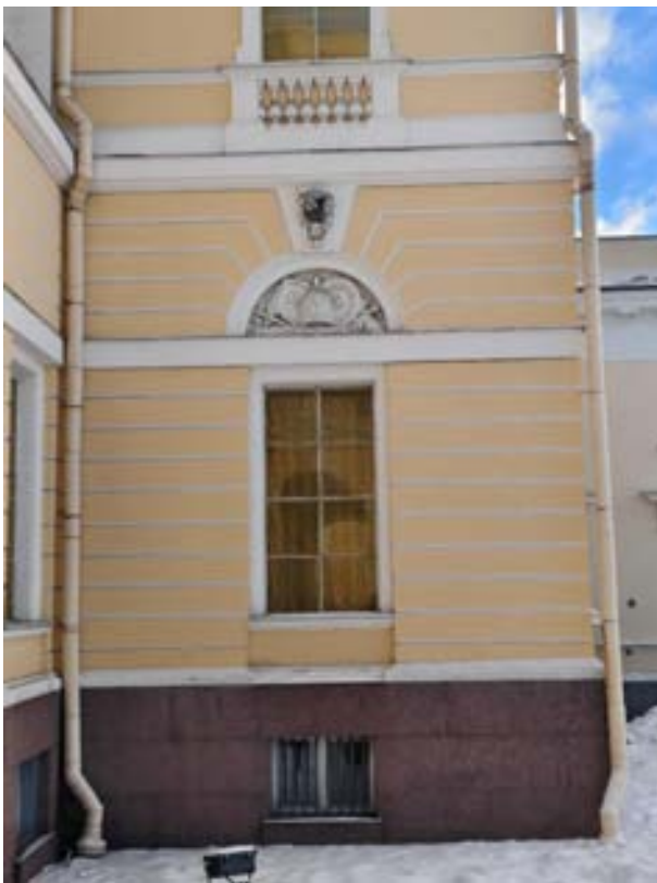
12. «Корпус главный Русского музея» (в составе «Дворец Великого князя Михаила Павловича (Русский музей императора Александра III)», Санкт-Петербург, Инженерная улица, дом 2-4, литера Д. Южный фасад. Фрагмент. Фото 02.02.2026г.
