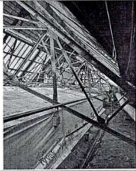
Фото 13. Фрагмент конструкций светового фонаря
