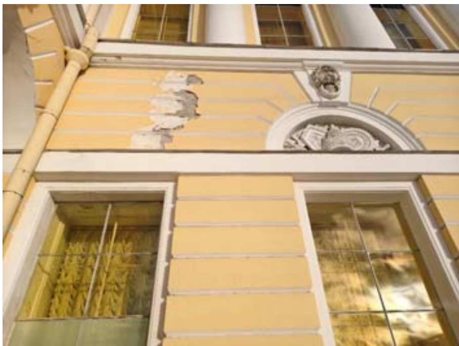
16. «Корпус главный Русского музея» (в составе «Дворец Великого князя Михаила Павловича (Русский музей императора Александра III)», Санкт-Петербург, Инженерная улица, дом 2-4, литера Д. Южный фасад. Фрагмент. Фото 02.02.2026г.
