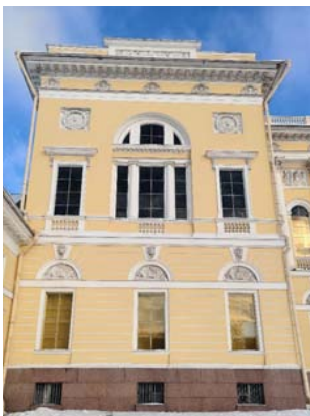
2. «Корпус главный Русского музея» (в составе «Дворец Великого князя Михаила Павловича (Русский музей императора Александра III)», Санкт-Петербург, Инженерная улица, дом 2-4, литера Д. Южный фасад. Фрагмент. Фото 02.02.2026г.
