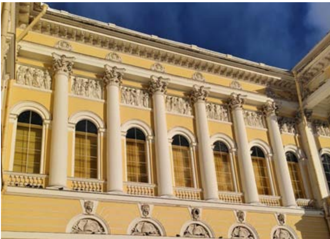
7. «Корпус главный Русского музея» (в составе «Дворец Великого князя Михаила Павловича (Русский музей императора Александра III)», Санкт-Петербург, Инженерная улица, дом 2-4, литера Д. Южный фасад. Фрагмент. Фото 02.02.2026г.
