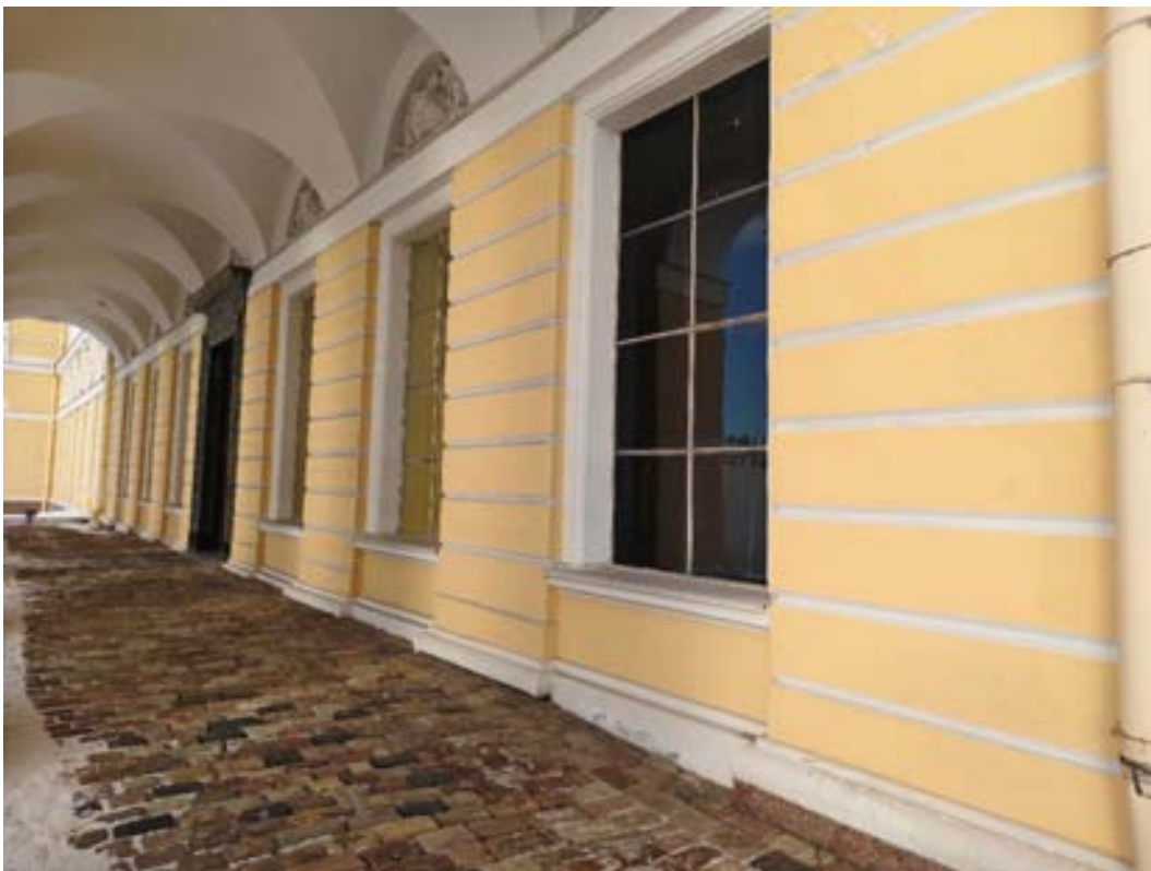
10. «Корпус главный Русского музея» (в составе «Дворец Великого князя Михаила Павловича (Русский музей императора Александра III)», Санкт-Петербург, Инженерная улица, дом 2-4, литера Д. Южный фасад. Фрагмент. Фото 02.02.2026г.
