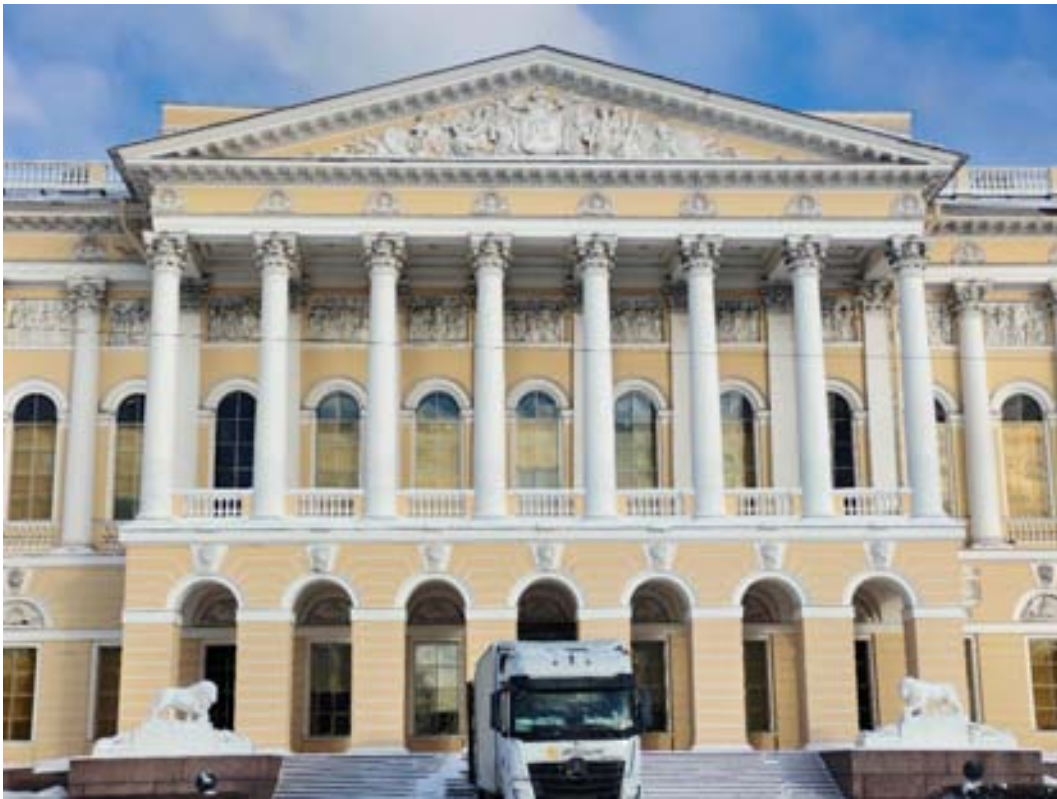
18. «Корпус главный Русского музея» (в составе «Дворец Великого князя Михаила Павловича (Русский музей императора Александра III)», Санкт-Петербург, Инженерная улица, дом 2-4, литера Д. Южный фасад. Фрагмент. Фото 02.02.2026г.
