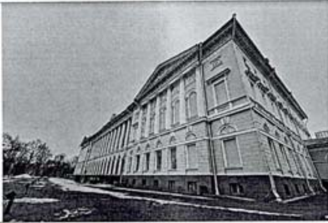
Фото 4. Фасад фрагмент (со стороны Михайловского сада)
