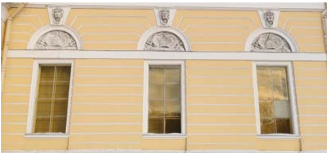
5. «Корпус главный Русского музея» (в составе «Дворец Великого князя Михаила Павловича (Русский музей императора Александра III)», Санкт-Петербург, Инженерная улица, дом 2-4, литера Д. Южный фасад. Фрагмент. Фото 02.02.2026г.
