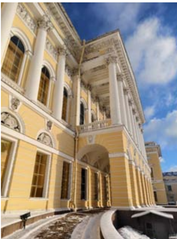
9. «Корпус главный Русского музея» (в составе «Дворец Великого князя Михаила Павловича (Русский музей императора Александра III)», Санкт-Петербург, Инженерная улица, дом 2-4, литера Д. Южный фасад. Фрагмент. Фото 02.02.2026г.
