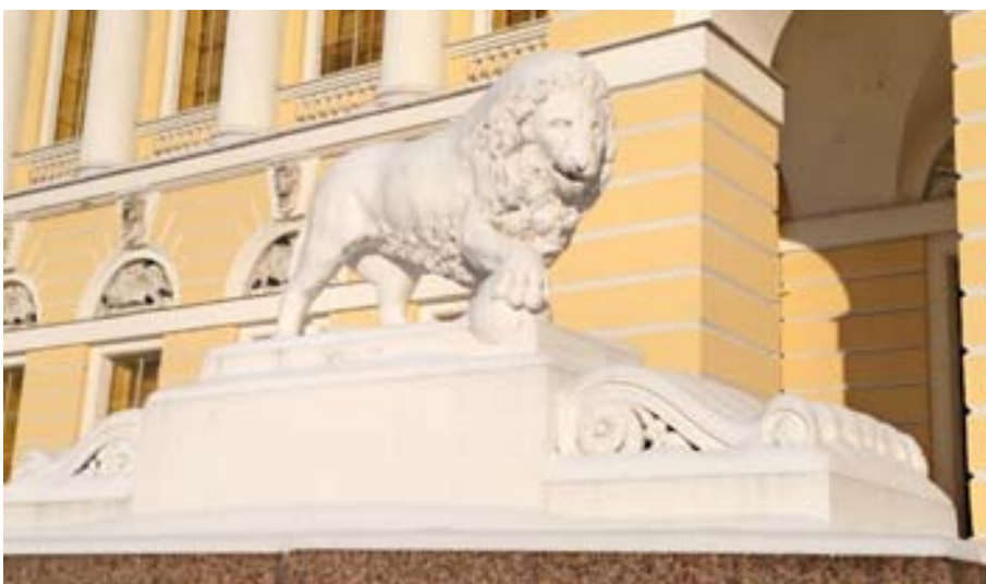
21. «Корпус главный Русского музея» (в составе «Дворец Великого князя Михаила Павловича (Русский музей императора Александра III)», Санкт-Петербург, Инженерная улица, дом 2-4, литера Д. Южный фасад. Фрагмент. Фото 02.02.2026г.
