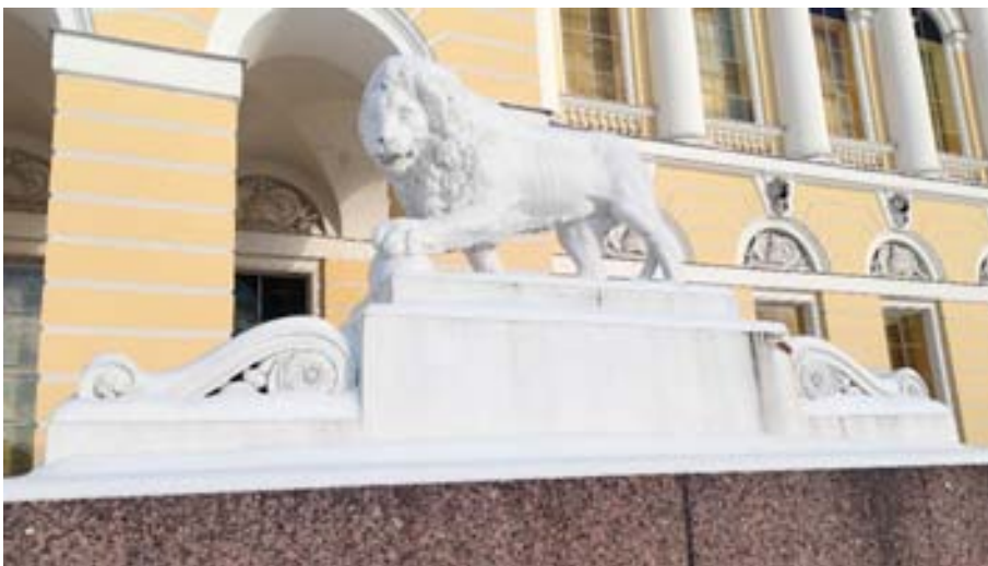
23. «Корпус главный Русского музея» (в составе «Дворец Великого князя Михаила Павловича (Русский музей императора Александра III)», Санкт-Петербург, Инженерная улица, дом 2-4, литера Д. Южный фасад. Фрагмент. Фото 02.02.2026г.
