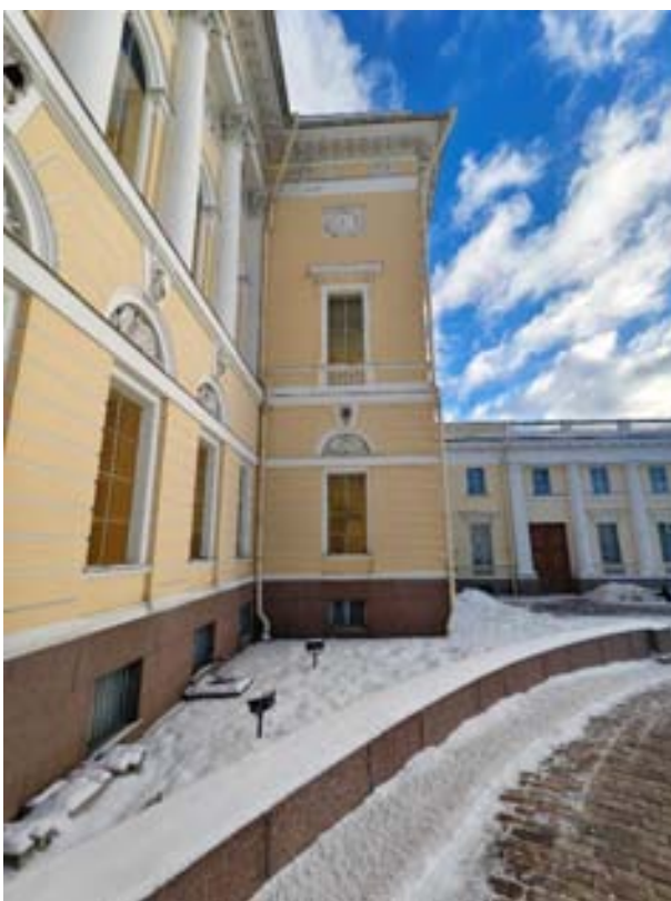
11. «Корпус главный Русского музея» (в составе «Дворец Великого князя Михаила Павловича (Русский музей императора Александра III)», Санкт-Петербург, Инженерная улица, дом 2-4, литера Д. Южный фасад. Фрагмент. Фото 02.02.2026г.
