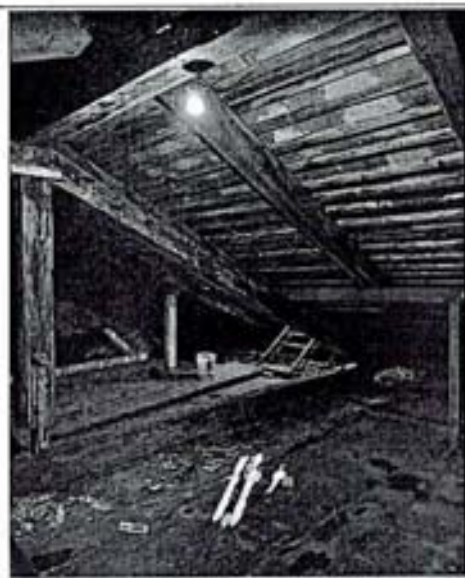
Фото 11. Фрагмент конструкций крыши
