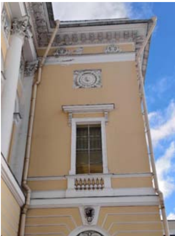
13. «Корпус главный Русского музея» (в составе «Дворец Великого князя Михаила Павловича (Русский музей императора Александра III)», Санкт-Петербург, Инженерная улица, дом 2-4, литера Д. Южный фасад. Фрагмент. Фото 02.02.2026г.
