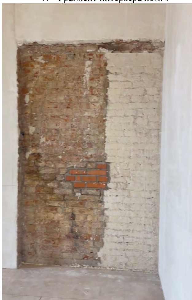
8. Фрагмент интерьера помещения 9, заложенный проем в помещение 13
