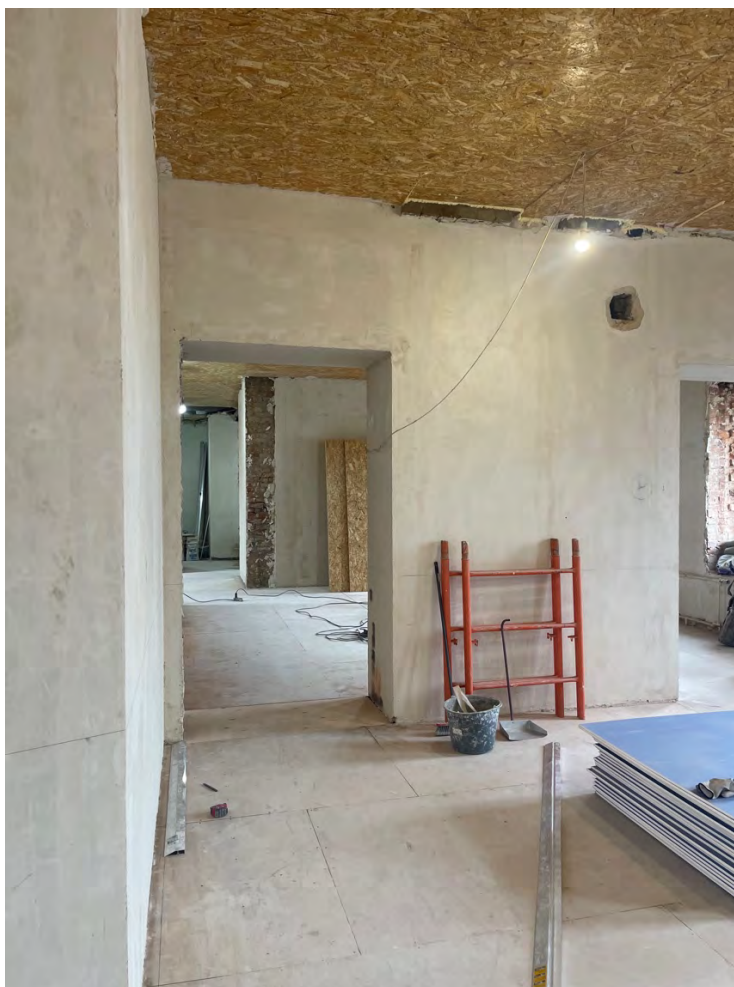
9. Вид на коридор пом. 8
