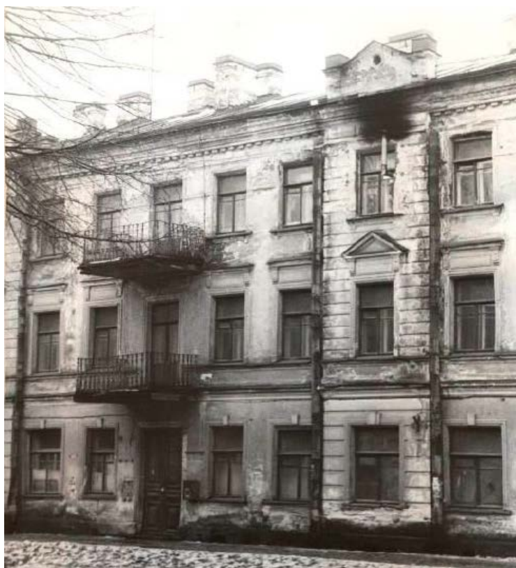
26. СПб., г. Ломоносов, Дворцовый пр., д.14/9 (пр. Юного Ленинца). Фрагмент лицевого фасада по Дворцовому проспекту (световые оси 5-11). Технический отчет. Инженерное обследование здания. Кн.1, Сбс «Стройбытсервис», 1993г. // Архив КГИОП, п-616-Г-6, пр.-138.
