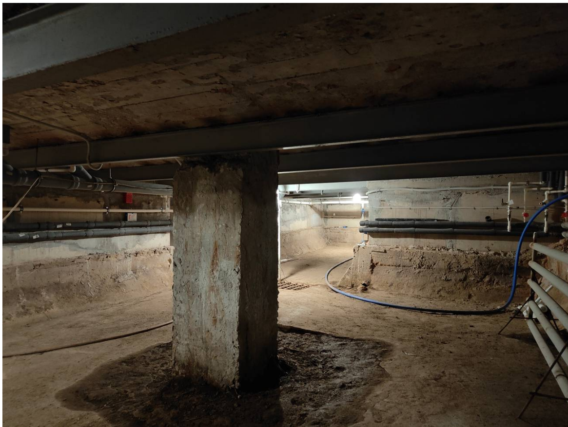
Фото 27 Интерьер выявленного объекта культурного наследия «Жилой дом» расположенного по адресу: Санкт-Петербург, город Ломоносов, Дворцовый проспект, дом 14/9, литера А (подвал)
