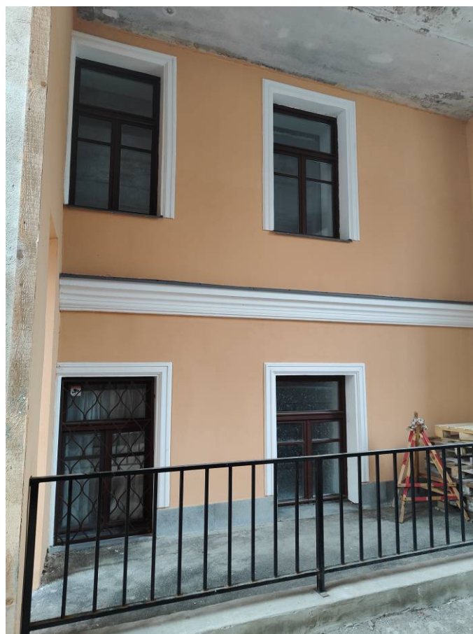
Фото 10 Фрагмент южного фасада выявленного объекта культурного наследия «Жилой дом» расположенного по адресу: Санкт-Петербург, город Ломоносов, Дворцовый проспект, дом 14/9, литера А
