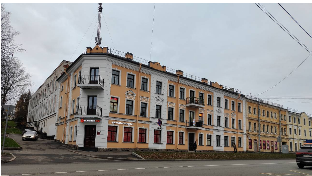
Фото 2 Северный и восточный фасады выявленного объекта культурного наследия «Жилой дом» расположенного по адресу: Санкт-Петербург, город Ломоносов, Дворцовый проспект, дом 14/9, литера А
