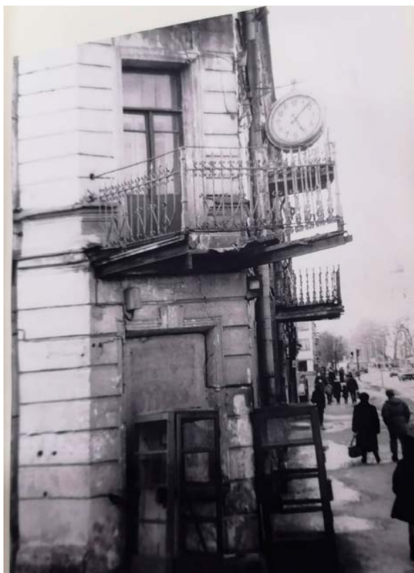
29. СПб., г. Ломоносов, Дворцовый пр., д.14/9 (пр. Юного Ленинца). Фрагмент углового фасада -1-ый и 2-ой этажи. Технический отчет. Инженерное обследование здания. Кн.1, Сбс «Стройбытсервис», 1993г. // Архив КГИОП, п-616-Г-6, пр.-138.
