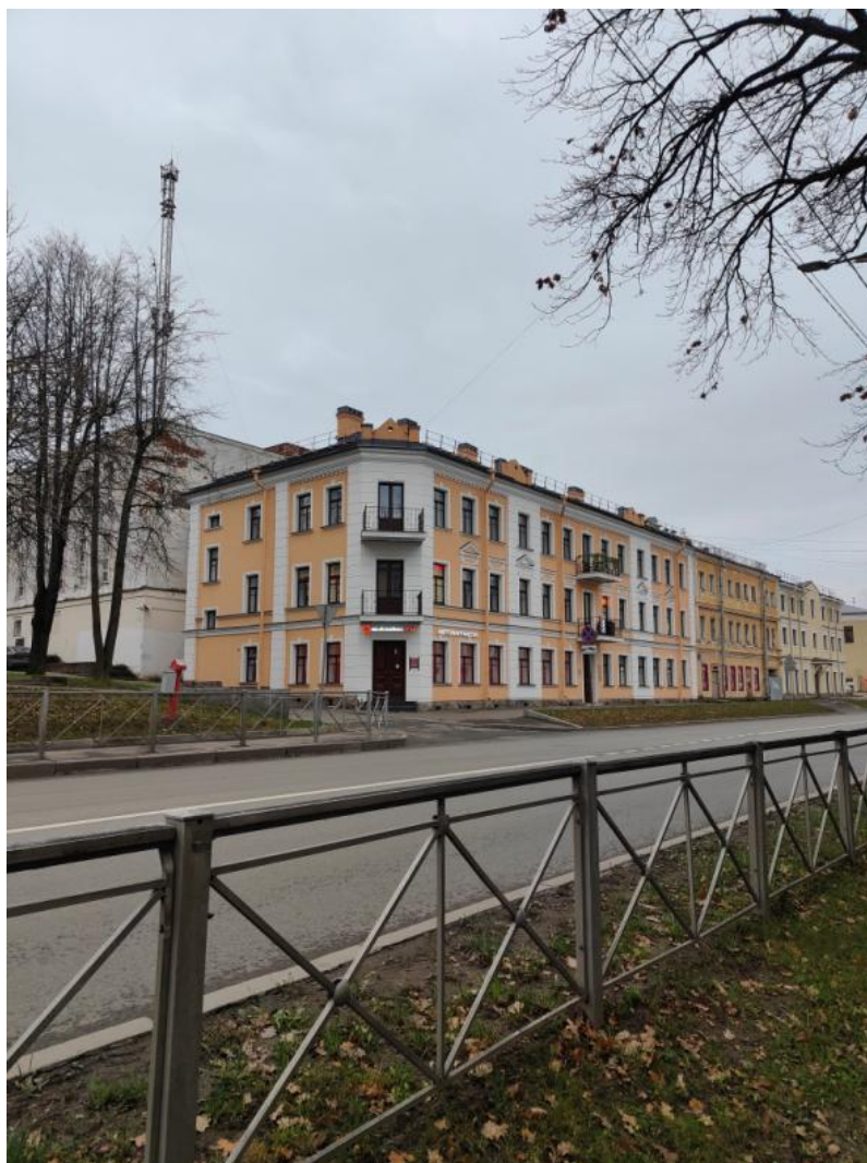
Фото 1 Северный и восточный фасады выявленного объекта культурного наследия «Жилой дом» расположенного по адресу: Санкт-Петербург, город Ломоносов, Дворцовый проспект, дом 14/9, литера А
