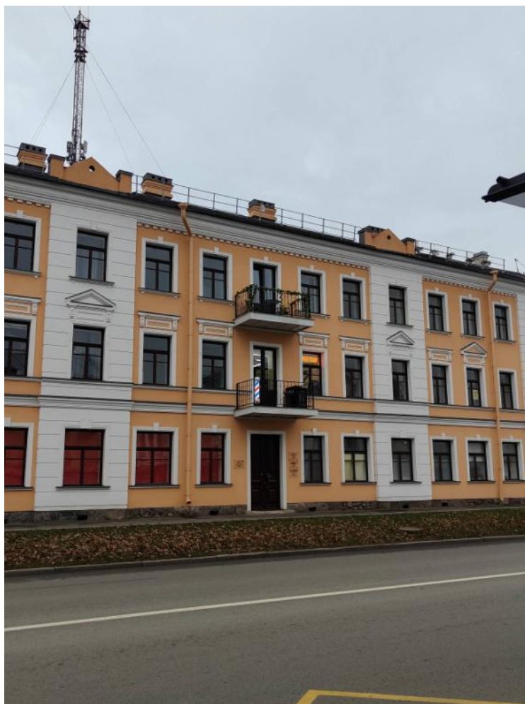
Фото 3 Фрагмент северного фасада выявленного объекта культурного наследия «Жилой дом» расположенного по адресу: Санкт-Петербург, город Ломоносов, Дворцовый проспект, дом 14/9, литера А
