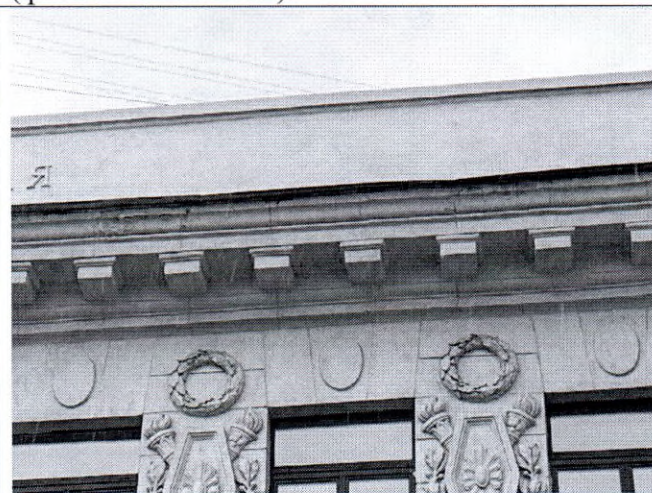
Фото 12. Фрагмент юго-восточного фасада (фото от 12.05.2022).
