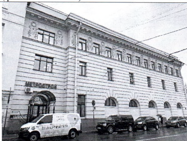
Фото 4. Северо-восточный фасад (фото от 12.05.2022).
