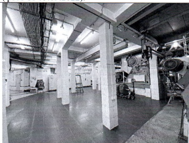
Фото 29. Помещение подвала (2-Н (21) (фото от 12.05.2022).
