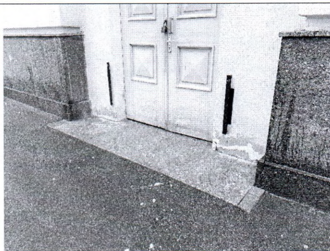
Фото 8. Крыльцо со стороны юго-западного фасада (фото от 12.05.2022).
