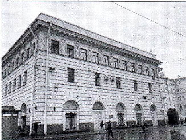
Фото 3. Юго-западный фасад (фото от 12.05.2022).
