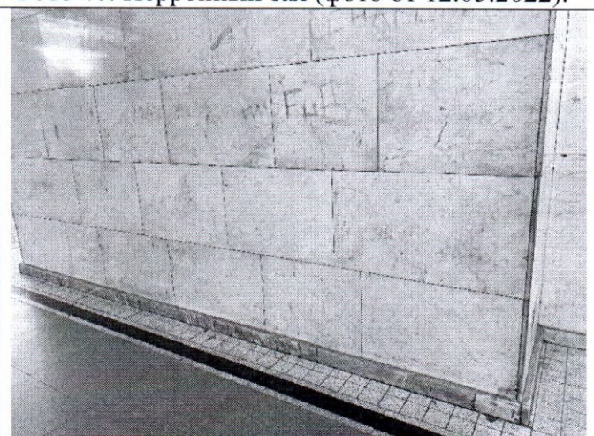
Фото 42. Перронный зал (фото от 12.05.2022).
