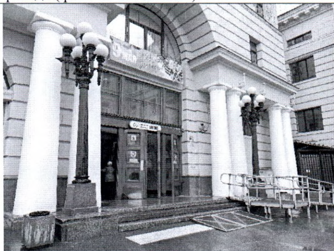
Фото 9. Фрагмент юго-восточного фасада (фото от 12.05.2022).
