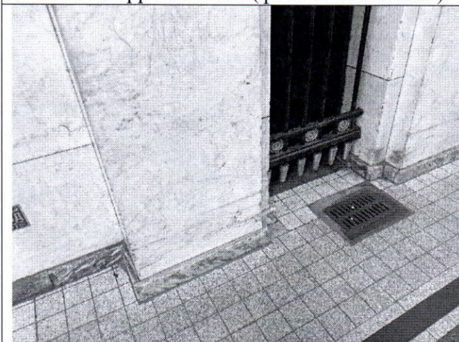
Фото 41. Перронный зал (фото от 12.05.2022).
