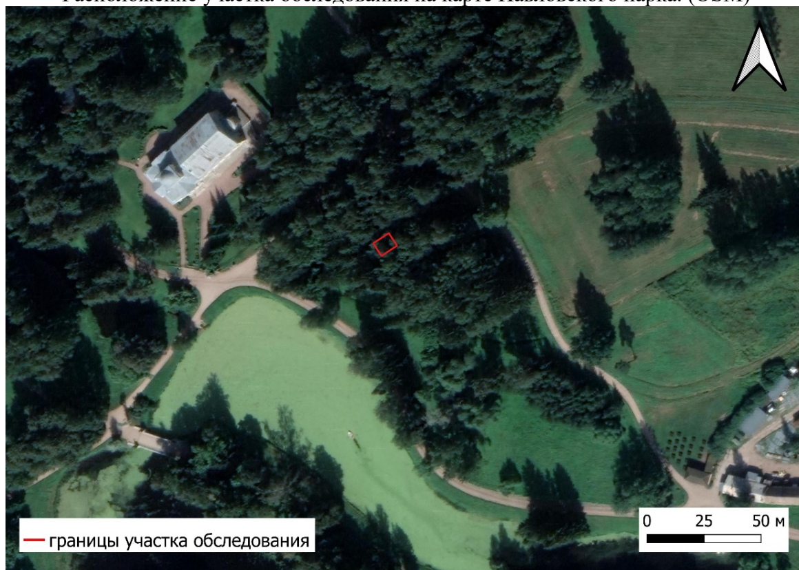
Рис. 4. Санкт-Петербург, Пушкинский р-н, г. Павловск, ул. Садовая, д. 20, лит. 3. Расположение участка обследования на спутниковом снимке Google (23.08.2022).
