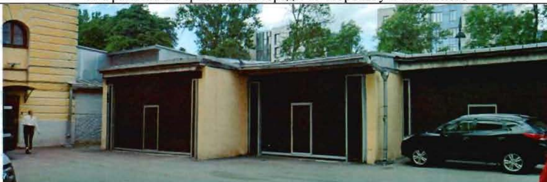
6. Фрагмент северной части ограды со стороны двора
