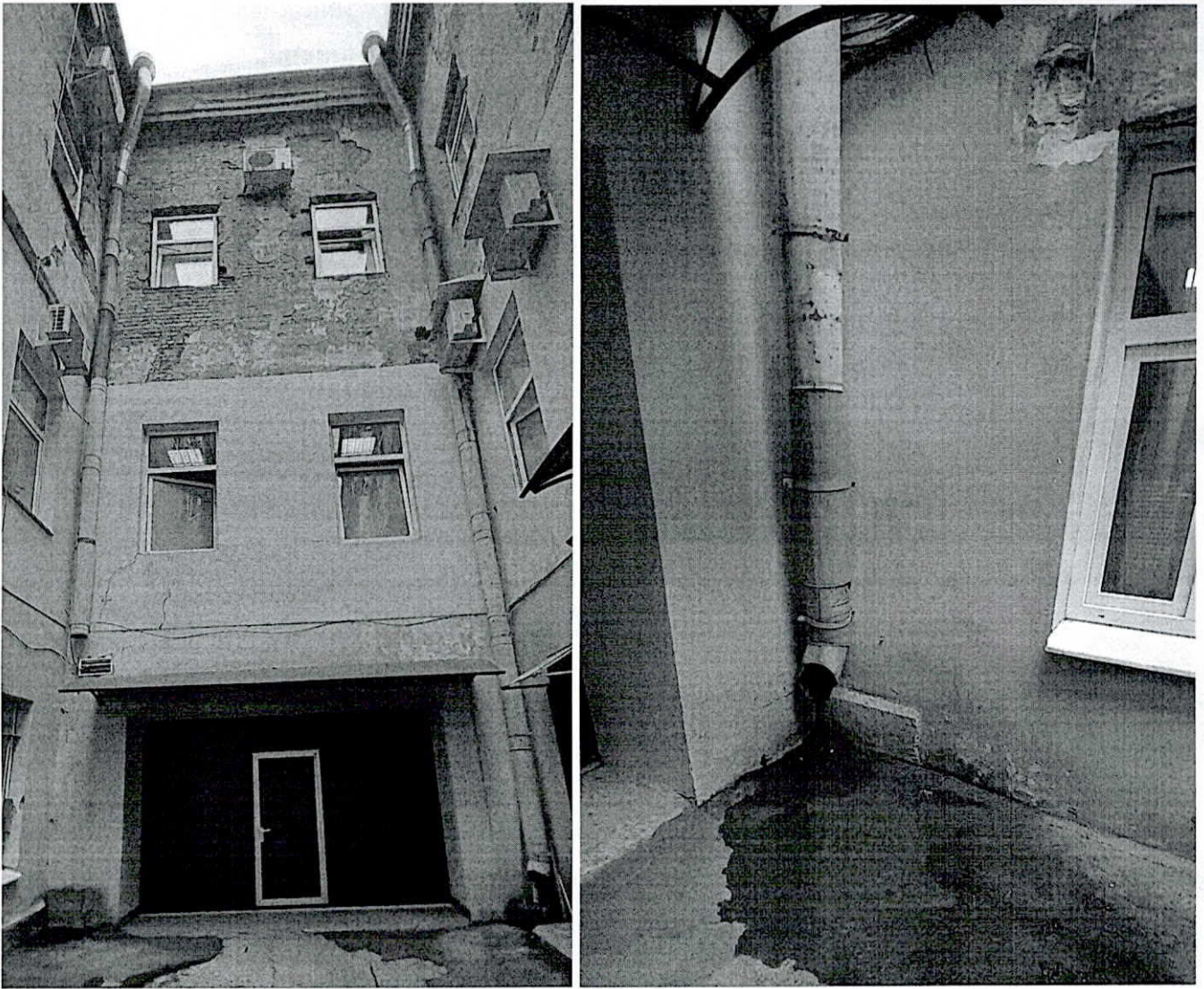
38. Фрагмент дворового фасада
