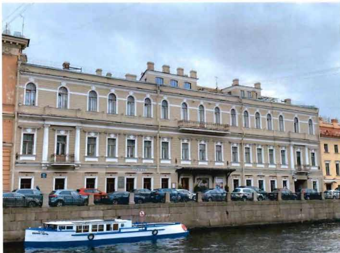
1. Общий вид на объект культурного наследия.
