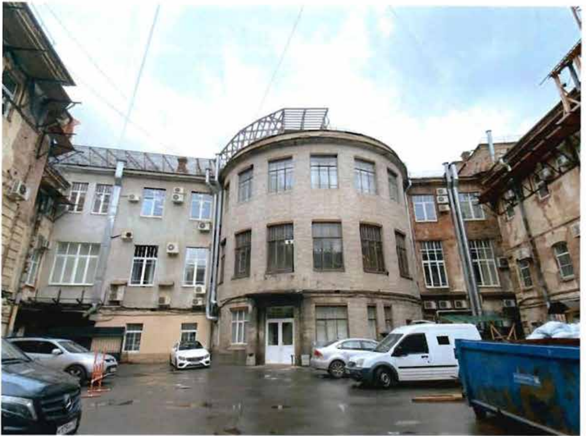
2. Общий вид на объект культурного наследия.
