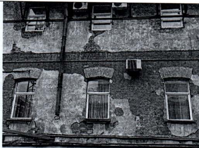
Фото 9. Фрагмент юго-западного фасада большого внутреннего двора.
