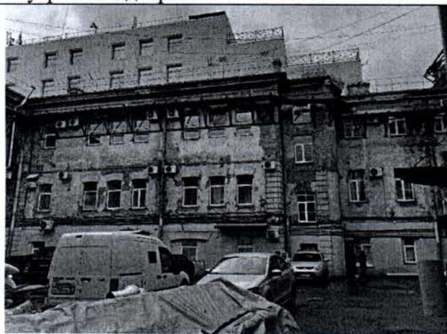
Фото 5. Северо-восточный фасад большого внутреннего двора.
