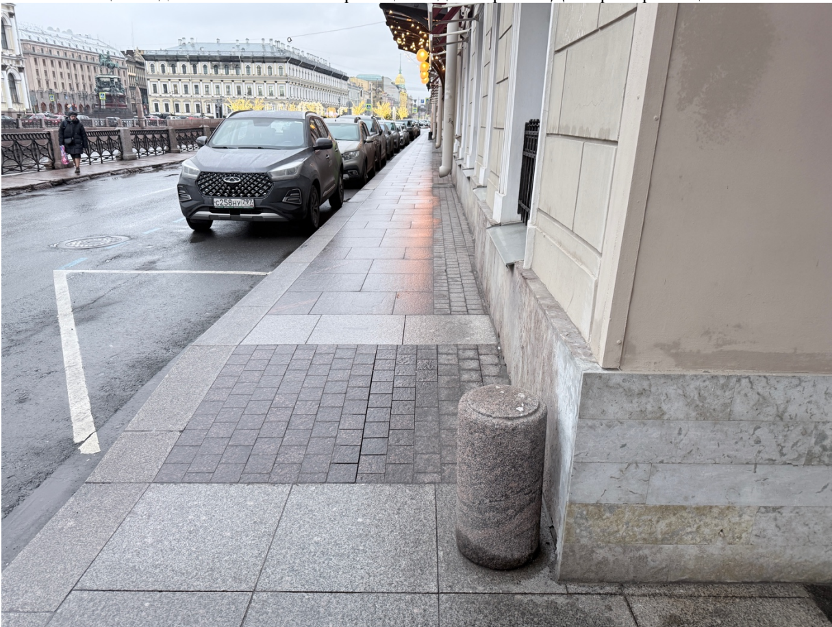
Фото 4. Общий вид на часть объекта в границах ведения работ. Дата фотофиксации: 09.12.2025г.
