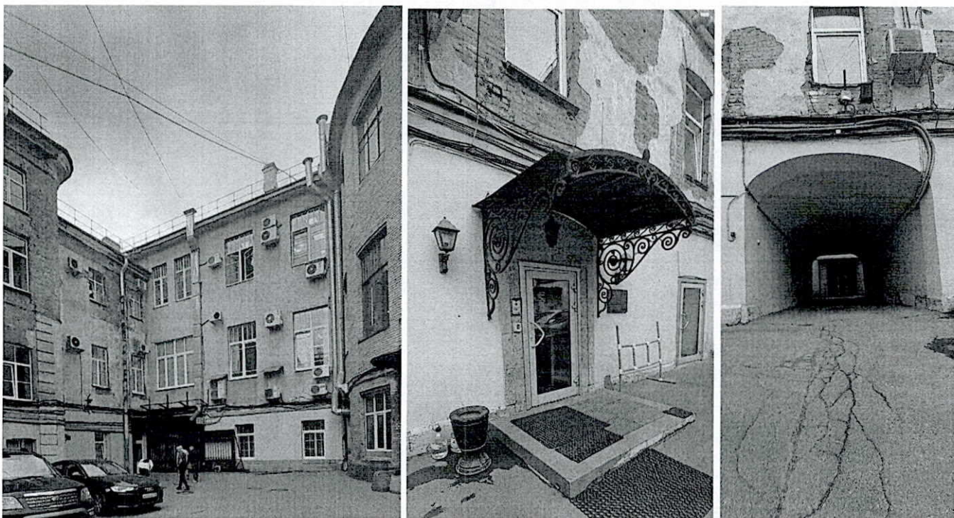
36. Фрагмент дворового фасада
