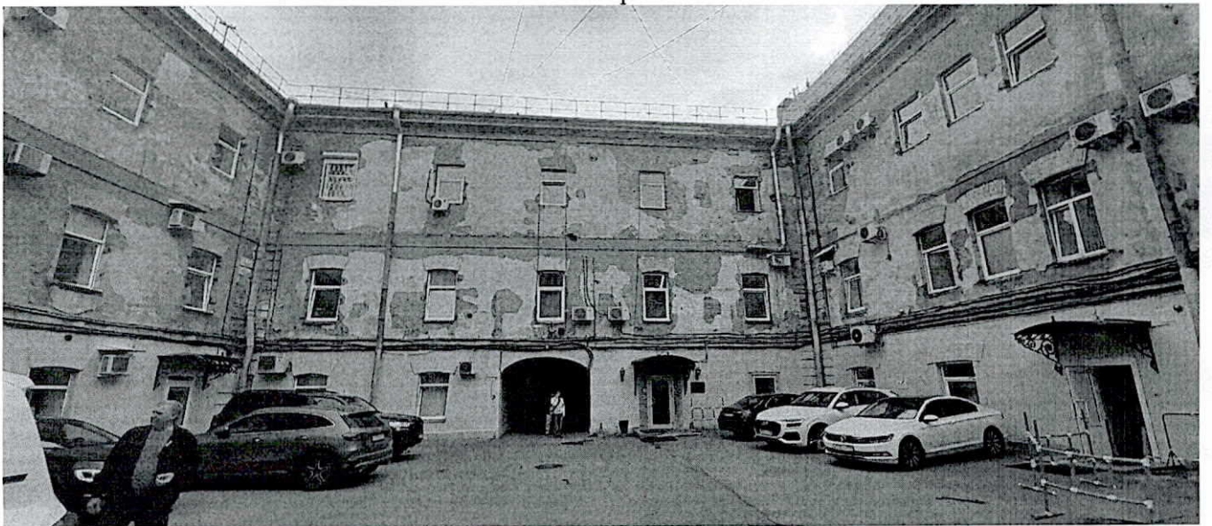
30. Фрагмент дворового фасада
