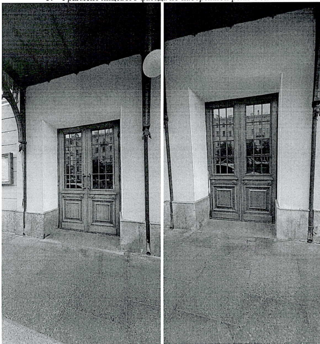
6. Дверное заполнение лицевого фасада по набережной реки Фонтанки
