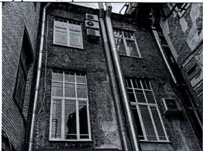
Фото 7. Фрагмент юго-восточного фасада большого внутреннего двора.
