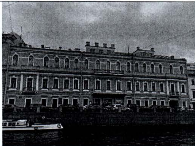
Фото 1. Северо-западный (лицевой) фасад.
