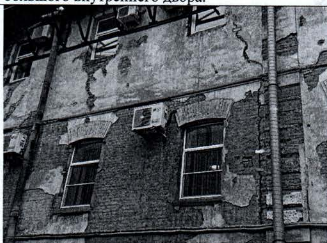
Фото 8. Фрагмент юго-западного фасада большого внутреннего двора.
