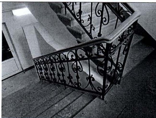
Фото 27. Лестница в юго-западной части дворового корпуса.
