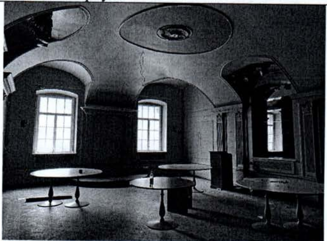
Фото 31. Помещение 1 этажа лицевого корпуса.
