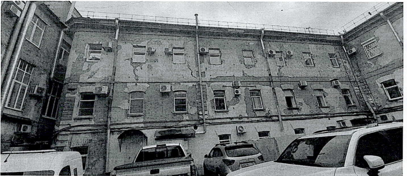
32. Фрагмент дворового фасада
