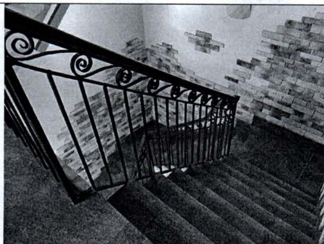
Фото 28. Лестница в северо-восточной части дворового корпуса.
