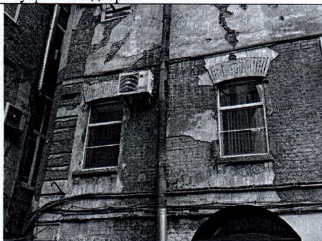
Фото 6. Фрагмент юго-западного фасада большого внутреннего двора.
