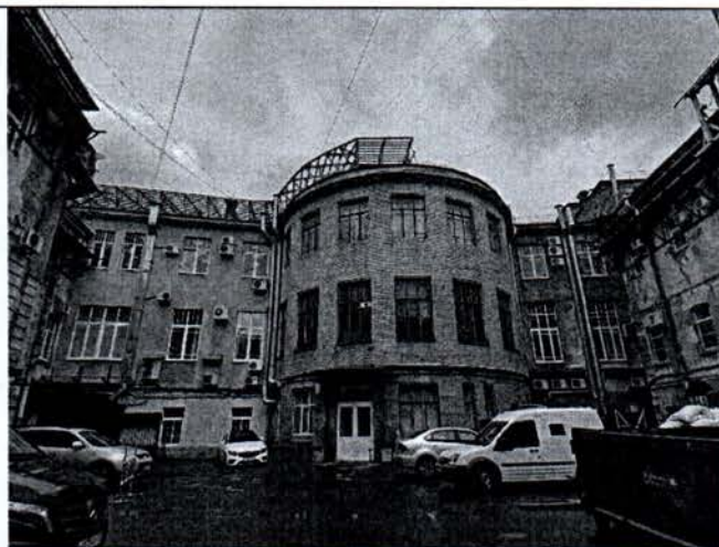
Фото 2. Юго-восточный фасад большого внутреннего двора.
