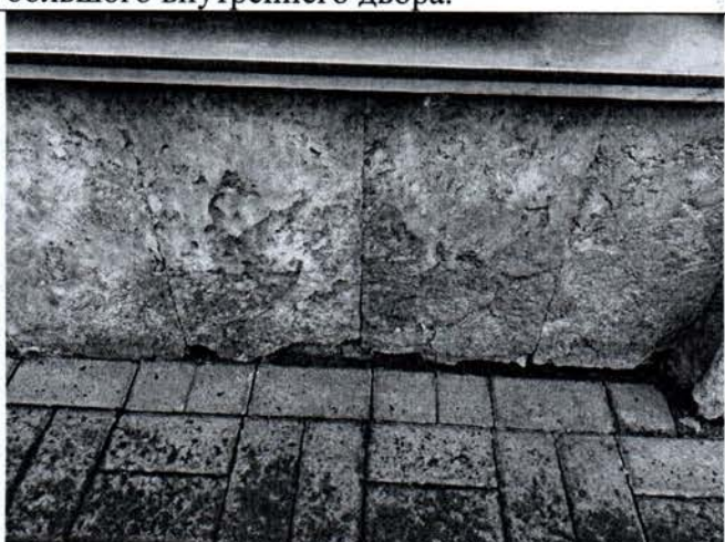
Фото 14. Цоколь северо-западного (лицевого) фасада.
