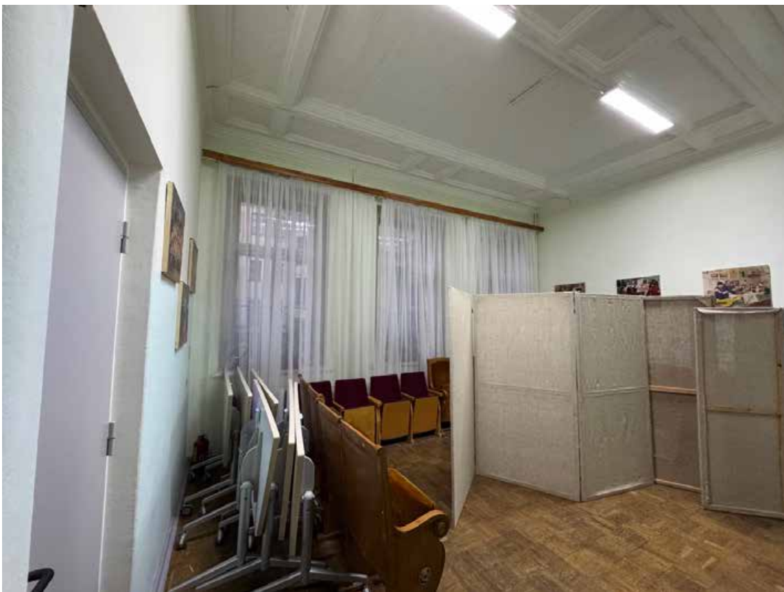
59. Объект культурного наследия регионального значения «Канцелярия Съезда мировых судей», по адресу: г. Санкт-Петербург, Гражданская ул., д. 26, литера А. Общий вид пом. 1-Н (77) в уровне 2 этажа.
