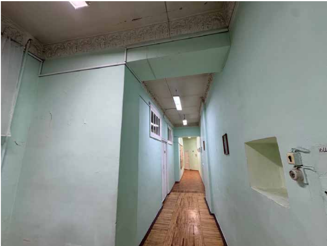
100. Объект культурного наследия регионального значения «Канцелярия Съезда мировых судей», по адресу: г. Санкт-Петербург, Гражданская ул., д. 26, литера А. Фрагмент пом. 1-Н (126) в уровне 4 этажа.
