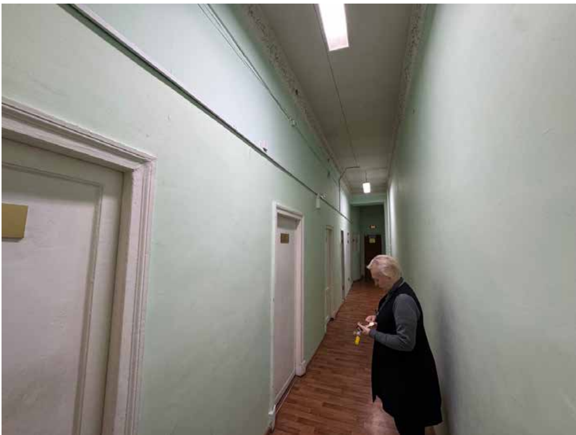
103. Объект культурного наследия регионального значения «Канцелярия Съезда мировых судей», по адресу: г. Санкт-Петербург, Гражданская ул., д. 26, литера А. Фрагмент пом. 1-Н (126) в уровне 4 этажа.
