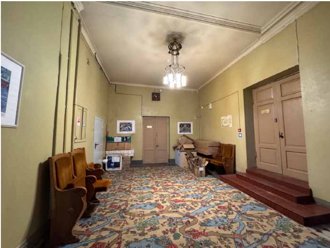
76. Объект культурного наследия регионального значения «Канцелярия Съезда мировых судей», по адресу: г. Санкт-Петербург, Гражданская ул., д. 26, литера А. Общий вид пом. 1-Н (78) в уровне 3 этажа.
