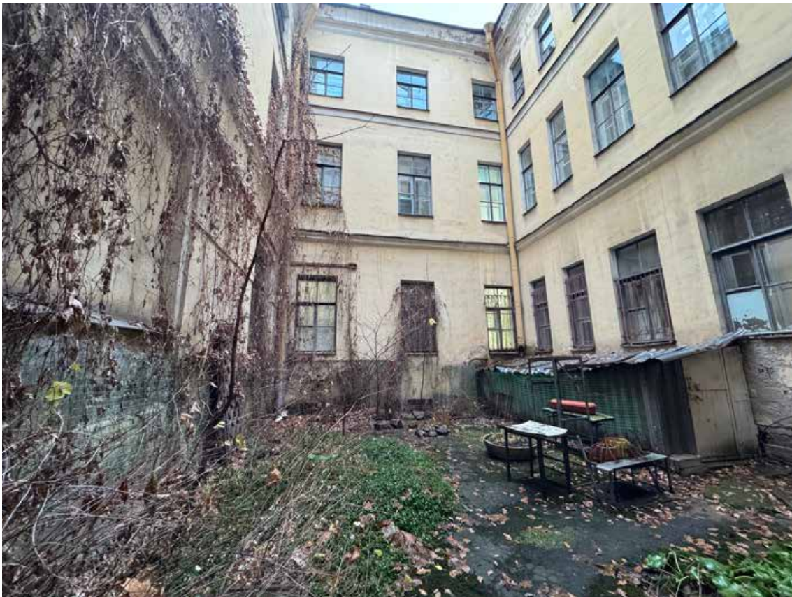
7. Объект культурного наследия регионального значения «Канцелярия Съезда мировых судей», по адресу: г. Санкт-Петербург, Гражданская ул., д. 26, литера А. Общий вид восточного дворового фасада корпуса по Гражданской ул.
