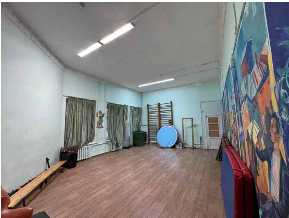
84. Объект культурного наследия регионального значения «Канцелярия Съезда мировых судей», по адресу: г. Санкт-Петербург, Гражданская ул., д. 26, литера А. Общий вид пом. 4-Н (1, 3, 4) в уровне 3 этажа.
