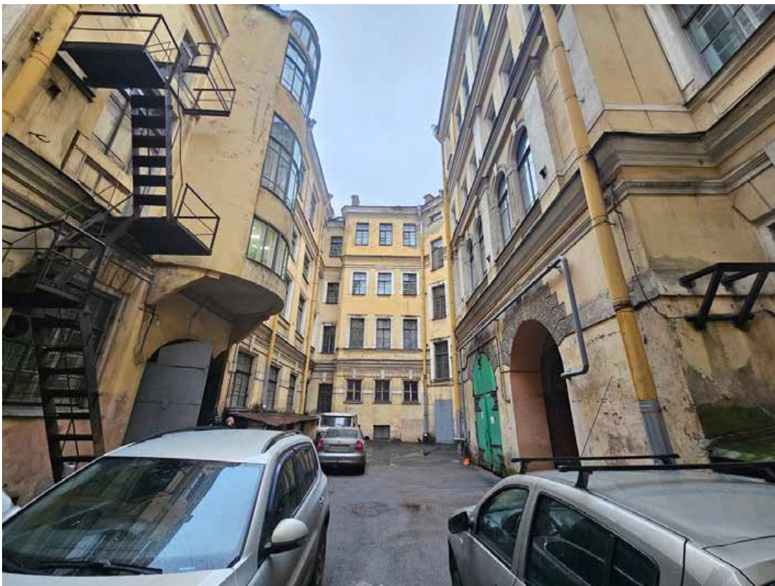
13. Объект культурного наследия регионального значения «Канцелярия Съезда мировых судей», по адресу: г. Санкт-Петербург, Гражданская ул., д. 26, литера А. Общий вид южного двора.
