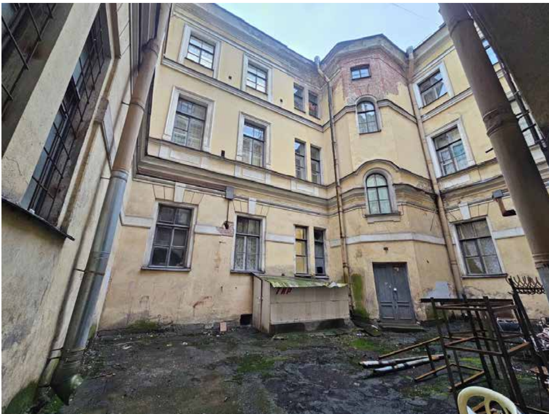
9. Объект культурного наследия регионального значения «Канцелярия Съезда мировых судей», по адресу: г. Санкт-Петербург, Гражданская ул., д. 26, литера А. Общий вид западного двора корпуса по Гражданской ул.
