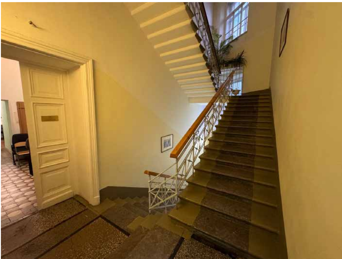
61. Объект культурного наследия регионального значения «Канцелярия Съезда мировых судей», по адресу: г. Санкт-Петербург, Гражданская ул., д. 26, литера А. Общий вид служебной лестницы в уровне 2 этажа.
