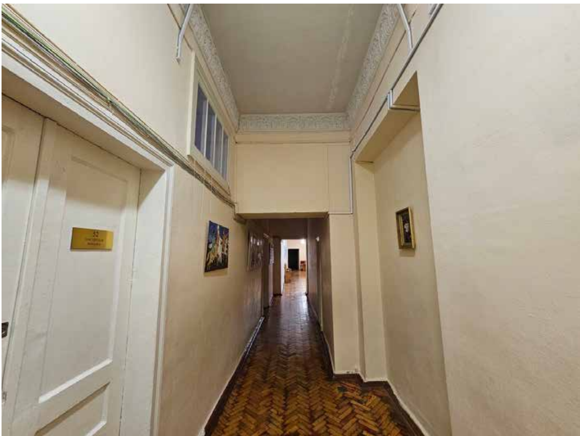
88. Объект культурного наследия регионального значения «Канцелярия Съезда мировых судей», по адресу: г. Санкт-Петербург, Гражданская ул., д. 26, литера А. Общий вид пом. 1-Н (107) в уровне 3 этажа.
