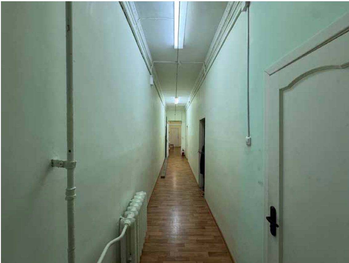
85. Объект культурного наследия регионального значения «Канцелярия Съезда мировых судей», по адресу: г. Санкт-Петербург, Гражданская ул., д. 26, литера А. Общий вид пом. 4-Н (2) в уровне 3 этажа.
