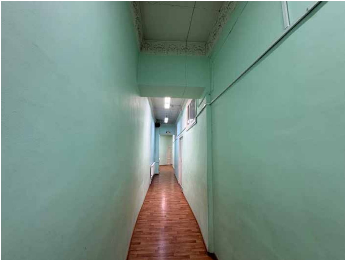
102. Объект культурного наследия регионального значения «Канцелярия Съезда мировых судей», по адресу: г. Санкт-Петербург, Гражданская ул., д. 26, литера А. Фрагмент пом. 1-Н (126) в уровне 4 этажа.
