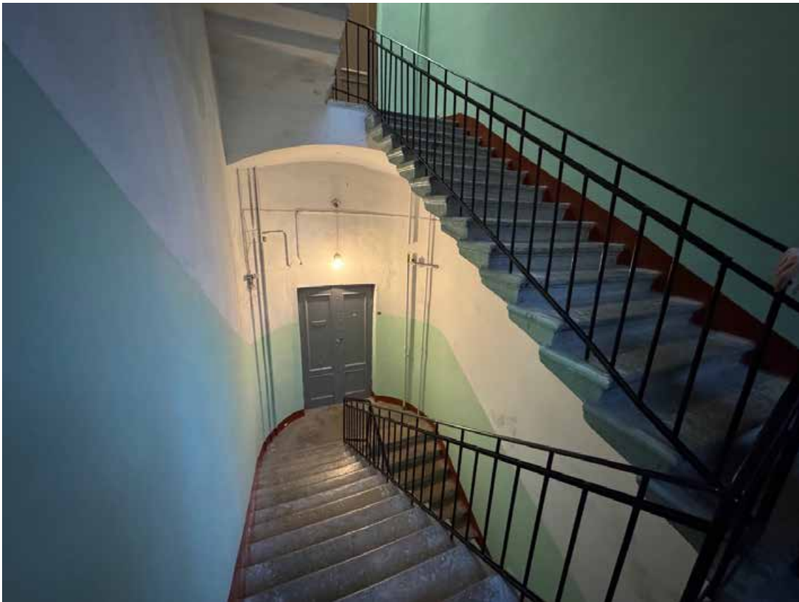
74. Объект культурного наследия регионального значения «Канцелярия Съезда мировых судей», по адресу: г. Санкт-Петербург, Гражданская ул., д. 26, литера А. Фрагмент лестницы Л-3 в уровне 2 этажа.
