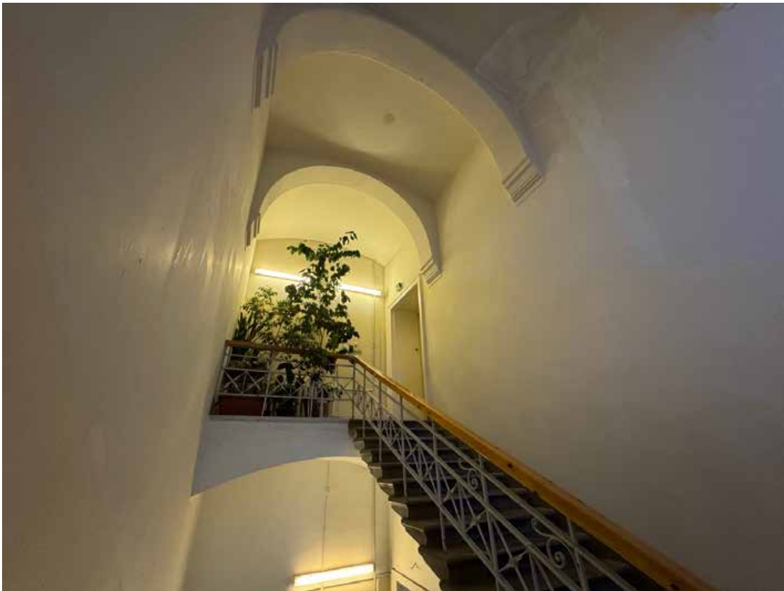
79. Объект культурного наследия регионального значения «Канцелярия Съезда мировых судей», по адресу: г. Санкт-Петербург, Гражданская ул., д. 26, литера А. Общий вид служебной лестницы в уровне 3 этажа.
