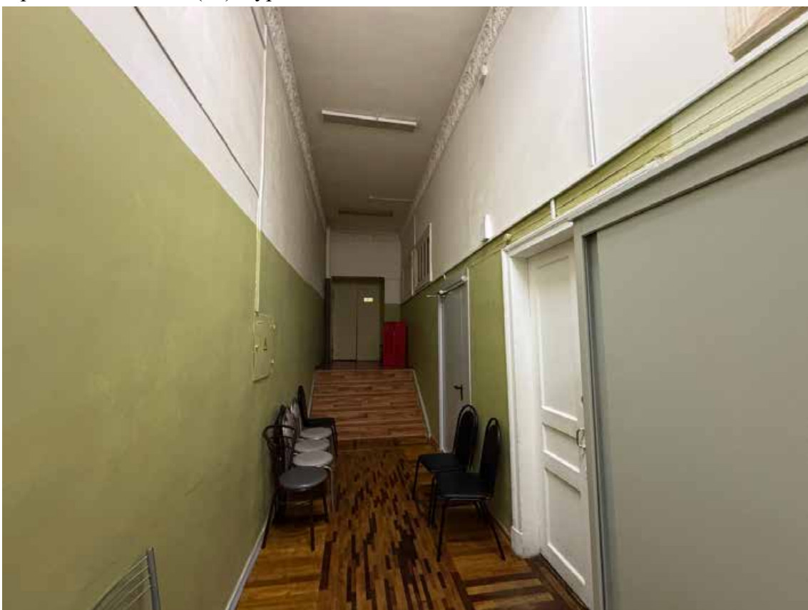
53. Объект культурного наследия регионального значения «Канцелярия Съезда мировых судей», по адресу: г. Санкт-Петербург, Гражданская ул., д. 26, литера А. Фрагмент пом. 1-Н (45) в уровне 2 этажа.
