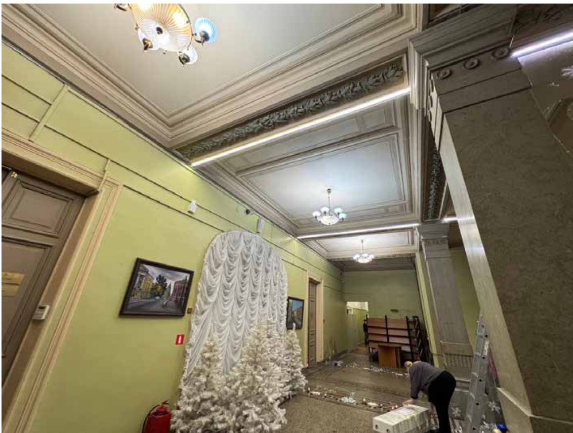
48. Объект культурного наследия регионального значения «Канцелярия Съезда мировых судей», по адресу: г. Санкт-Петербург, Гражданская ул., д. 26, литера А. Фрагмент пом. 1-Н (39) в уровне 2 этажа.
