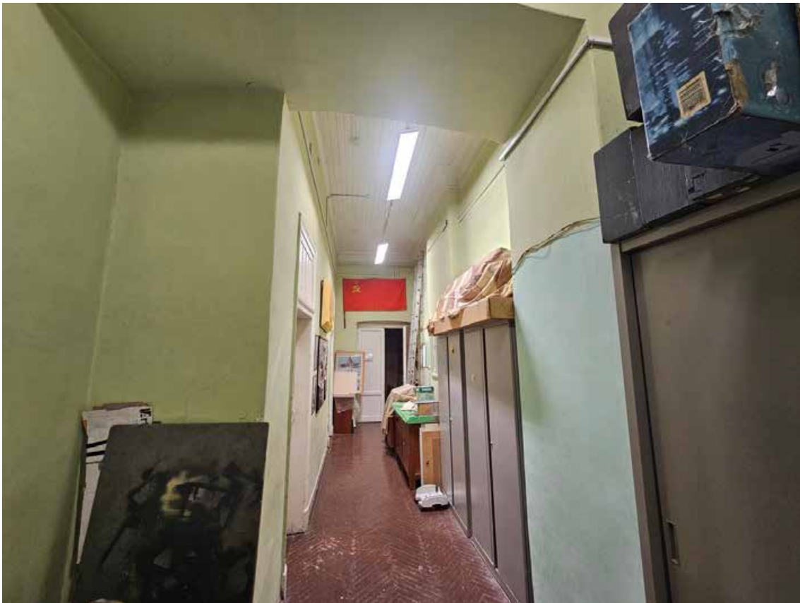
28. Объект культурного наследия регионального значения «Канцелярия Съезда мировых судей», по адресу: г. Санкт-Петербург, Гражданская ул., д. 26, литера А. Общий вид пом. 1-Н (28) в уровне 1 этажа.
