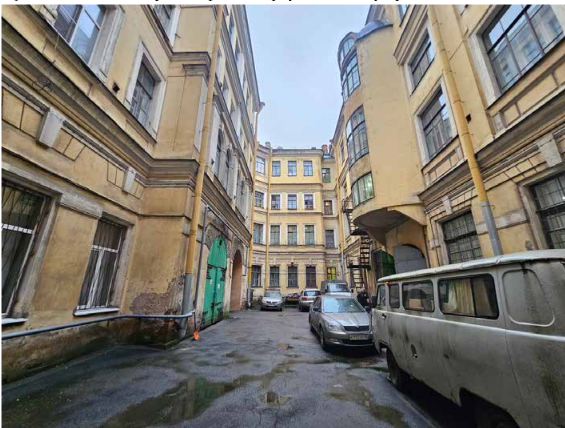
12. Объект культурного наследия регионального значения «Канцелярия Съезда мировых судей», по адресу: г. Санкт-Петербург, Гражданская ул., д. 26, литера А. Общий вид южного двора.
