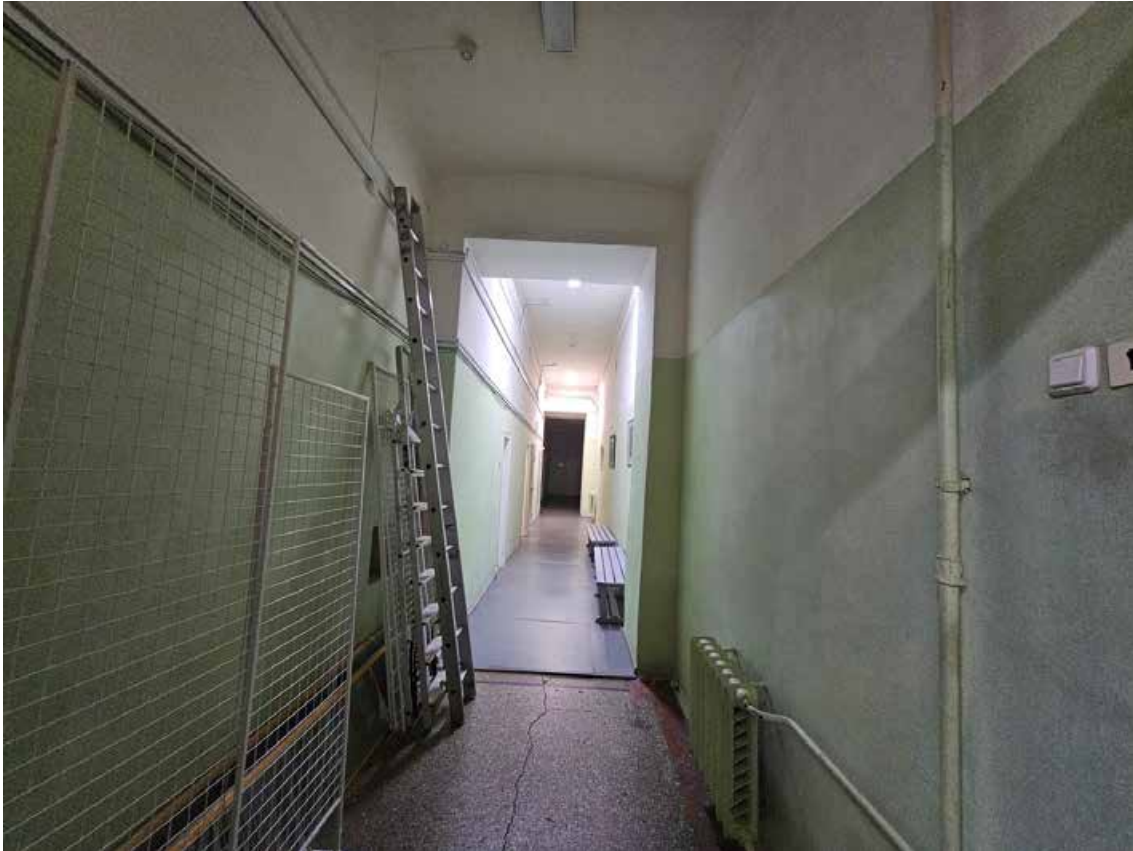
26. Объект культурного наследия регионального значения «Канцелярия Съезда мировых судей», по адресу: г. Санкт-Петербург, Гражданская ул., д. 26, литера А. Фрагмент пом. 1-Н (32) в уровне 1 этажа.
