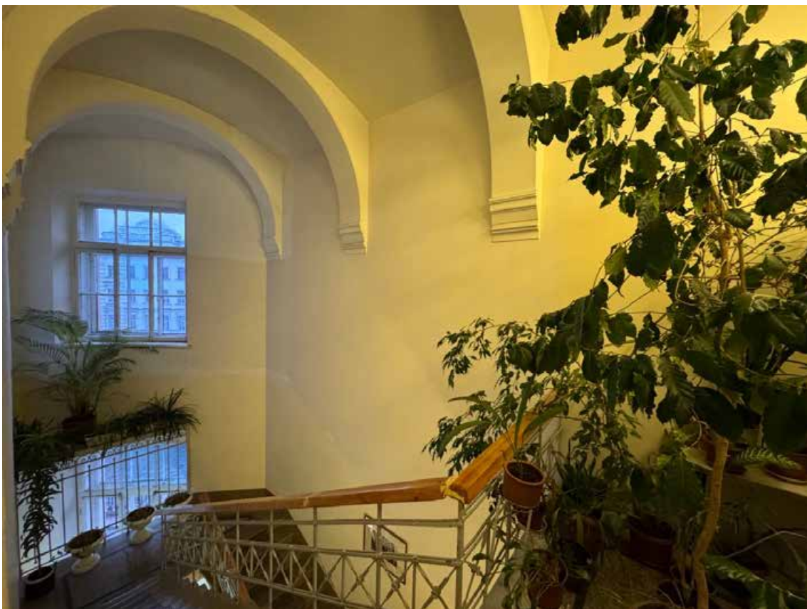
82. Объект культурного наследия регионального значения «Канцелярия Съезда мировых судей», по адресу: г. Санкт-Петербург, Гражданская ул., д. 26, литера А. Общий вид служебной лестницы в уровне 3 этажа.
