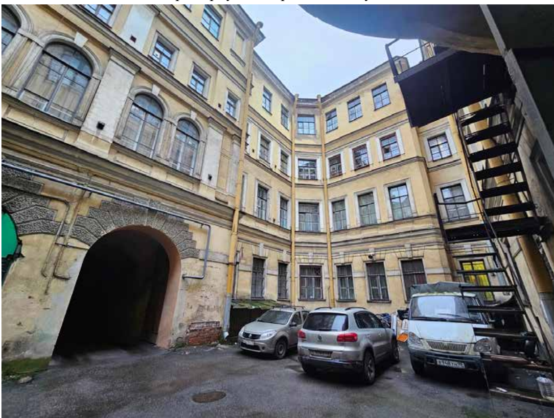
10. Объект культурного наследия регионального значения «Канцелярия Съезда мировых судей», по адресу: г. Санкт-Петербург, Гражданская ул., д. 26, литера А. Фрагмент южного дворового фасада корпуса по каналу Грибоедова.
