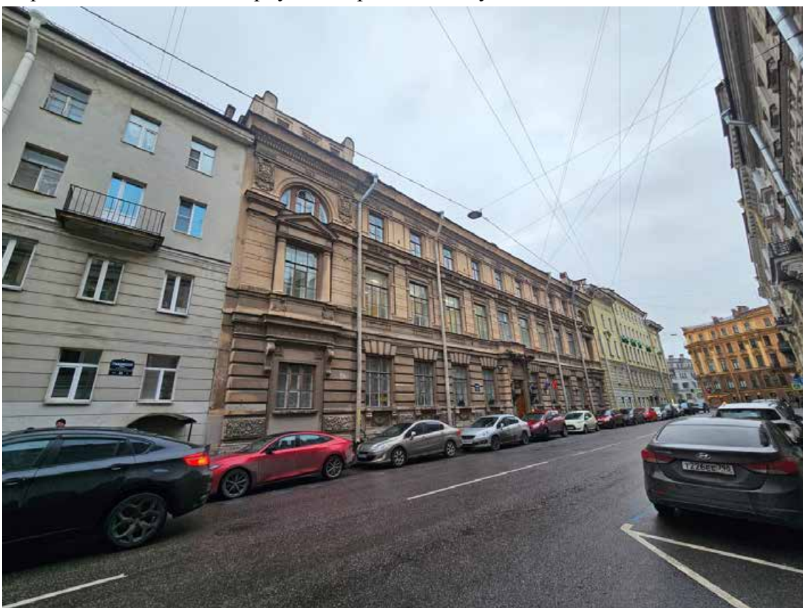
4. Объект культурного наследия регионального значения «Канцелярия Съезда мировых судей», по адресу: г. Санкт-Петербург, Гражданская ул., д. 26, литера А. Общий вид лицевого фасада корпуса по Гражданской ул.
