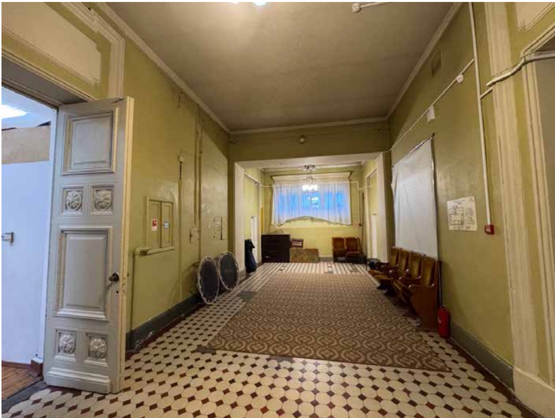
97. Объект культурного наследия регионального значения «Канцелярия Съезда мировых судей», по адресу: г. Санкт-Петербург, Гражданская ул., д. 26, литера А. Общий вид пом. 1-Н (107) в уровне 4 этажа.
