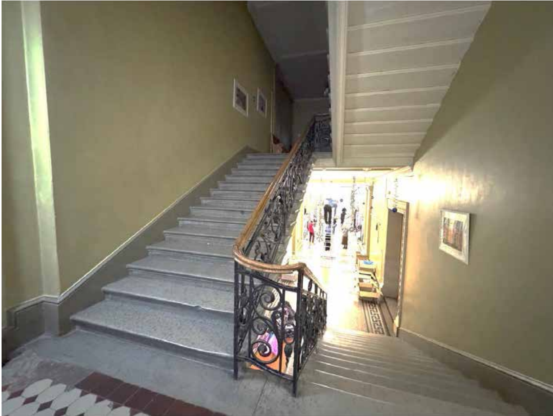
75. Объект культурного наследия регионального значения «Канцелярия Съезда мировых судей», по адресу: г. Санкт-Петербург, Гражданская ул., д. 26, литера А. Общий вид двухмаршевой лестницы в центральной части поперечного дворового корпуса между 2-м и 3-м этажами.
