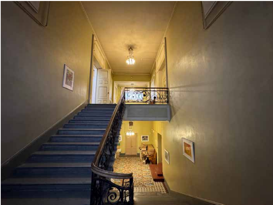
96. Объект культурного наследия регионального значения «Канцелярия Съезда мировых судей», по адресу: г. Санкт-Петербург, Гражданская ул., д. 26, литера А. Общий вид двухмаршевой лестницы в центральной части поперечного дворового корпуса между 3-м и 4-м этажами.
