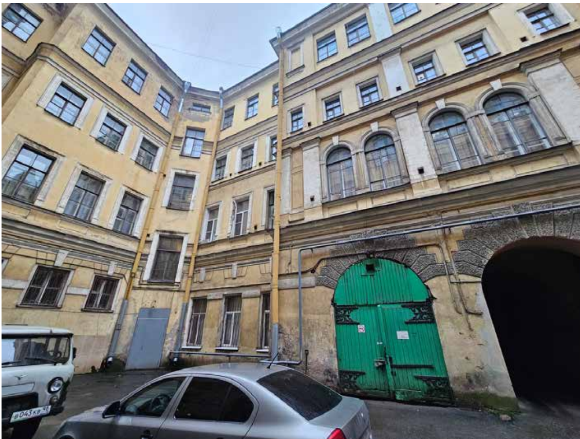
11. Объект культурного наследия регионального значения «Канцелярия Съезда мировых судей», по адресу: г. Санкт-Петербург, Гражданская ул., д. 26, литера А. Фрагмент южного дворового фасада корпуса по каналу Грибоедова.
