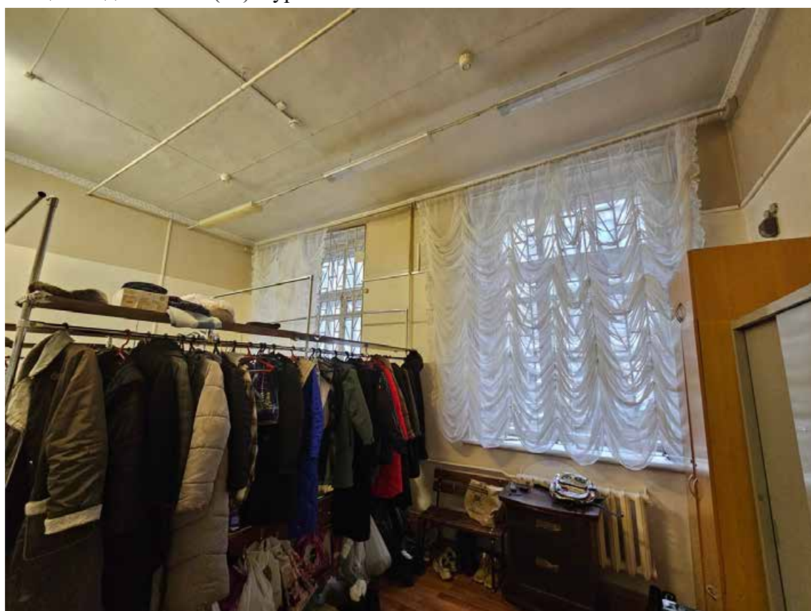
33. Объект культурного наследия регионального значения «Канцелярия Съезда мировых судей», по адресу: г. Санкт-Петербург, Гражданская ул., д. 26, литера А. Общий вид пом. 1-Н (35) в уровне 1 этажа.
