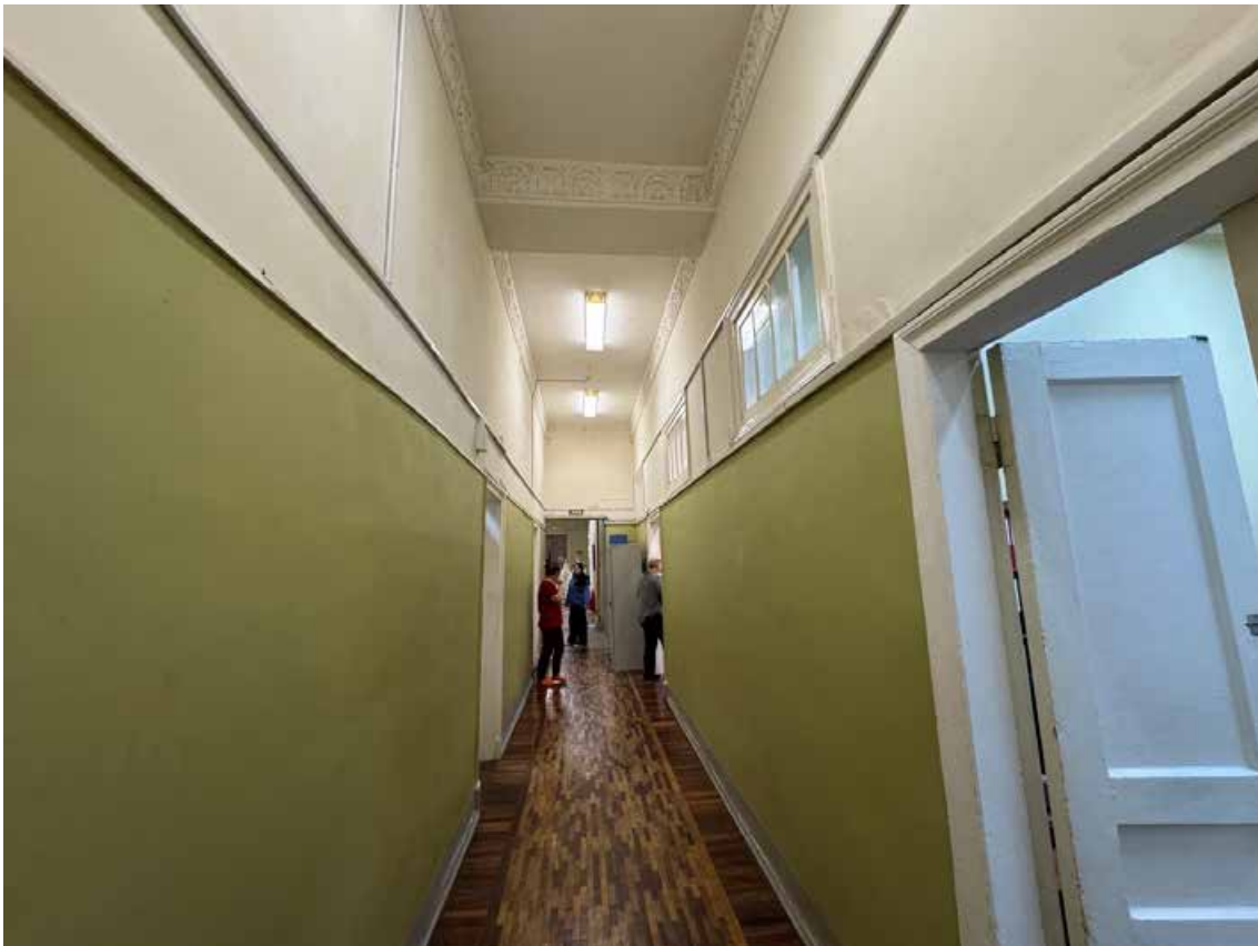
52. Объект культурного наследия регионального значения «Канцелярия Съезда мировых судей», по адресу: г. Санкт-Петербург, Гражданская ул., д. 26, литера А. Фрагмент пом. 1-Н (45) в уровне 2 этажа.
