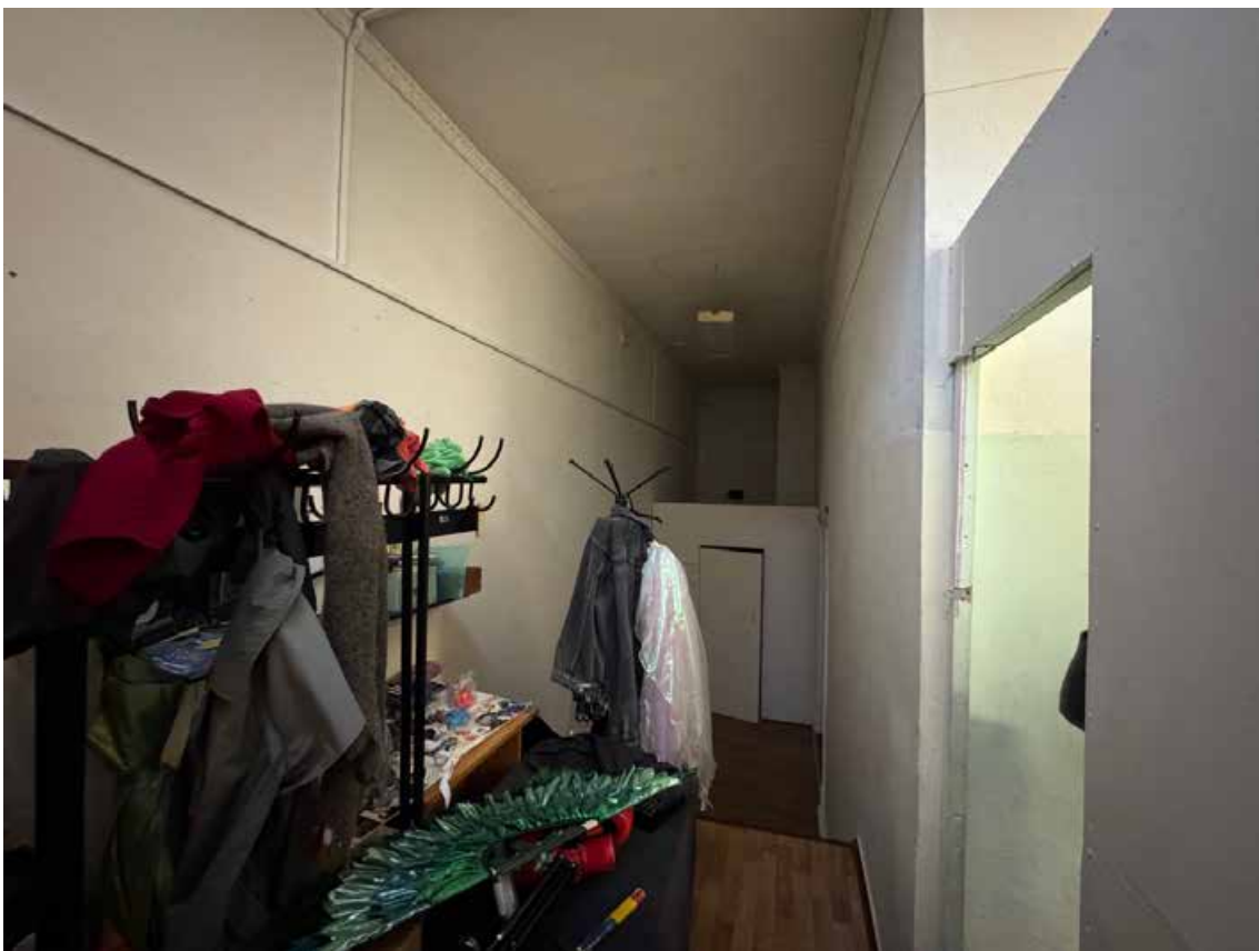
73. Объект культурного наследия регионального значения «Канцелярия Съезда мировых судей», по адресу: г. Санкт-Петербург, Гражданская ул., д. 26, литера А. Общий вид пом. 1-Н (46) в уровне 2 этажа.
