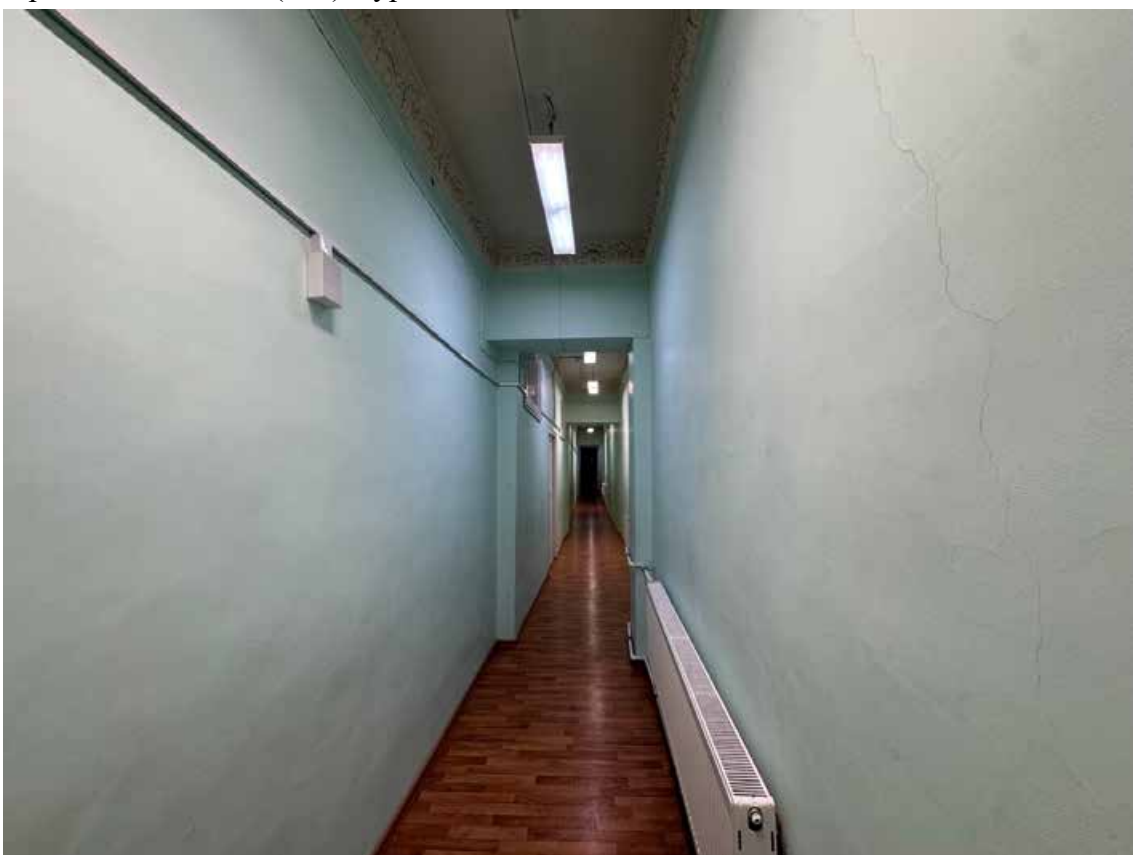
101. Объект культурного наследия регионального значения «Канцелярия Съезда мировых судей», по адресу: г. Санкт-Петербург, Гражданская ул., д. 26, литера А. Фрагмент пом. 1-Н (126) в уровне 4 этажа.
