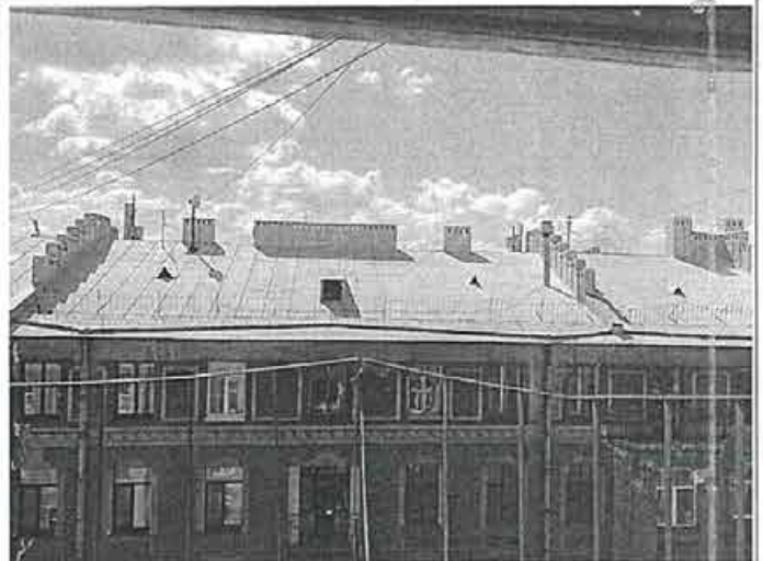
Фото 68. Фрагмент кровли, имеются сквозные отверстия.
