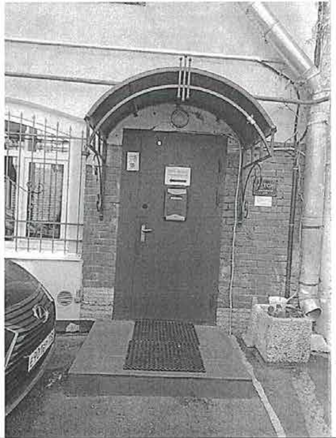
Фото 126. Фрагмент фасада Литера Ц.
