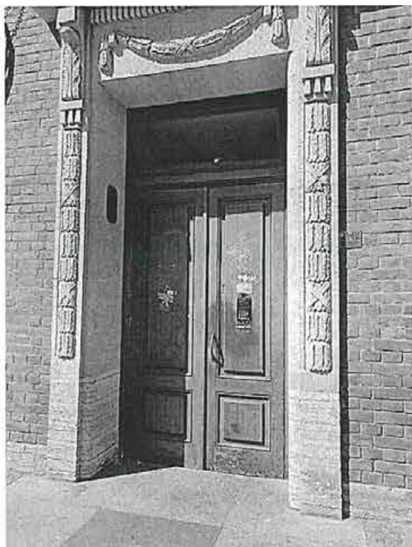
Фото 45. Фрагмент лицевого фасада со стороны Рубинштейна
