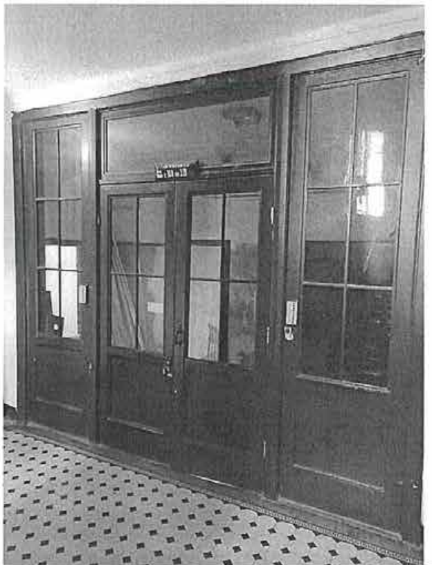
Фото 86. Дверное заполнение квартиры № 309-328
