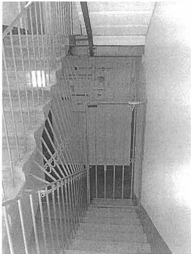
Фото 111. Устройство металлической решетки ограждения между 1 и 2 этажами на черной лестнице (где расположены квартиры №№ 156, 157)
