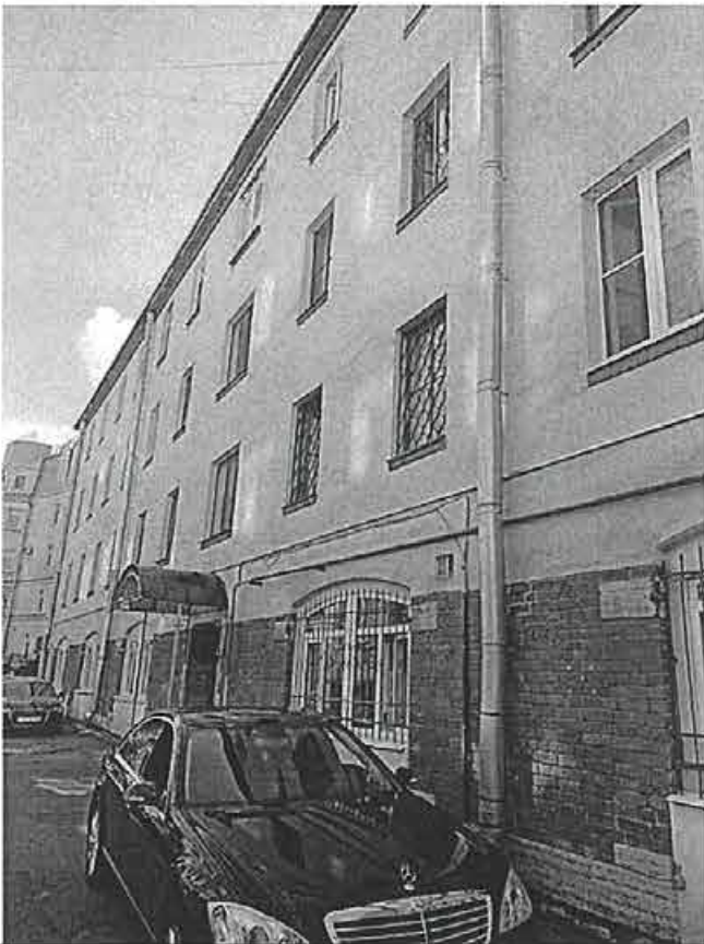
Фото 125. Фрагмент фасада Литера Ц.
