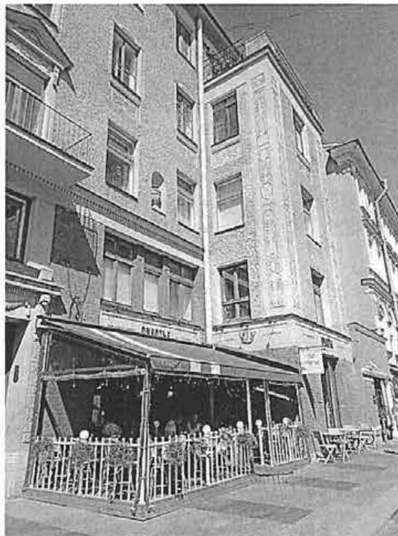
Фото 52. Фрагмент лицевого фасада со стороны Рубинштейна. Правая сторона. Устройство маркизы помещения № 73-Н. Крепление маркиз помещения № 73-Н осуществляется к фасаду Объекта.
