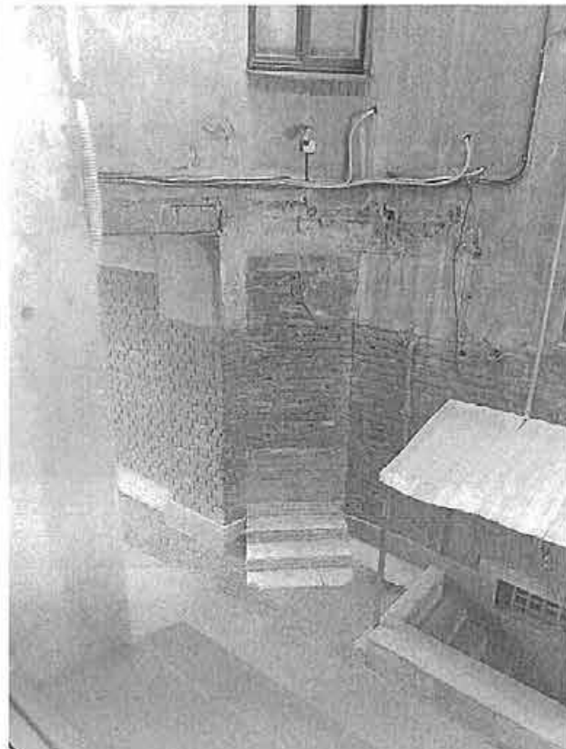
Фото 112. Выполнена закладка проема кирпичом помещения 1-Н
