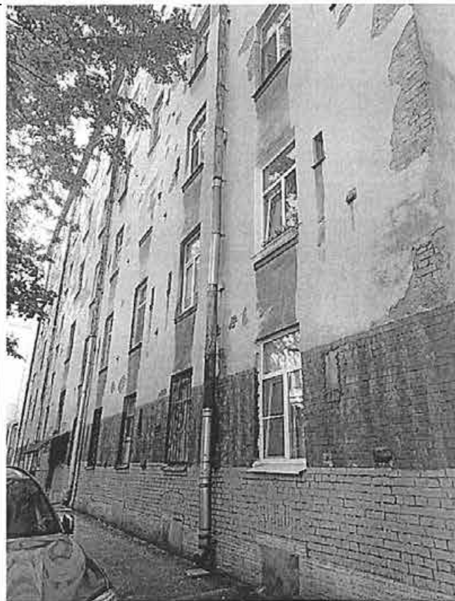
Фото 80. Фрагмент дворового фасада внешнего контура.
