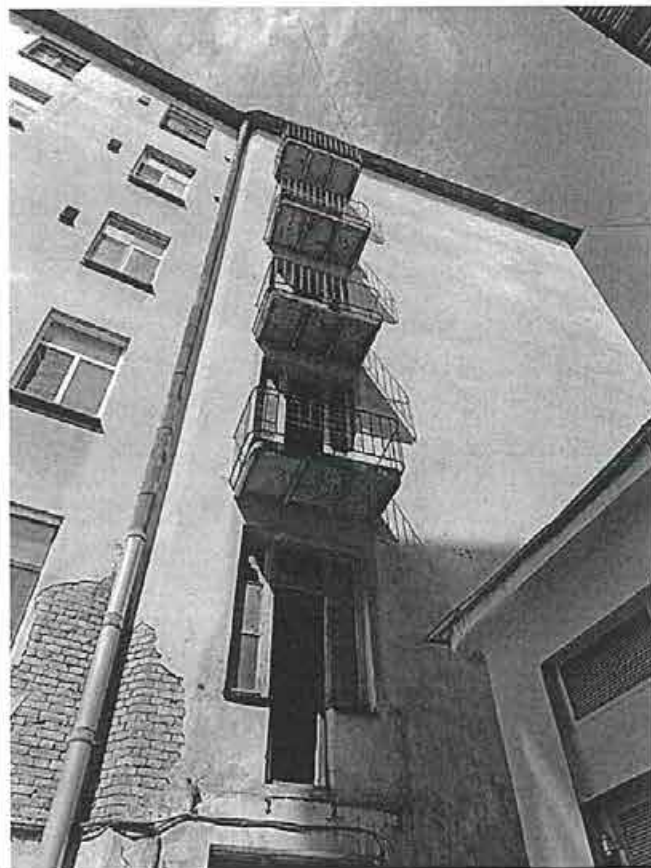
Фото 82. Фрагмент дворового фасада внешнего контура.
