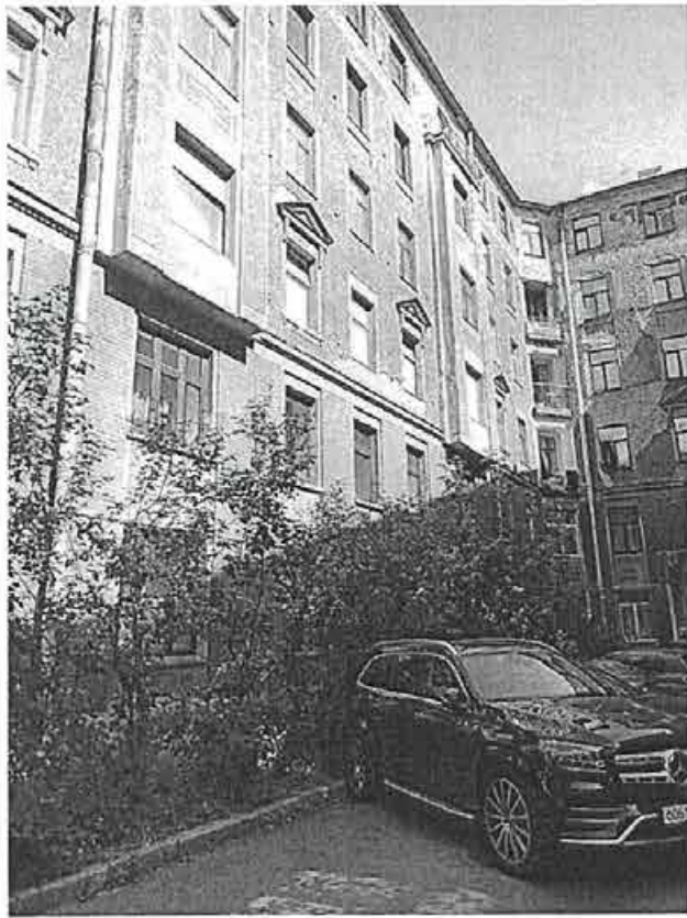
Фото 23. Дворовые фасады внутреннего двора
