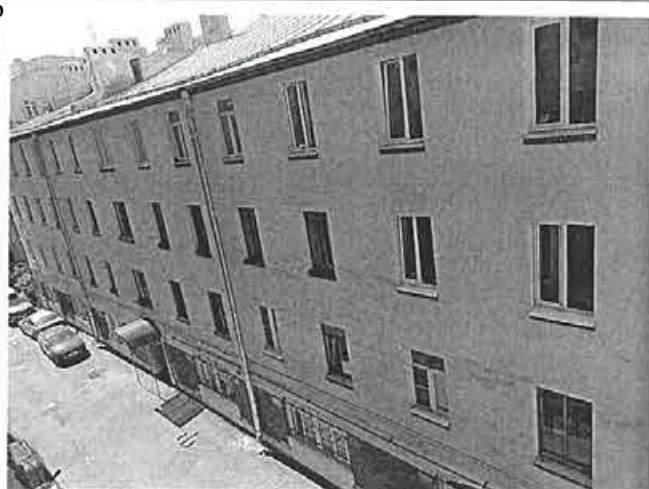
Фото 128. Фасад и кровля литера Ц.
