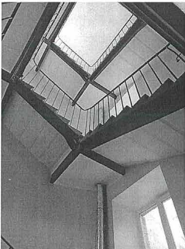
Фото 121. Литера Ц. Фрагмент внутренней лестницы.
