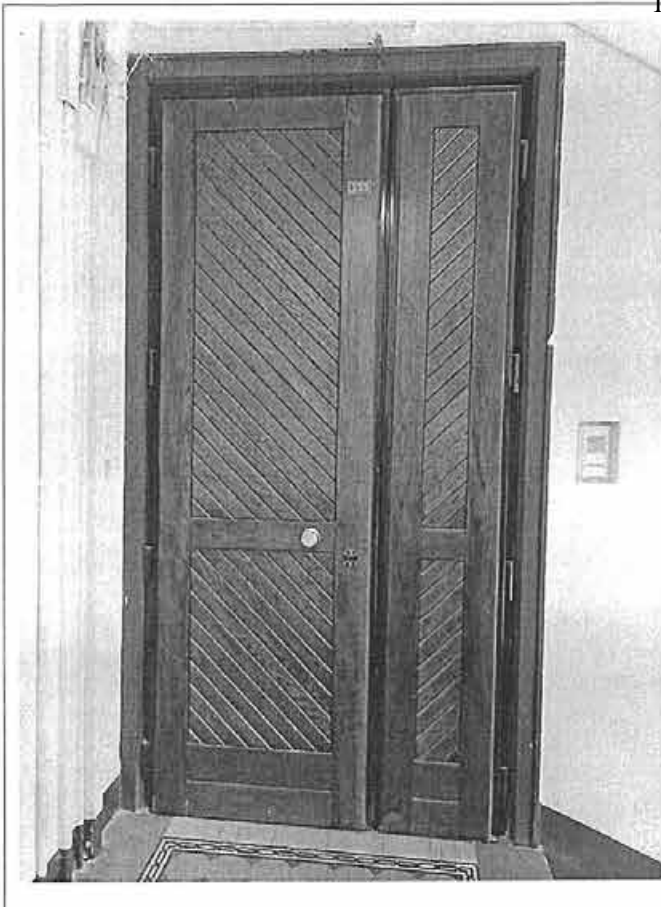
Фото 95. Дверное заполнение квартиры № 555
