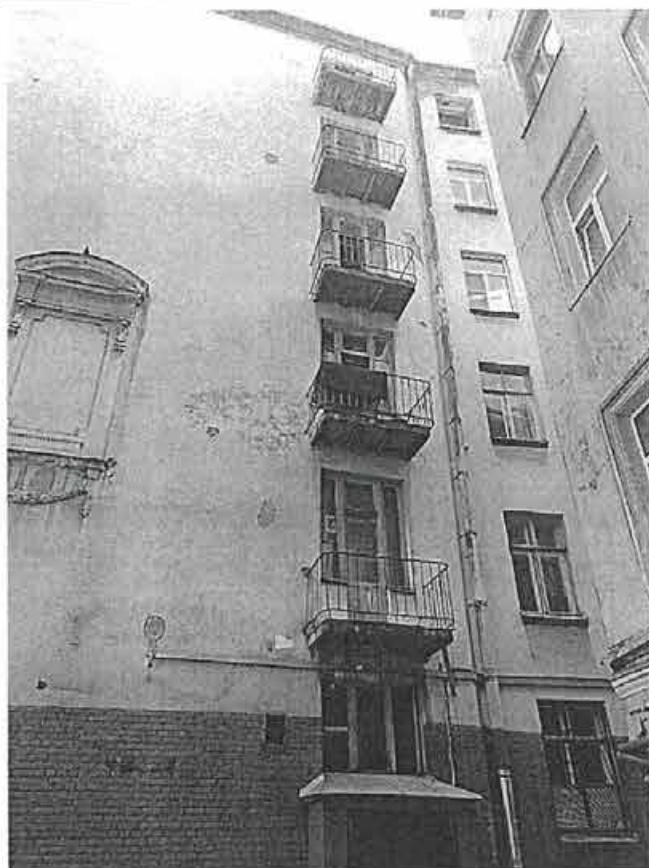
Фото 81. Фрагмент дворового фасада внешнего контура.
