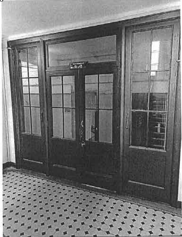
Фото 88. Дверное заполнение квартиры № 409-428
