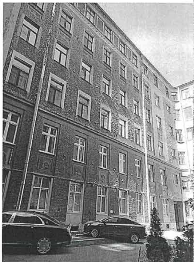
Фото 28. Дворовые фасады внутреннего двора
