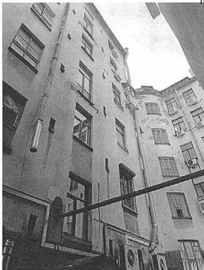
Фото 79. Фрагмент дворового фасада внешнего контура.
