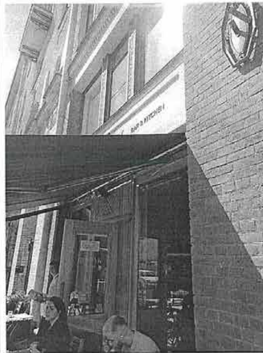
Фото 50. Выполнено устройство маркизы со стороны лицевого фасада помещения № 2-Н. Крепление маркиз помещения № 2-Н осуществляется к заполнению оконного проема.
