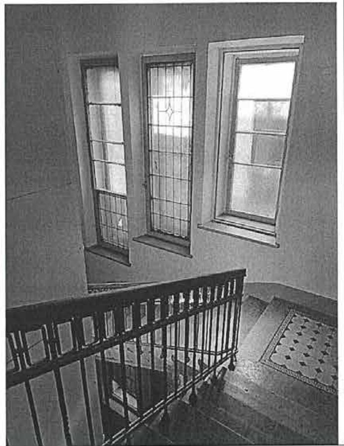
Фото 10. Парадная лестница (вход с фасада по наб. реки Фонтанки по девятой световой оси)
