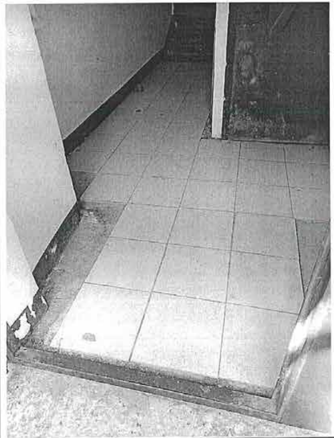
Фото 98. Площадка перед входом на первый этаж черной лестницы (где расположены квартиры №№ 109-117, 108)
