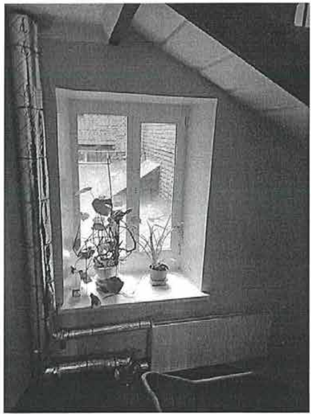
Фото 122. Литера Ц. Фрагмент внутренней лестницы.
