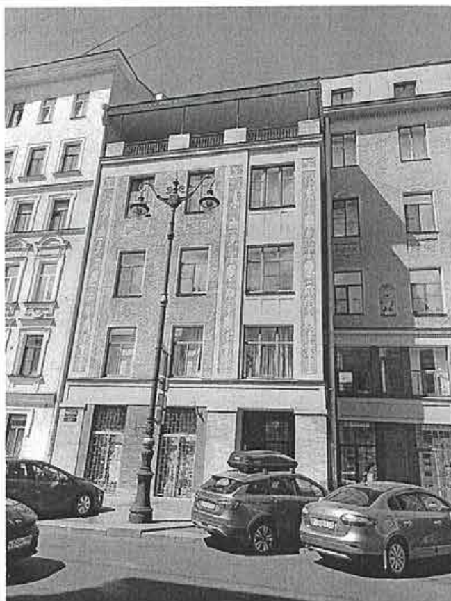
Фото 48. Фрагмент лицевого фасада со стороны Рубинштейна. Левая сторона. Над ризалитом лицевого фасада в границах квартиры № 552 устроен навес на опорах.
