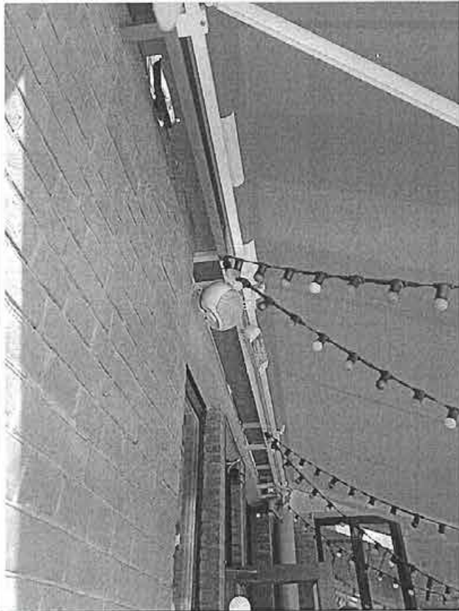
Фото 55. Выполнено устройство маркизы со стороны лицевого фасада помещения № 73-Н.
