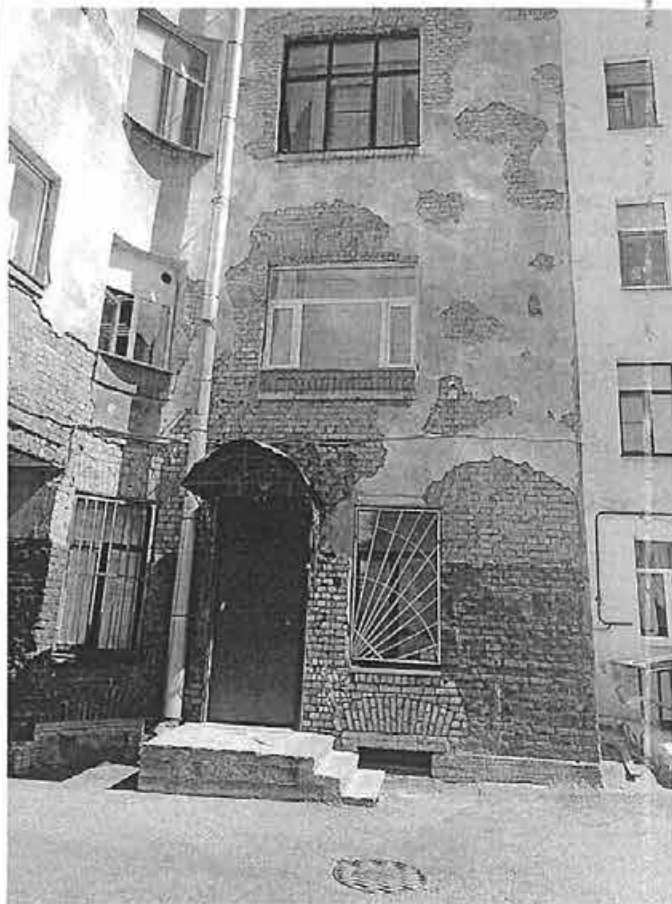
Фото 108. Фрагмент дворового фасада внешнего контура здания. В квартире № 252 выполнена закладка кирпичом нижней части двух оконных проемов
