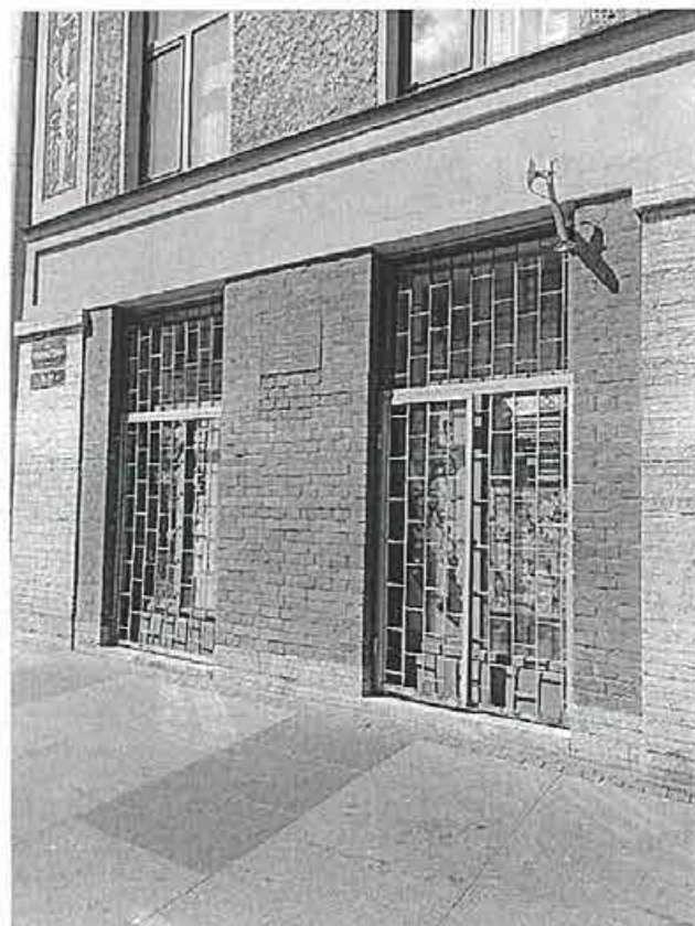
Фото 42. Фрагмент лицевого фасада со стороны Рубинштейна, оконные проемы помещения 4-Н. Решетки в оконных проемах
