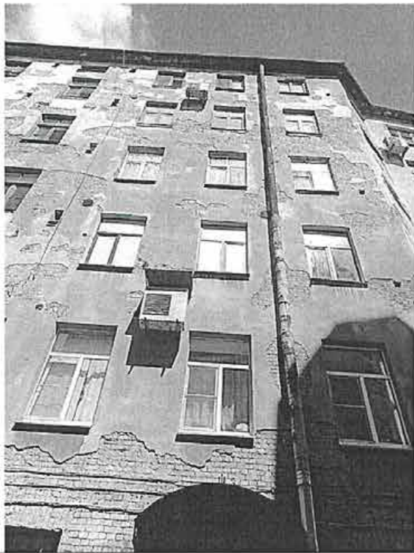
Фото 63. Фрагмент дворового фасада внешнего контура. Ненадлежащее состояние штукатурной отделки фасадов.
