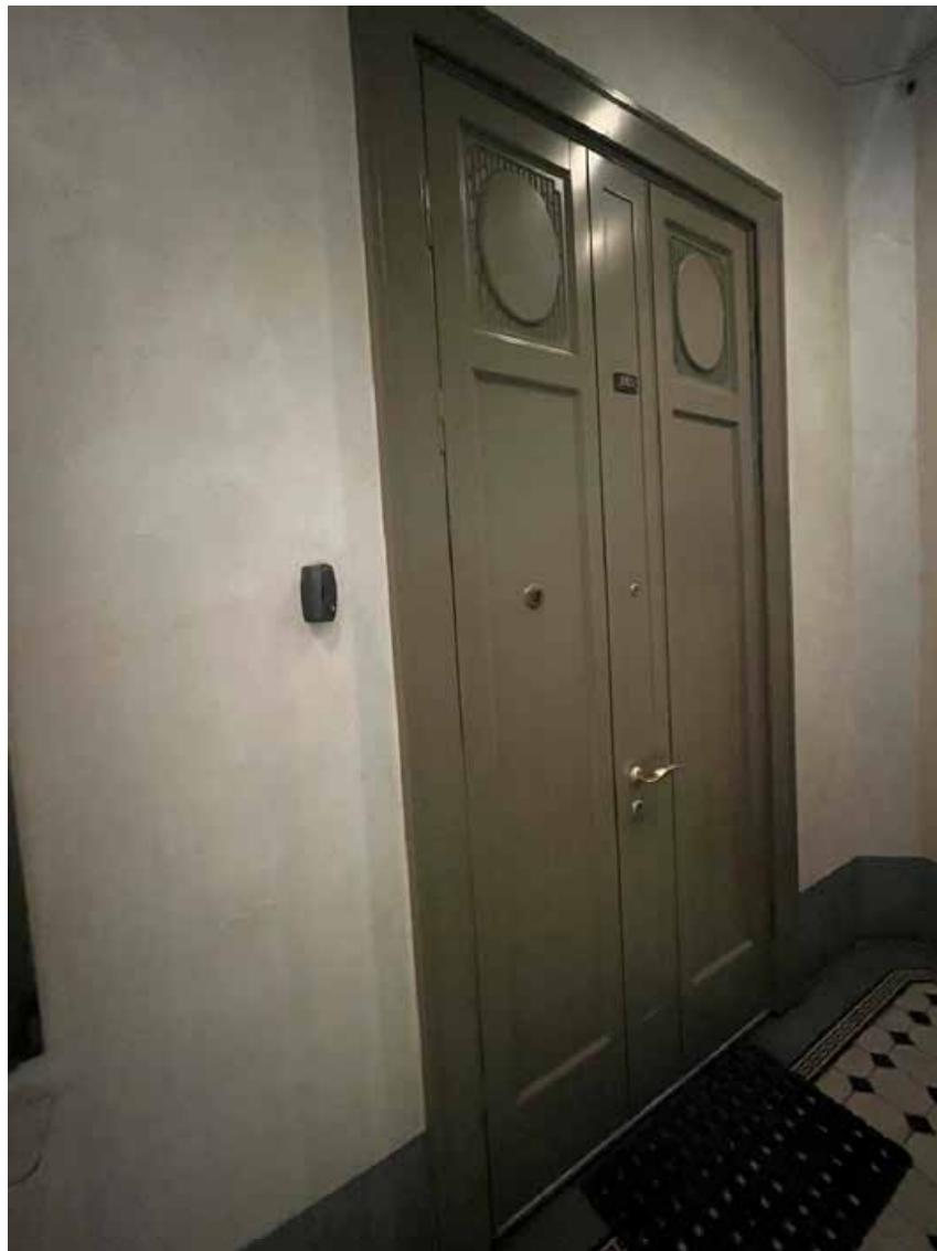
Фото №25. Лестничная площадка второго этажа, вход в квартиру №263 (дверное заполнение).
