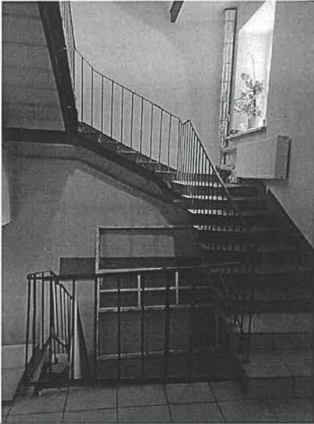
Фото 123. Литера Ц. Фрагмент внутренней лестницы.
