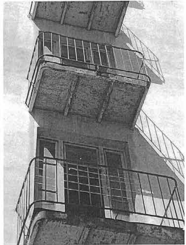
Фото 116. Фрагмент дворового фасада внешнего контура здания. Балконы
