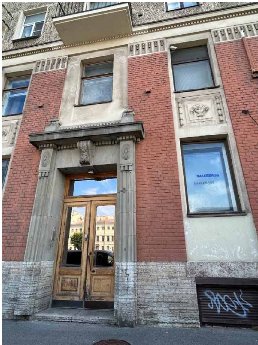
Фото №2. Лицевой фасад по наб. р. Фонтанки, парадный вход.
