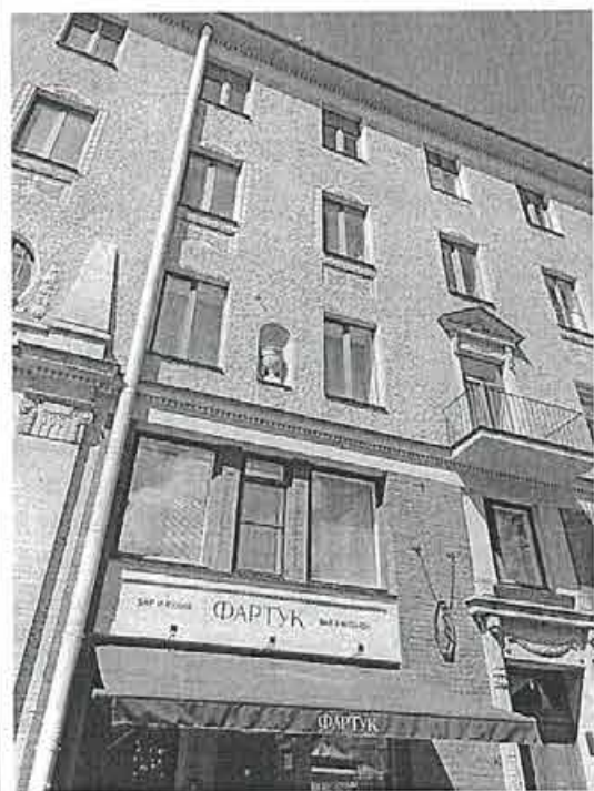
Фото 49. Фрагмент лицевого фасада со стороны Рубинштейна. Правая сторона. Выполнено устройство маркизы со стороны лицевого фасада помещения № 2-Н
