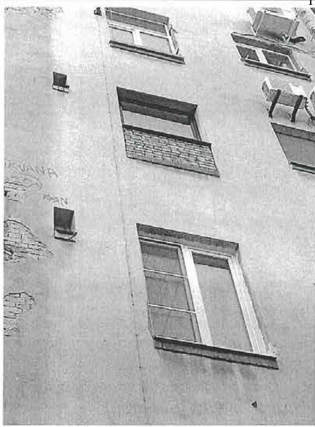
Фото 119. Фрагмент дворового фасада внешнего контура здания. Закладка нижней части оконного проема квартиры № 405
