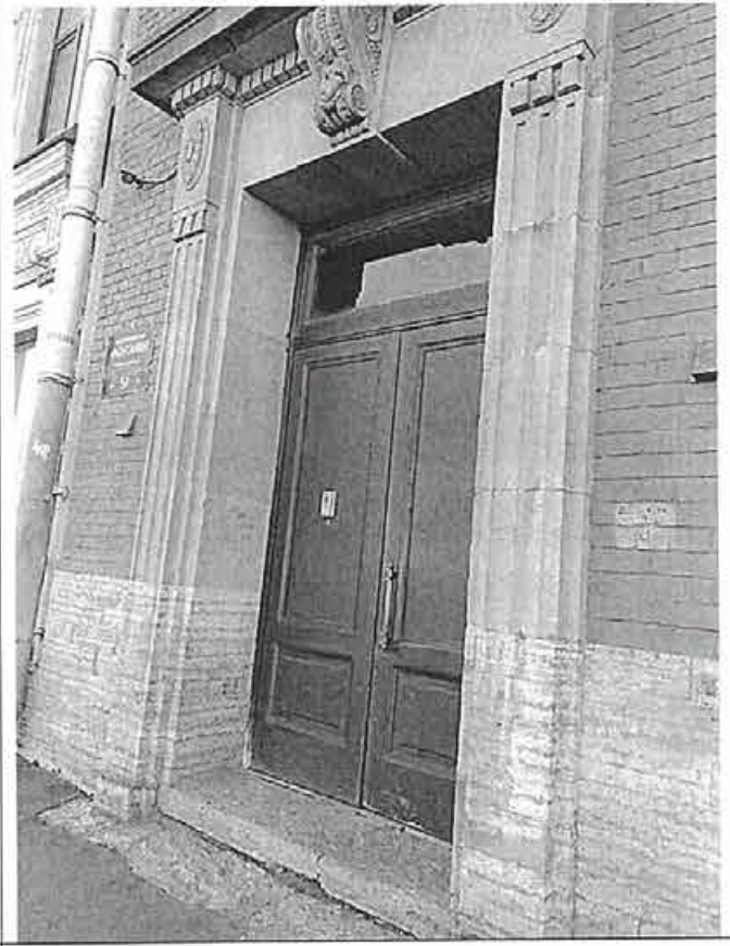
Фото 4. Фрагмент лицевого фасада по наб. реки Фонтанки. Первая световая ось.
