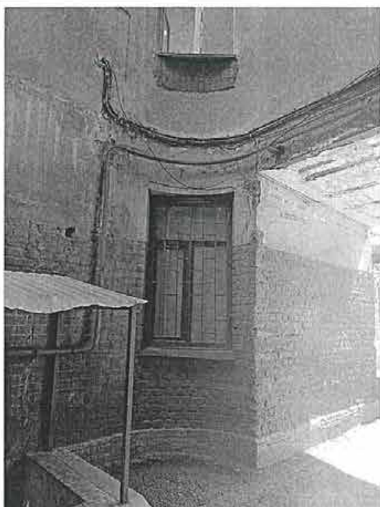
Фото 109. Фрагмент дворового фасада внешнего контура здания. В квартире № 252 выполнена закладка кирпичом нижней части
