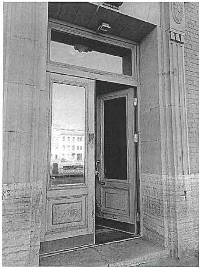
Фото 13. Фрагмент лицевого фасада по наб. реки Фонтанки. Девятая световая ось, вход в парадную
