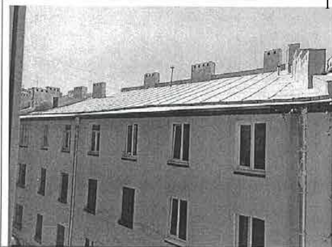
Фото 127. Фасад и кровля литера Ц.
