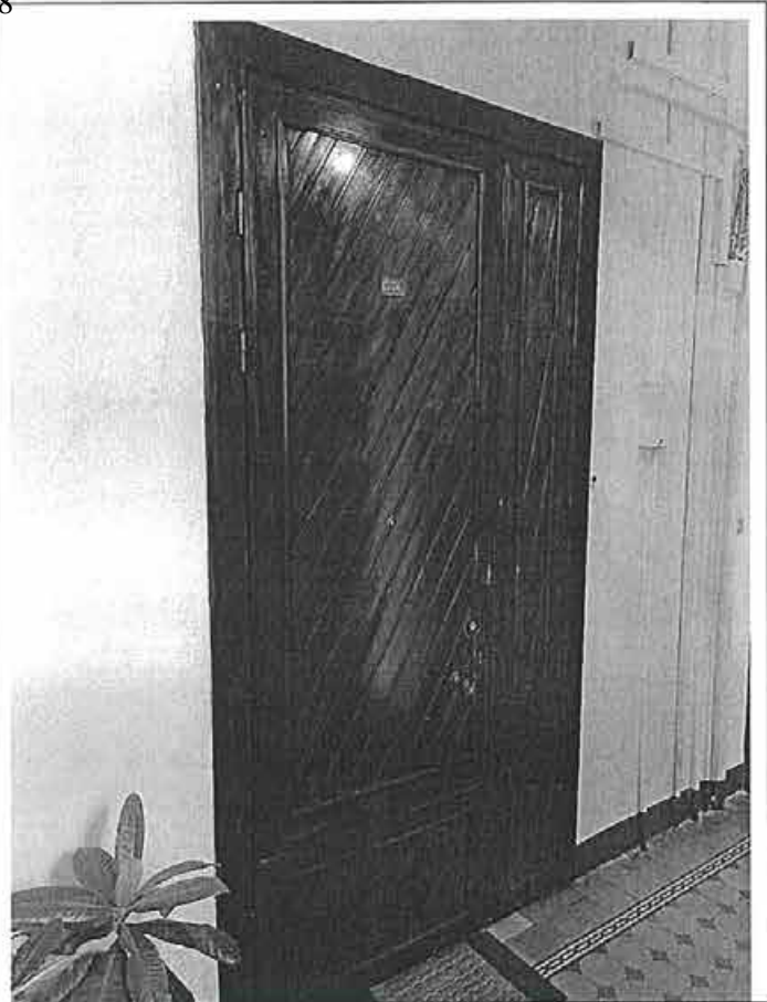
Фото 96. Дверное заполнение квартиры № 556
