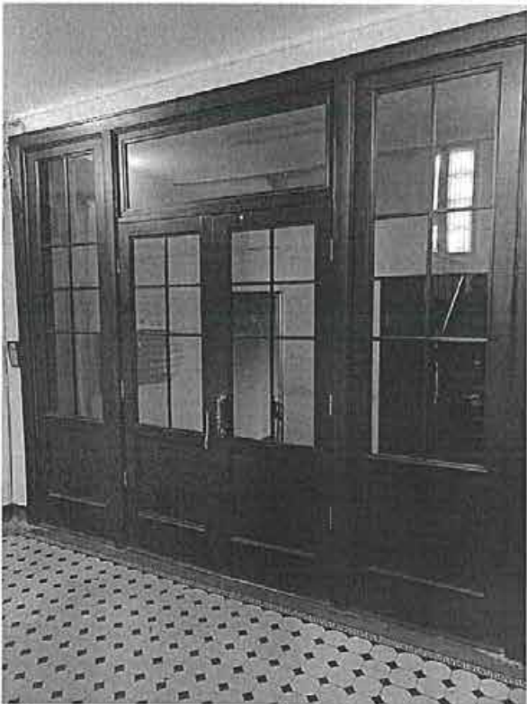
Фото 85. Дверное заполнение квартиры № 209-228
