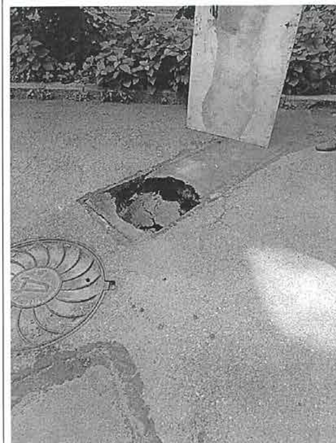
Фото 35. Дворовая территория около 9 парадной
