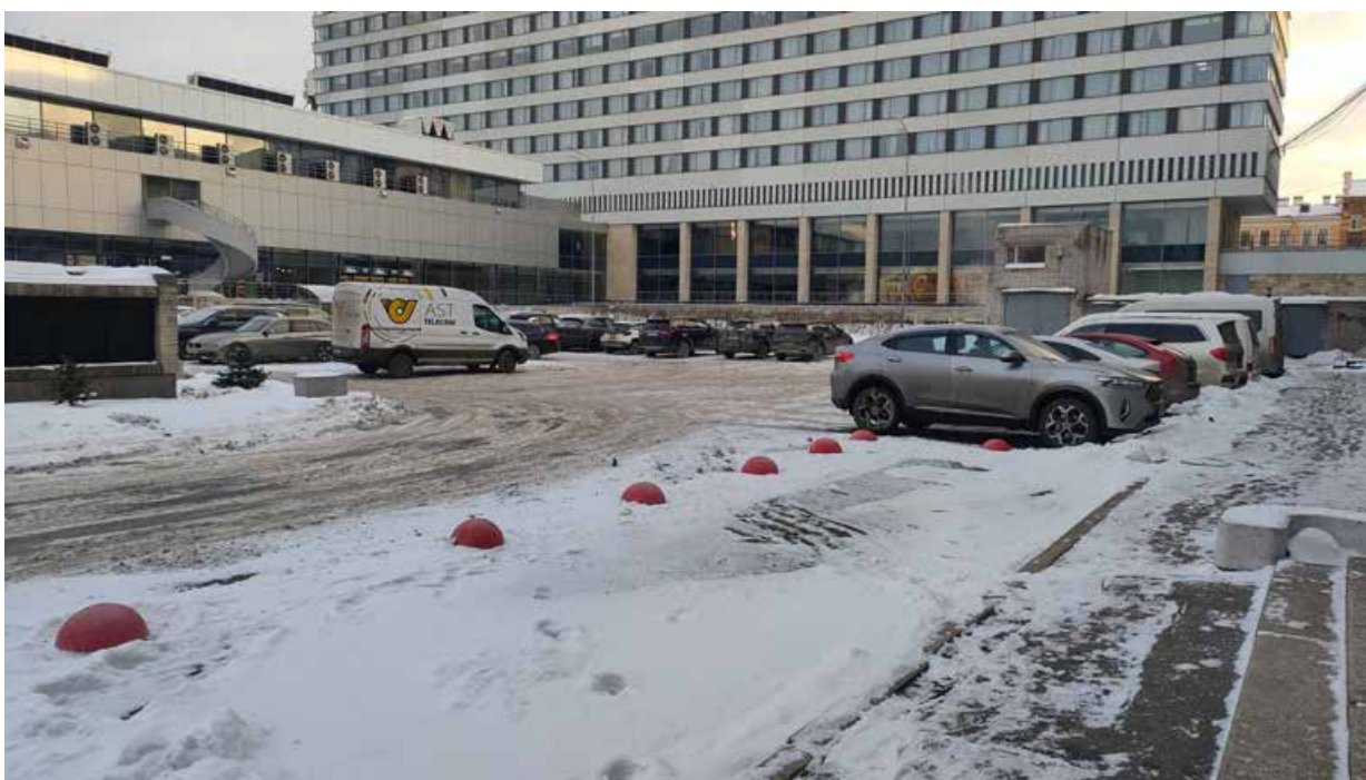
Точка фотофиксации 1. Общий вид на территорию обследования с СЗ.
