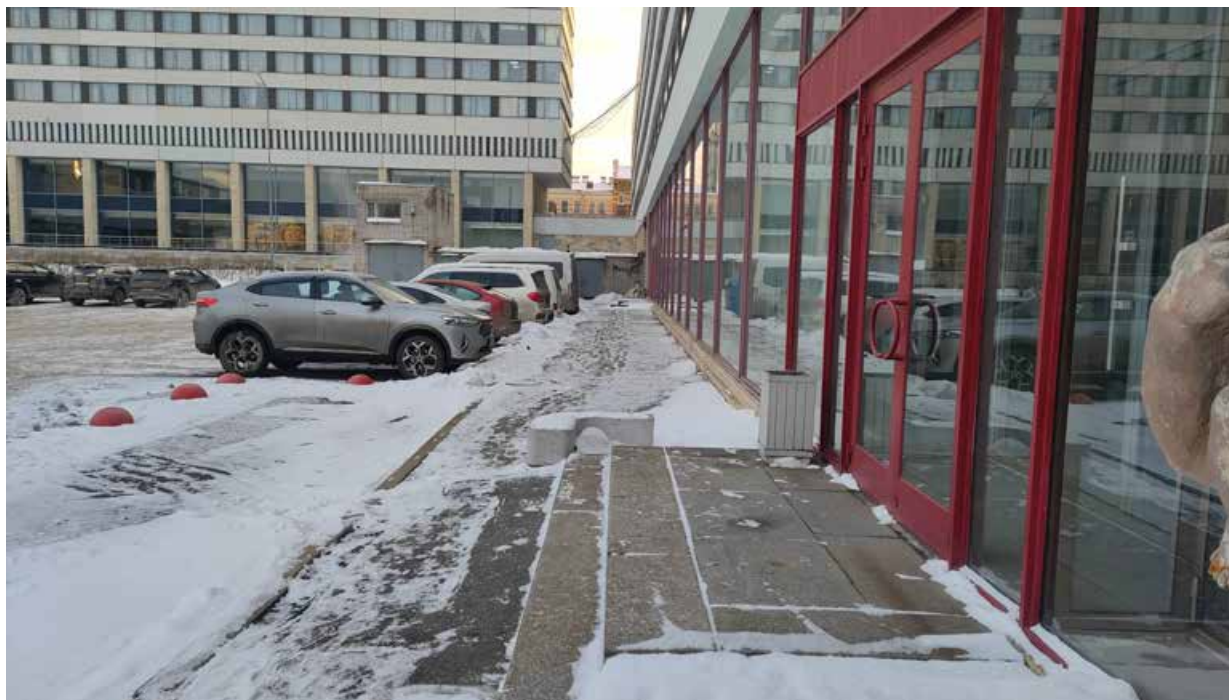
Точка фотофиксации 1. Общий вид на территорию обследования с С.
