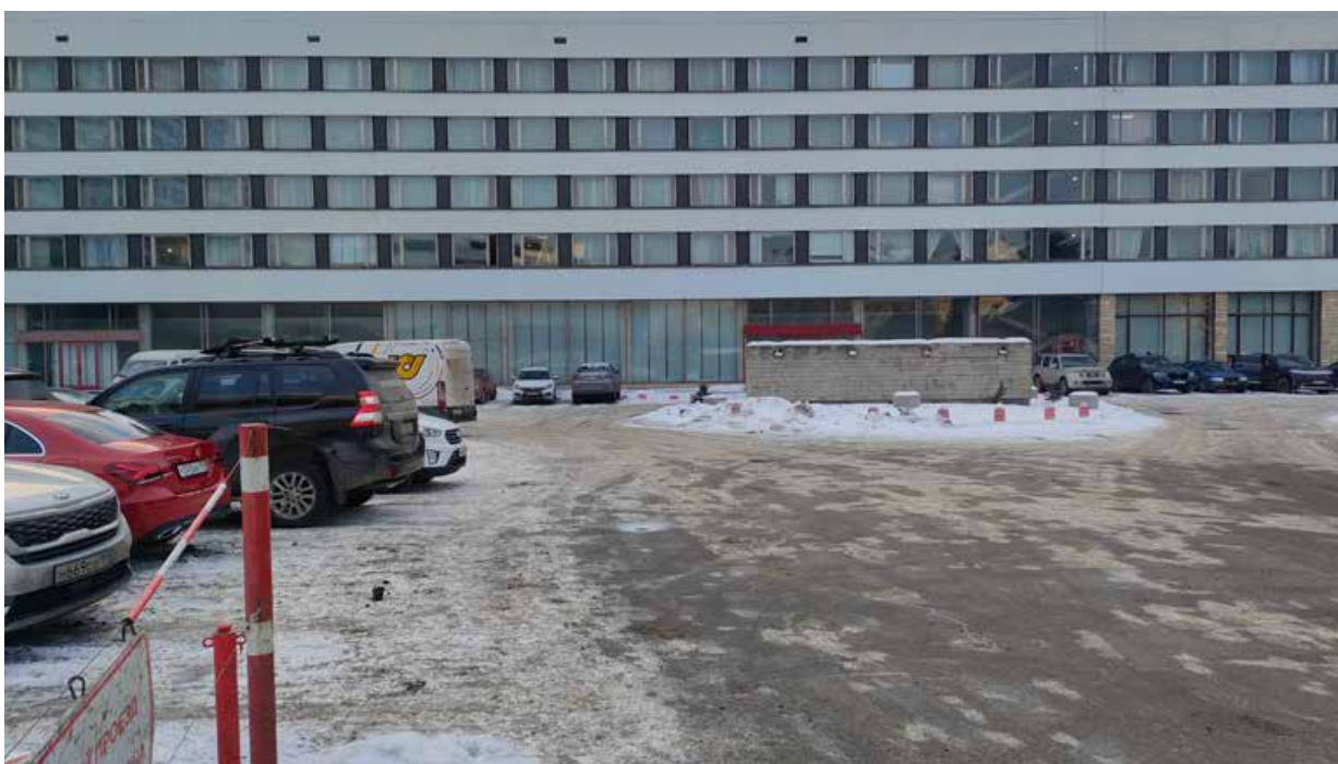
Точка фотофиксации 4. Общий вид на территорию обследования с В.
