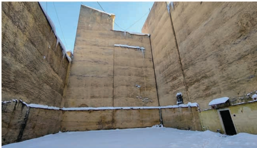
2. Вид на брандмауэрные стены здания
