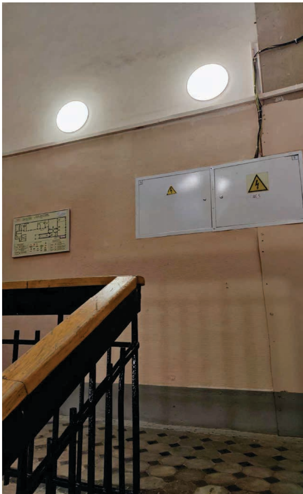
3. Вид на лестничную клетку
