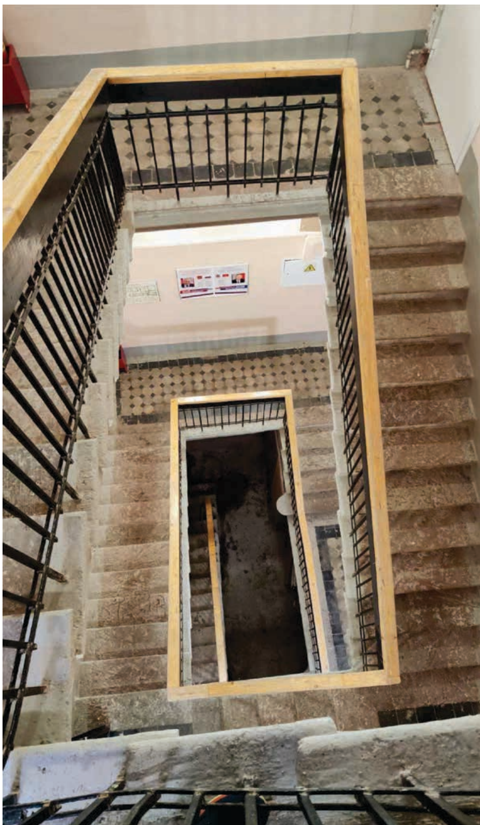
4. Вид на лестничную клетку
