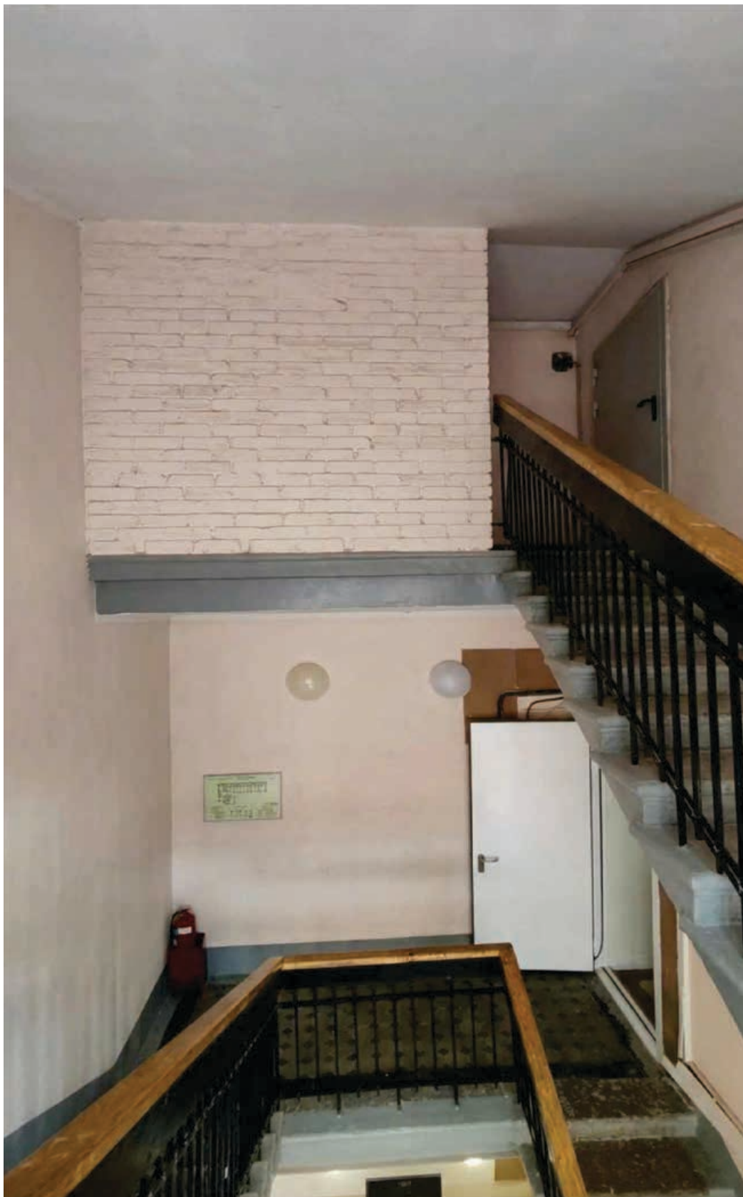
5. Вид на лестничную клетку
