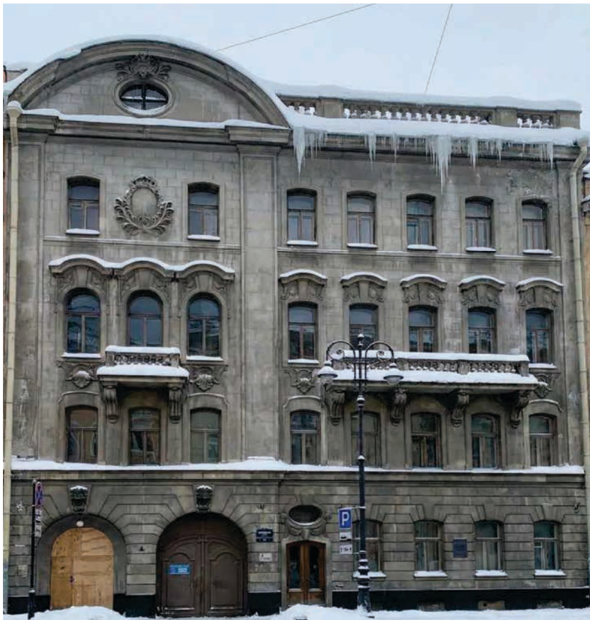
1. Вид на лицевой фасад здания №15
