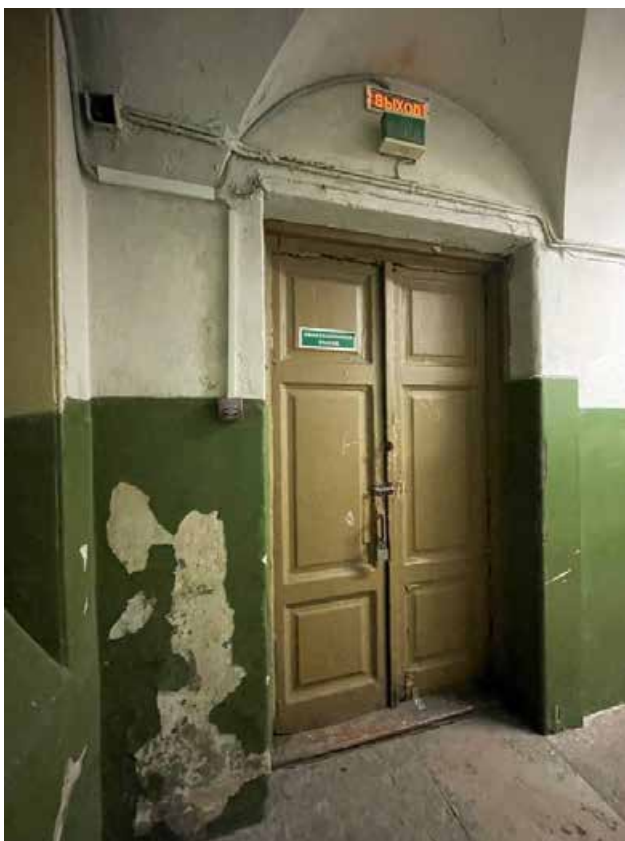
Фото 19. Интерьер 1 этажа объекта культурного наследия федерального значения «Академия», входящего в состав объекта культурного наследия федерального значения «Российская Академия»
