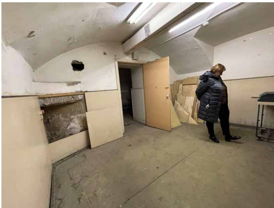
Фото 181. Интерьер подвального этажа объекта культурного наследия федерального значения «Академия», входящего в состав объекта культурного наследия федерального значения «Российская Академия»
