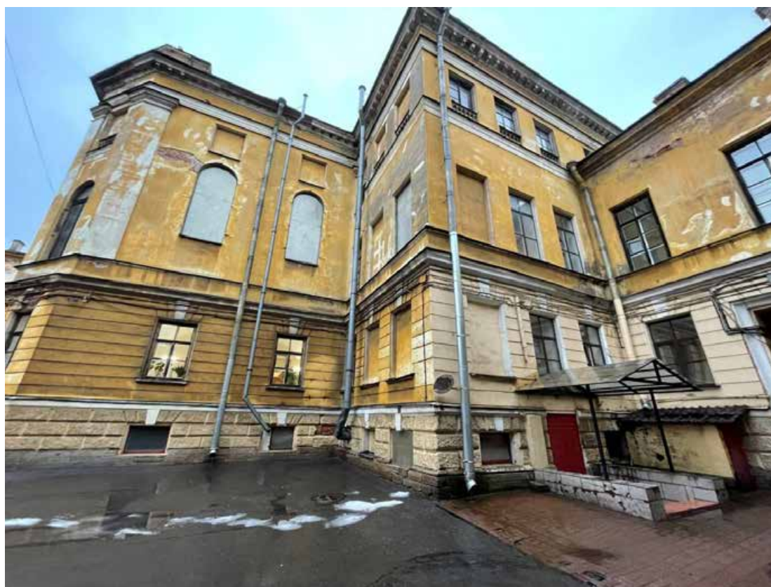
Фото 14. Фрагмент дворового фасада объекта культурного наследия федерального значения «Академия», входящего в состав объекта культурного наследия федерального значения «Российская Академия»
