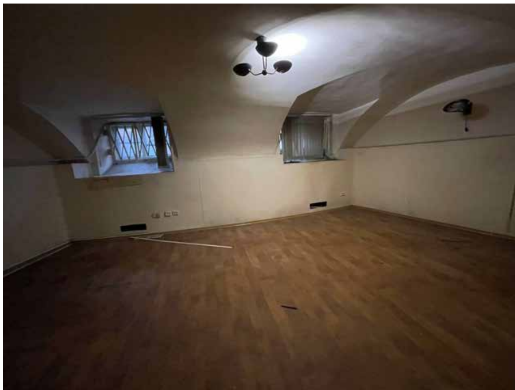
Фото 207. Интерьер подвального этажа объекта культурного наследия федерального значения «Академия», входящего в состав объекта культурного наследия федерального значения «Российская Академия»
