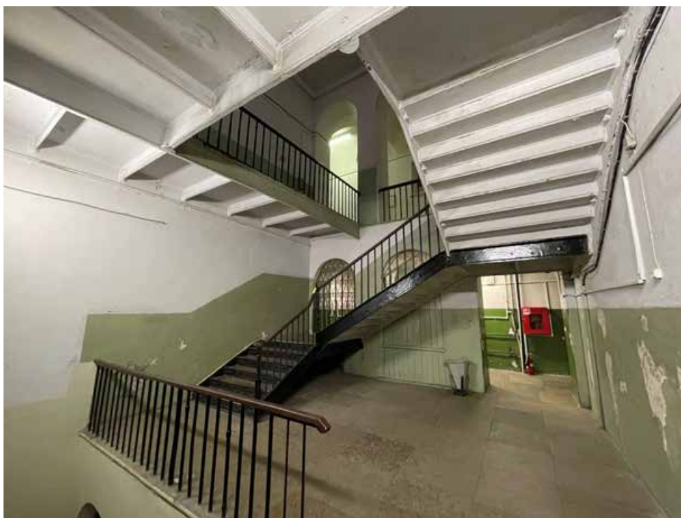
Фото 31. Интерьер 1 этажа объекта культурного наследия федерального значения «Академия», входящего в состав объекта культурного наследия федерального значения «Российская Академия»
