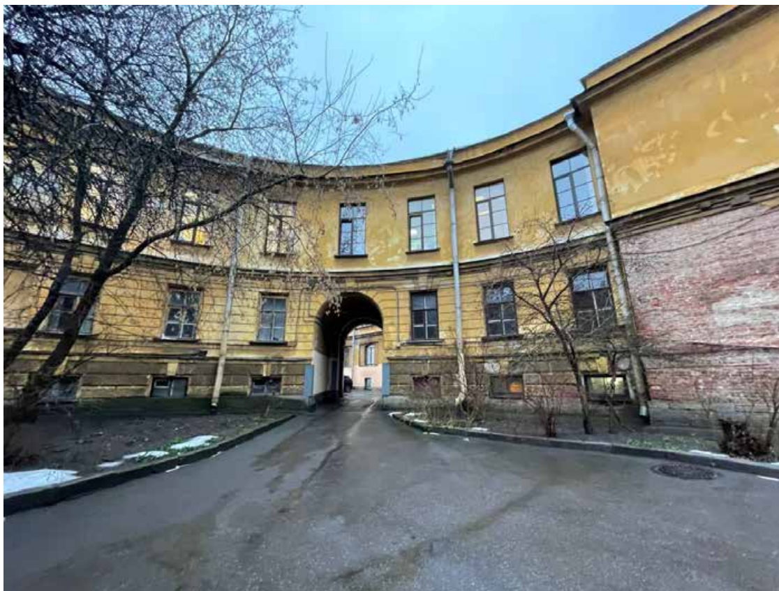
Фото 9. Фрагмент дворового фасада объекта культурного наследия федерального значения «Академия», входящего в состав объекта культурного наследия федерального значения «Российская Академия»
