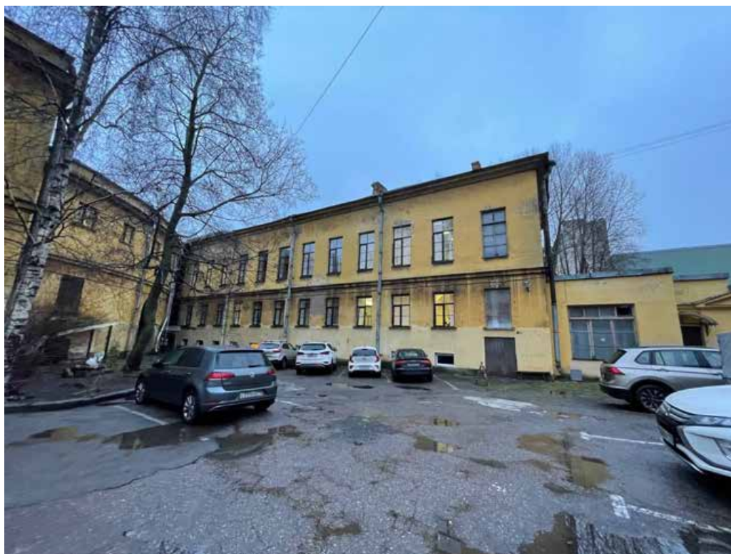
Фото 4. Фрагмент дворового фасада объекта культурного наследия федерального значения «Академия», входящего в состав объекта культурного наследия федерального значения «Российская Академия»
