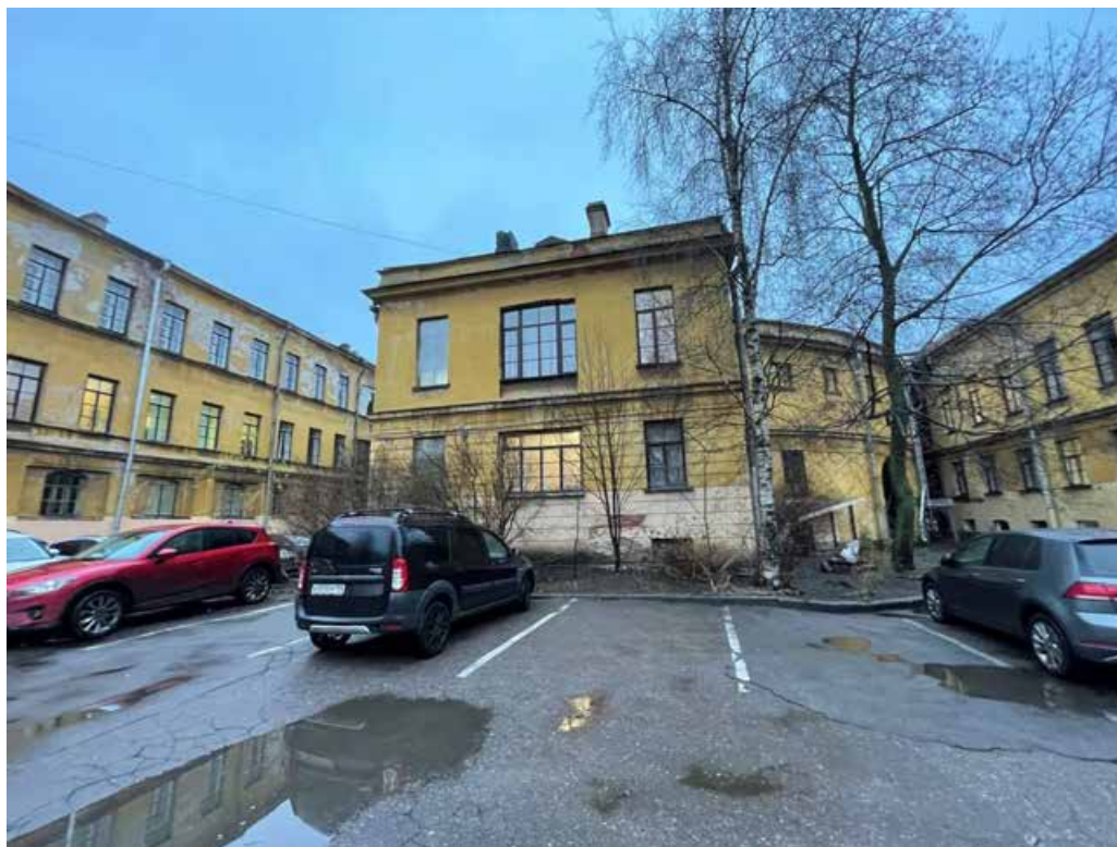
Фото 5. Фрагмент дворового фасада объекта культурного наследия федерального значения «Академия», входящего в состав объекта культурного наследия федерального значения «Российская Академия»
