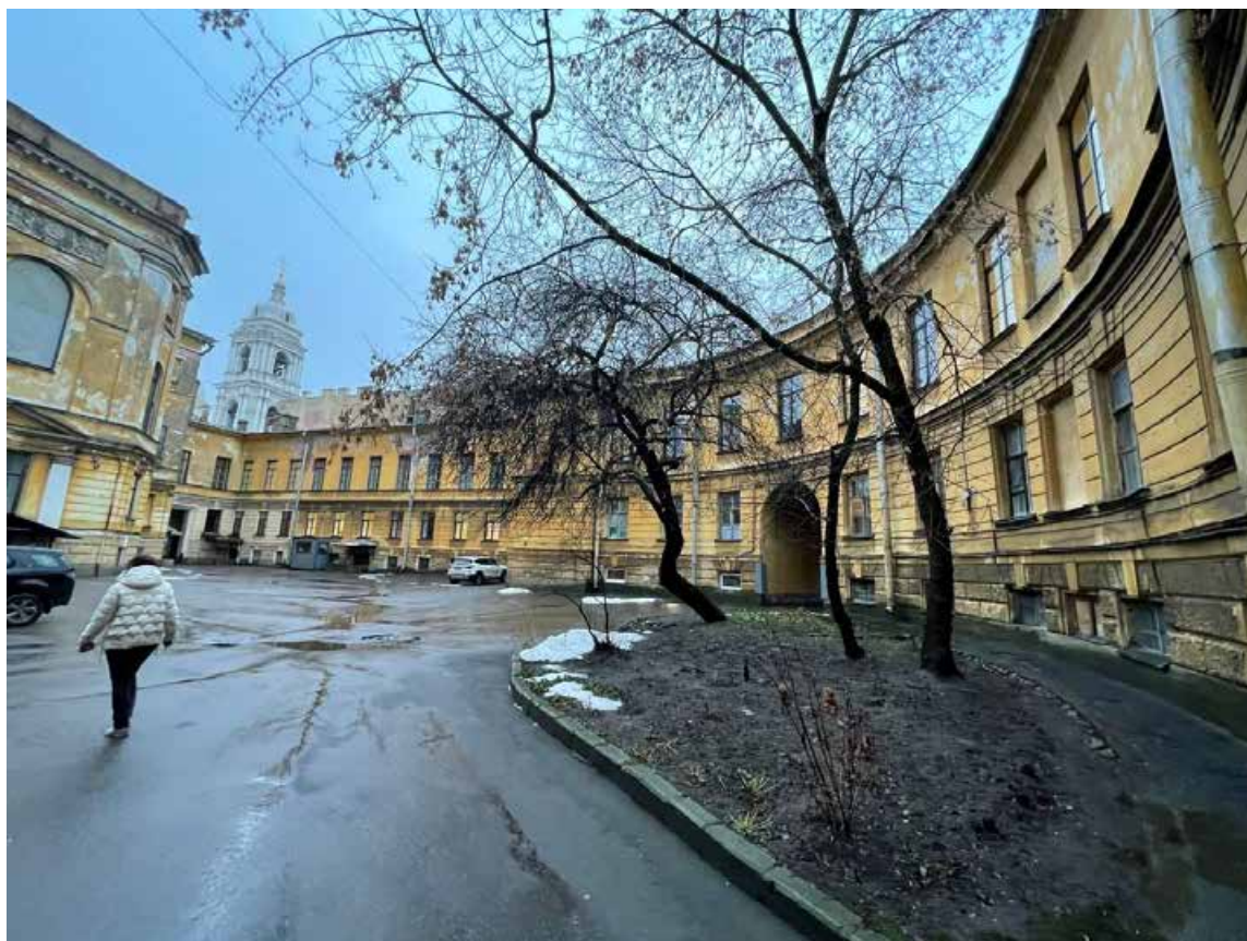
Фото 6. Фрагмент дворового фасада объекта культурного наследия федерального значения «Академия», входящего в состав объекта культурного наследия федерального значения «Российская Академия»
