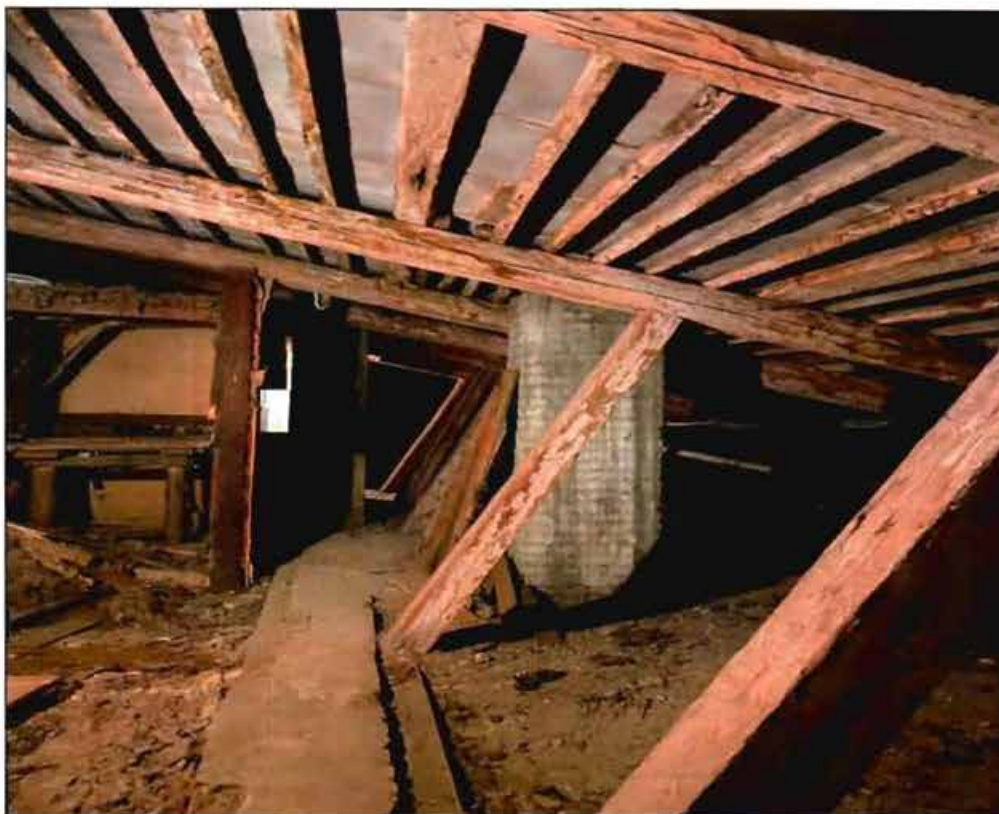
21. Стропильная система. Фото от 16.05.2022 г.
