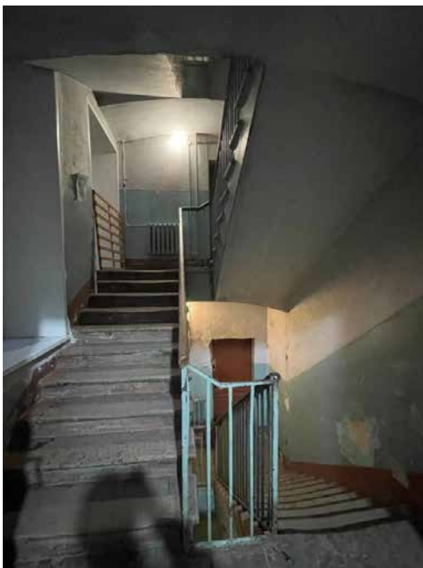
Фото 39. Интерьер 2 этажа объекта культурного наследия федерального значения «Академия», входящего в состав объекта культурного наследия федерального значения «Российская Академия»
