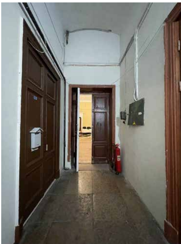
Фото 38. Интерьер 2 этажа объекта культурного наследия федерального значения «Академия», входящего в состав объекта культурного наследия федерального значения «Российская Академия»
