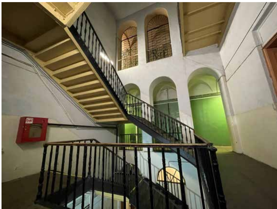
Фото 91. Интерьер 2 этажа объекта культурного наследия федерального значения «Академия», входящего в состав объекта культурного наследия федерального значения «Российская Академия»
