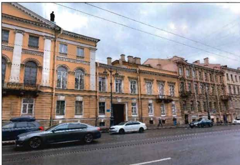
2. Общий вид на лицевой фасад объекта культурного наследия с 1-й линии В.О. Фото от 16.05.2022 г.
