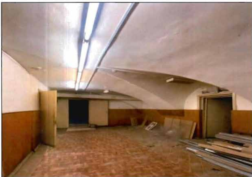
18. Помещения цокольного этажа. Фото от 18.02.2022 г.
