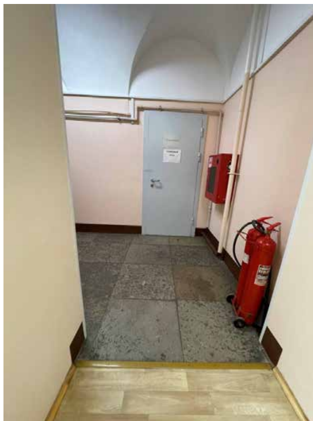
Фото 140. Интерьер 1 этажа объекта культурного наследия федерального значения «Академия», входящего в состав объекта культурного наследия федерального значения «Российская Академия»
