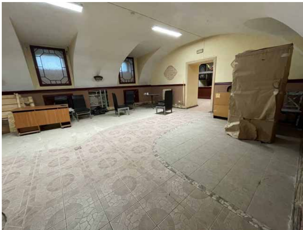
Фото 187. Интерьер подвального этажа объекта культурного наследия федерального значения «Академия», входящего в состав объекта культурного наследия федерального значения «Российская Академия»
