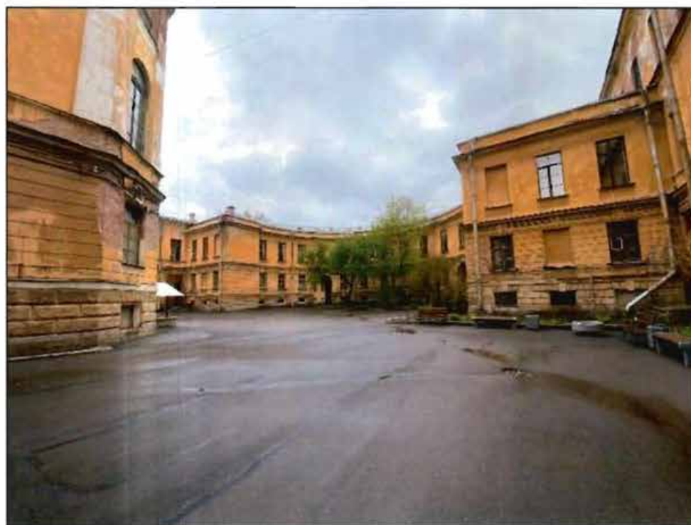
6. Дворовые фасады и территория объекта культурного наследия. Фото от 16.05.2022 г.
