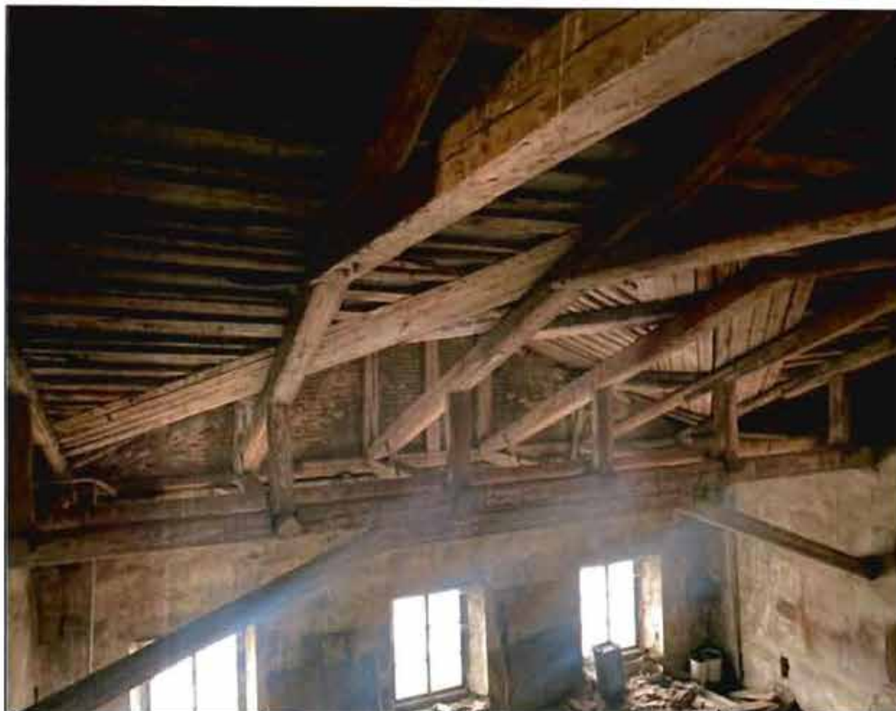
19. Стропильная система. Фото от 18.02.2022 г.
