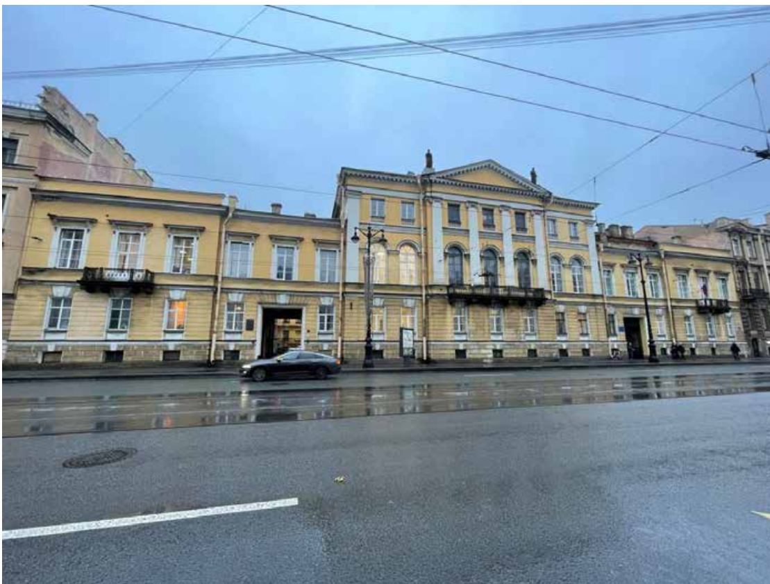
Фото 1. Лицевой фасад объекта культурного наследия федерального значения «Академия», входящего в состав объекта культурного наследия федерального значения «Российская Академия»
