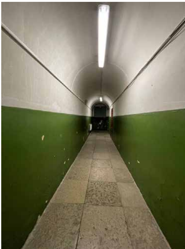
Фото 21. Интерьер 1 этажа объекта культурного наследия федерального значения «Академия», входящего в состав объекта культурного наследия федерального значения «Российская Академия»
