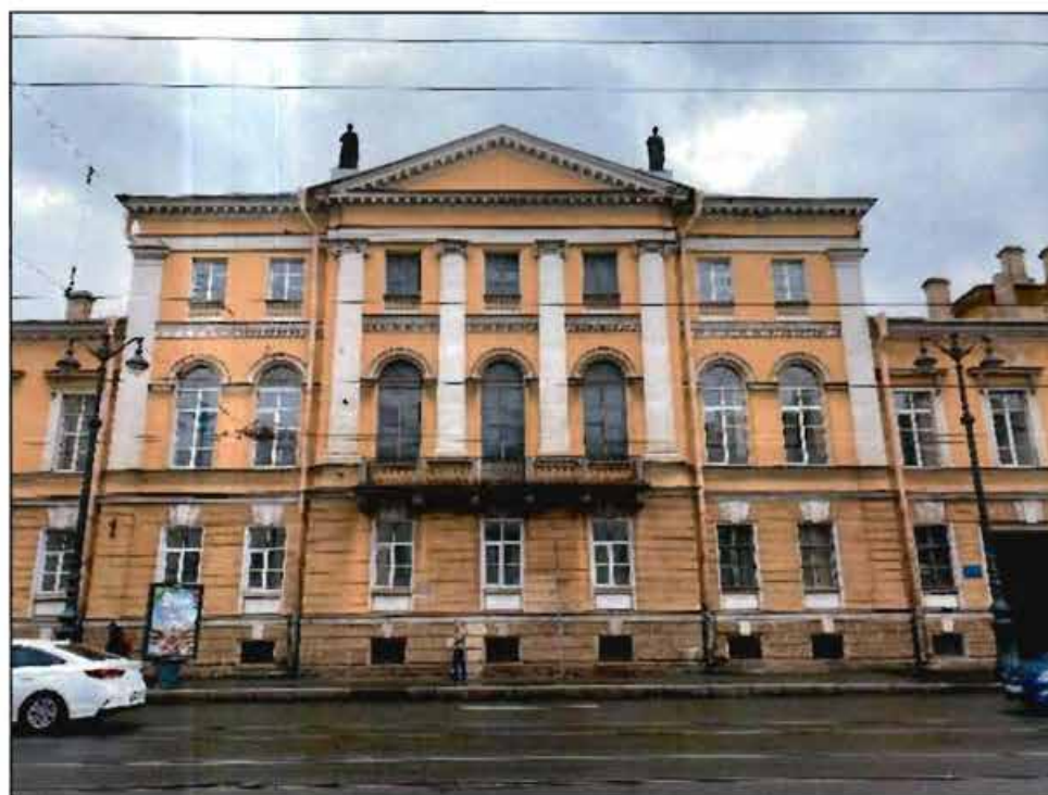
4. Общий вид на центральный корпус лицевого фасада объекта культурного наследия с 1-й линии В.О. Фото от 16.05.2022 г.
