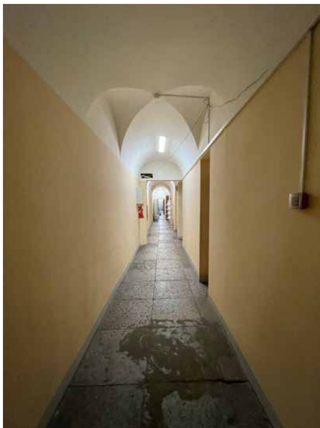
Фото 85. Интерьер 1 этажа объекта культурного наследия федерального значения «Академия», входящего в состав объекта культурного наследия федерального значения «Российская Академия»
