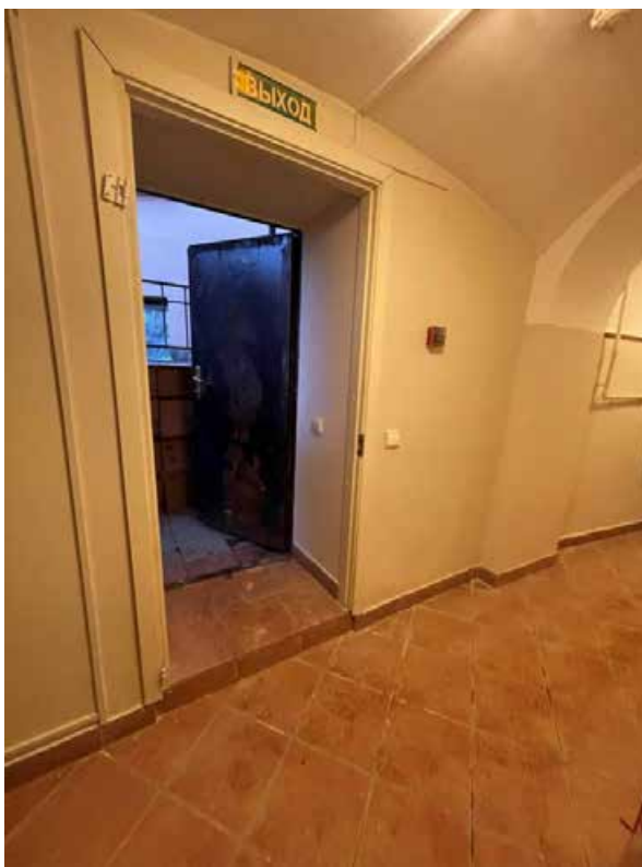
Фото 211. Интерьер подвального этажа объекта культурного наследия федерального значения «Академия», входящего в состав объекта культурного наследия федерального значения «Российская Академия»
