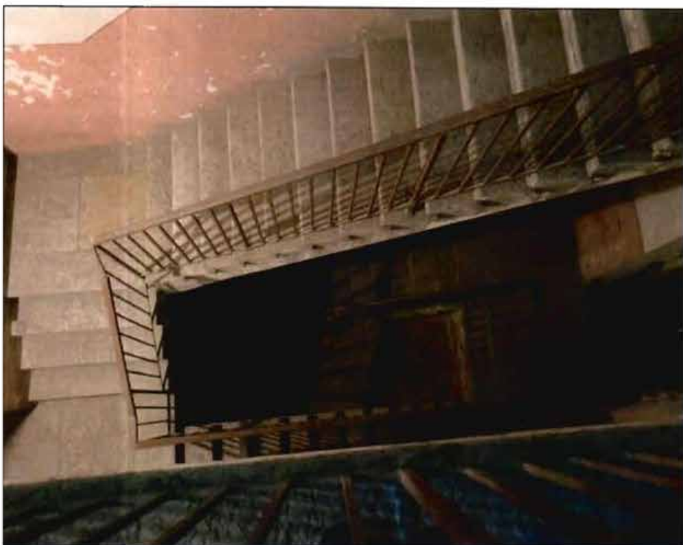
17. Трехмаршевая каменная лестница по косоурам северного (пом. 25-Н (68)) бокового флигеля. Фото от 18.02.2022 г.
