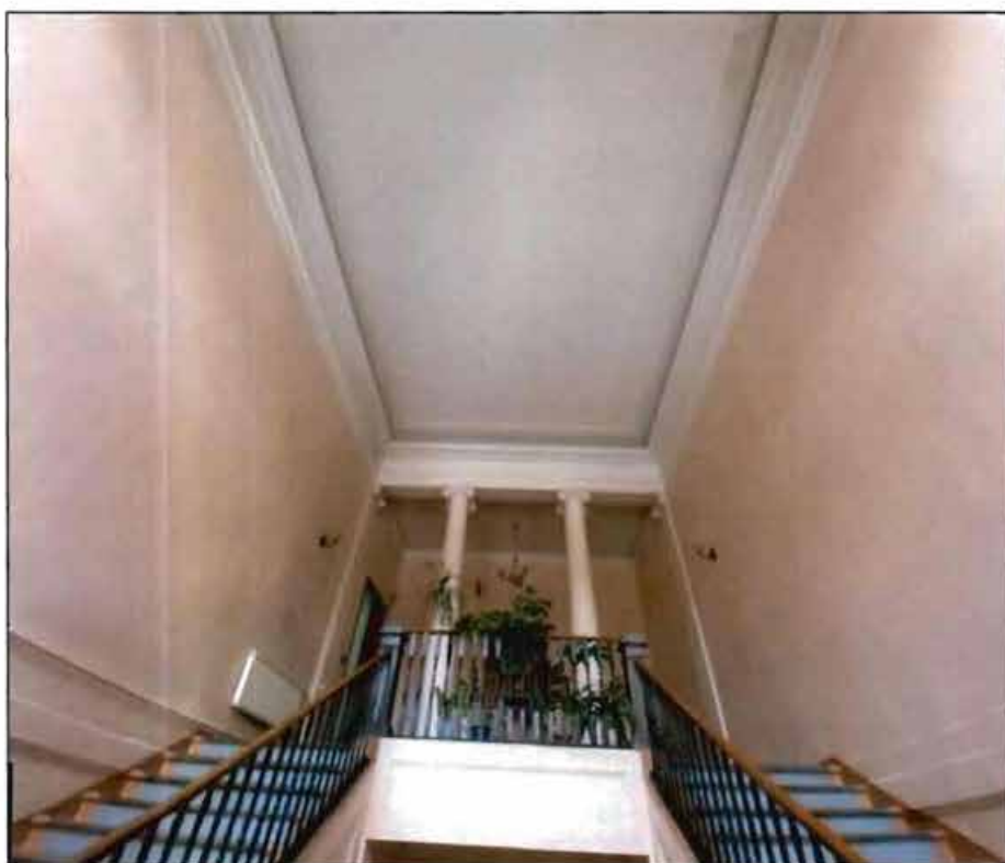
14. Холл главной лестницы (пом. 25-Н (88)) в уровне 2-го этажа. Фото от 18.02.2022 г.
