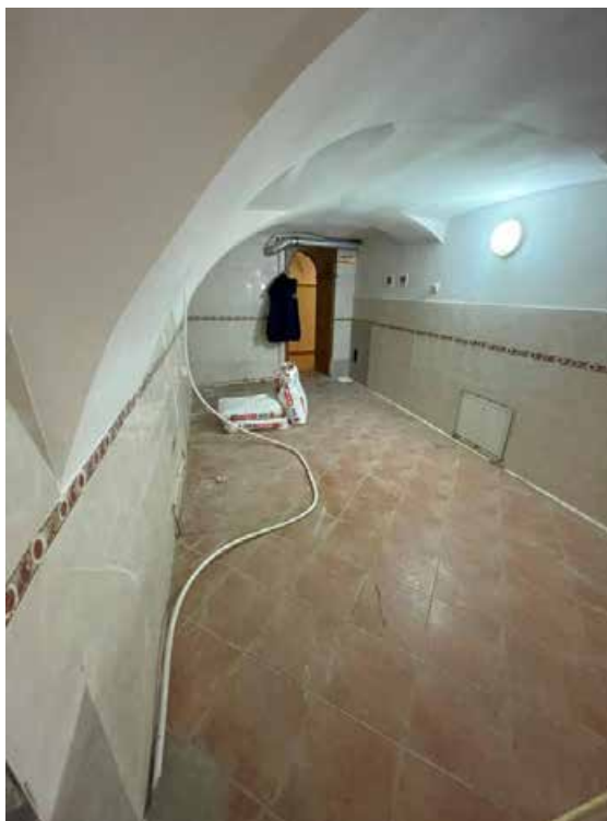
Фото 212. Интерьер подвального этажа объекта культурного наследия федерального значения «Академия», входящего в состав объекта культурного наследия федерального значения «Российская Академия»
