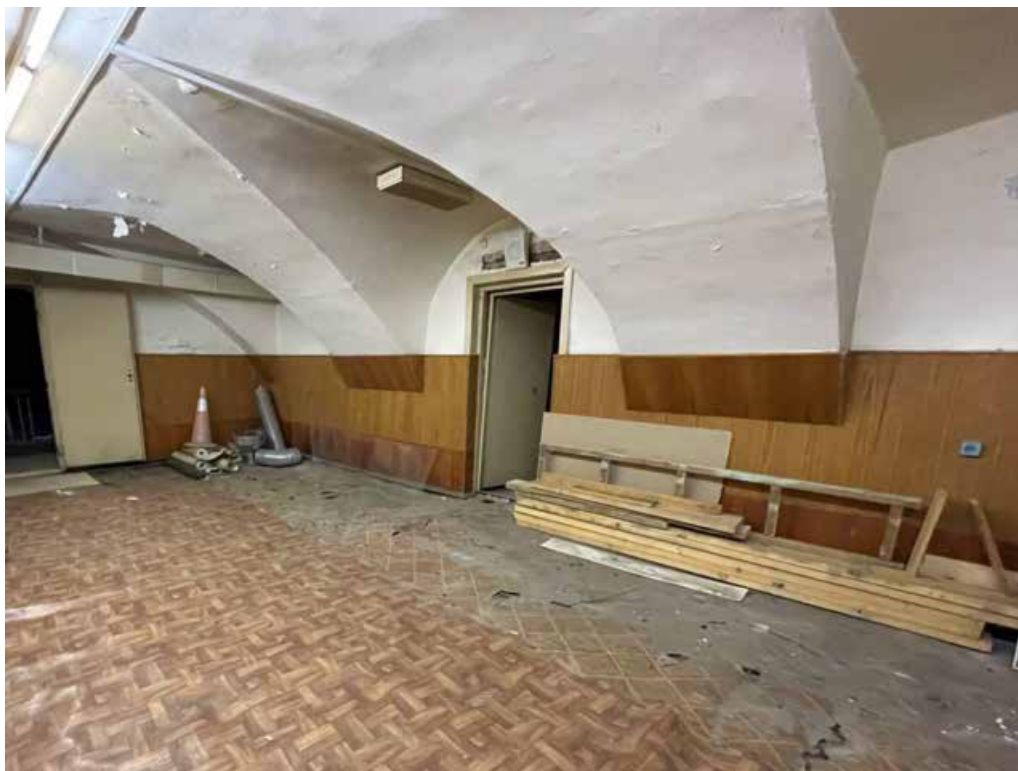
Фото 179. Интерьер подвального этажа объекта культурного наследия федерального значения «Академия», входящего в состав объекта культурного наследия федерального значения «Российская Академия»
