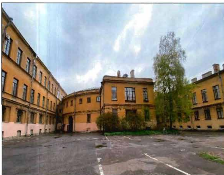
10. Общий вид на дворовые фасады объекта культурного наследия с южной части территории. Фото от 16.05.2022 г.
