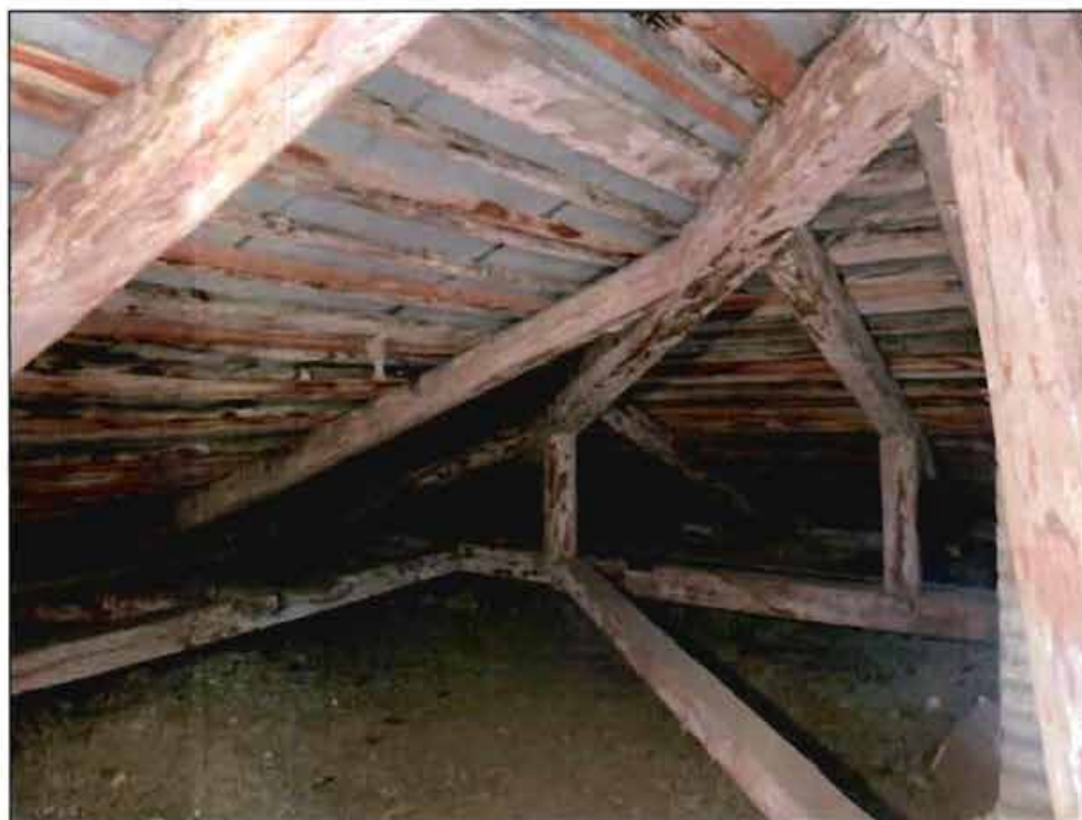
20. Стропильная система. Фото от 18.02.2022 г.
