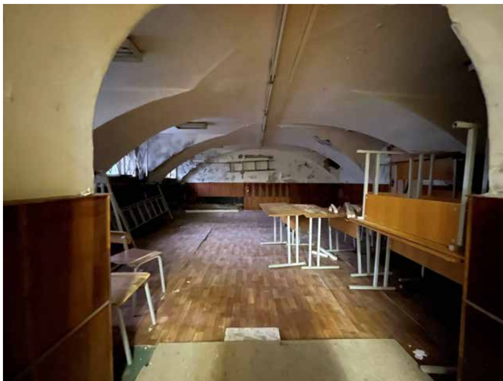
Фото 182. Интерьер подвального этажа объекта культурного наследия федерального значения «Академия», входящего в состав объекта культурного наследия федерального значения «Российская Академия»
