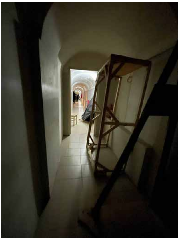
Фото 199. Интерьер подвального этажа объекта культурного наследия федерального значения «Академия», входящего в состав объекта культурного наследия федерального значения «Российская Академия»
