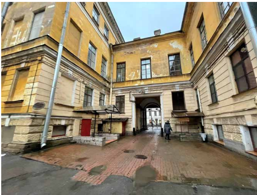
Фото 15. Фрагмент дворового фасада объекта культурного наследия федерального значения «Академия», входящего в состав объекта культурного наследия федерального значения «Российская Академия»
