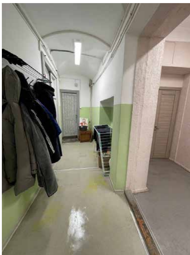
Фото 170. Интерьер 1 этажа объекта культурного наследия федерального значения «Академия», входящего в состав объекта культурного наследия федерального значения «Российская Академия»
