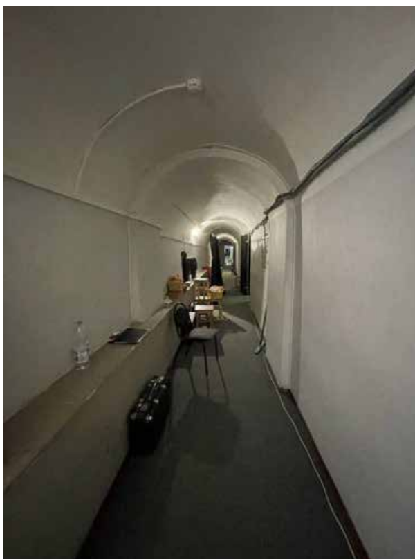
Фото 197. Интерьер подвального этажа объекта культурного наследия федерального значения «Академия», входящего в состав объекта культурного наследия федерального значения «Российская Академия»
