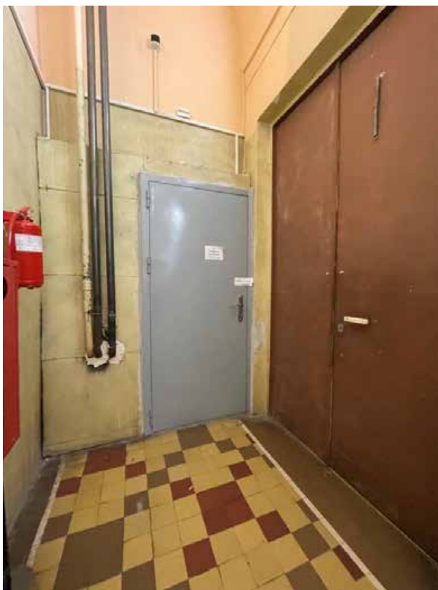
Фото 115. Интерьер 3 этажа объекта культурного наследия федерального значения «Академия», входящего в состав объекта культурного наследия федерального значения «Российская Академия»
