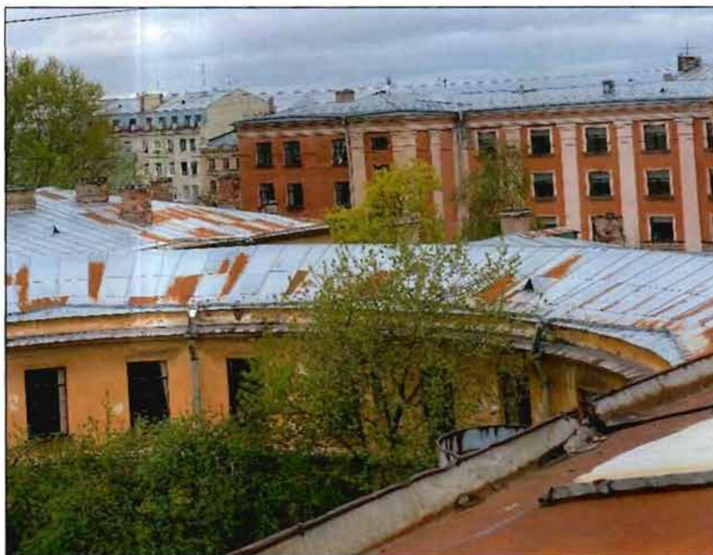
22. Металлическая кровля. Фото от 16.05.2022 г.
