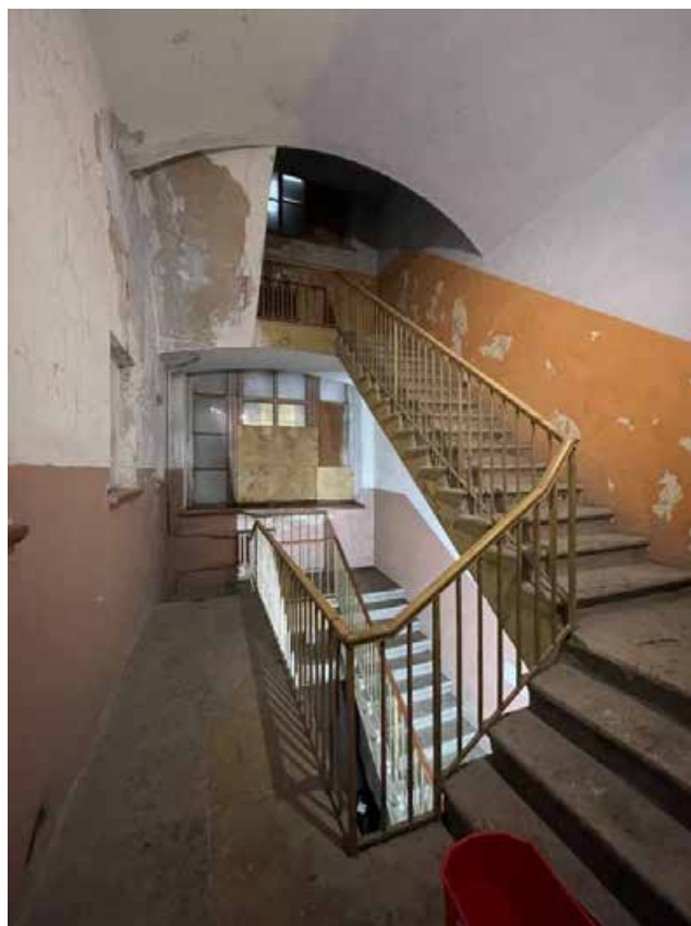
Фото 100. Интерьер 2 этажа объекта культурного наследия федерального значения «Академия», входящего в состав объекта культурного наследия федерального значения «Российская Академия»
