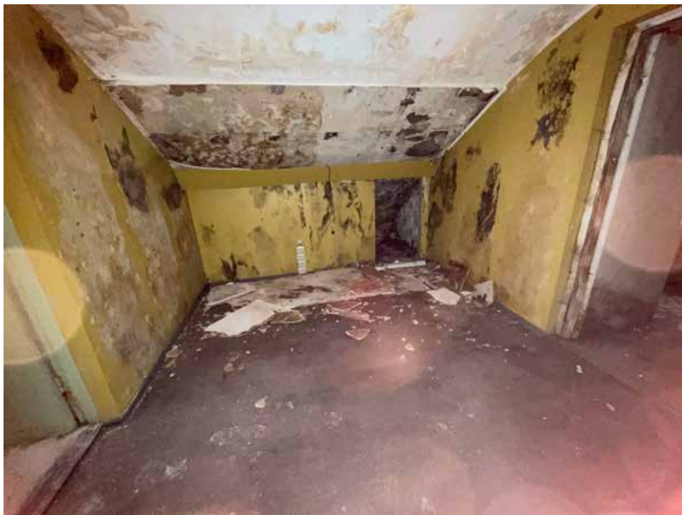
Фото 209. Интерьер подвального этажа объекта культурного наследия федерального значения «Академия», входящего в состав объекта культурного наследия федерального значения «Российская Академия»
