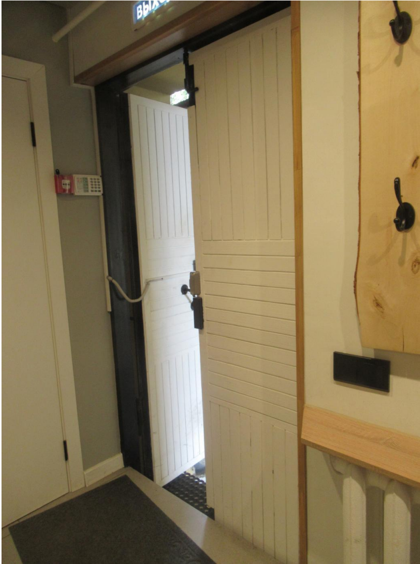
12. Входной дверной проем. Вид со стороны помещения 1-Н.
