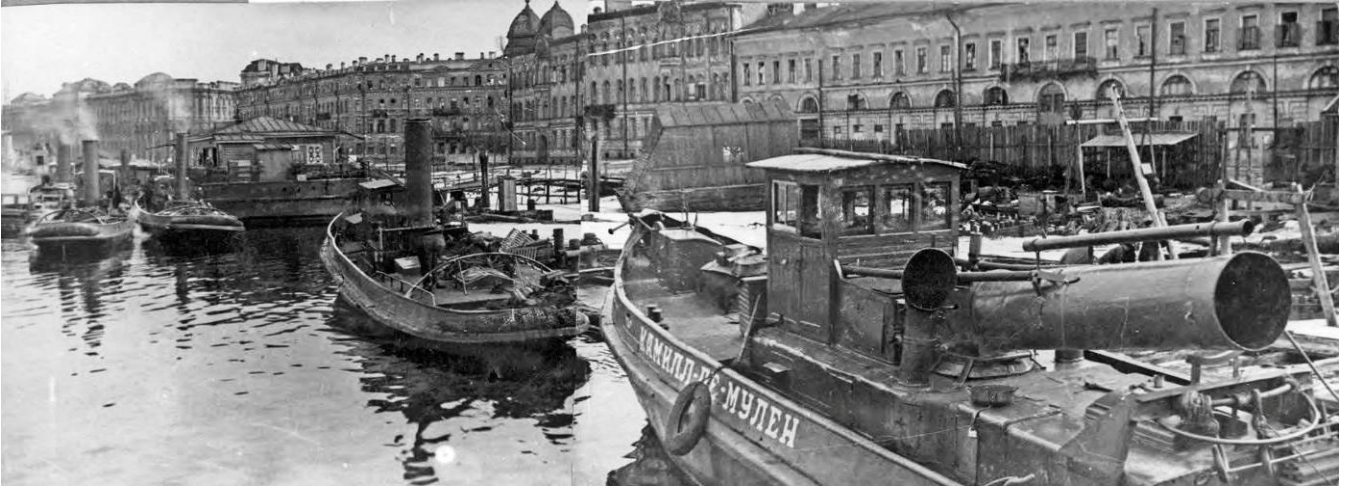
Илл. 15. Открытие навигации. Фото 1943 г. Справа, за причальной стенкой — бывшие дома Яковлевых.
