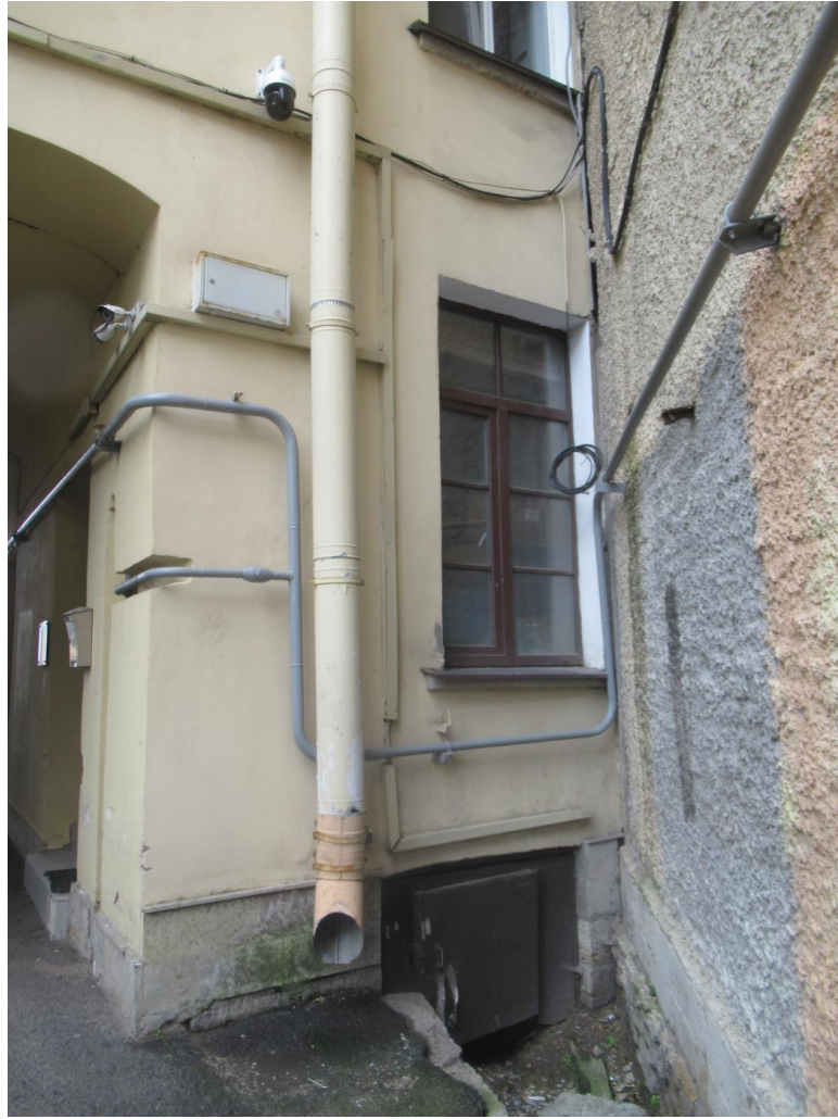
10. Оконный проем нежилого помещения 1-Н со стороны двора.
