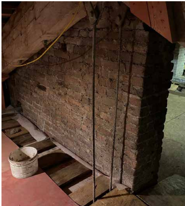
Фото 9. Чердак, стропильная система
