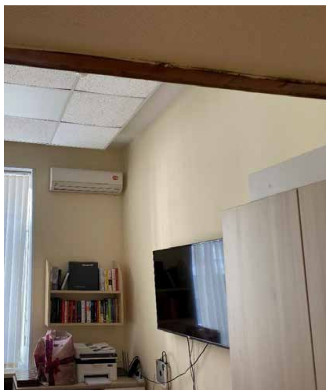
Фото 20, 3 этаж. Внутренний блок кондиционирования
