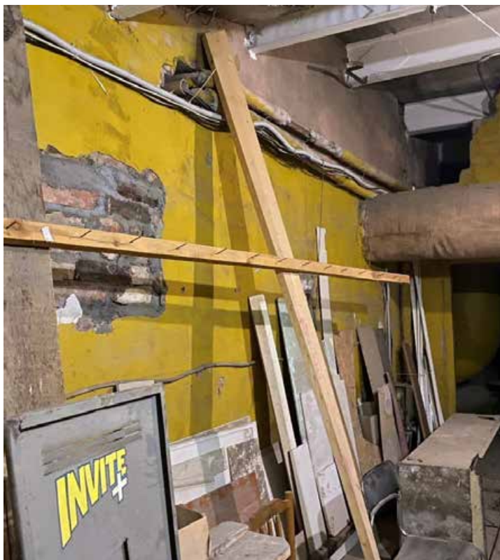
Фото 17. Чердак, вентиляционная камера
