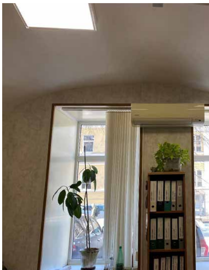
Фото 8, 1 этаж. Внутренний блок кондиционирования
