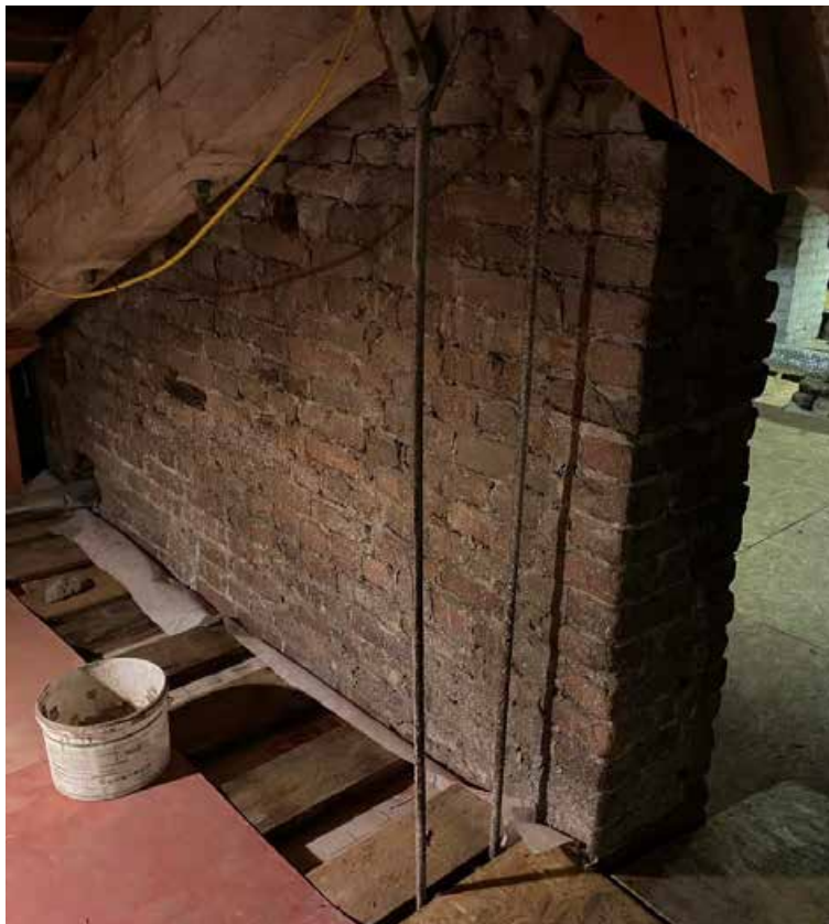
Фото 9. Чердак, стропильная система
