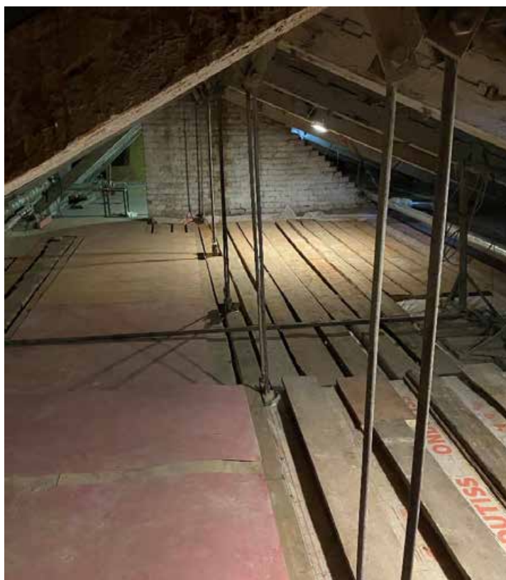
Фото 6. Чердак, общий вид конструкции растяжек стропильных ног
