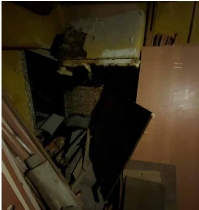
Фото 11. Чердак, вентиляционная камера
