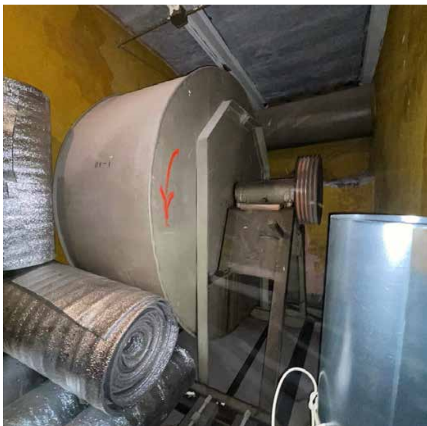
Фото 20. Чердак, вентиляционная камера
