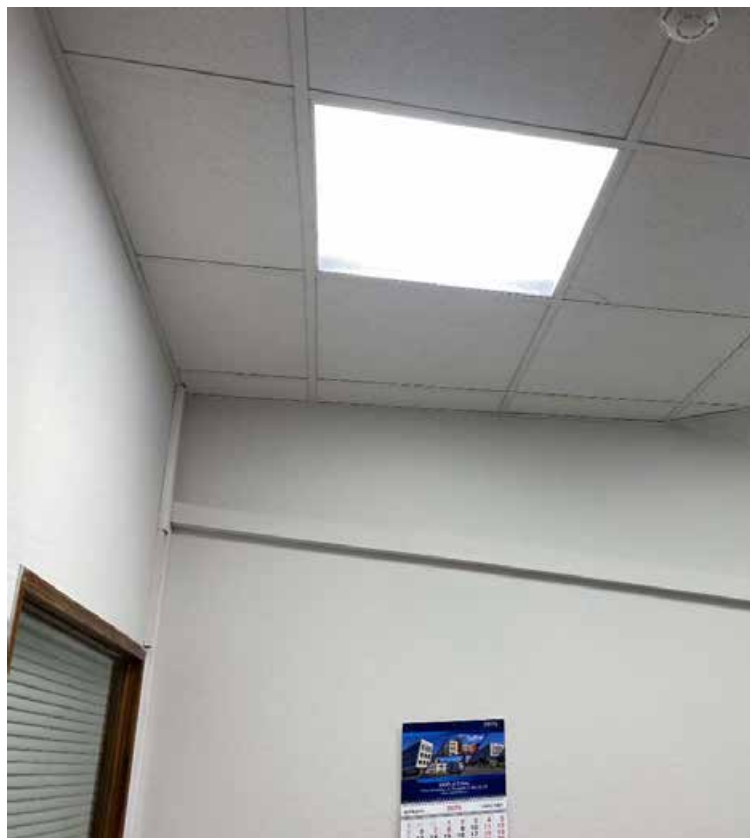
Фото 11, 1 этаж. Трасса, соединяющая блоки кондиционирования
