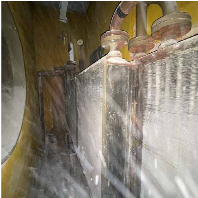
Фото 19. Чердак, вентиляционная камера
