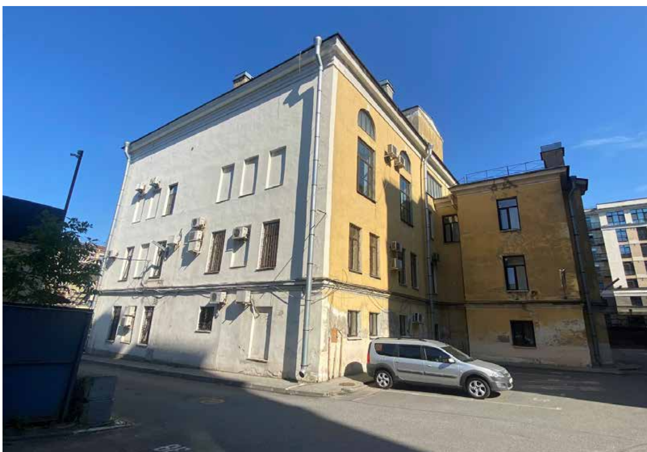
Фото 7, Фрагмент северо-восточного фасада
