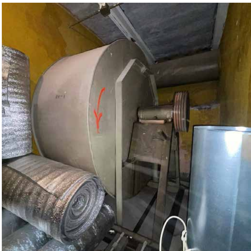
Фото 20. Чердак, вентиляционная камера
