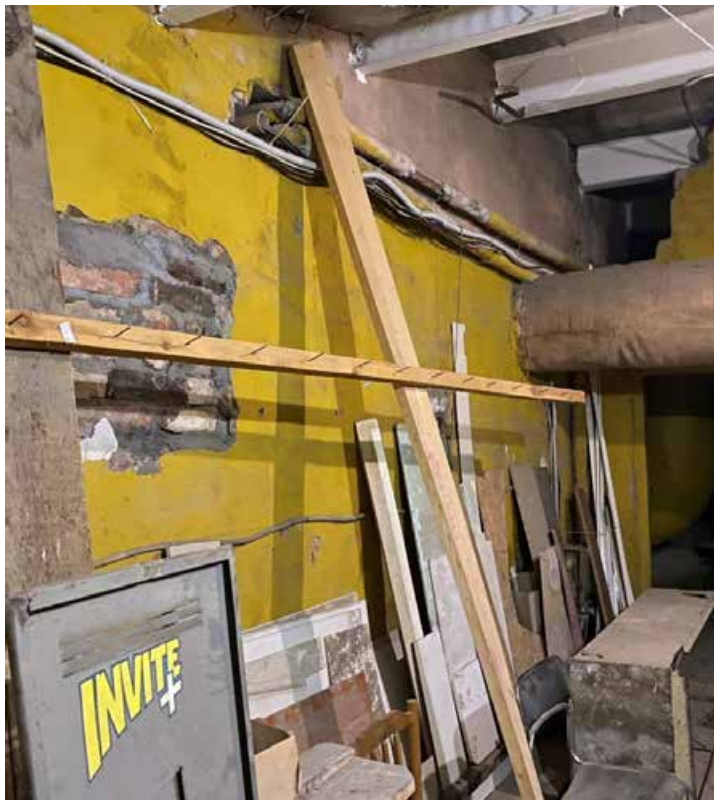
Фото 17. Чердак, вентиляционная камера
