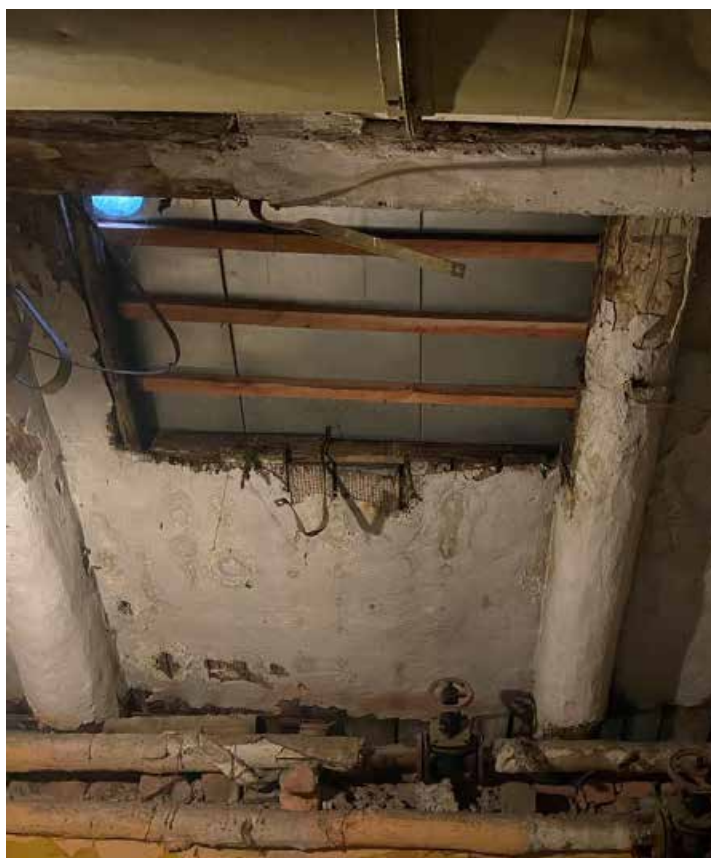
Фото 8. Чердак, люк на кровлю
