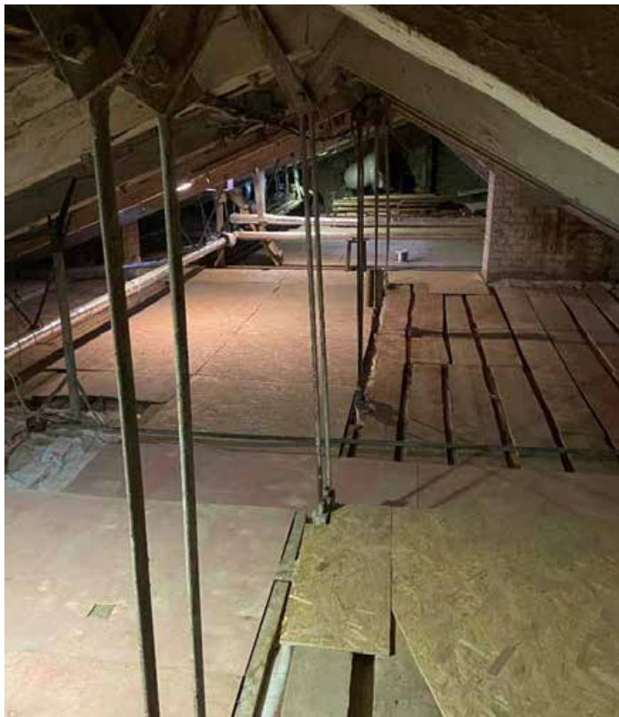
Фото 5. Чердак, общий вид конструкции растяжек стропильных ног
