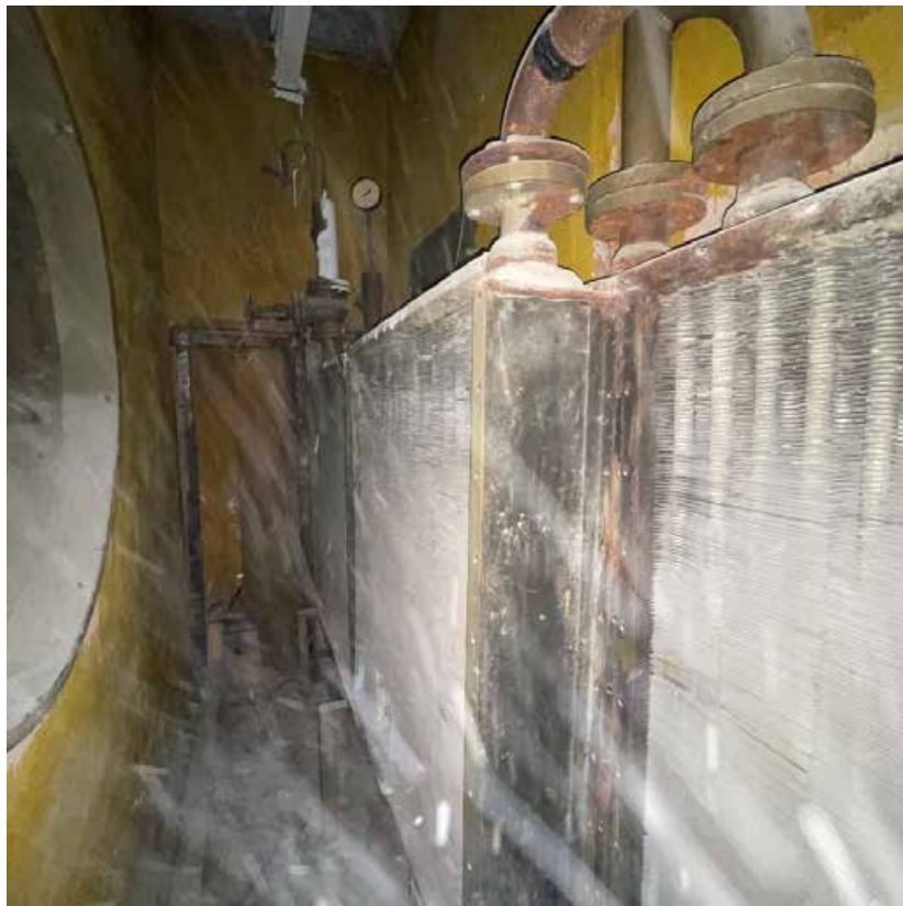
Фото 19. Чердак, вентиляционная камера
