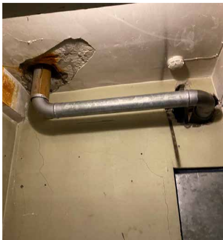
Фото 12, 1 этаж. Коридор. Общий вид трубы водоснабжения
