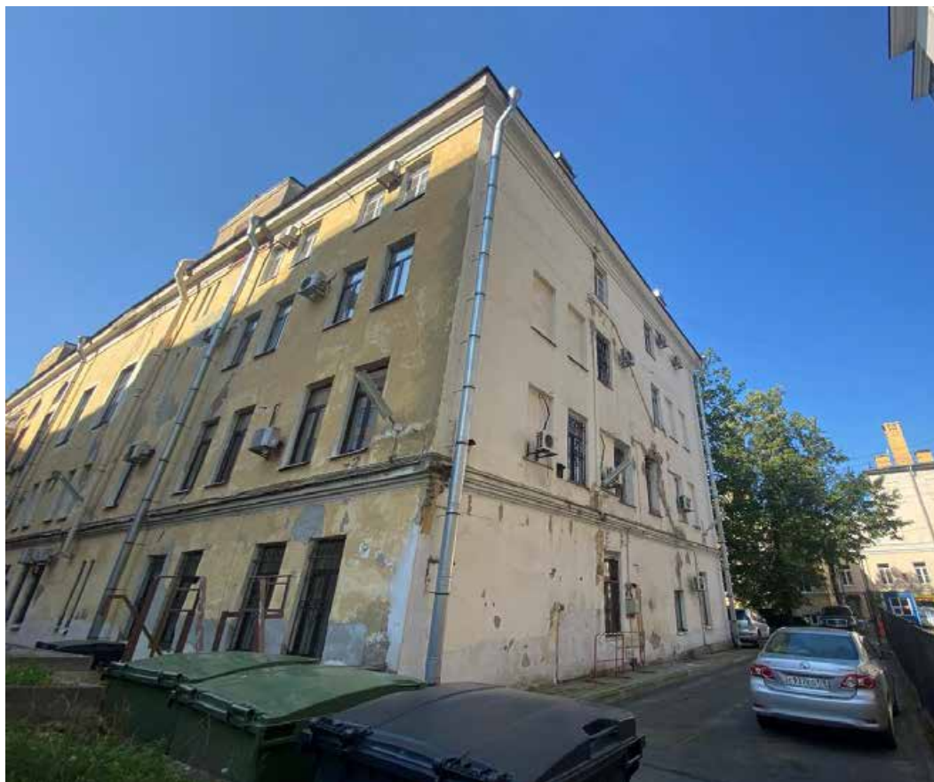
Фото 4, Фрагмент юго-восточного фасада
