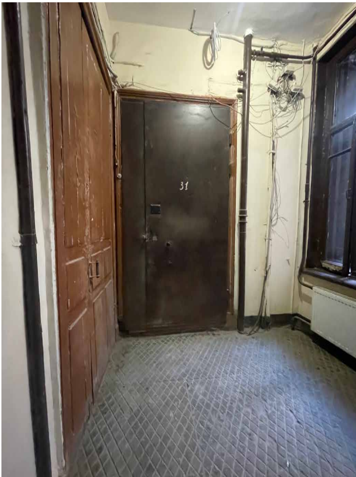
38. Входные двери в помещение 41-Н со стороны лестничной клетки в уровне 2 этажа.
