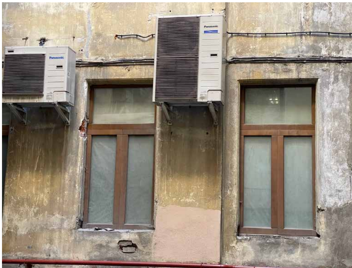
5. Оконные заполнения проемов помещения 41-Н со стороны дворового фасада в уровне 1 этажа.
