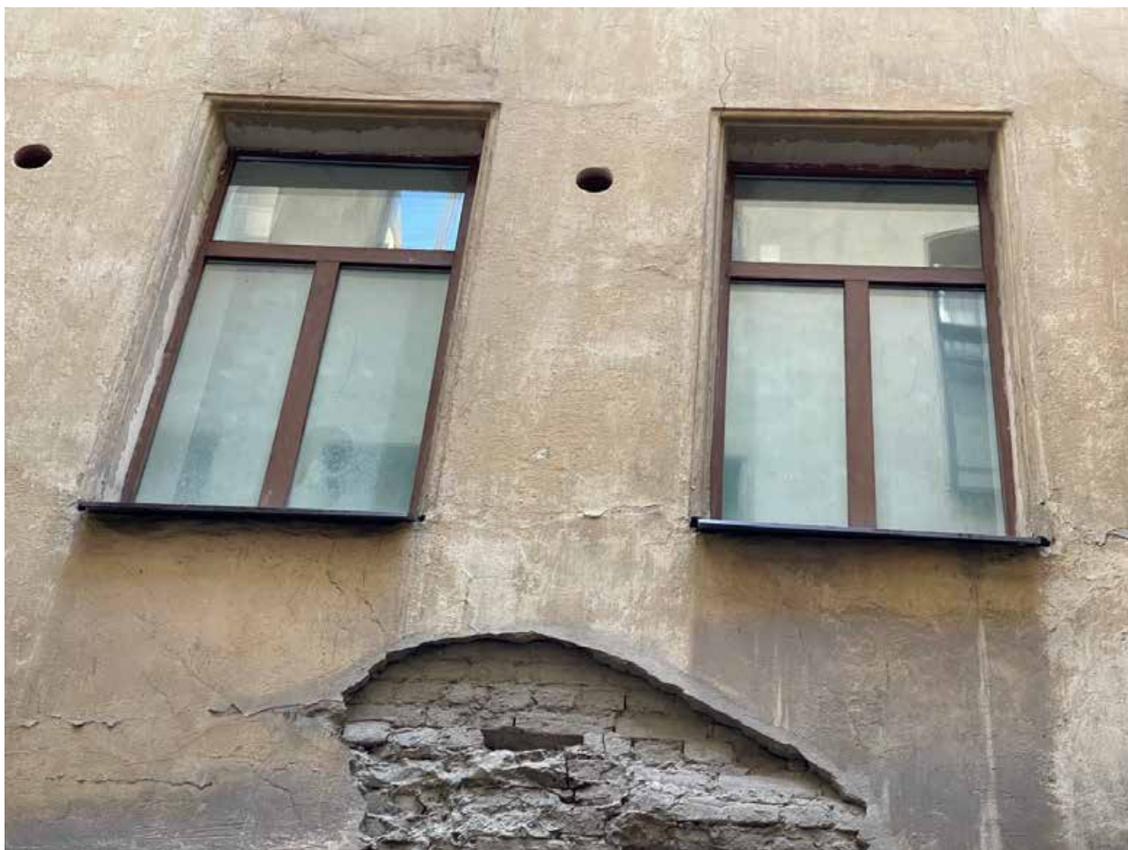
10. Оконные заполнения проемов помещения 41-Н со стороны дворового фасада в уровне 3 этажа.
