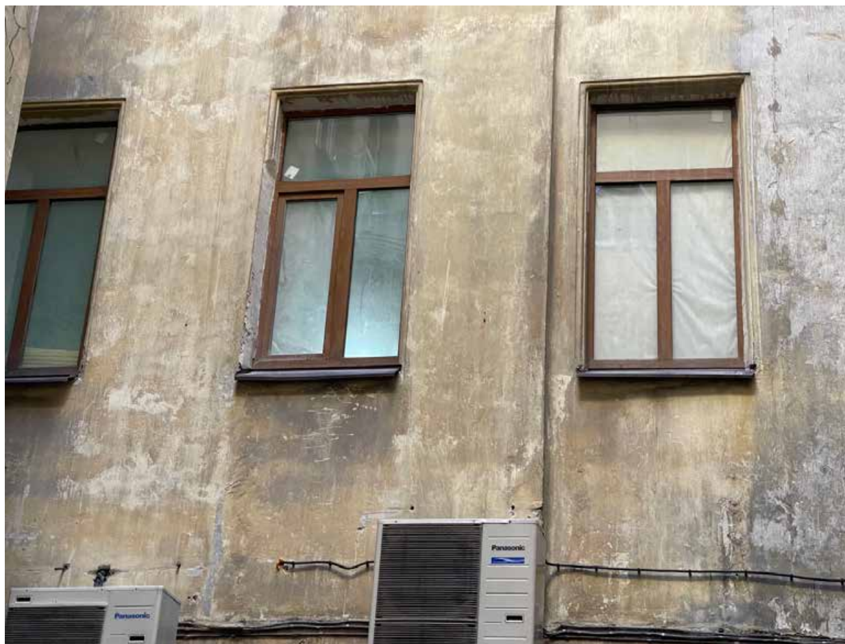
6. Оконные заполнения проемов помещения 41-Н со стороны дворового фасада в уровне 2 этажа.
