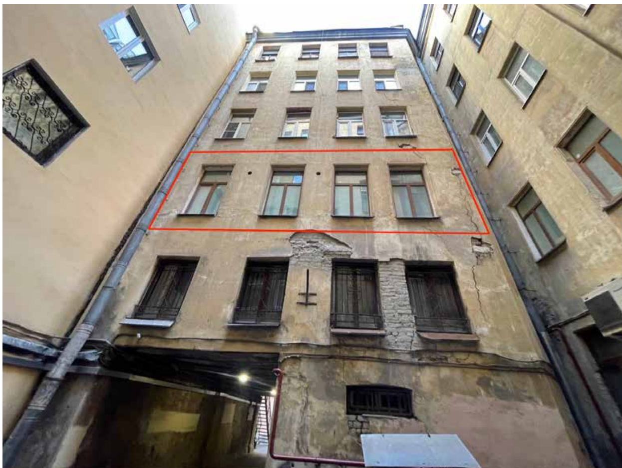
9. Общий вид дворового фасада. Красной линией отмечены оконные проемы помещения 41-Н в уровне 3 этажа.
