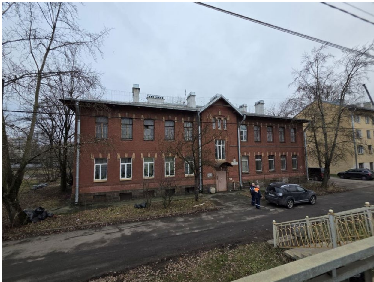
Фото 24. Объект культурного наследия регионального значения «Историческая железнодорожная станция «Фарфоровский пост», расположенный по адресу: Санкт-Петербург, Фарфоровский пост. Северо-восточный фасад здания по адресу: Санкт-Петербург, Фарфоровский пост, дом 40.
