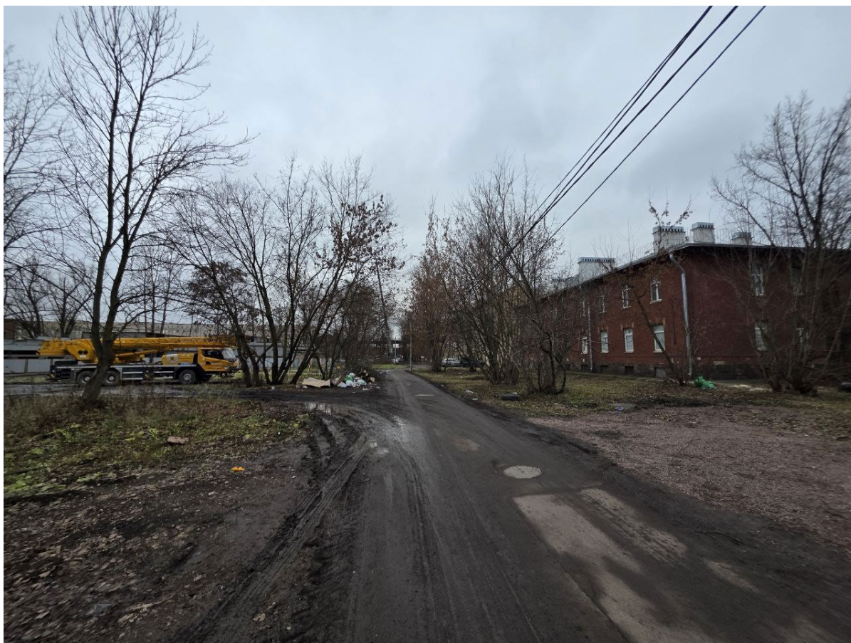
Фото 14. Объект культурного наследия регионального значения «Историческая железнодорожная станция «Фарфоровский пост», расположенный по адресу: Санкт-Петербург, Фарфоровский пост. Существующий внутриквартальный проезд, вид на дом 40 по адресу: Санкт-Петербург, Фарфоровский пост.
