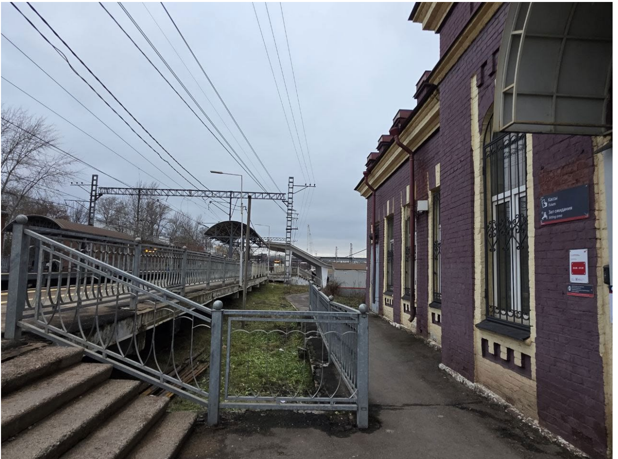
Фото 4. Объект культурного наследия регионального значения «Историческая железнодорожная станция «Фарфоровский пост», расположенный по адресу: Санкт-Петербург, Фарфоровский пост. Композиционная ось, сформированная железнодорожными путями, здание вокзала.
