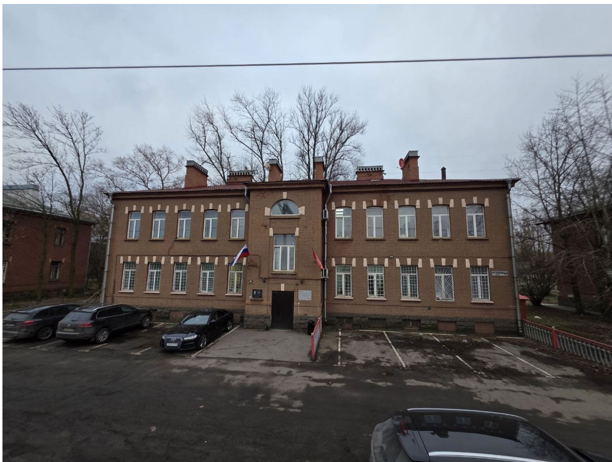
Фото 25. Объект культурного наследия регионального значения «Историческая железнодорожная станция «Фарфоровский пост», расположенный по адресу: Санкт-Петербург, Фарфоровский пост. Северо-восточный фасад здания по адресу: Санкт-Петербург, Фарфоровский пост, дом 44.
