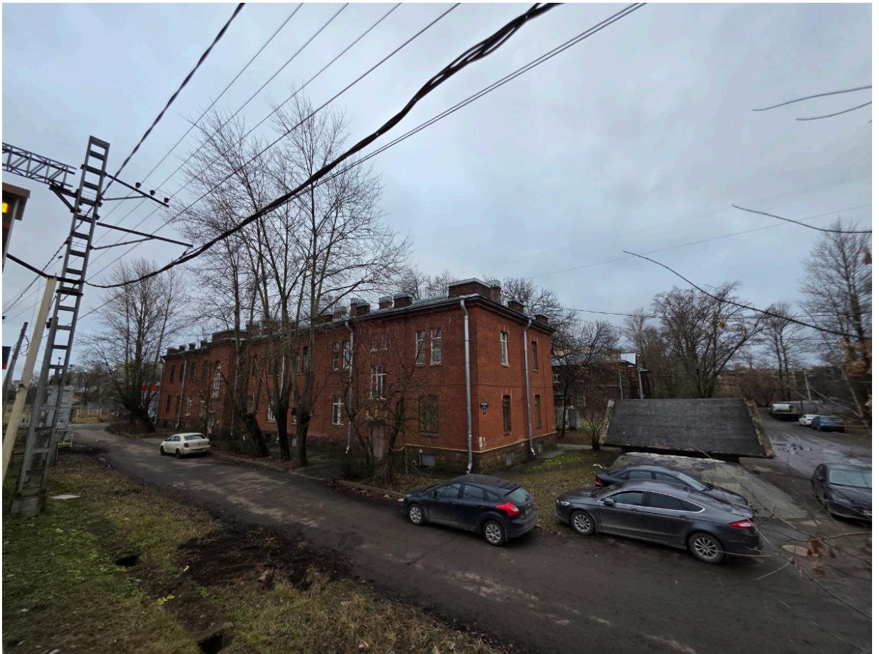
Фото 7. Объект культурного наследия регионального значения «Историческая железнодорожная станция «Фарфоровский пост», расположенный по адресу: Санкт-Петербург, Фарфоровский пост. Ряд краснокирпичных фасадов зданий. Здание справа – Санкт-Петербург, Фарфоровский пост, дом 54, литера А.
