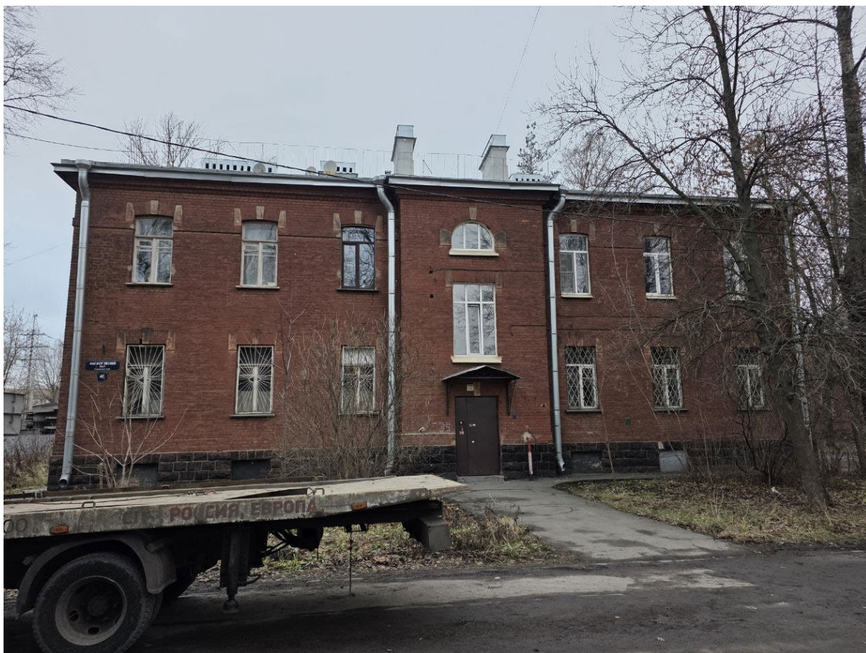
Фото 28. Объект культурного наследия регионального значения «Историческая железнодорожная станция «Фарфоровский пост», расположенный по адресу: Санкт-Петербург, Фарфоровский пост. Юго-восточный фасад здания по адресу: Санкт-Петербург, Фарфоровский пост, дом 46.
