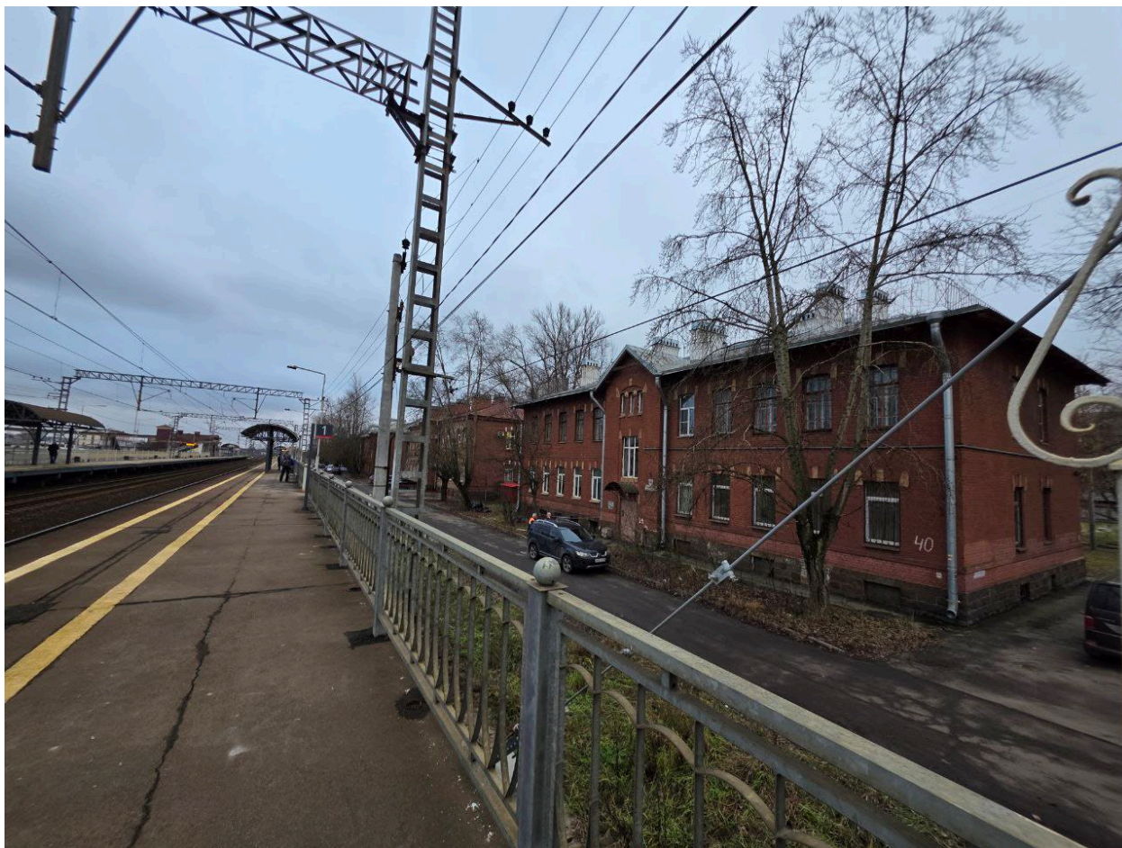
Фото 2. Объект культурного наследия регионального значения «Историческая железнодорожная станция «Фарфоровский пост», расположенный по адресу: Санкт-Петербург, Фарфоровский пост. Композиционная ось, сформированная железнодорожными путями.
