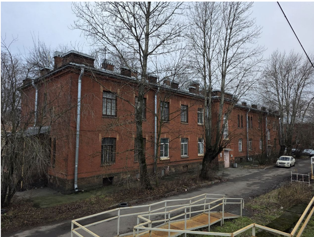
Фото 27. Объект культурного наследия регионального значения «Историческая железнодорожная станция «Фарфоровский пост», расположенный по адресу: Санкт-Петербург, Фарфоровский пост. Северо-восточный фасад здания по адресу: Санкт-Петербург, Фарфоровский пост, дом 54.
