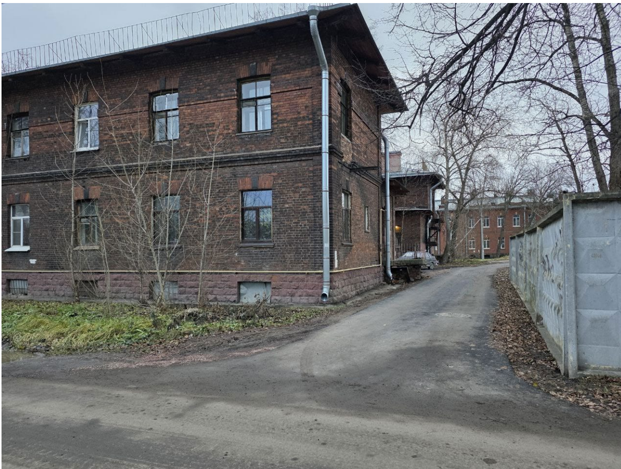
Фото 19. Объект культурного наследия регионального значения «Историческая железнодорожная станция «Фарфоровский пост», расположенный по адресу: Санкт-Петербург, Фарфоровский пост. Вид на существующий внутриквартальный проезд у дома 52 по адресу: Санкт-Петербург, Фарфоровский пост.
