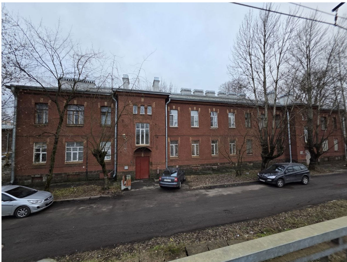
Фото 26. Объект культурного наследия регионального значения «Историческая железнодорожная станция «Фарфоровский пост», расположенный по адресу: Санкт-Петербург, Фарфоровский пост. Северо-восточный фасад здания по адресу: Санкт-Петербург, Фарфоровский пост, дом 48.
