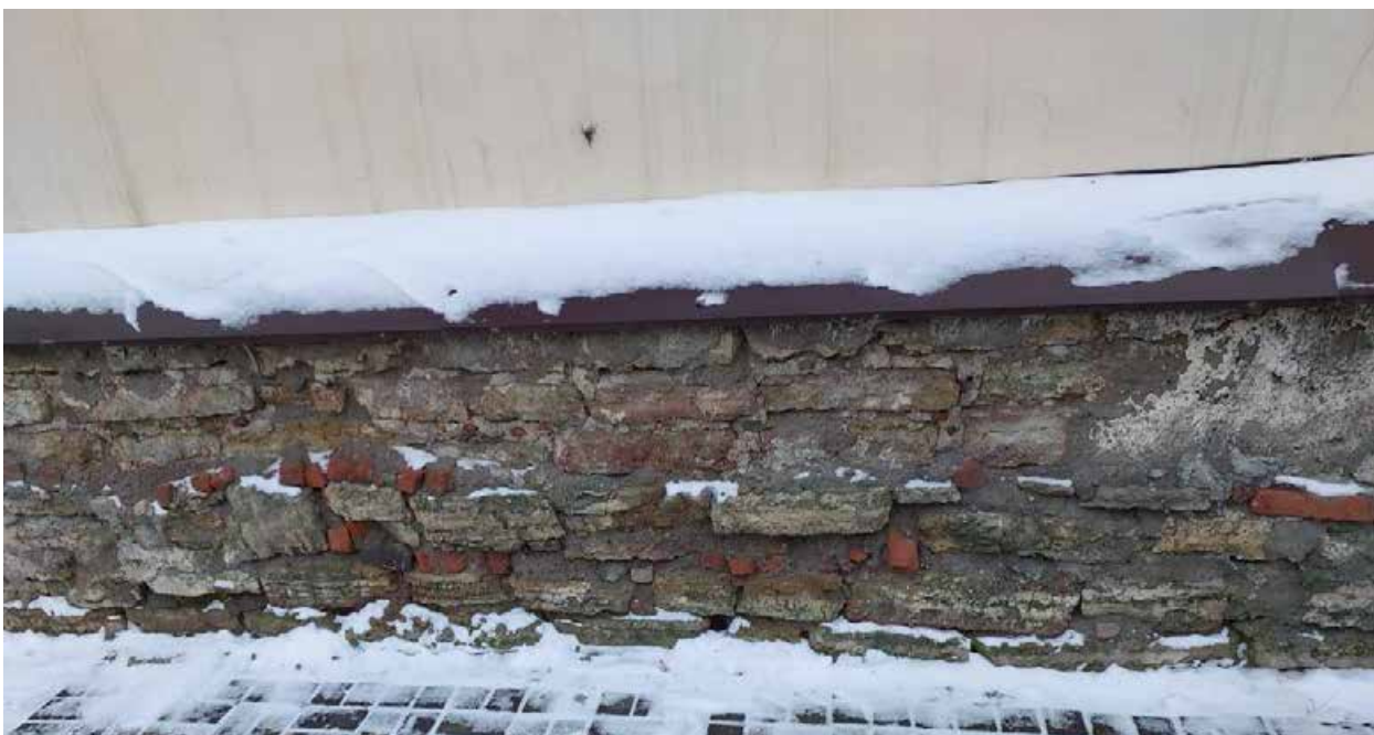
Фото 6 – Цокольная часть лицевого фасада ограды со стороны ул. Смольного (16.01.2026 г.)
