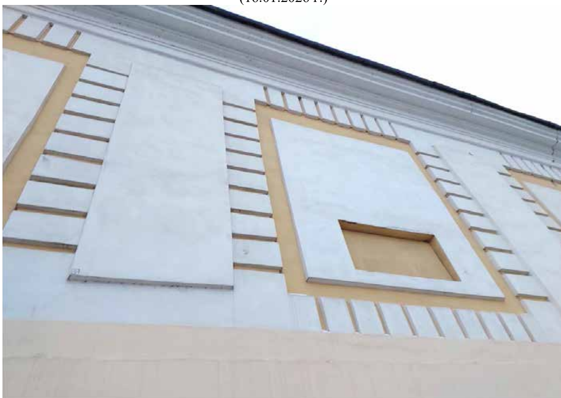
Фото 5 – Лицевой фасад ограды со стороны ул. Смольного (16.01.2026 г.)
