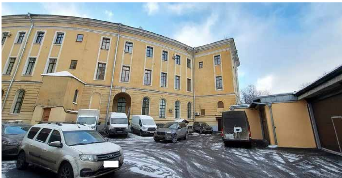
Фото 43 – Общий вид здания по адресу: ул. Смольного, д.3, литера А (16.01.2026 г.)
