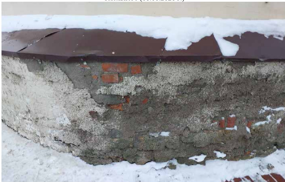
Фото 3 – Цокольная часть лицевого фасада угловой части ограды со стороны пересечения Смольной наб. и ул. Смольного (16.01.2026 г.)
