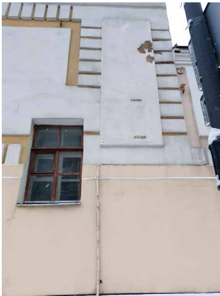
Фото 17 – Лицевой фасад ограды со стороны ул. Смольного (16.01.2026 г.)
