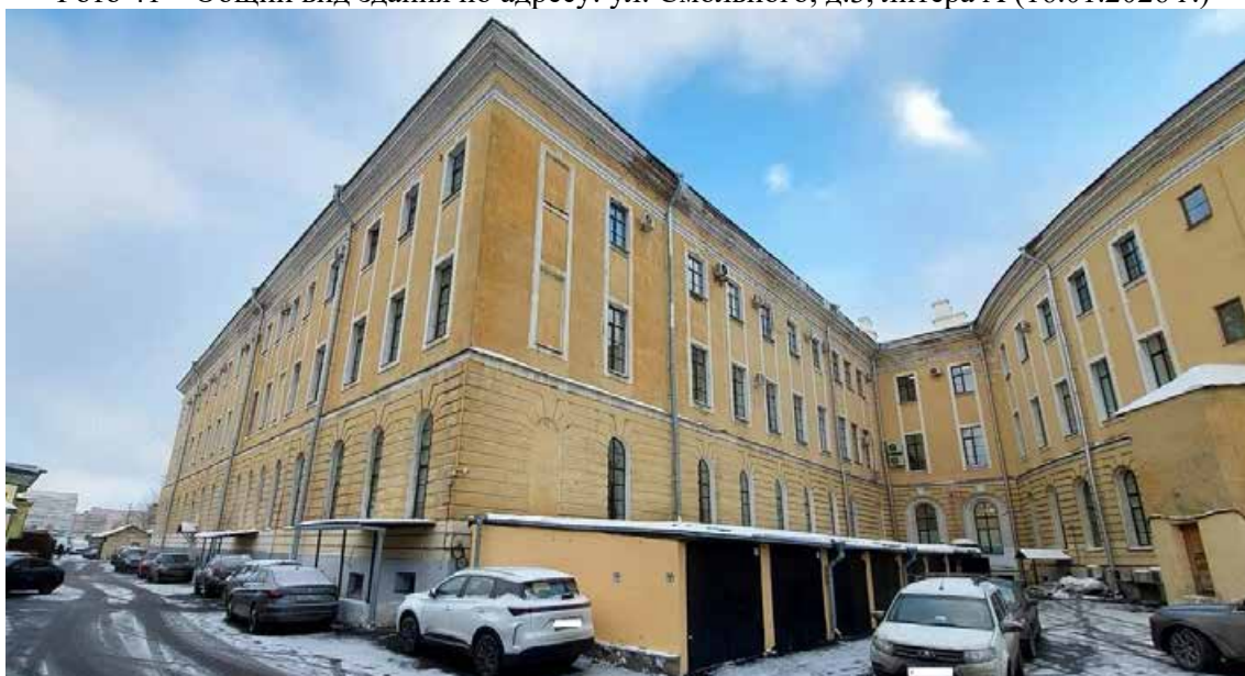
Фото 42 – Общий вид здания по адресу: ул. Смольного, д.3, литера А (16.01.2026 г.)
