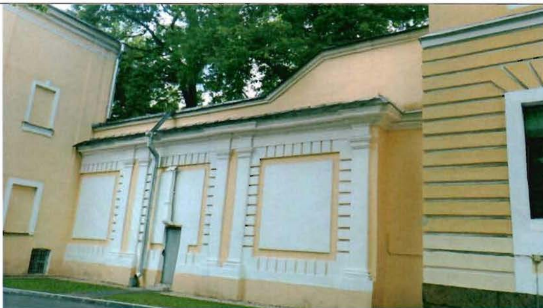
1. Южная часть ограды
