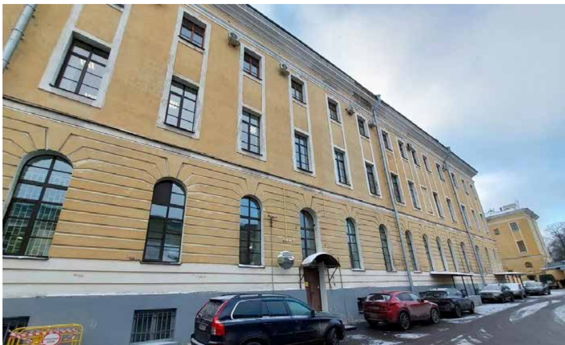
Фото 41 – Общий вид здания по адресу: ул. Смольного, д.3, литера А (16.01.2026 г.)
