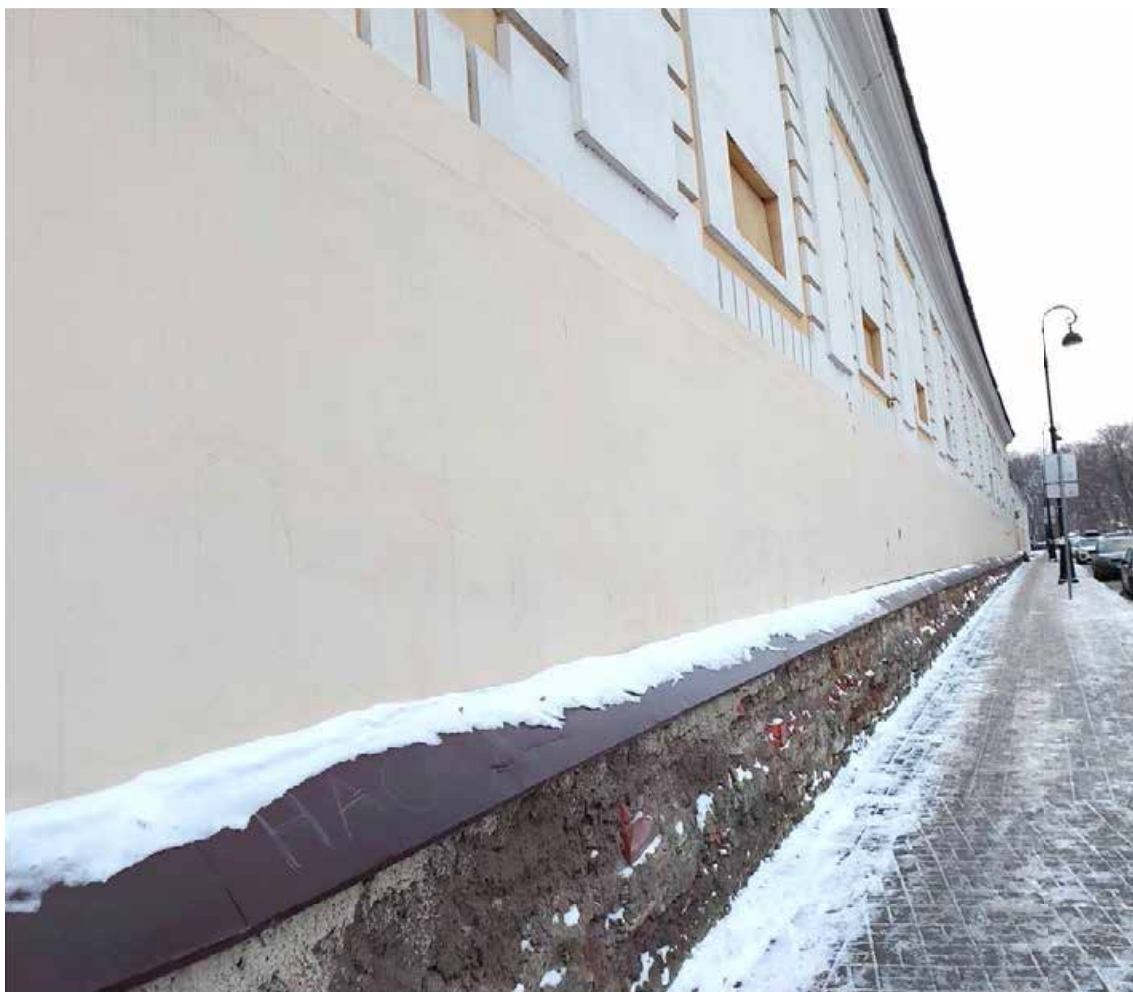
Фото 4 – Нижняя и цокольная часть лицевого фасада ограды со стороны ул. Смольного (16.01.2026 г.)
