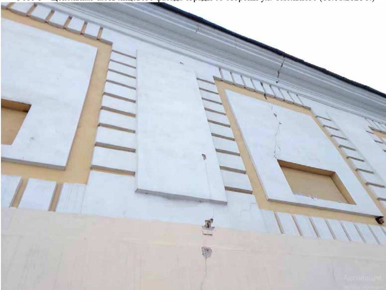
Фото 7 – Лицевой фасад ограды со стороны ул. Смольного (16.01.2026 г.)
