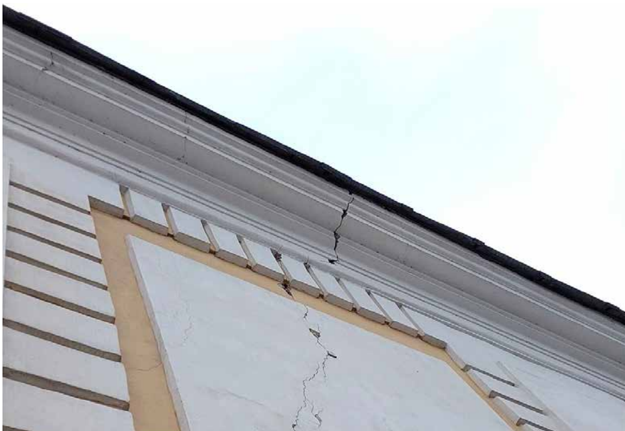
Фото 8 – Карнизная часть лицевого фасада ограды со стороны ул. Смольного (16.01.2026 г.)
