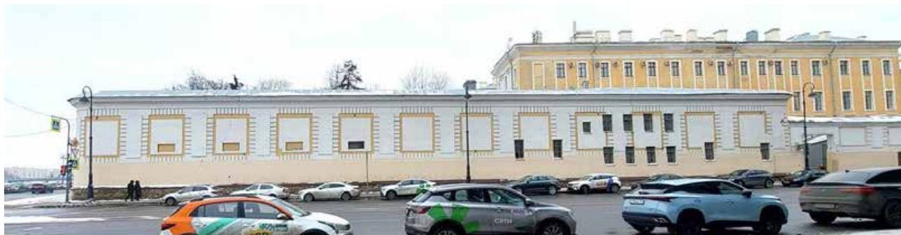
Фото 30 – Общий вид лицевого фасада ограды со стороны ул. Смольного (16.01.2026 г.)
