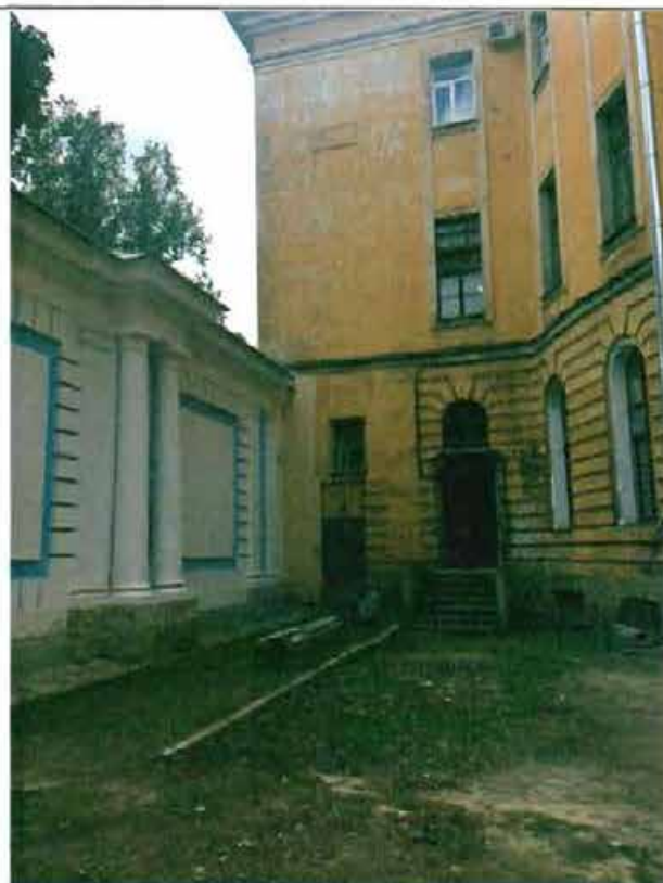
5. Фрагмент южного фасада
