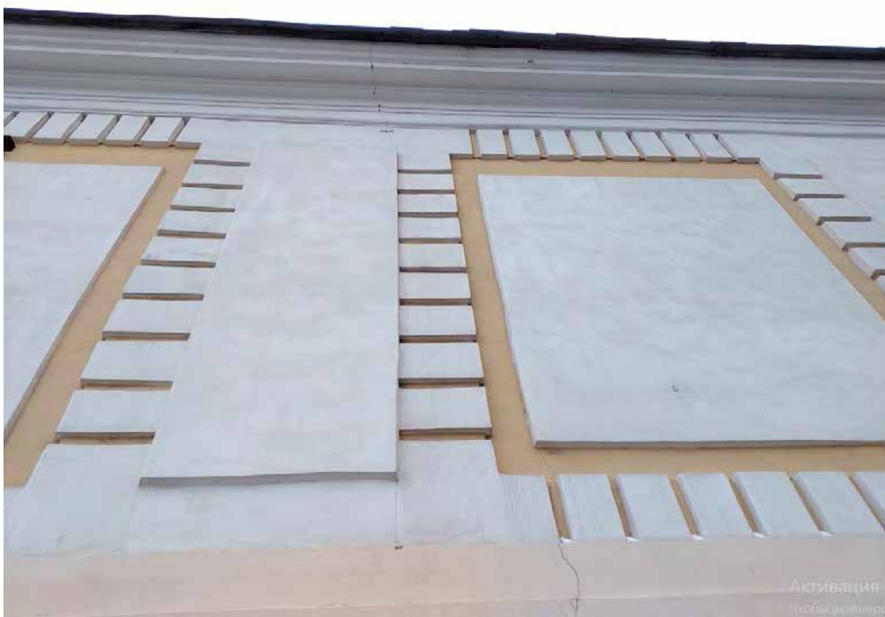
Фото 11 – Лицевой фасад ограды со стороны ул. Смольного (16.01.2026 г.)
