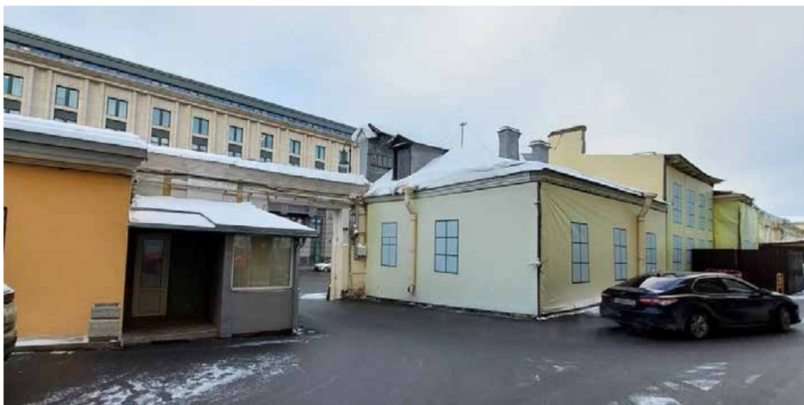
Фото 48 – Общий вид зданий по адресу: ул. Смольного, д.3, литера В и литера Б (16.01.2026 г.)
