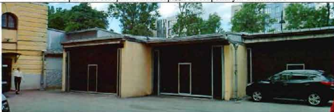
6. Фрагмент северной части ограды со стороны двора
