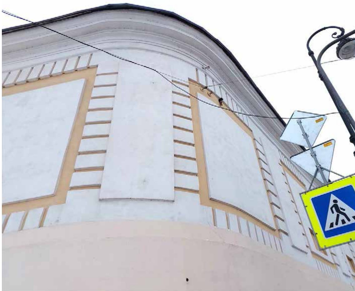
Фото 2 – Лицевой фасад угловой части ограды со стороны пересечения Смольной наб. и ул. Смольного (16.01.2026 г.)
