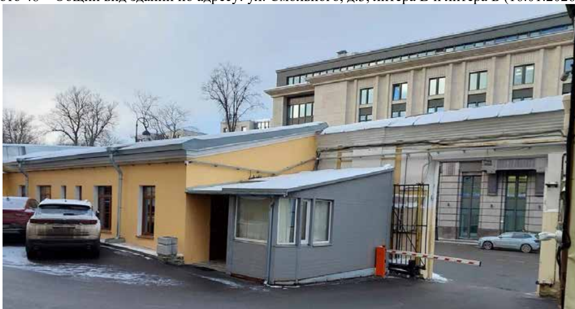
Фото 49 – Общий вид здания по адресу: ул. Смольного, д.3, литера В (16.01.2026 г.)
