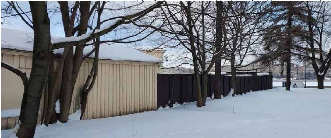
Фото 38 – Общий вид здания по адресу: ул. Смольного, д.3, литера Д и забора (16.01.2026 г.)
