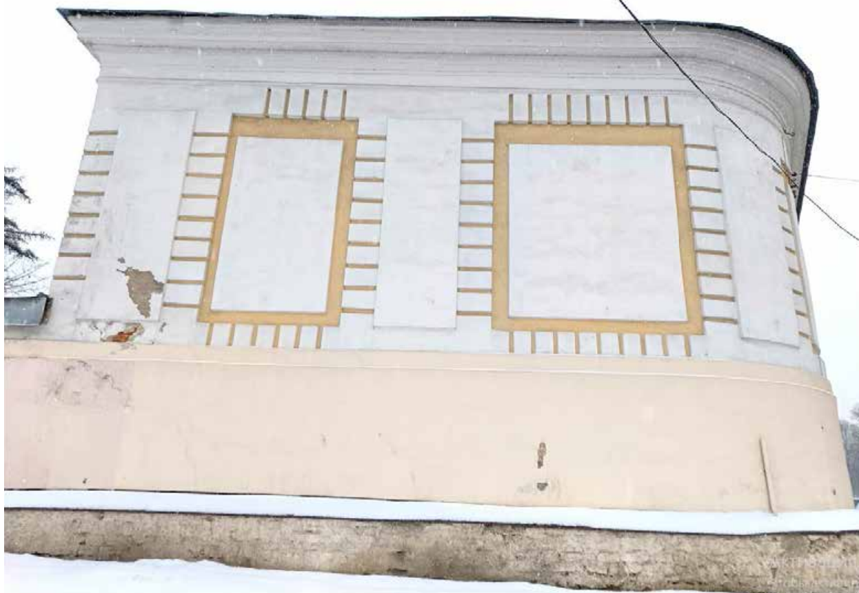
Фото 1 – Лицевой фасад ограды со стороны Смольной наб. (16.01.2026 г.)
