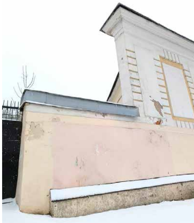
Фото 31 – Лицевой фасад ограды со стороны Смольной наб. (16.01.2026 г.)
