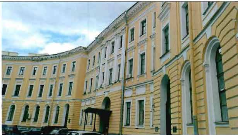
1. Фрагмент западного фасада
