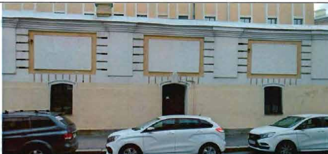
4. Фрагмент северной части ограды со стороны ул. Смольного
