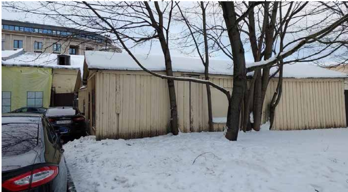
Фото 37 – Общий вид здания по адресу: ул. Смольного, д.3, литера Д (16.01.2026 г.)
