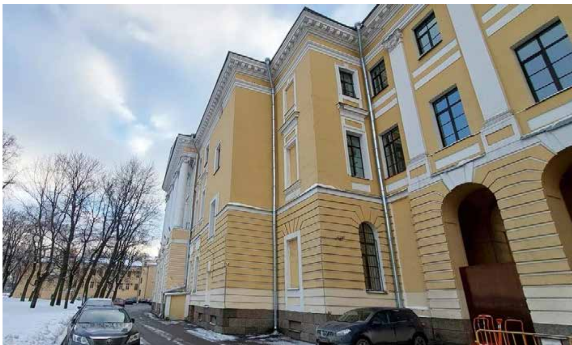
Фото 39 – Общий вид здания по адресу: ул. Смольного, д.3, литера А (16.01.2026 г.)
