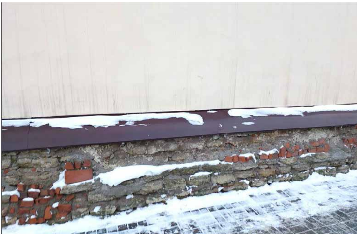
Фото 10 – Нижняя и цокольная часть лицевого фасада ограды со стороны ул. Смольного (16.01.2026 г.)
