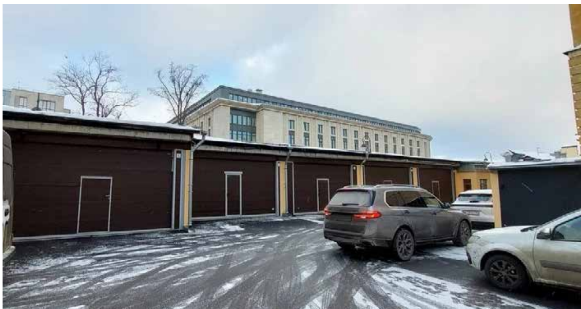
Фото 45 – Общий вид здания по адресу: ул. Смольного, д.3, литера П (16.01.2026 г.)
