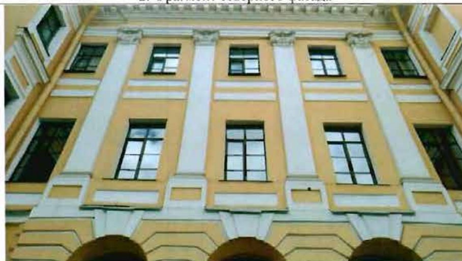
3. Фрагмент восточного фасада
