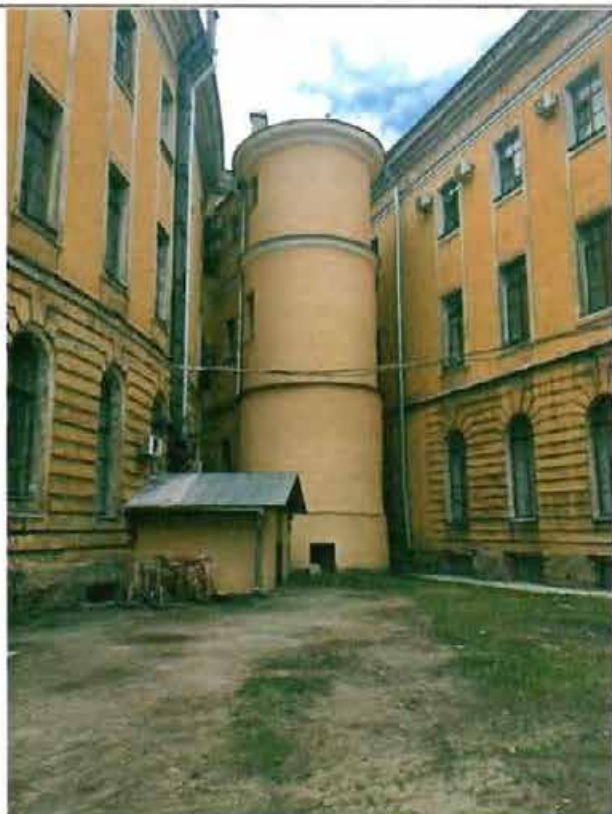
4. Фрагмент южного фасада
