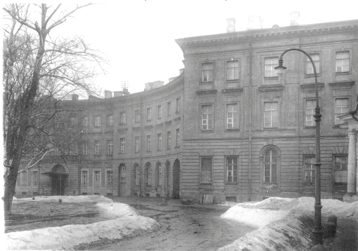
Рисунок 4.31 – Вид части фасада здания бывшего Александровского института, 1932 г. ЦГАКФФД СПб. Фотодокументы. Оп.1ГР-31. Ед.хр.45934
