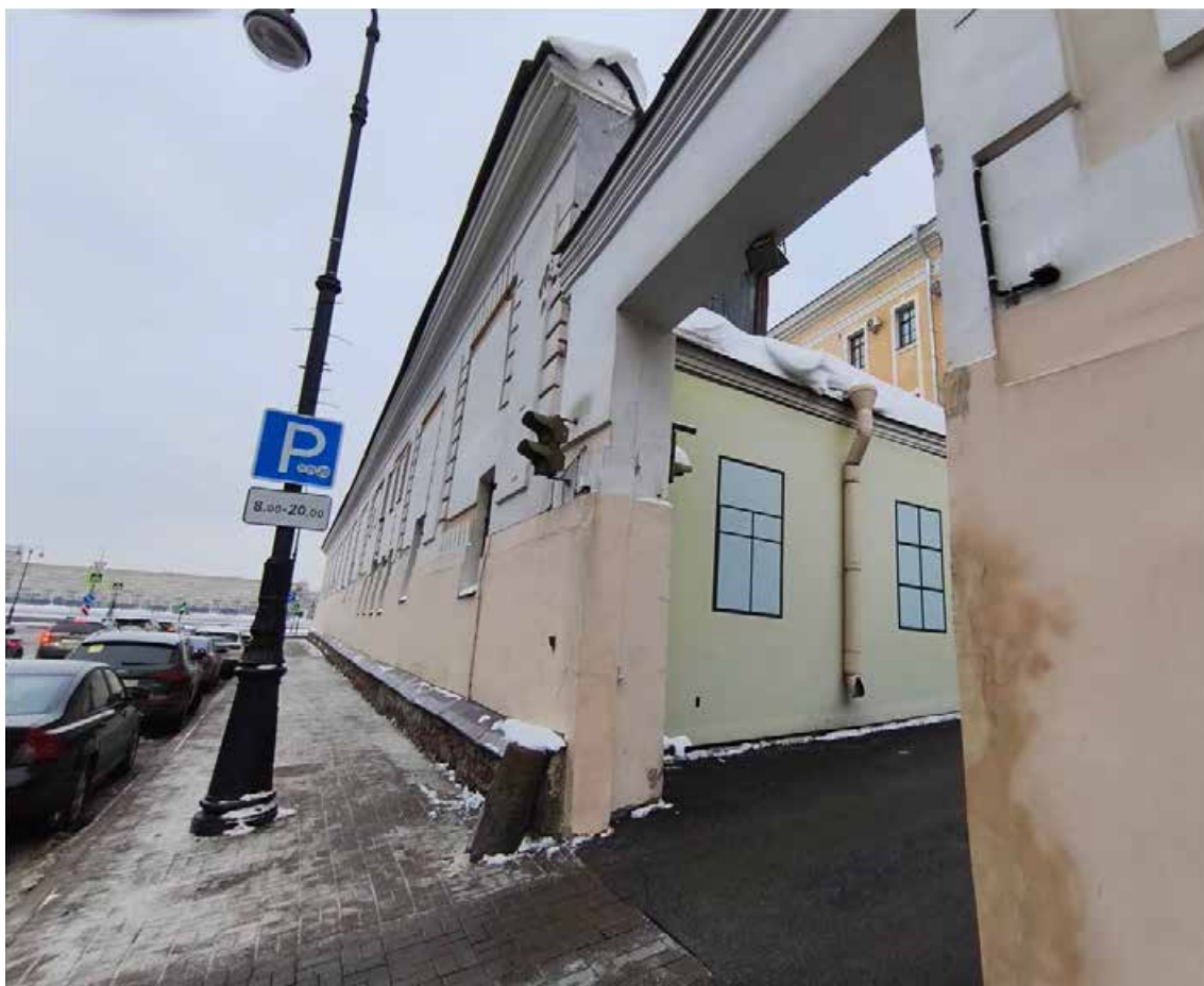
Фото 19 – Лицевой фасад ограды и воротный проезд со стороны ул. Смольного (16.01.2026 г.)
