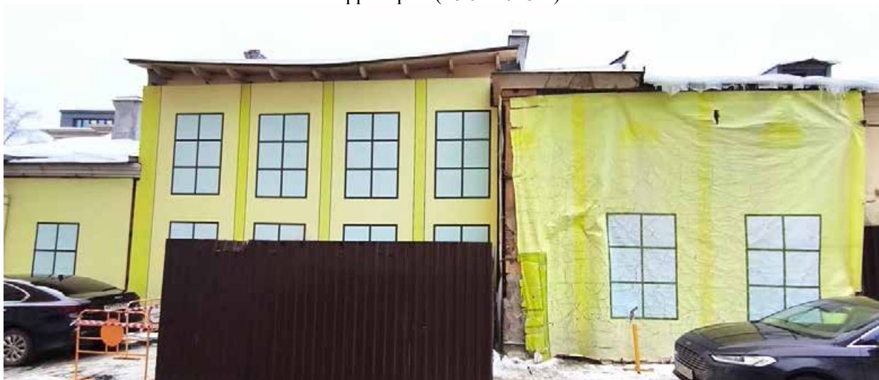
Фото 23 – Общий вид дворового фасада пристроенного здания гаража со стороны дворовой территории (16.01.2026 г.)
