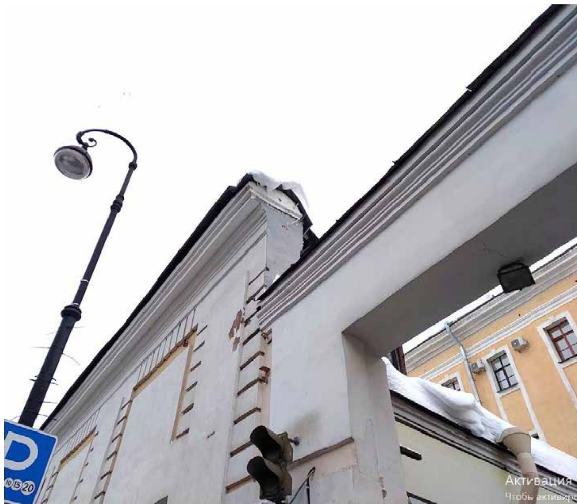
Фото 18 – Лицевой фасад ограды и фрагмент воротного проезда со стороны ул. Смольного (16.01.2026 г.)
