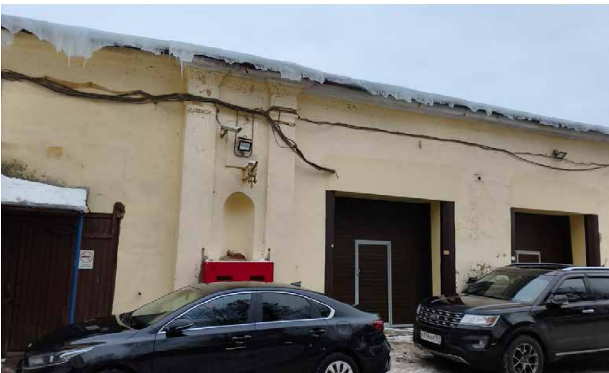
Фото 25 – Общий вид дворового фасада пристроенного здания гаража со стороны дворовой территории (16.01.2026 г.)
