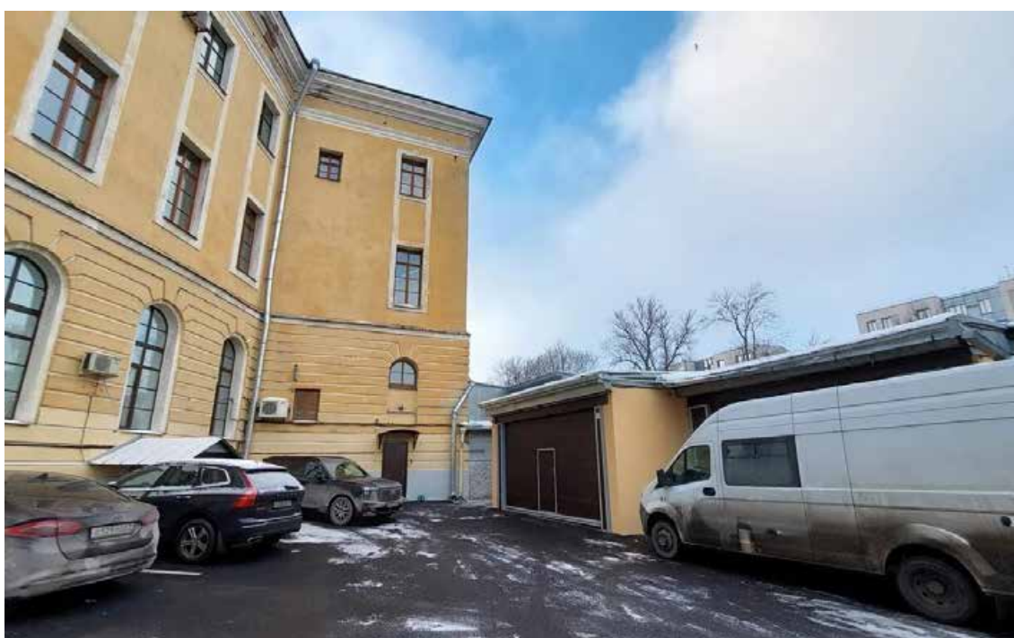
Фото 44 – Общий вид здания по адресу: ул. Смольного, д.3, литера А (16.01.2026 г.)
