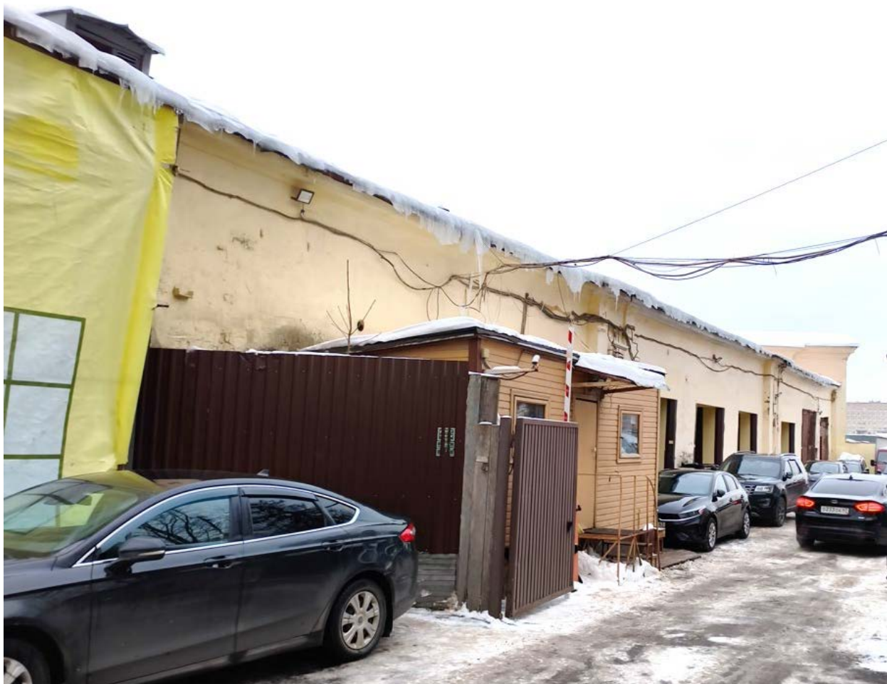
Фото 24 – Общий вид дворового фасада пристроенного здания гаража со стороны дворовой территории (16.01.2026 г.)
