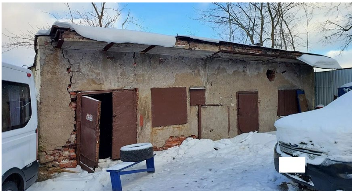
Фото 33 – Общий вид здания по адресу: ул. Смольного, д.3, литера Г (16.01.2026 г.)
