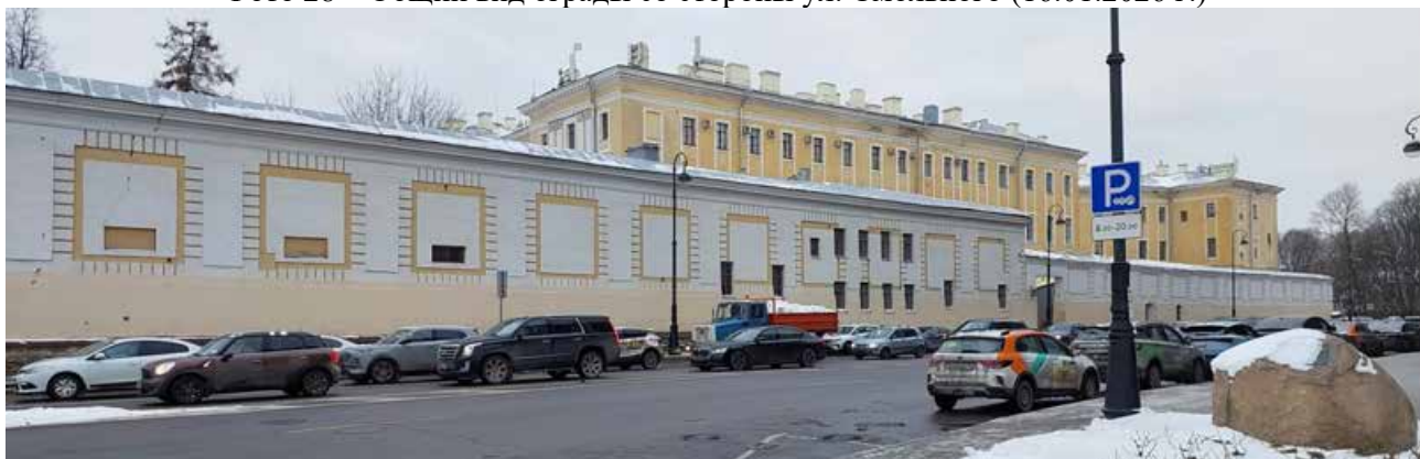
Фото 29 – Общий вид лицевого фасада ограды со стороны ул. Смольного (16.01.2026 г.)
