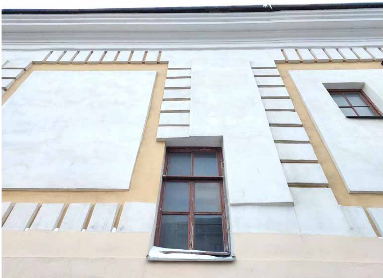
Фото 13 – Лицевой фасад ограды со стороны ул. Смольного (16.01.2026 г.)
