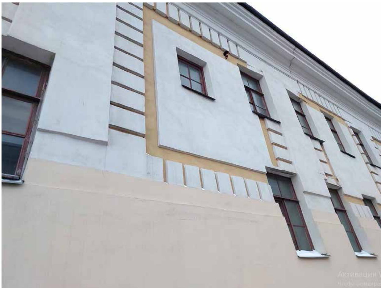
Фото 14 – Лицевой фасад ограды со стороны ул. Смольного (16.01.2026 г.)
