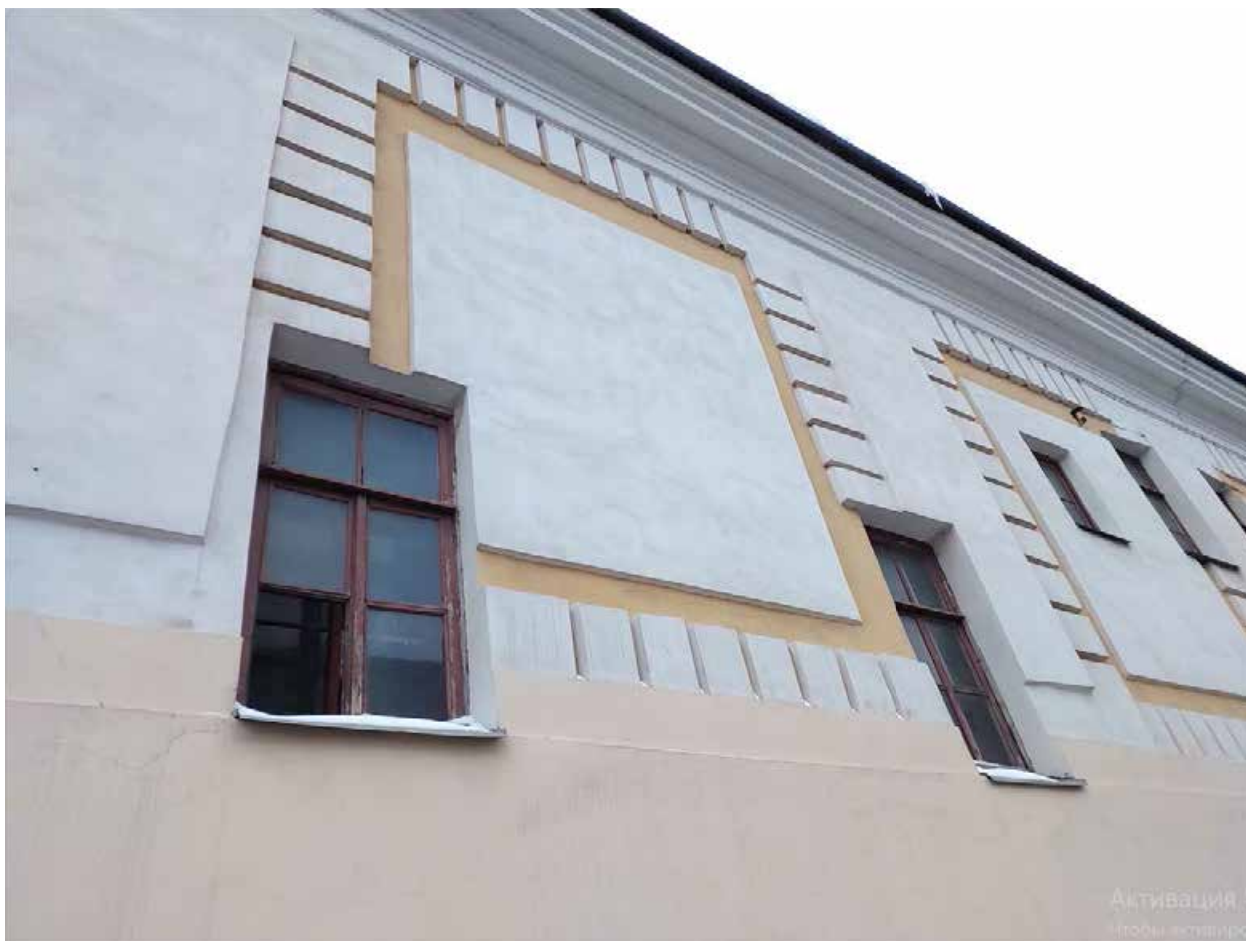
Фото 12 – Лицевой фасад ограды со стороны ул. Смольного (16.01.2026 г.)
