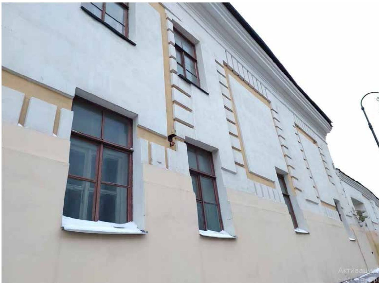
Фото 16 – Лицевой фасад ограды со стороны ул. Смольного (16.01.2026 г.)
