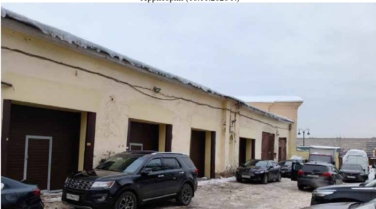
Фото 26 – Общий вид дворового фасада пристроенного здания гаража со стороны дворовой территории (16.01.2026 г.)
