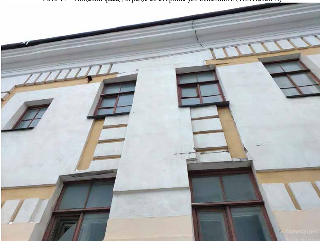
Фото 15 – Лицевой фасад ограды со стороны ул. Смольного (16.01.2026 г.)
