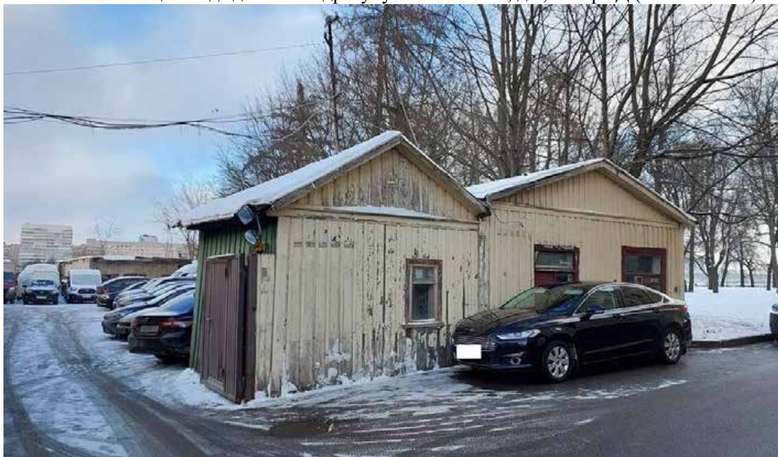
Фото 36 – Общий вид здания по адресу: ул. Смольного, д.3, литера Д (16.01.2026 г.)
