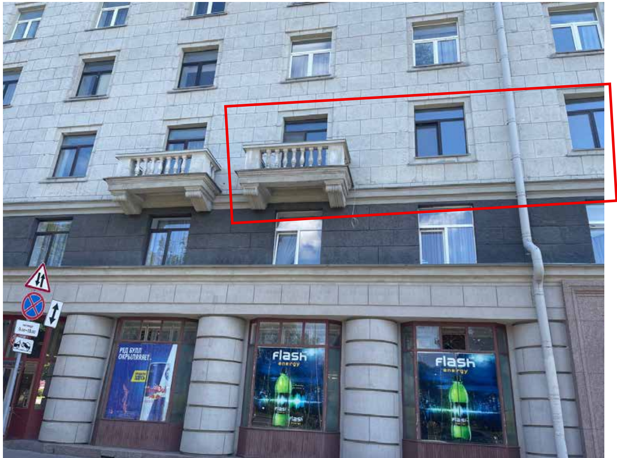
4. Вид на лицевой фасад. Красной линией отмечены оконные проемы квартиры.
