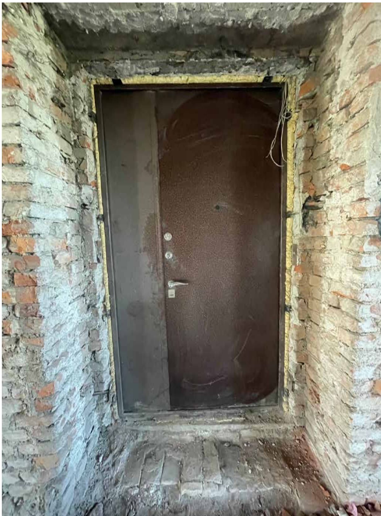
6. Входная дверь квартиры изнутри.
