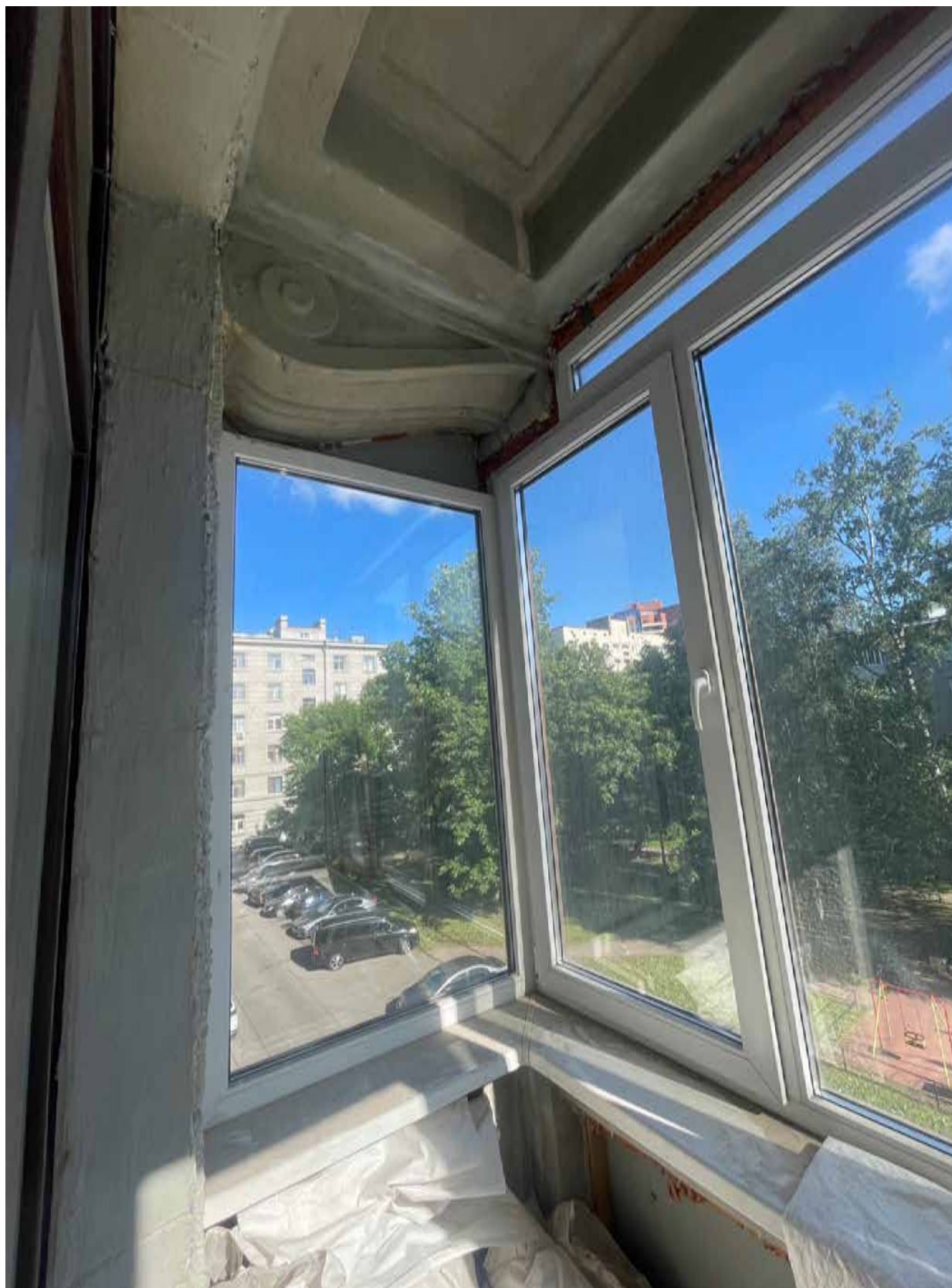
11. Балкон со стороны дворового фасада.
