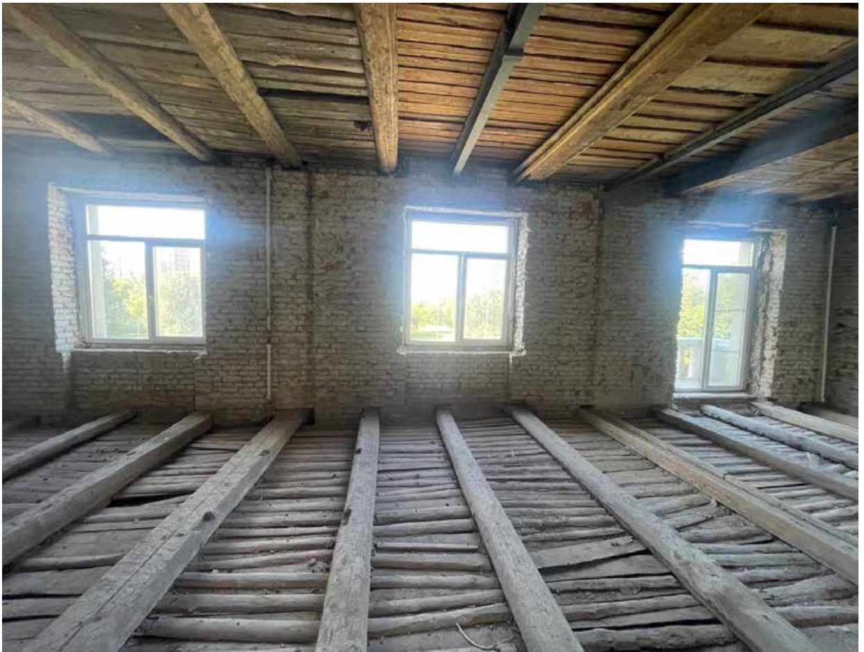
7. Помещение со стороны лицевого фасада.
