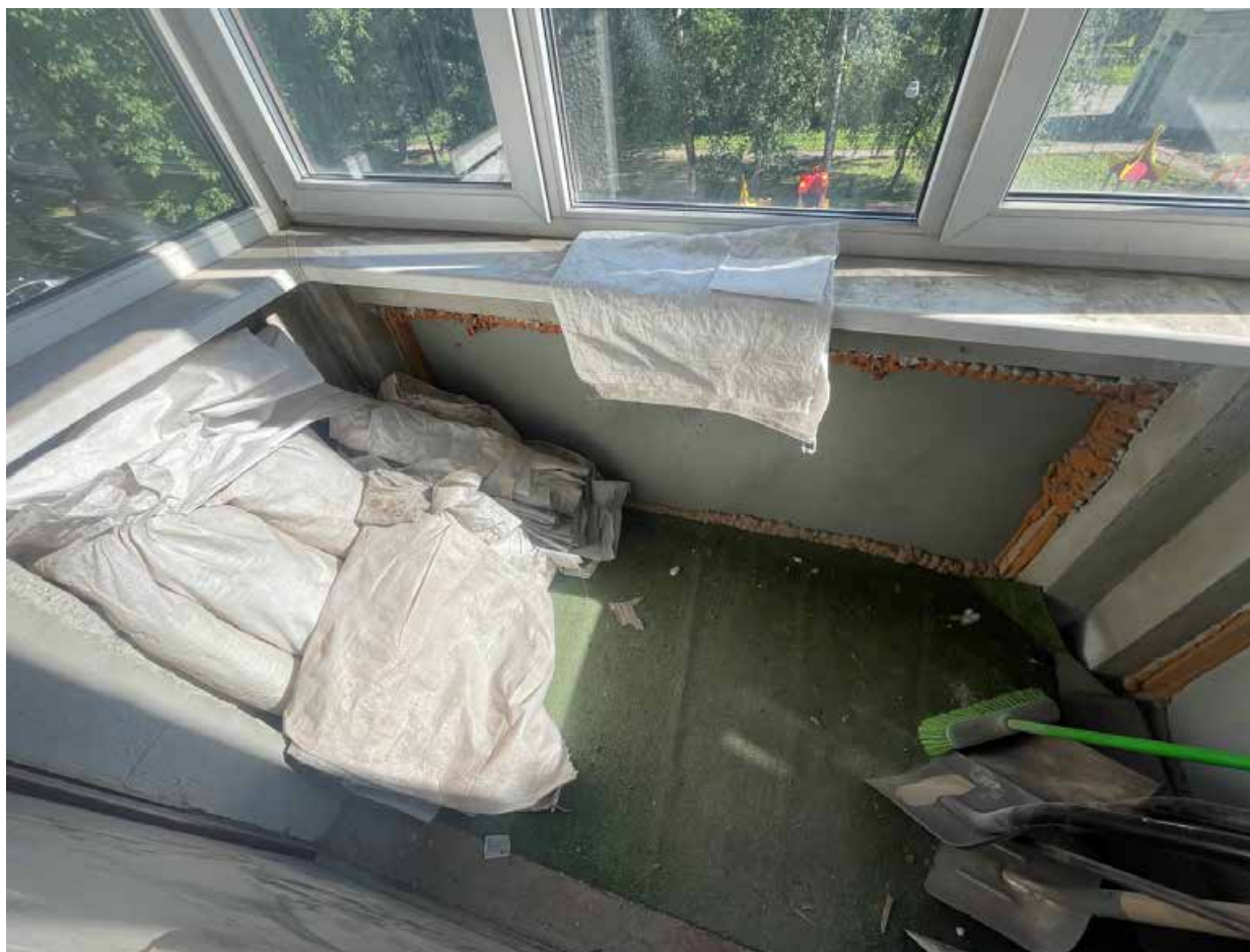
13. Балкон со стороны дворового фасада.
