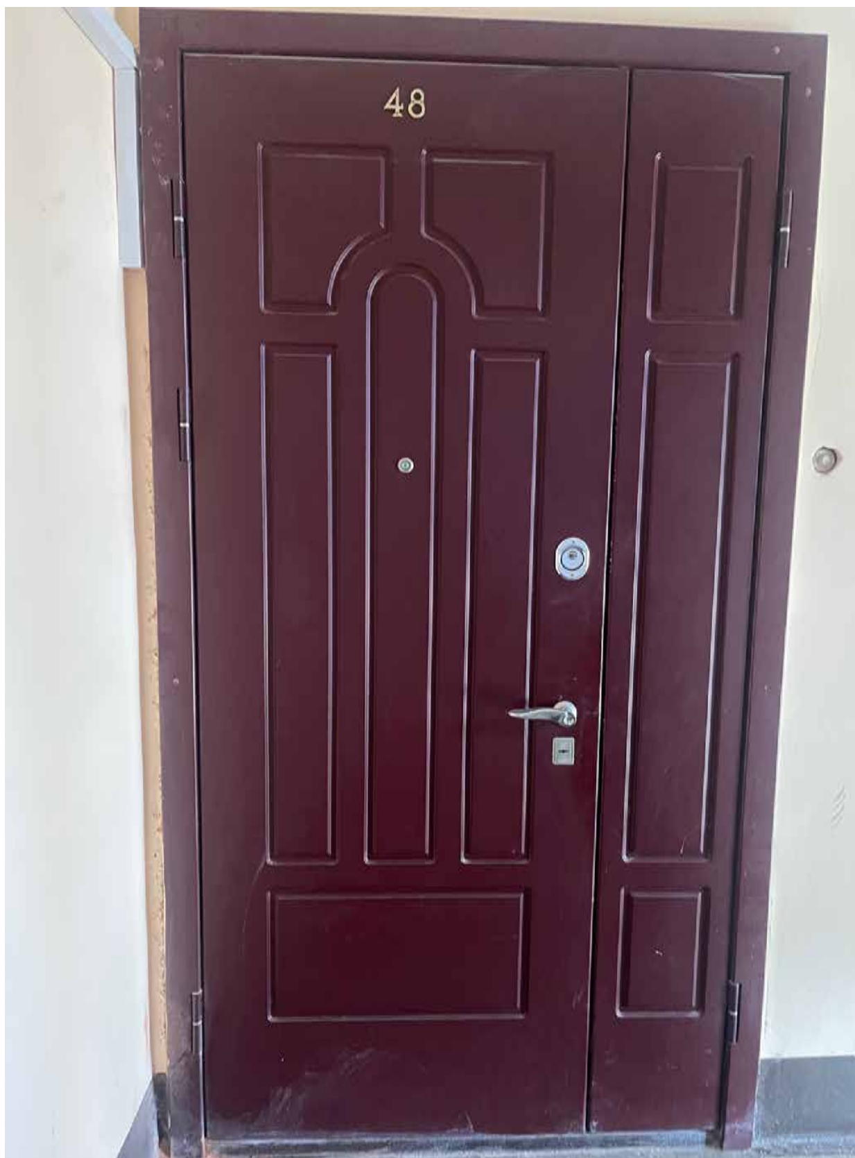
5. Входная дверь квартиры со стороны лестничной клетки.
