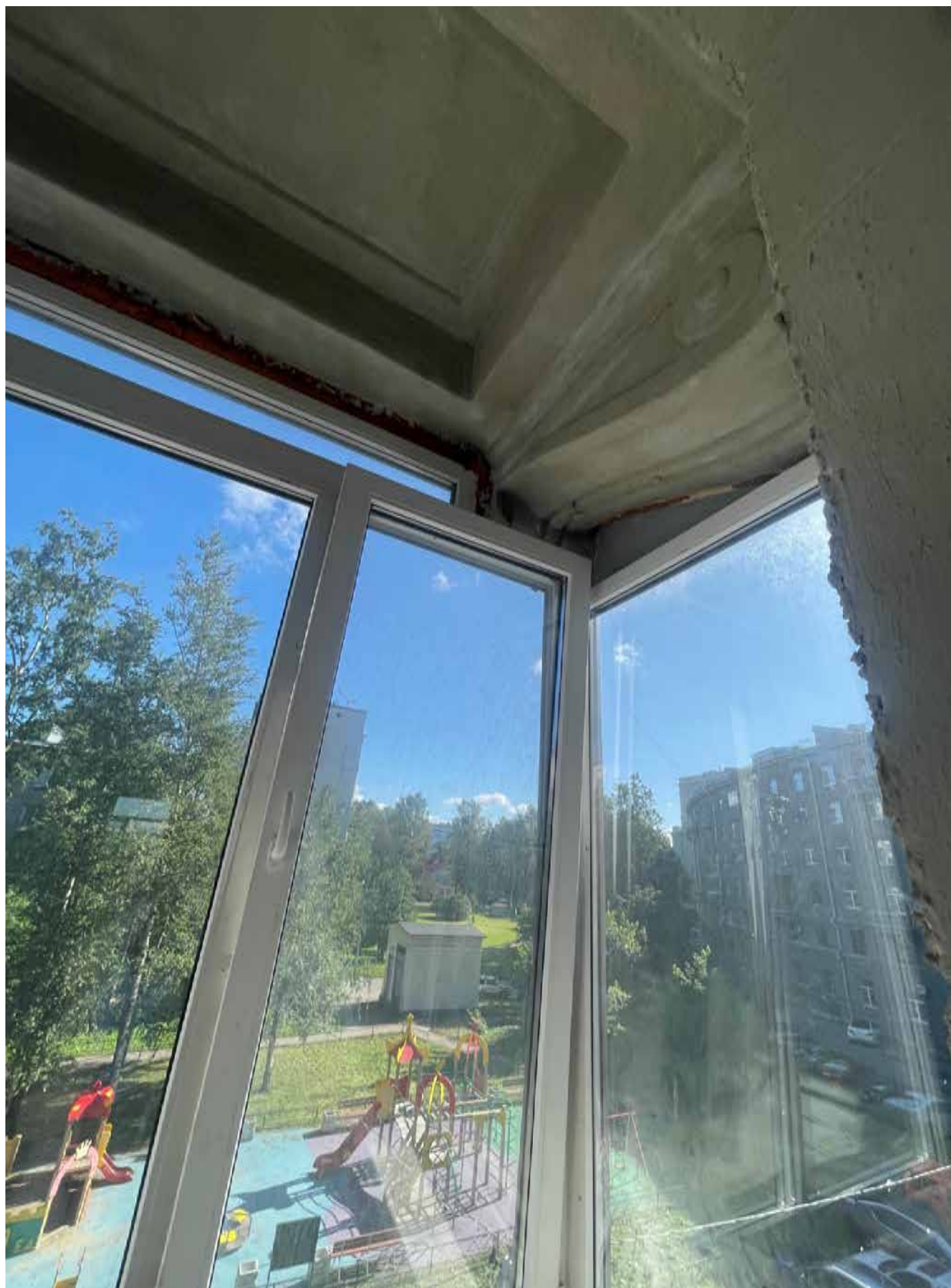
12. Балкон со стороны дворового фасада.
