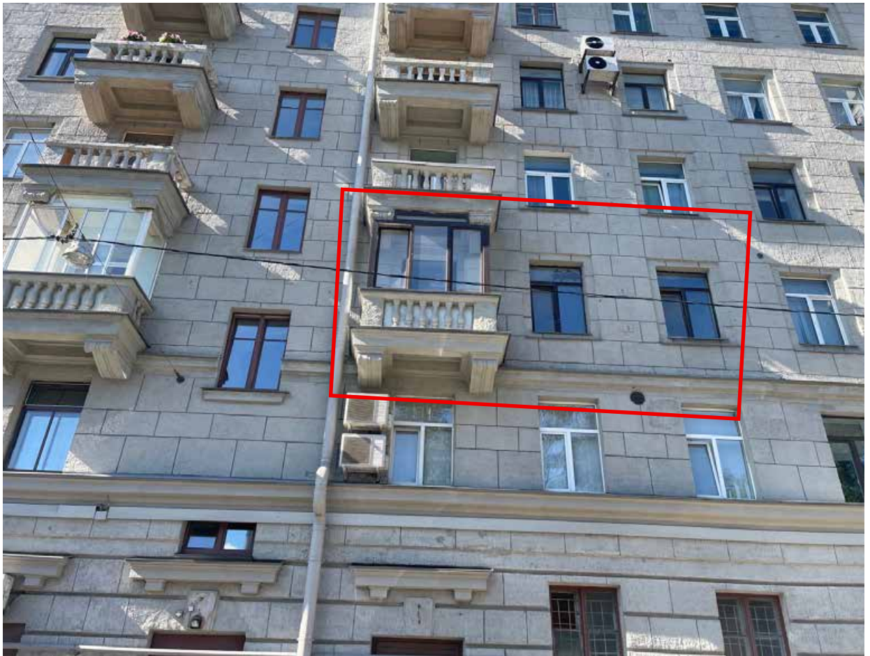
2. Фрагмент дворового фасада. Красной линией отмечены оконные проемы квартиры.
