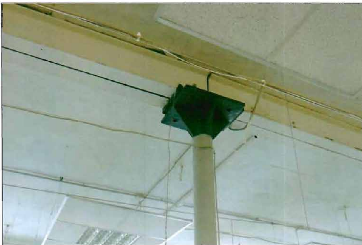
7. Интерьер. Фрагмент. Конструкция перекрытия.
