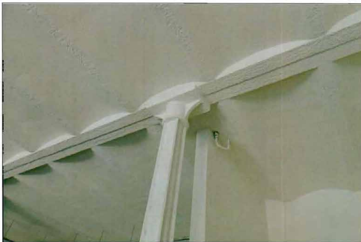
6. Интерьер. Фрагмент. Конструкция перекрытия.
