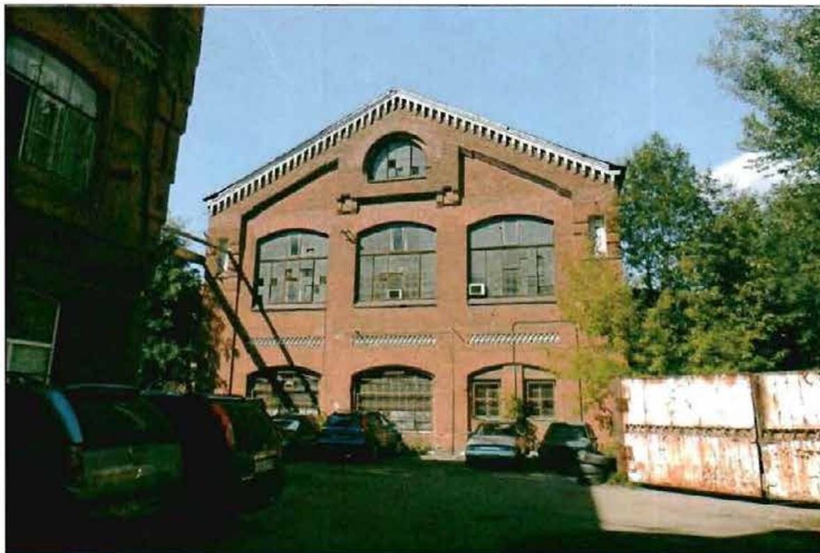
8. Общий вид юго-восточного фасада.
