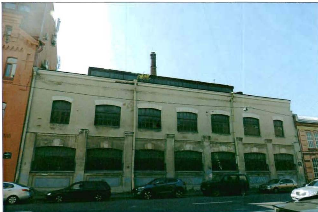
3. Лицевой фасад по 17-й линии В.О.
