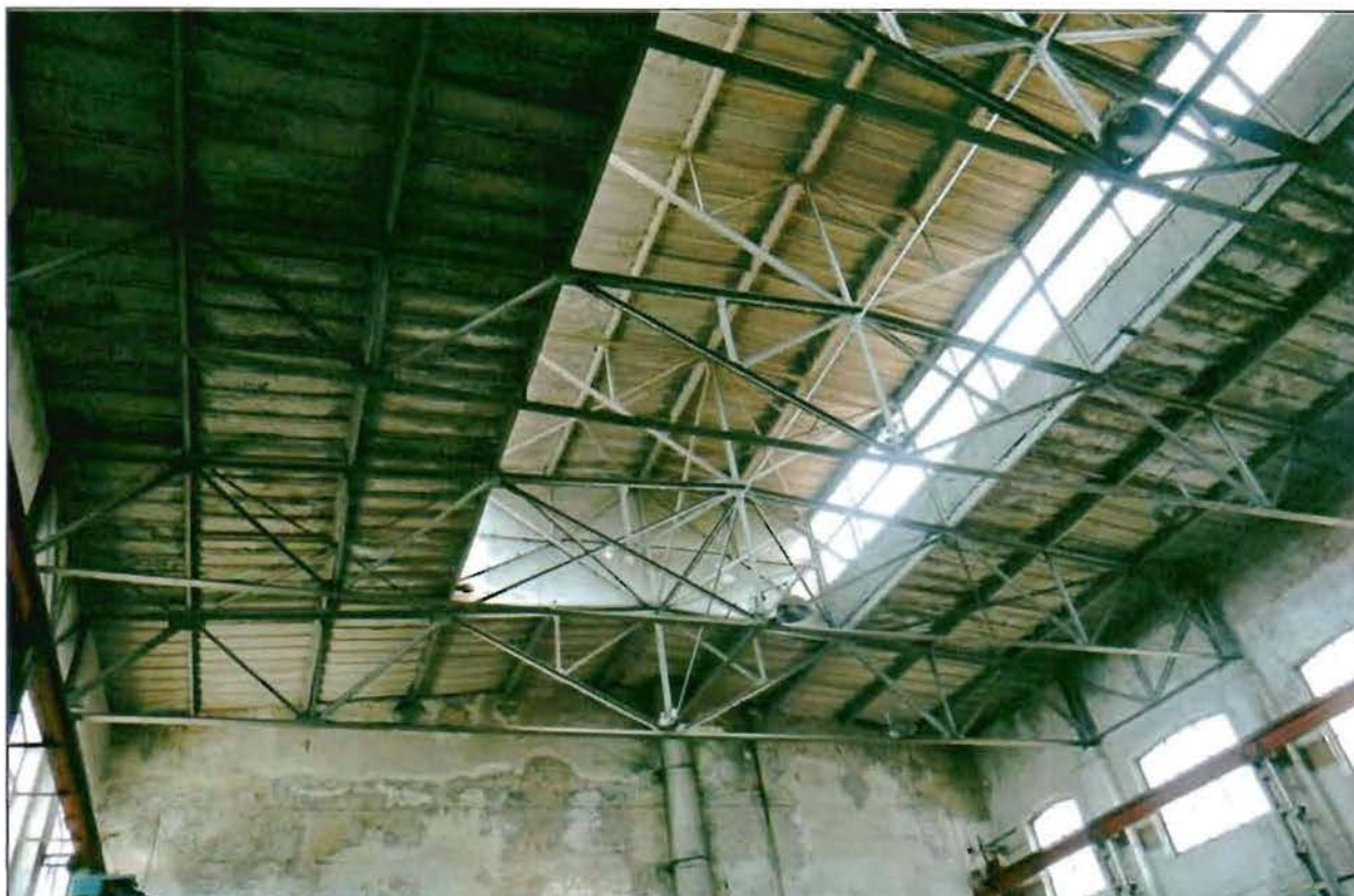
4. Интерьер. Фрагмент. Конструкции светового фонаря.
