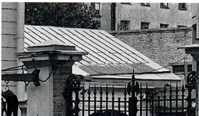
3. Фрагмент крыши здания
