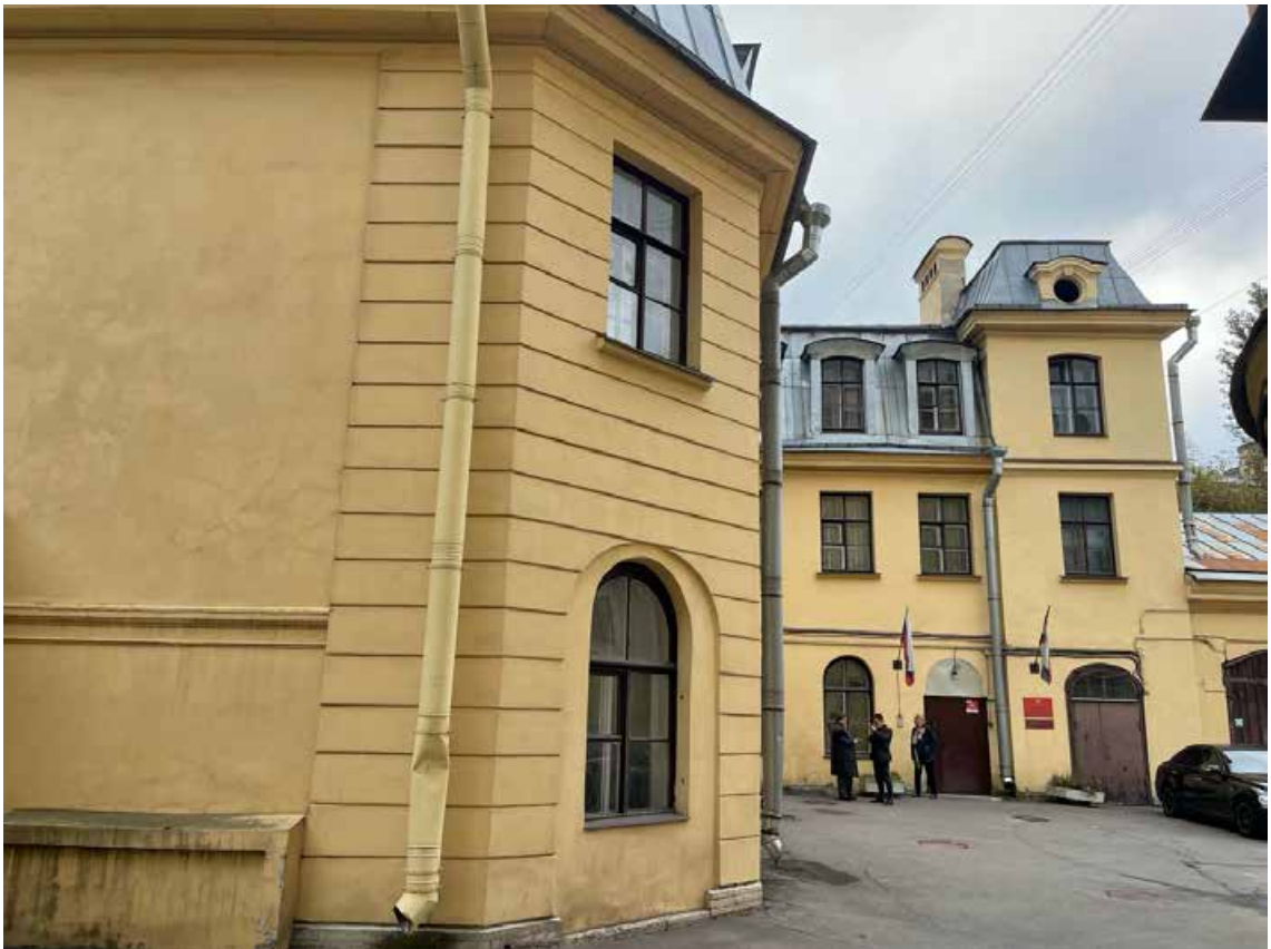
4. Вид на западные фасады со стороны двора
