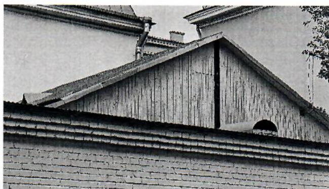
4. Фрагмент крыши здания (с южной стороны)
