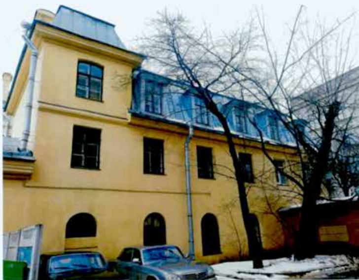
2. Общий вид. Восточный фасад объекта культурного наследия.
