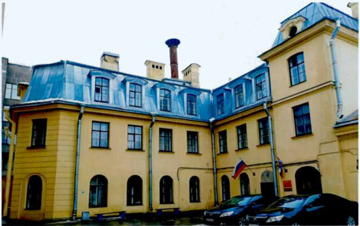
3. Общий вид. Дворовые фасады объекта культурного наследия.
