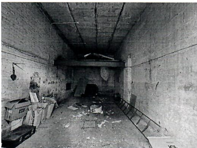
Фрагмент интерьера (пом. 1-го эт)
